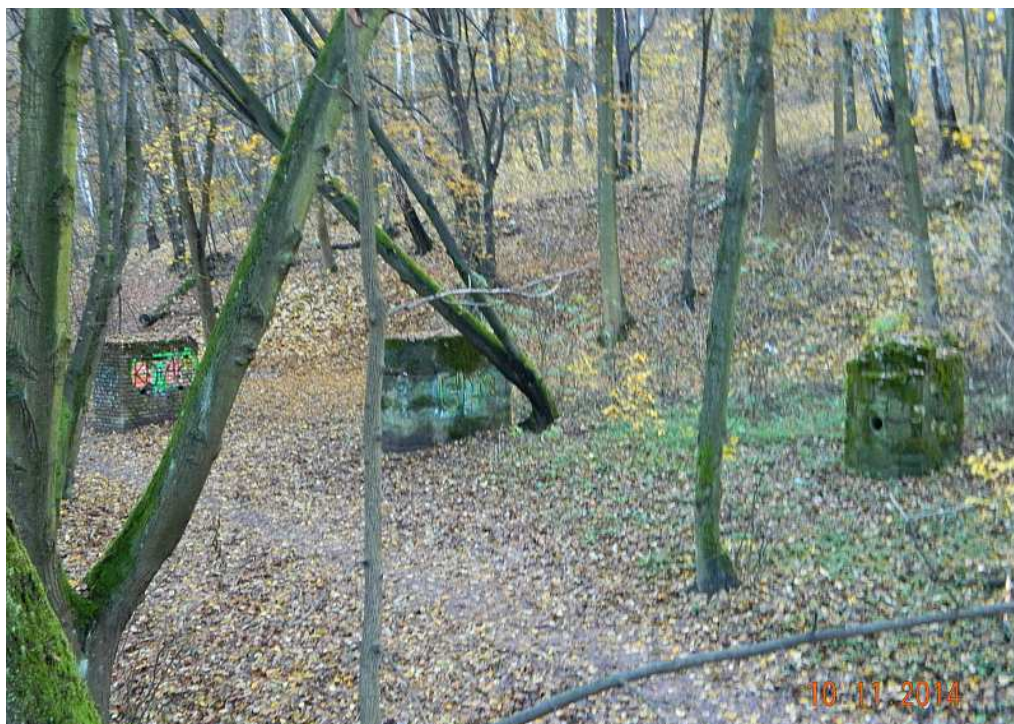
Fot. nr 177. Filary dawnego mostu u podnóża tory saneczkowego, którydy od strony ulicy Królowej Jadwigi wiodła kiedyś droga dojazdowa do niemieckich garaży.
