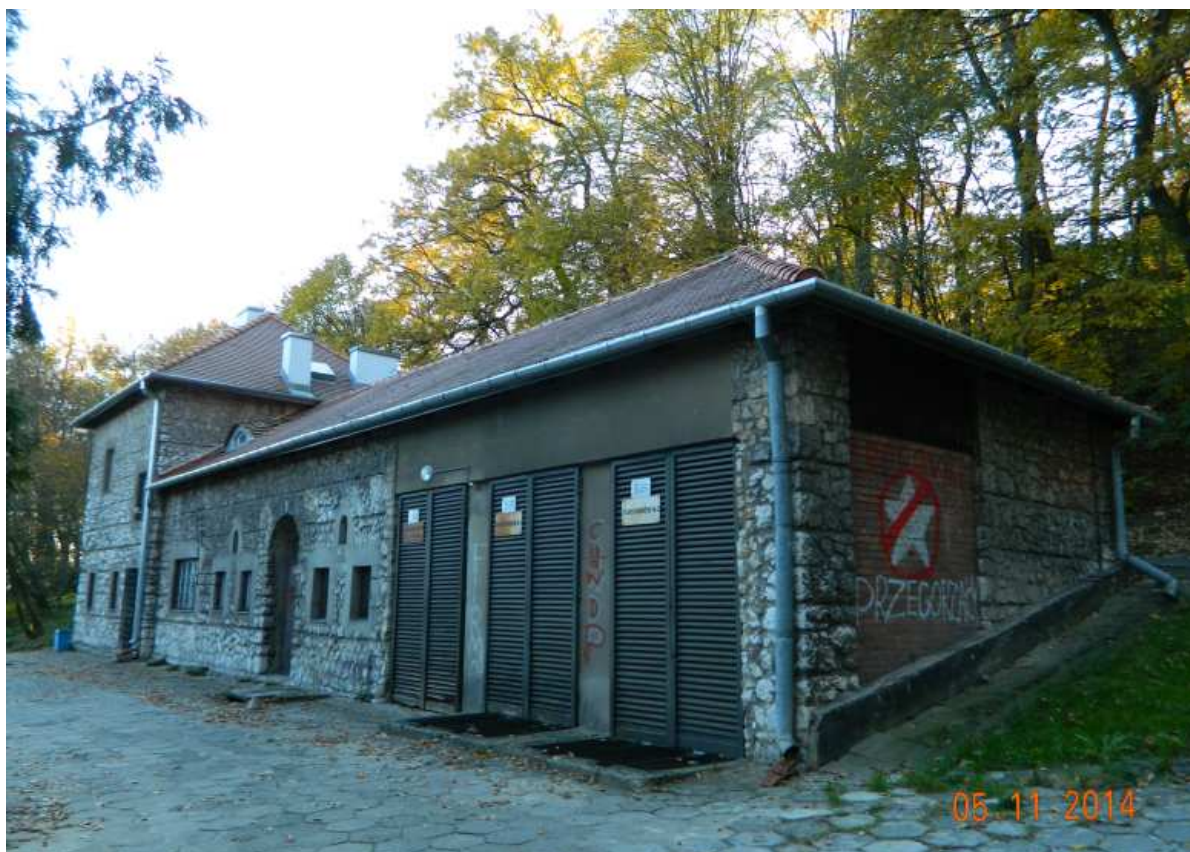
Fot. nr 273. Pozostałości przedwojennej, małej architektury przy ulicy Jodłowej.
