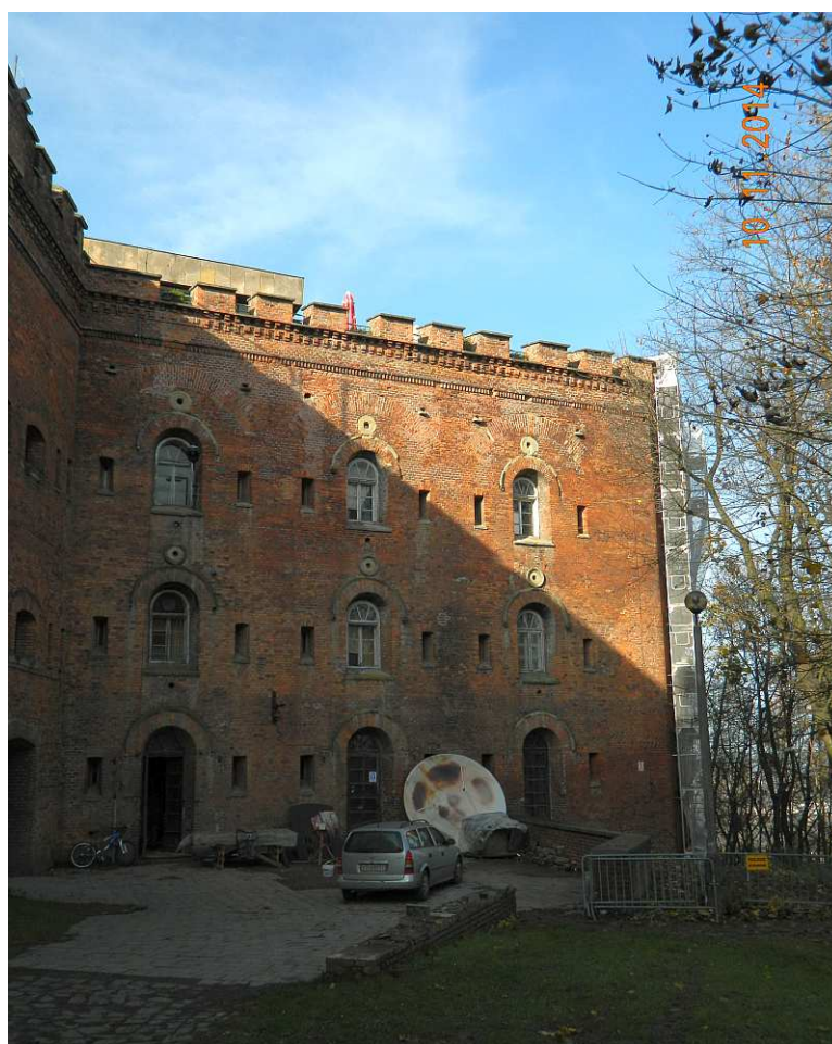
Fot. nr 113. Remontowany bastion nr IV fortu Kościuszki.
