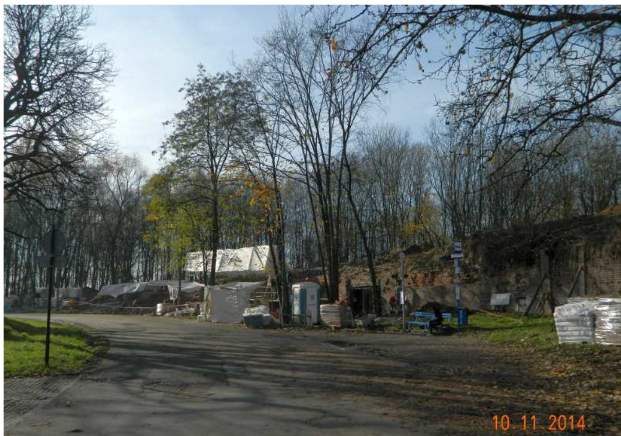
Fot. nr 130 (130-131). Coś drgnęło przy rekonstrukcji bastionu nr II.
