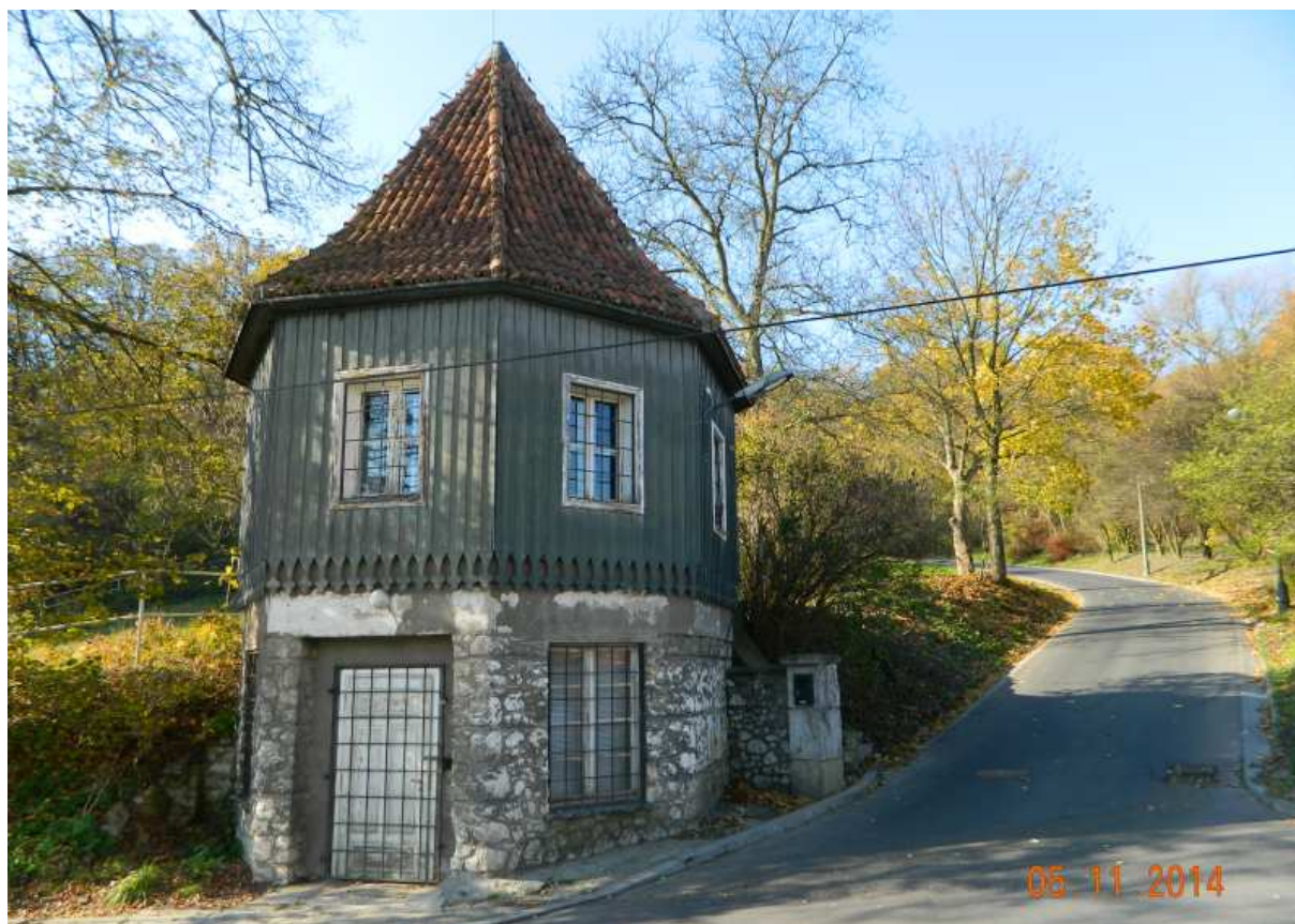
Fot. nr 267. Zapewne budka dozorczy przy rozwidleniu ulicy Jodłowej, usytuowana w dolnej części dawnego majątku Adolfa Szyszko-Bohusza.
