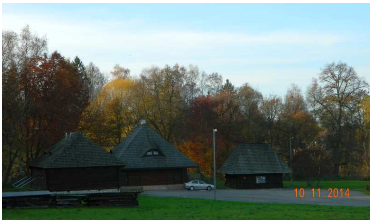
Fot. nr 251. Trzy budynki gospodarcze objęte ochroną.
