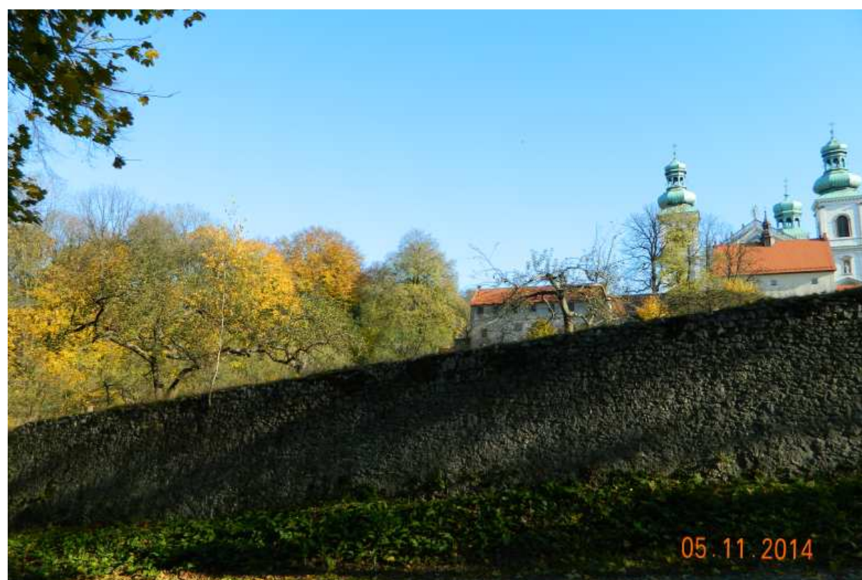
Fot. nr 302. Sad za murem klasztornym.
