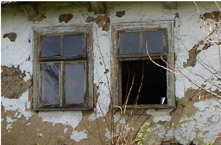
Fot. nr 196. Oryginalne okna. (19.04.2009)
