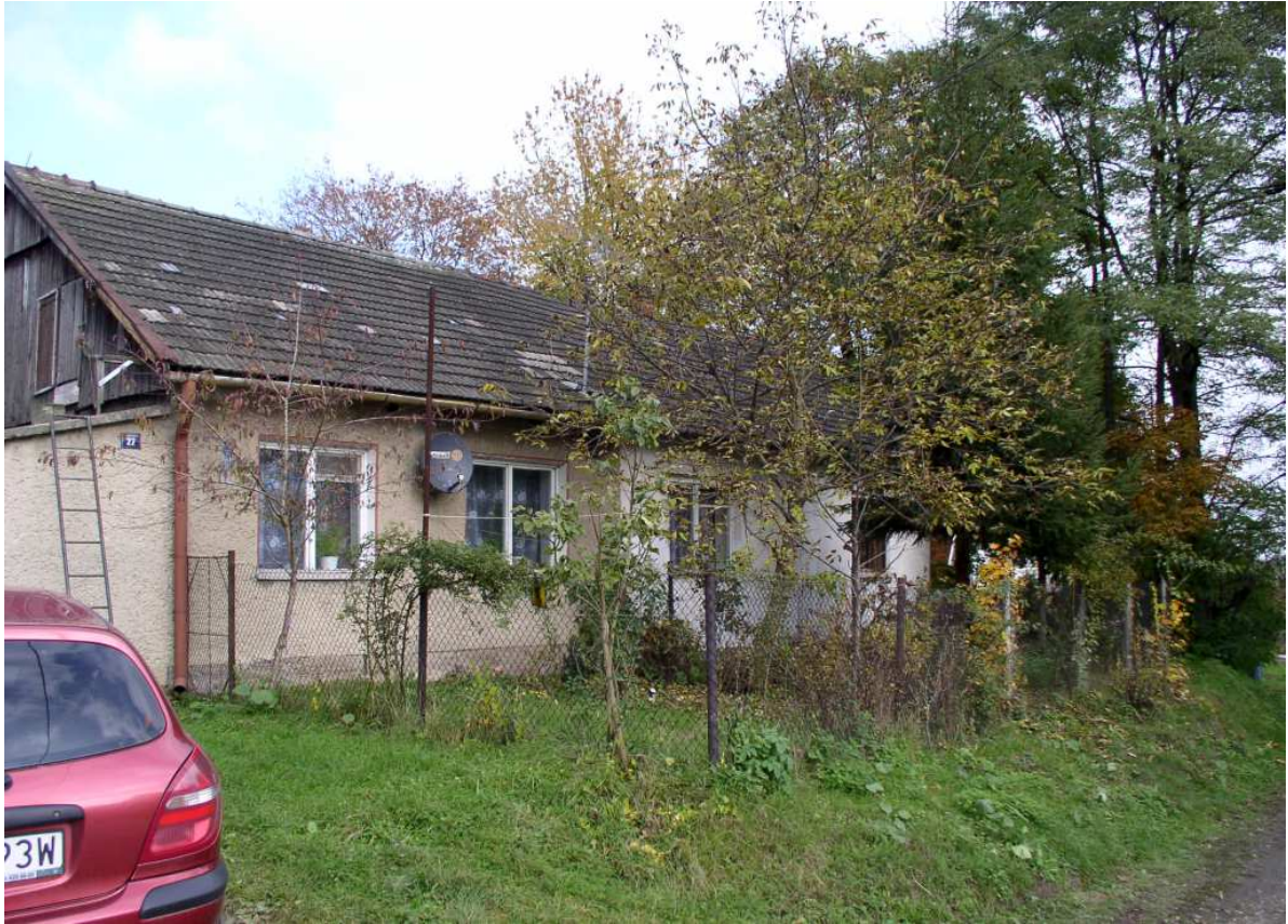
Fot. nr 102 (102-104). Współczesna wersja dawnej chałupy Grabowskich spod nr 22, do 1934 roku w rękach rodziny Grabowskich, potem Kędrynow. (31.10.2009)
