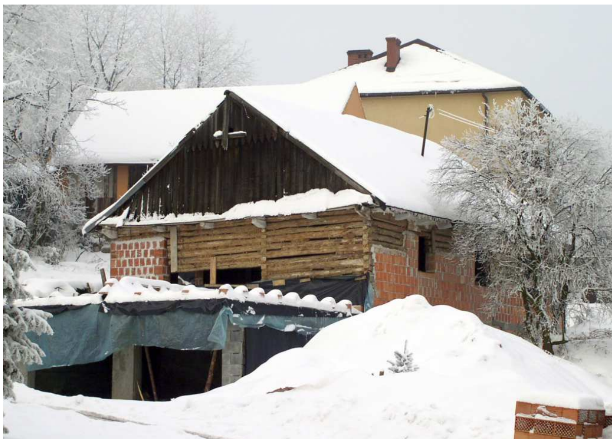
Fot. nr 214. Przebudowa domu pod nr 165 (?). (18.01.2010)
