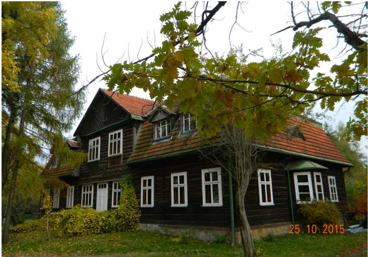
Fot. nr 294. Tylna część budynku dworskiego.
