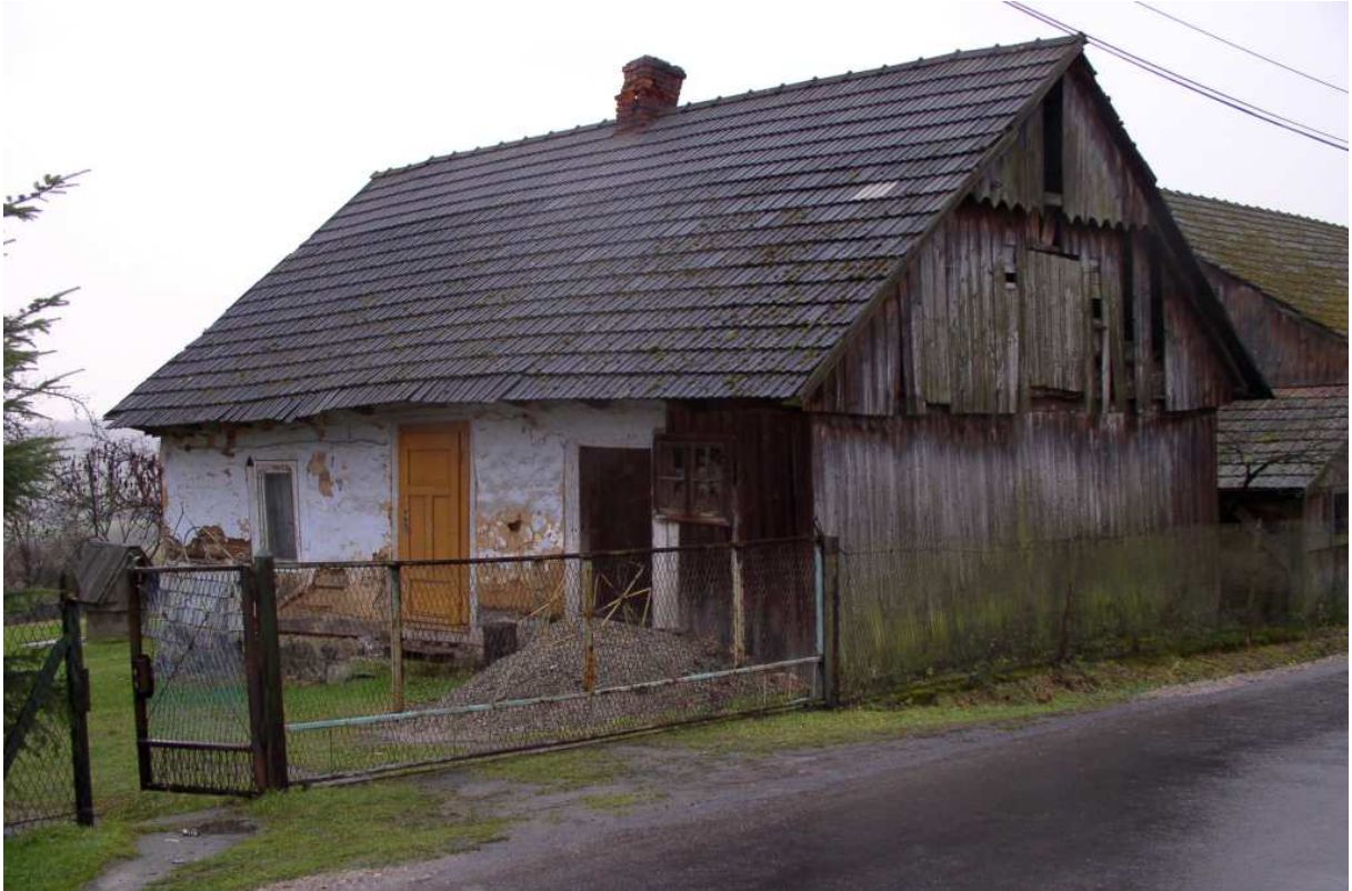
Fot. nr 278. Raczej nieistniejąca już chałupa pod nr 22 (?). (21.12.2008)
