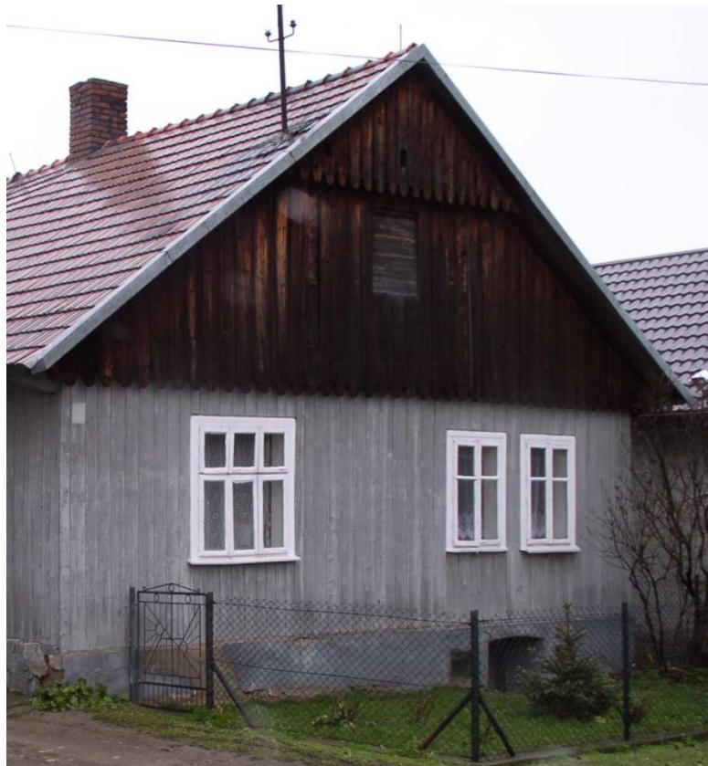
Fot. nr 277. Szczytowa ściana domuprzylegająca do drogi. (21.12.2008)
