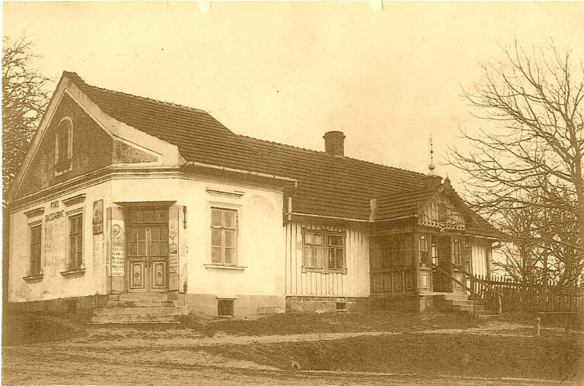
Fot. nr 4 (4-9). Dom Kaletów-„Wójcioków” na Klinie i przylegająca do niego dobudówka usługowa, zapewne wg stanu z II dekady XX-go wieku, bo na końcu po prawej stronie nie widać jeszcze fragmentu ze stolarnią. Na pierwszym planie do wejście do szynku, a od tyłu pomieszczenie zakładu fotograficznego, do którego wchodziło się z dziedzińca.
