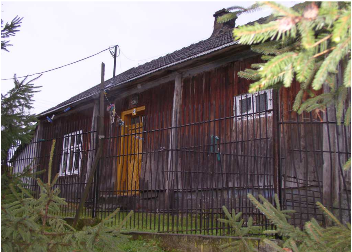
Fot. nr 283 (283-284). Zapewne blisko 100-letni dom pod nr 61. (21.12.2008).
