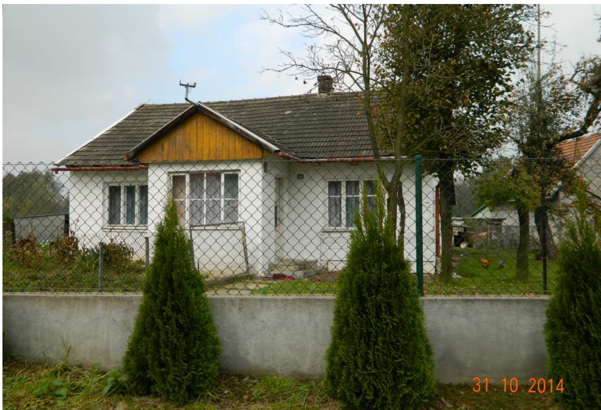
Fot. nr 47. Dom spod nr 126, częściowo już przebudowany ze starej chałupy. (31.10.2014)
