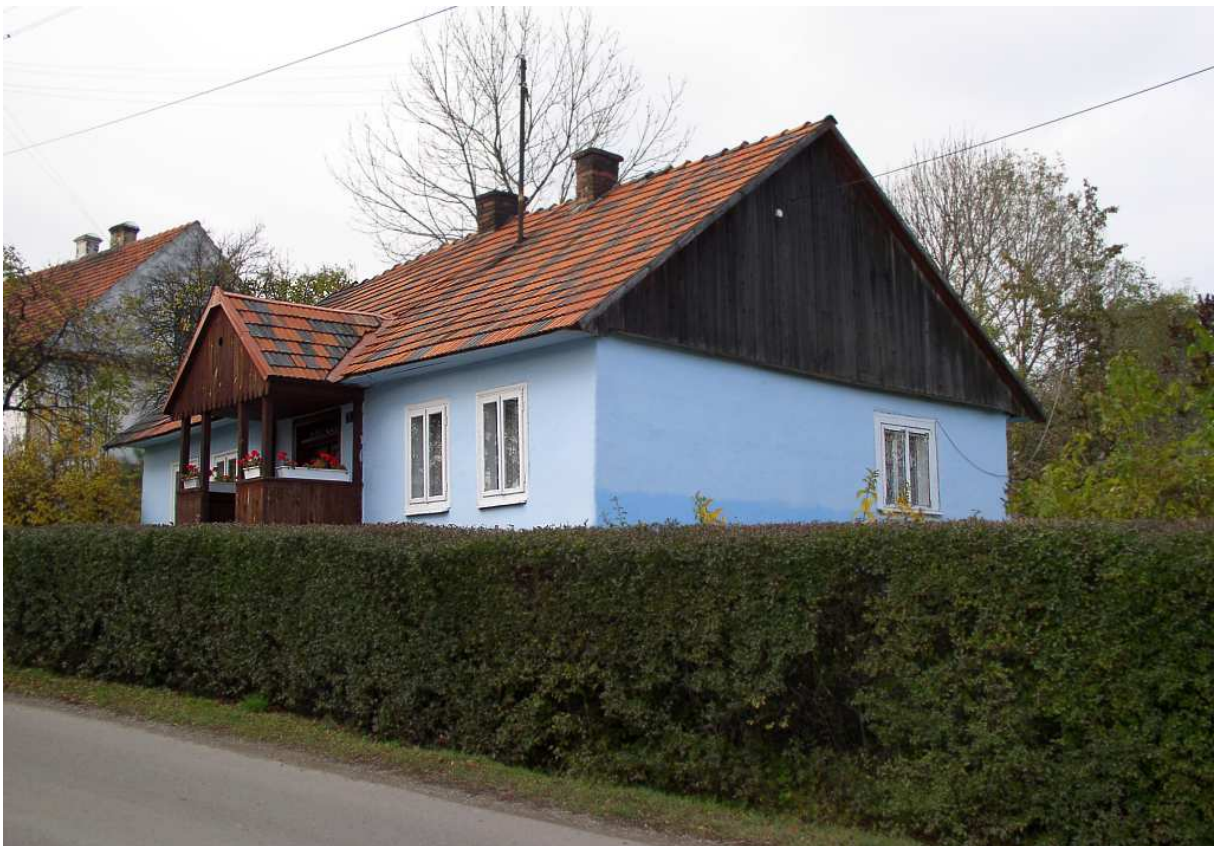
Fot. nr 228 (228-230). Bliska oryginałowi chałupa pod nr 49: bielona, z portykiem. Okna nieoryginalne. Można ją datować na przełom XIX/XX wieku. (31.10.2009)
