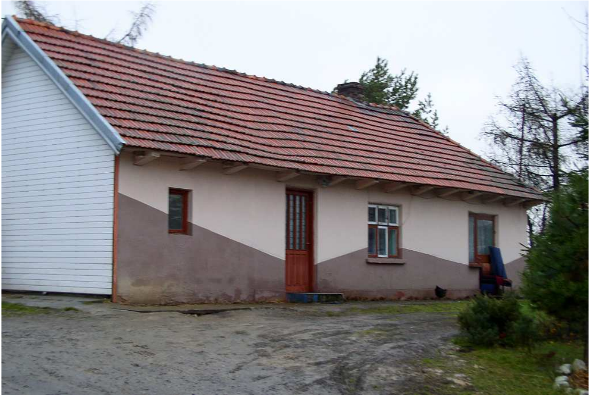
Fot. nr 282. Zapewne przedwojenny jeszcze dom spod nr 18 (?). (21.12.2008)
