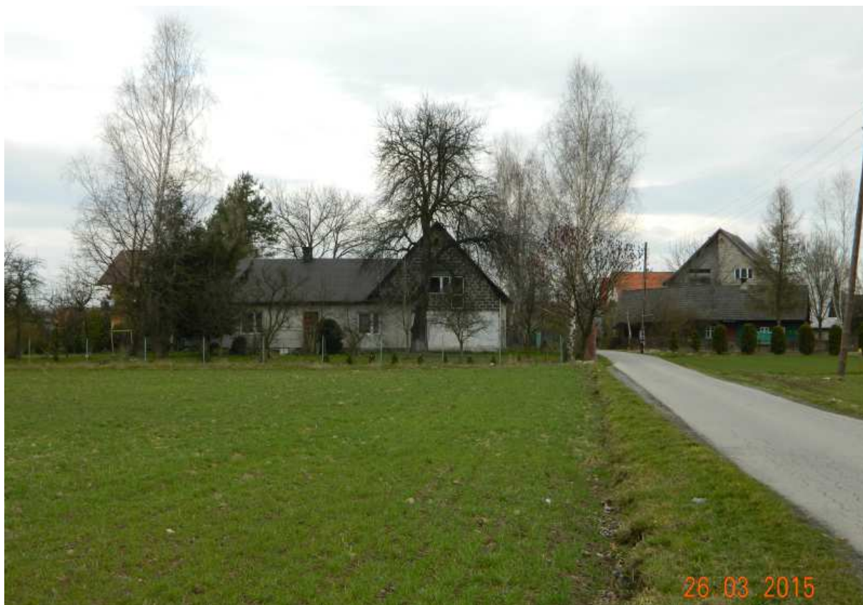
Fot. nr 156. Kolejny fragment przysiółka Rudy - fragment wzdłuż ulicy Rudy, w sąsiedztwie cmentarza.
