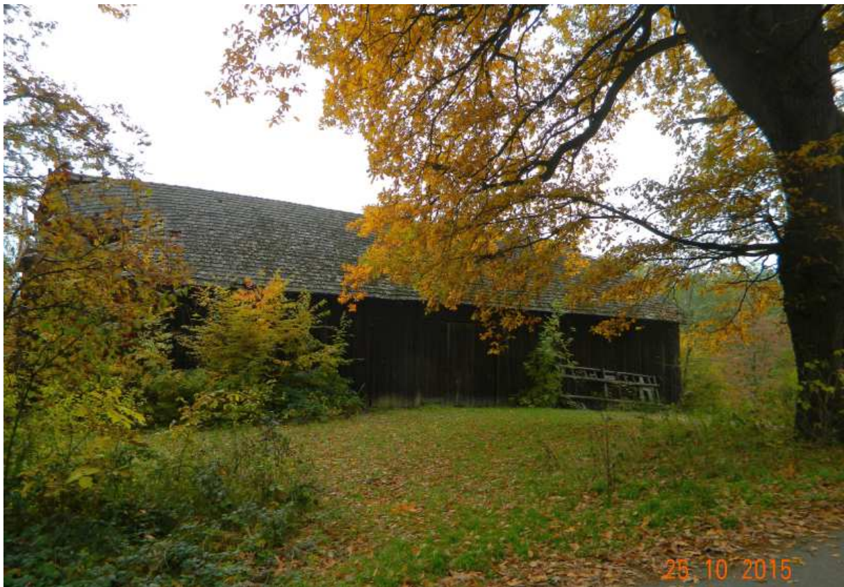
Fot. nr 315. Dworska stodoła i przylegający do niej wiekowy dąb, który jest pomnikiem przyrody. Może stara stała właśnie w tym miejscu?
