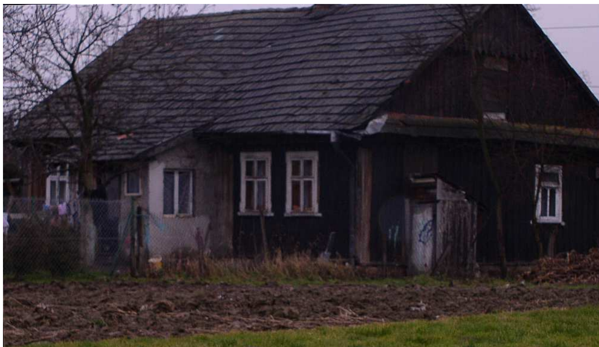
Fot. nr 80. Widok od strony ogrodu. (21.12.2008)
