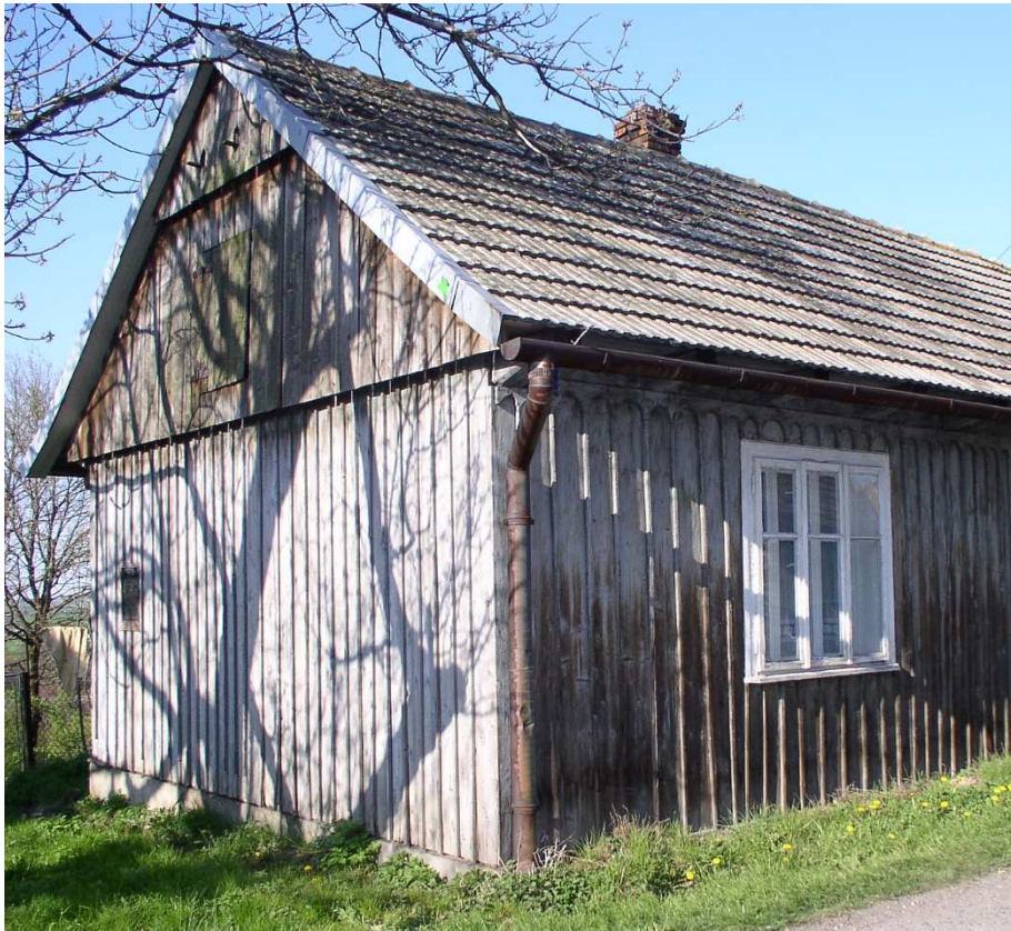
Fot. nr 210. Oryginalny fragment domu. (19.04.2009)
