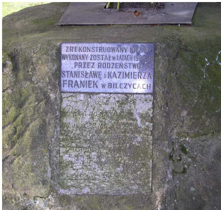
Fot. nr 161. Ledwo czytelna stara inskrypcja na cokole i nowa tablica. (08.05.10)
