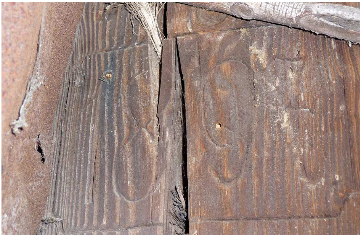
Fot. nr 111. Data budowy obiektu na podłużnej belce z boku drzwi. (31.10.2011)
