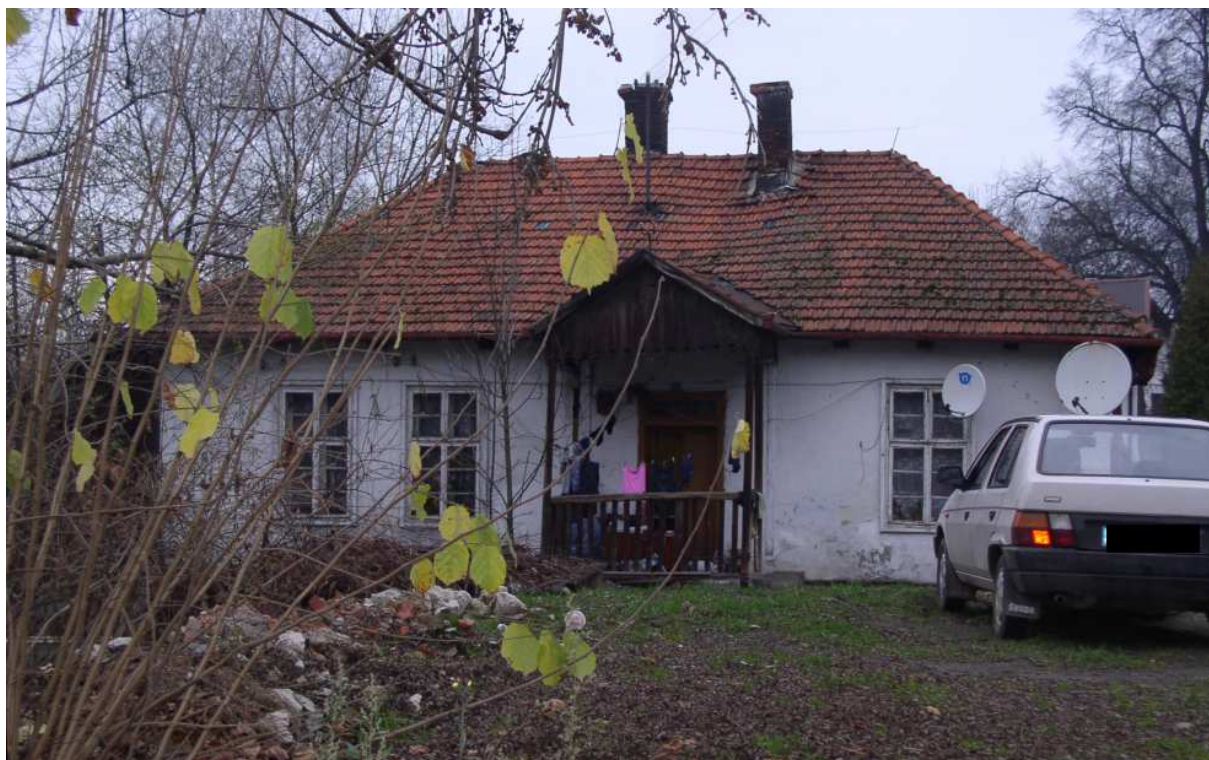
Fot. nr 180 (180-188). Nieistniejący już dom na kształt skromnego dworku pod nr Gdów 173. Był to cenny przykład zabudowy klasycystycznej, typowej dla III. ćwierci XIX wieku. W okresie międzywojennym należał do Dąbrowskich. W czasach PRL mieścił się tu ośrodek zdrowia. Kto mógł przypuszczać, że tak cenny obiekt zostanie on wyburzony. (16.11.2008)
