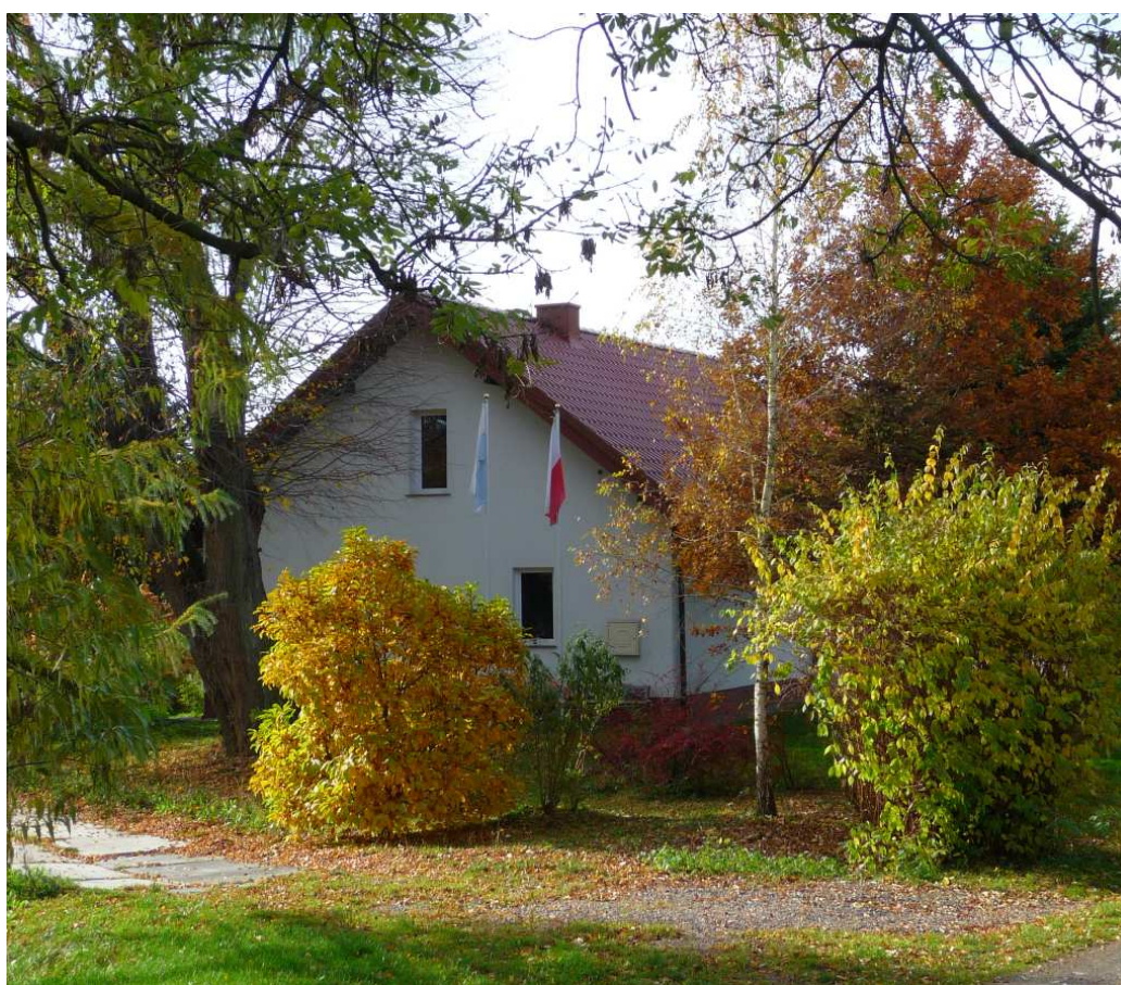
Fot. nr 394. Boczna ściana, podobnie jak fasada po remoncie. Oryginalne okna typu skrzynkowego zastąpiły bezpodziałowe plastiki, a poddasze zostało przemurowane. Stan z 02.11.2025. (02.11.2025)
