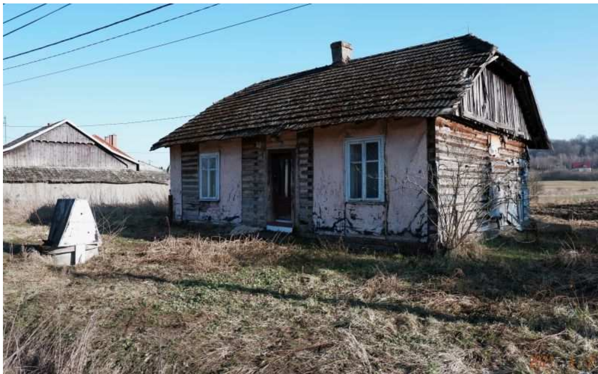
Fot. nr 559 (559-563). Chałupa spod nr Gdów 265, która mogła zostać wybudowana w I ćwierci XX wieku. Nie ma jej w GEZ.
