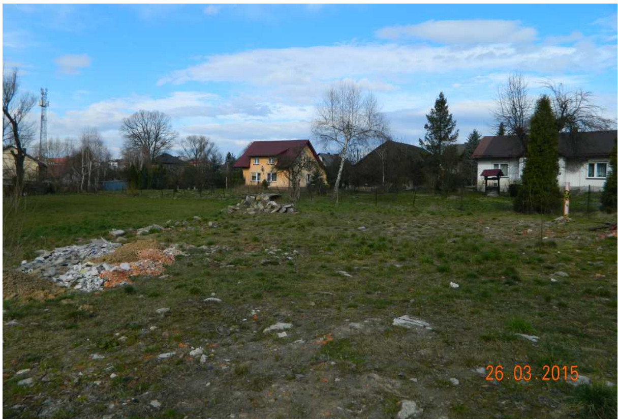
Fot. nr 187 (187-188). A tu już pusta przestrzeń po niedawnym wyburzeniu. W tle, z prawej, wyremontowany już dom pod nr Gdów 323 (?).
