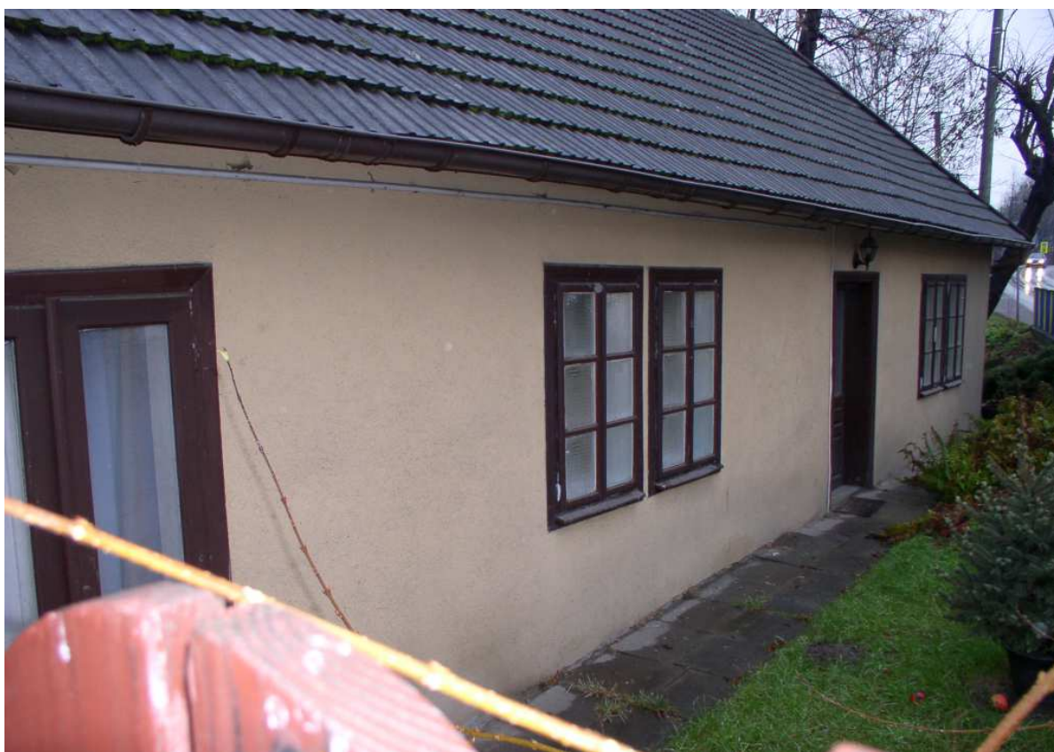
Fot. nr 175 (175-176). Detale pokrytej tynkiem fasady po remoncie z roku 1990. (21.12.2008)
