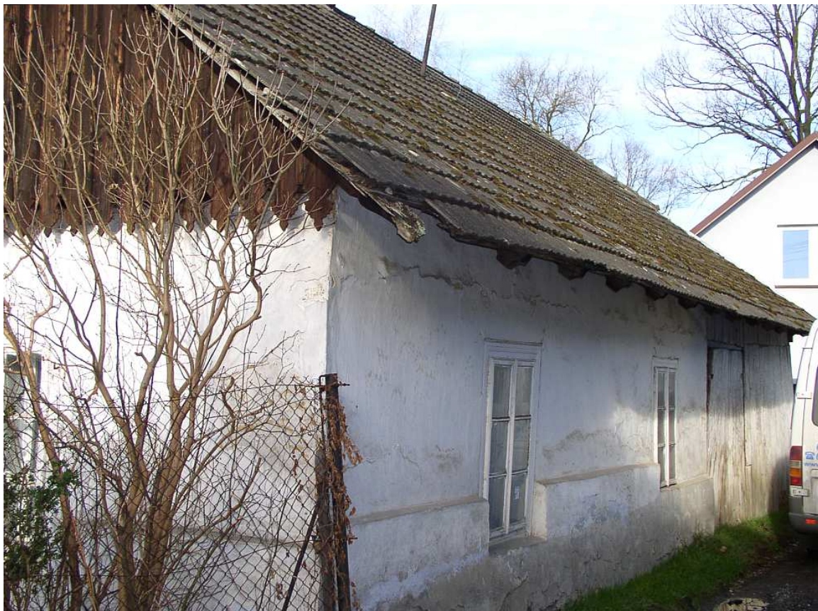
Fot. nr 152 (152-153). Bielona fasada od strony ulicy, a w niej oryginalne sześciopolowe okna typu ościeżnicowego. (02.12.2008)
