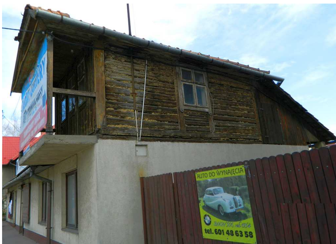
Fot. nr 456 (456-457). Znacznie przebudowany już w stosunku do dawnego oryginału drewniany kiedyś dom pod nr 160, który powstał na początku XX wieku, gdzie w czasach PRL mieściła się kawiarnia „U Reli” (taką jej nazwę słyszałem od miejscowych).
