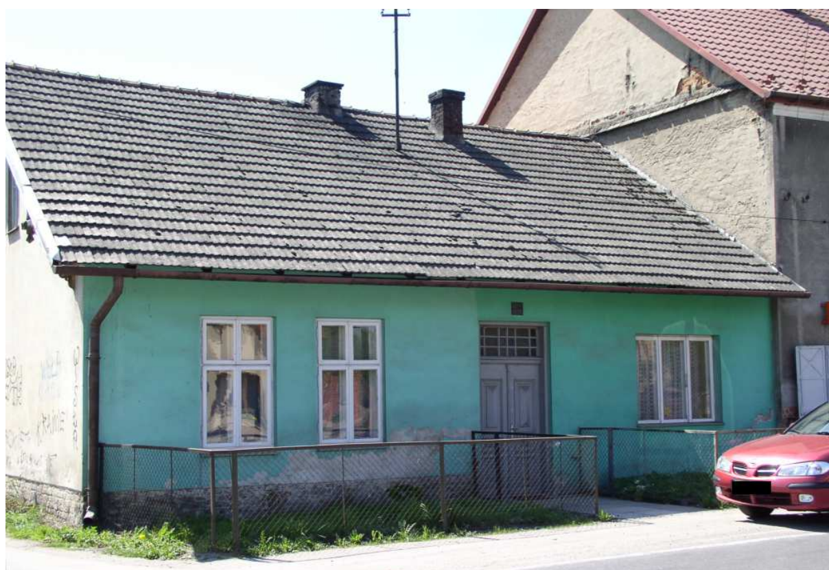
Fot. nr 444 (444-448). Zapewne przedwojenny dom murowany spod nr Gdów 204 i jego detale. (25.04.2009)
