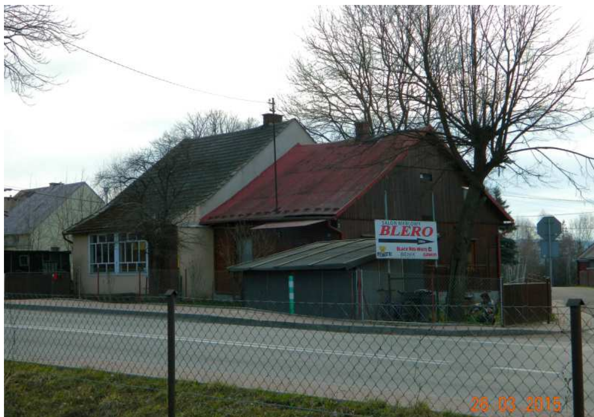
Fot. nr 289 (289-291). Stan z roku 2015, po remoncie elewacji.
