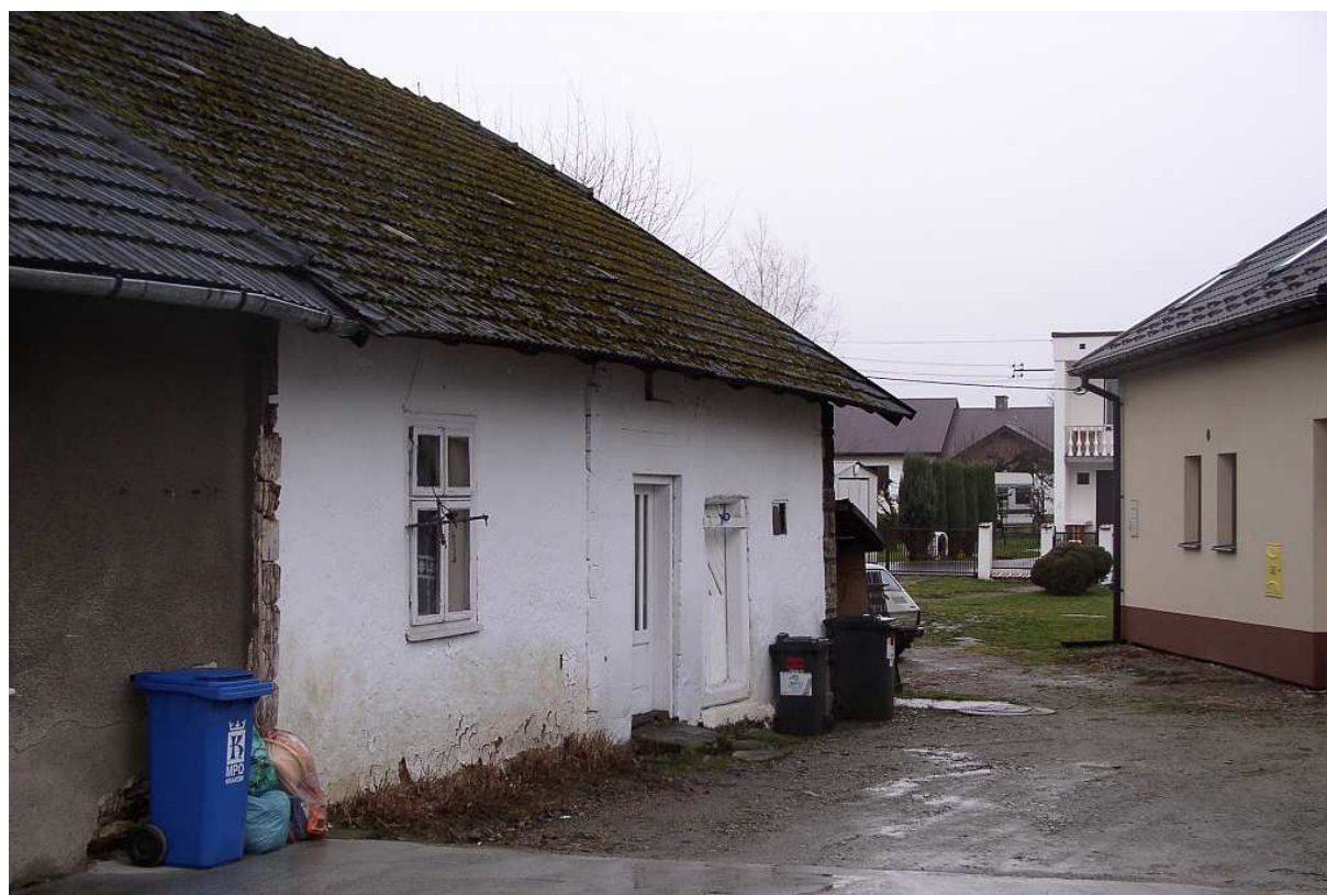
Fot. nr 401. Prawa, bielona część rozległego budynku, jak się wydaje starsza. (21.12.2008)
