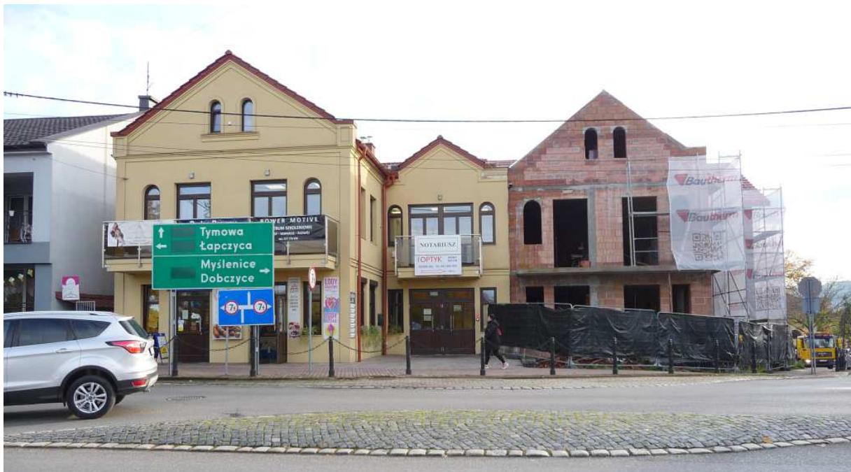
Fot. nr 500. Rozbudowa narożnego domu na posesji pod nr Gdów 57. (22.10.2025)
