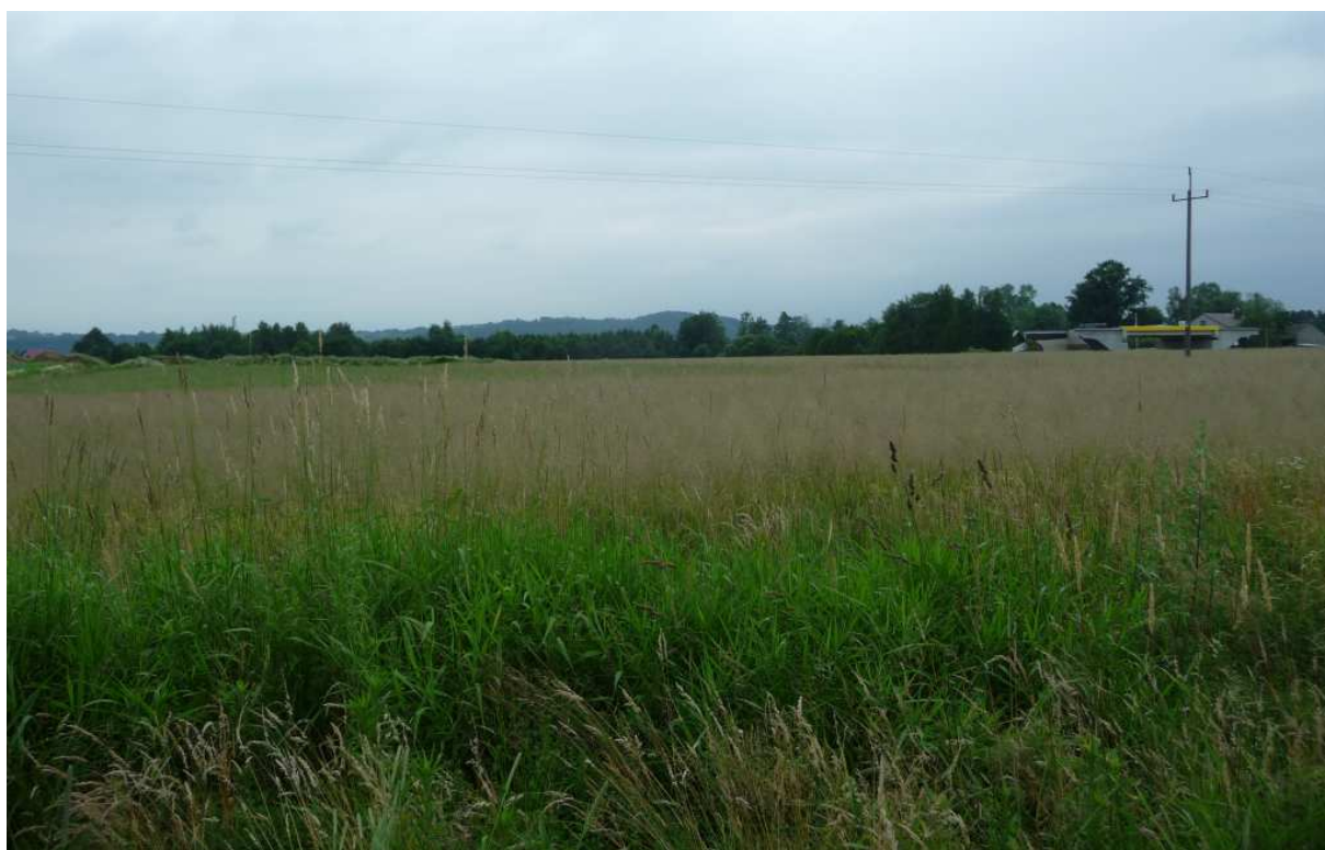
Fot. nr 41. Na pierwszym planie trwa już budowa gdowskiej obwodnicy. (13.06.2013)
