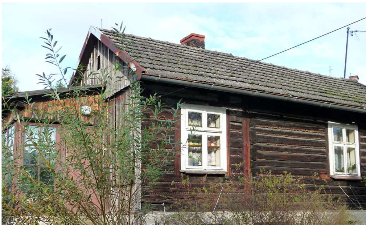
Fot. nr 533. Fasada o konstrukcji zrębowej z uszczelnieniami wykonanymi z warkoczy ze słomy. (22.10.2025)
