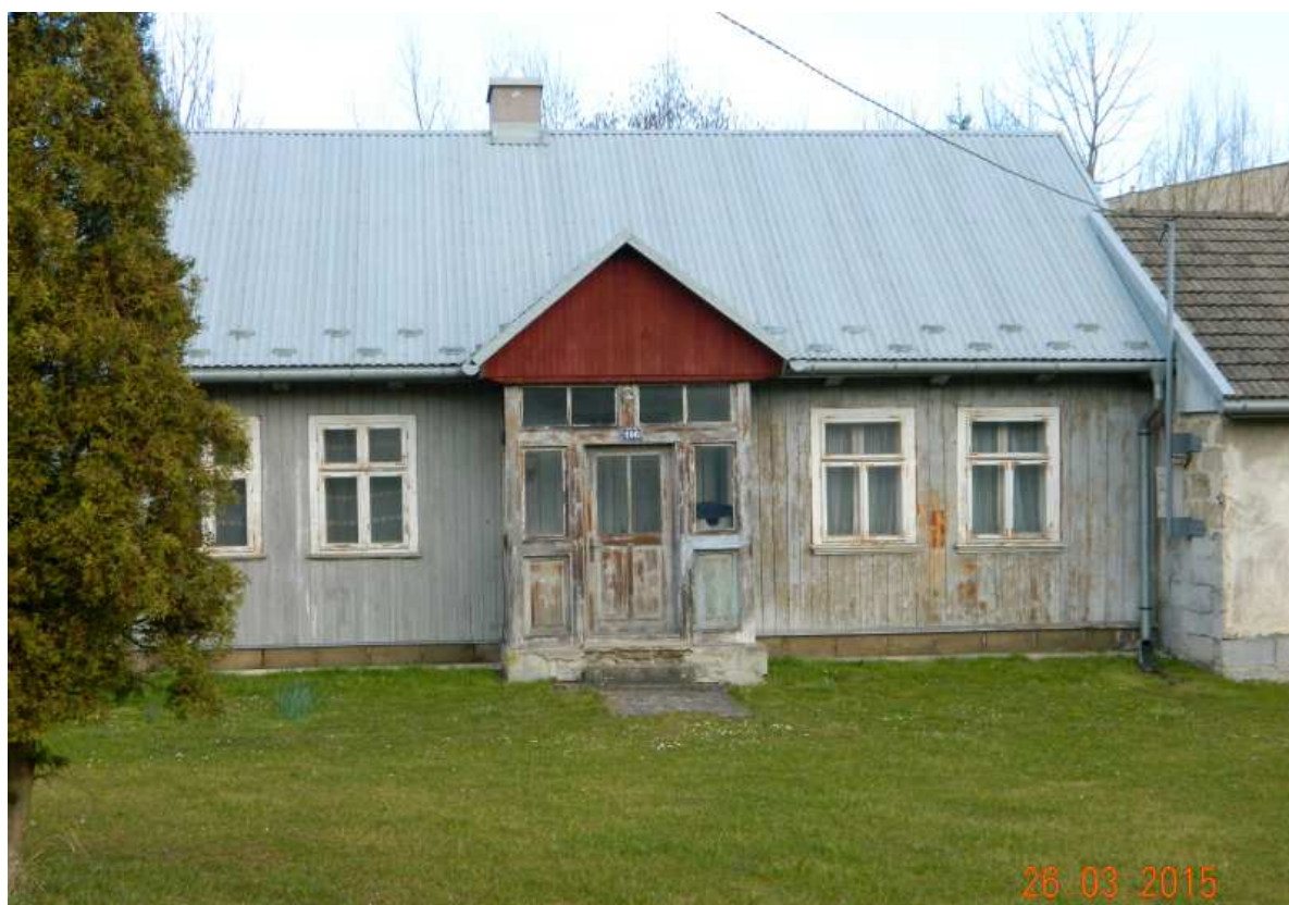
Fot. nr 524. Dwa typy okien w fasadzie: trójkwaterowe (z prawej) i chyba nieco starsze, czterokwaterowe (z lewej).
