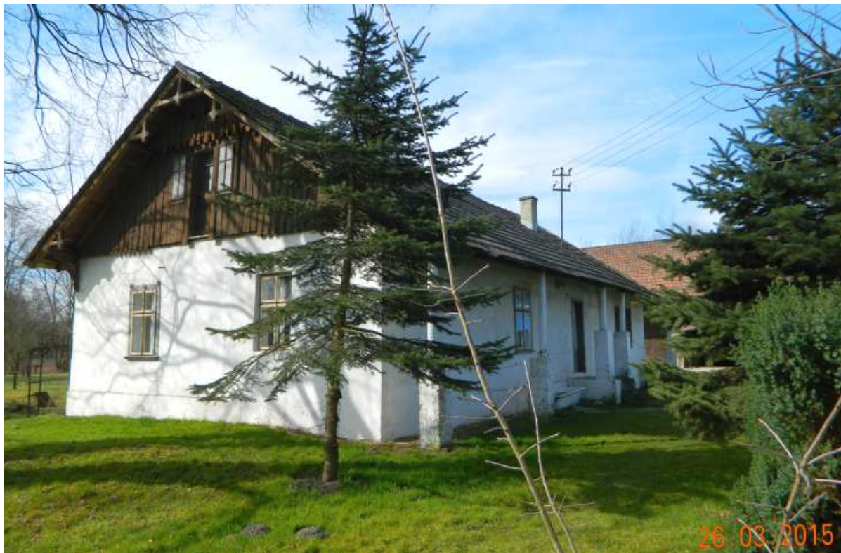
Fot. nr 392 (392-393). Widoki od strony ulicy Zacisze. Na uwagę zasługuje okapowy dach od strony podwórka, wsparty na kolumnach.
