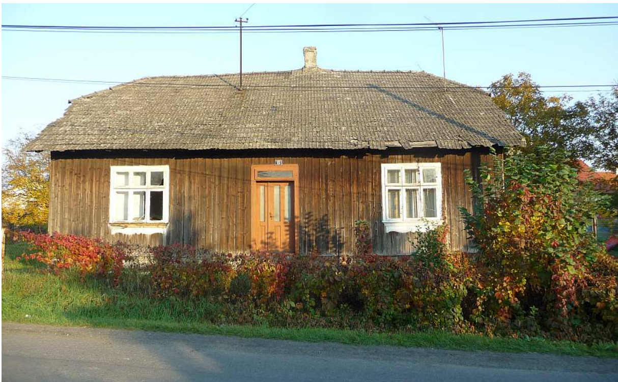
Fot. nr 279. Fasada z oryginalnymi oknami typu weneckiego. (22.10.2012)
