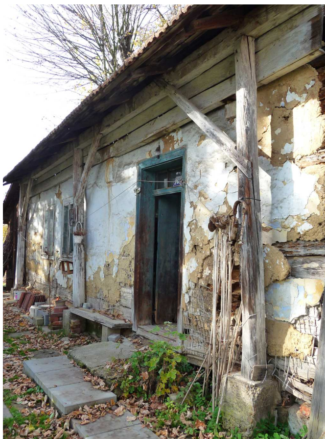
Fot. 223. Pokryta glinianą polepą i bielona ściana o konstrukcji zrębowej. (02.11.2025)
