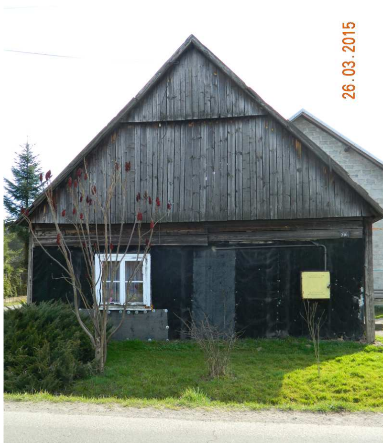
Fot. nr 360 (360-362). Szczytowa ściana od strony ulicy.
