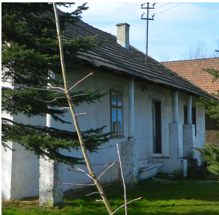
Fot. nr 393. Fragment od strony podwórka.
