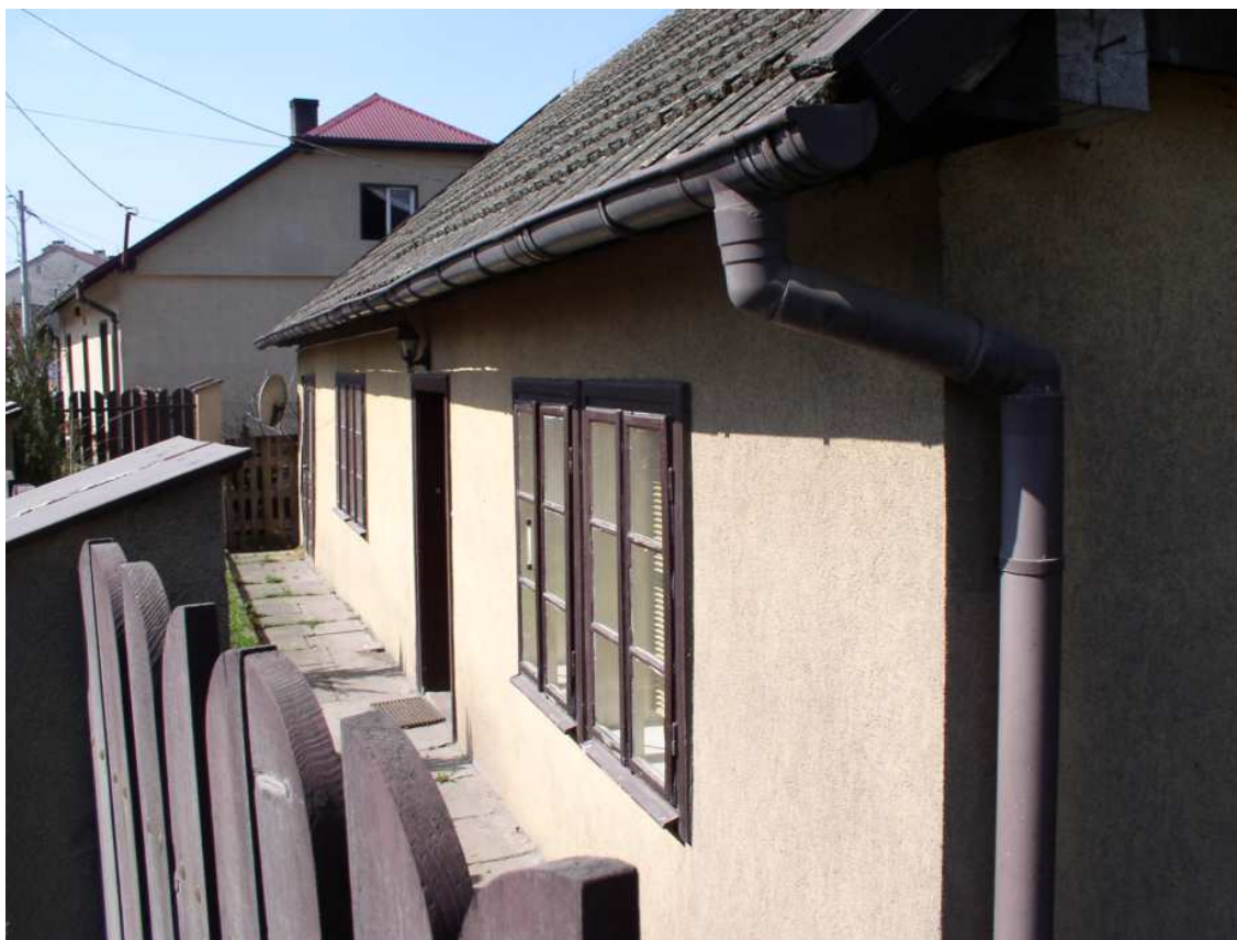
Fot. nr 176. Oryginalne okna typu ościeżnicowego. (05.04.2009)
