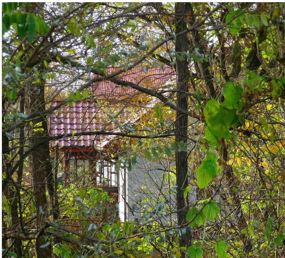
Fot. nr 390. Próba uchwycenia fasady i ganku w roku 2025, już po remoncie domu. Ganek przetrwał, ale wygląda na to, że utracił wiele detali. (02.11.2025)
