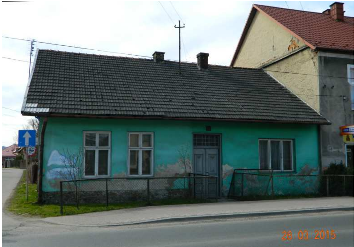
Fot. nr 445. Czterokwaterowe okna typu ościeżnicowego w lewej części fasady.
