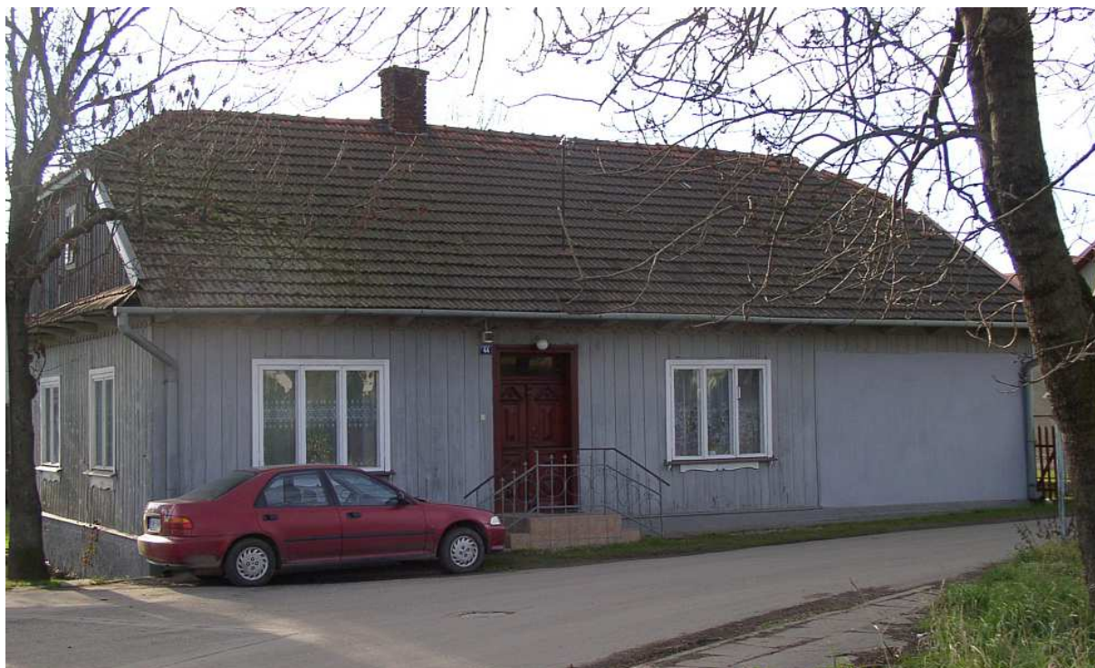
Fot. nr 469 (469-472). Bliski oryginałowi dom z naczółkowym dachem spod nr Gdów 44, zlokalizowany w narożu z ulicą Młyńską, który można datować na I ćwierć XX wieku. (02.12.2008)
