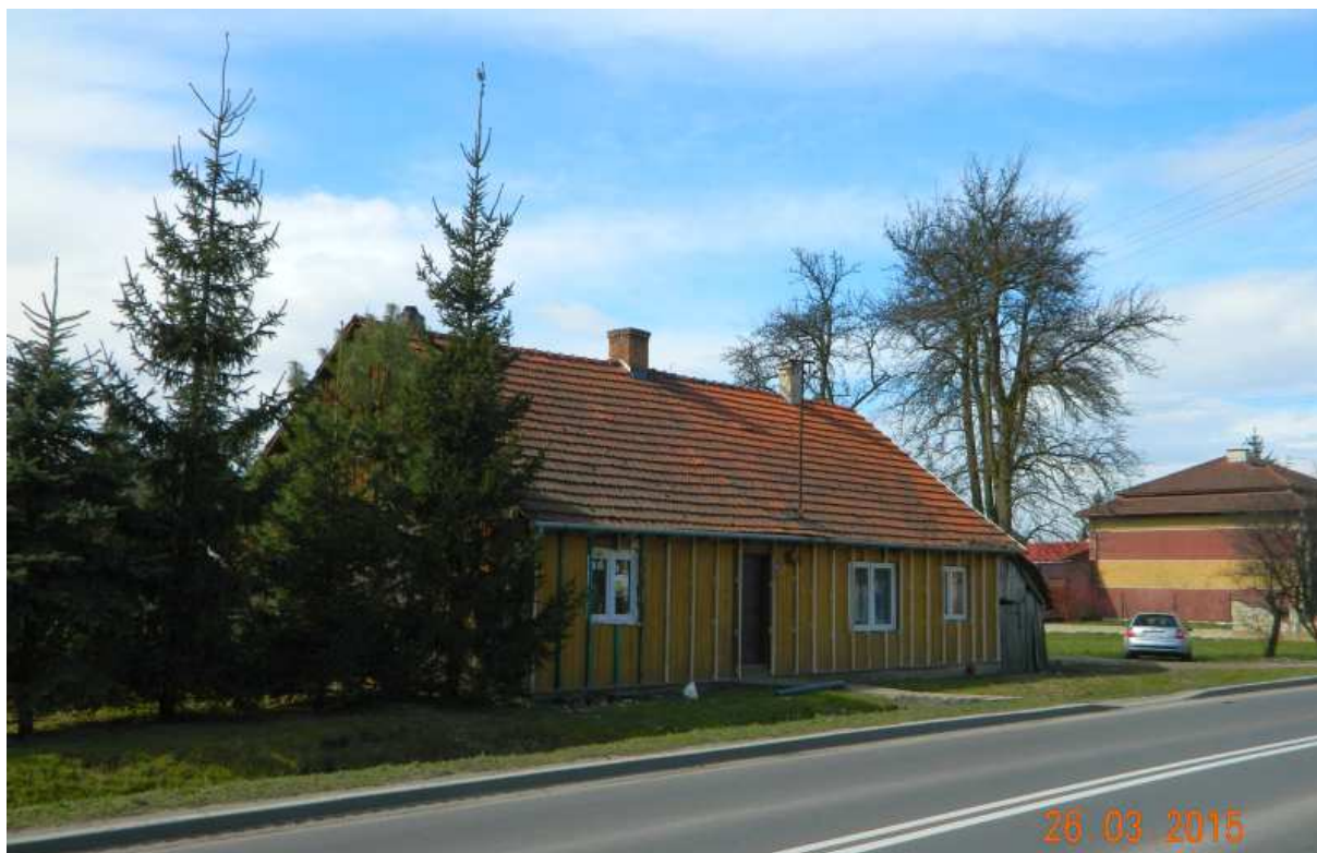
Fot. nr 407 (407-408). Przebudowana, oszalowana dawna chałupa z ulicy Łapanowskiej, już z nowymi typami okien z plastiku pod nr Gdów 82.
