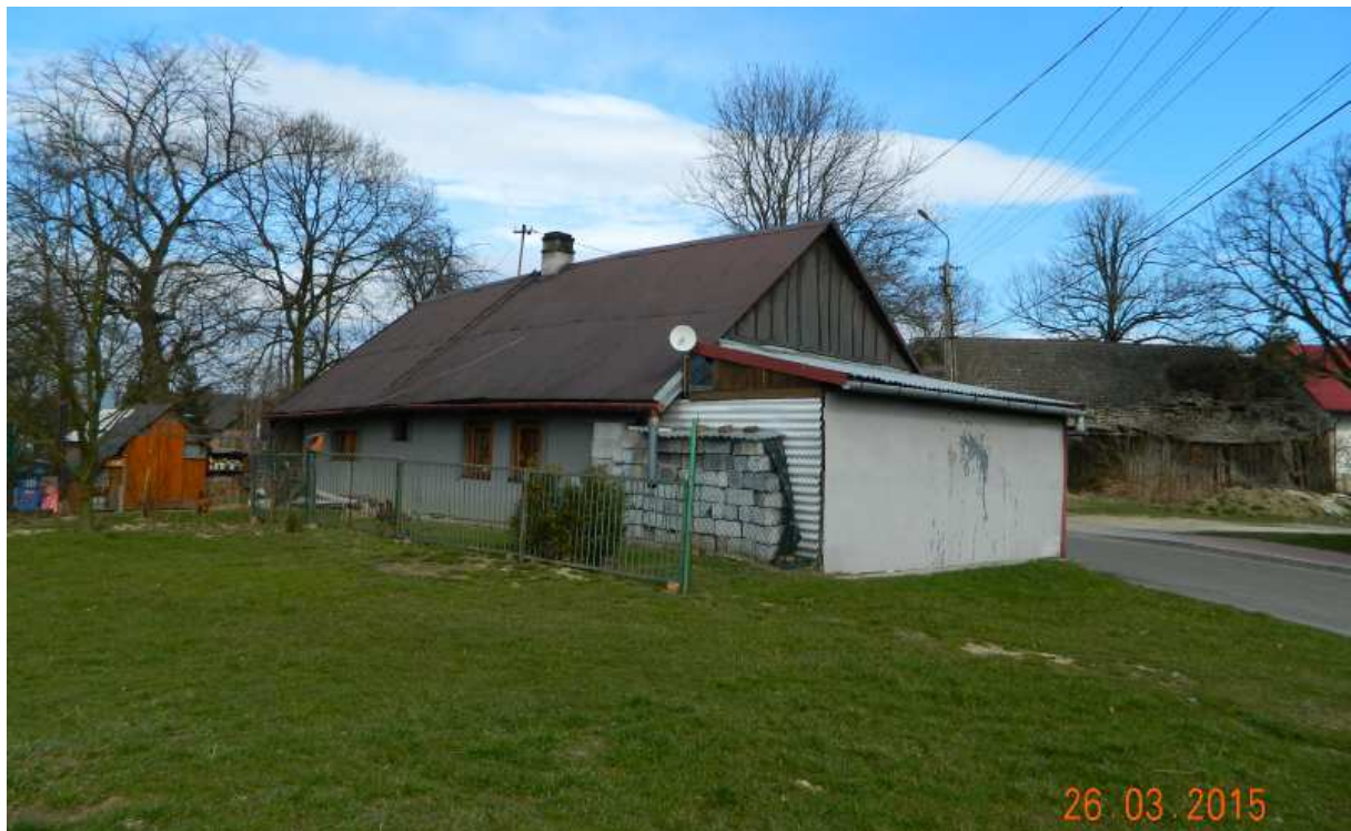
Fot. nr 312. Tylńa część chałupy.
