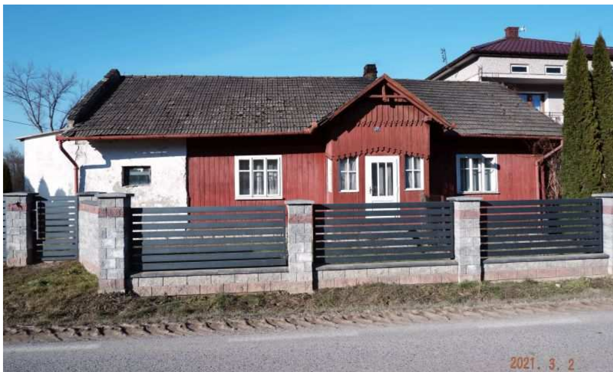
Fot. nr 564 (564-565). Oszalowana drewnianymi deskami chałupa z krytym gankiem i oknami typu weneckiego spod nr Gdów 273, która mogła powstać w latach 20. XX. wieku. Nie figuruje w GEZ.
