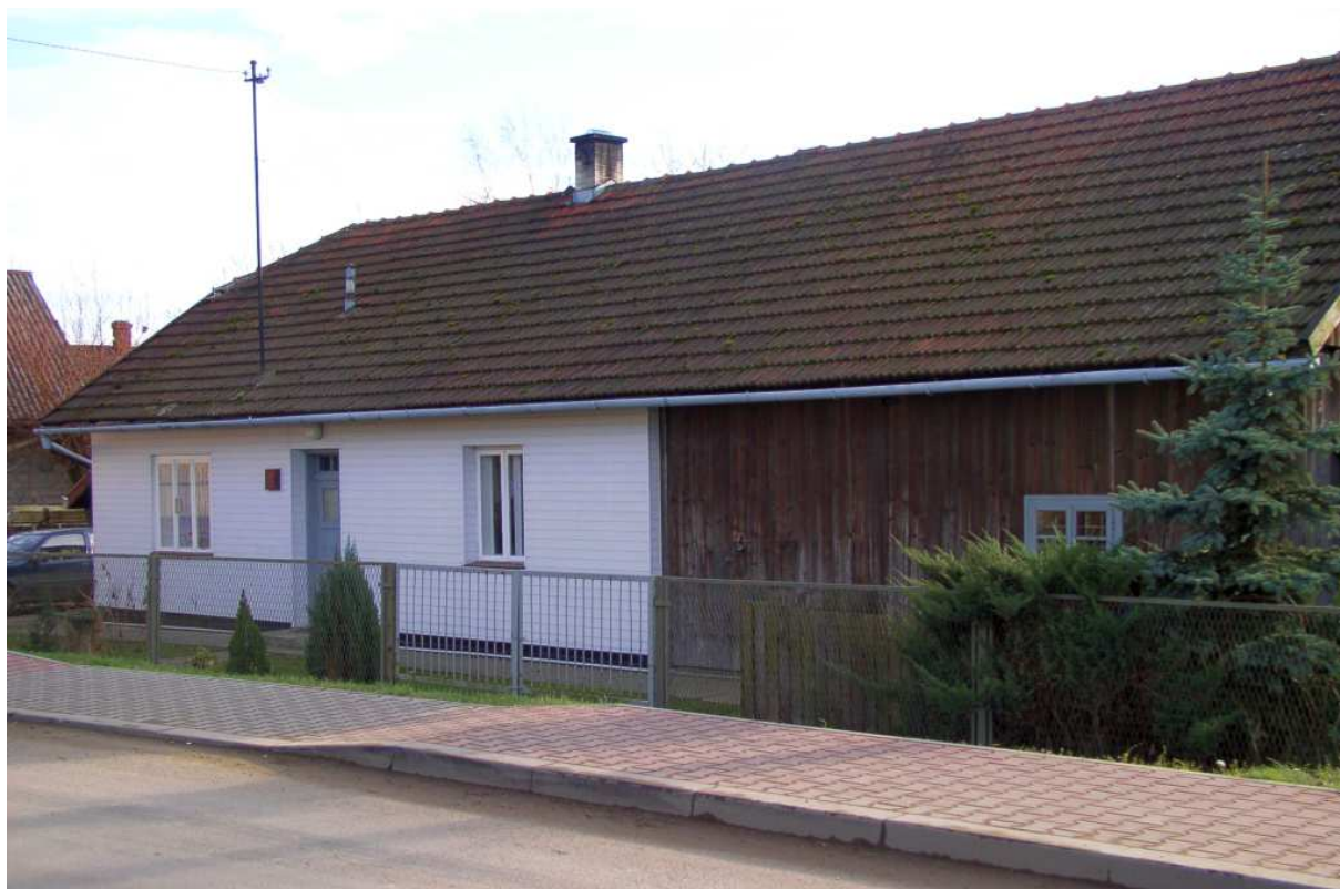
Fot. nr 463 (463-466). Ciekawy kompleks: dom mieszkalny, zapewne drewniany, zespolony z częścią gospodarczą, z początkowego fragmentu ulicy Młyńskiej pod nr Gdów 303, który mógł powstać na początku XX. wieku. (02.12.2008)
