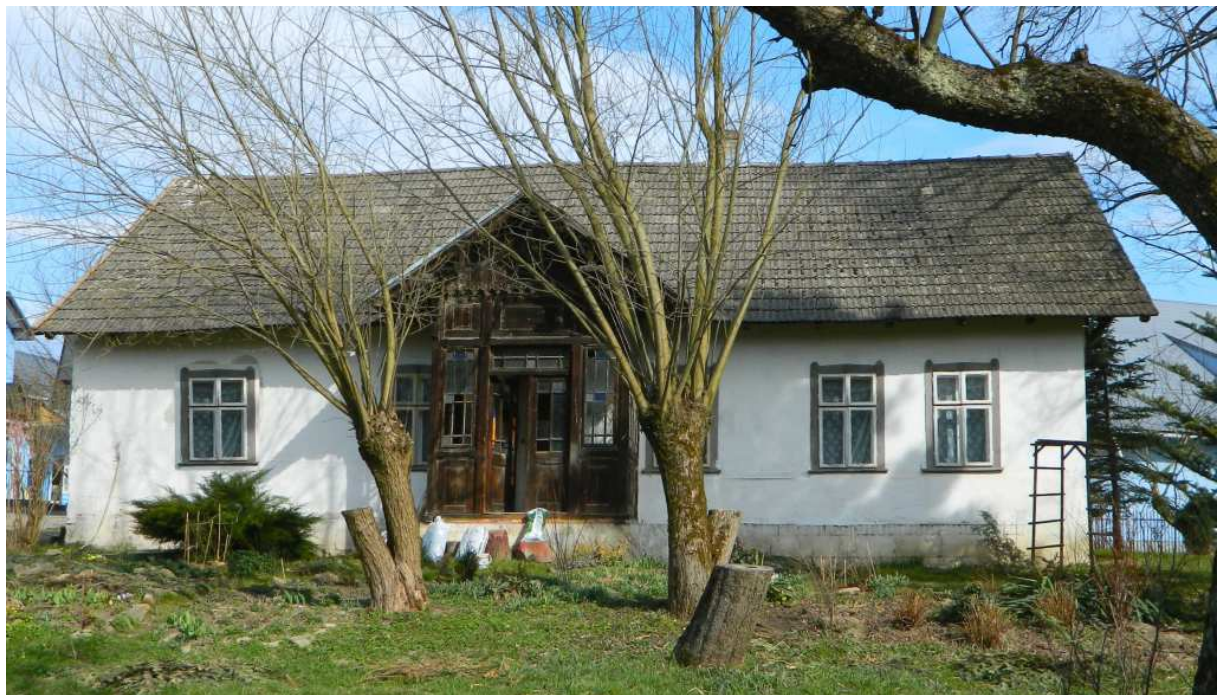
Fot. nr 386. Próba rekonstrukcji lewej, nieoryginalnej już w tym czasie części fasady, z jednym dodatkowym oknem. (26.03.2015)
