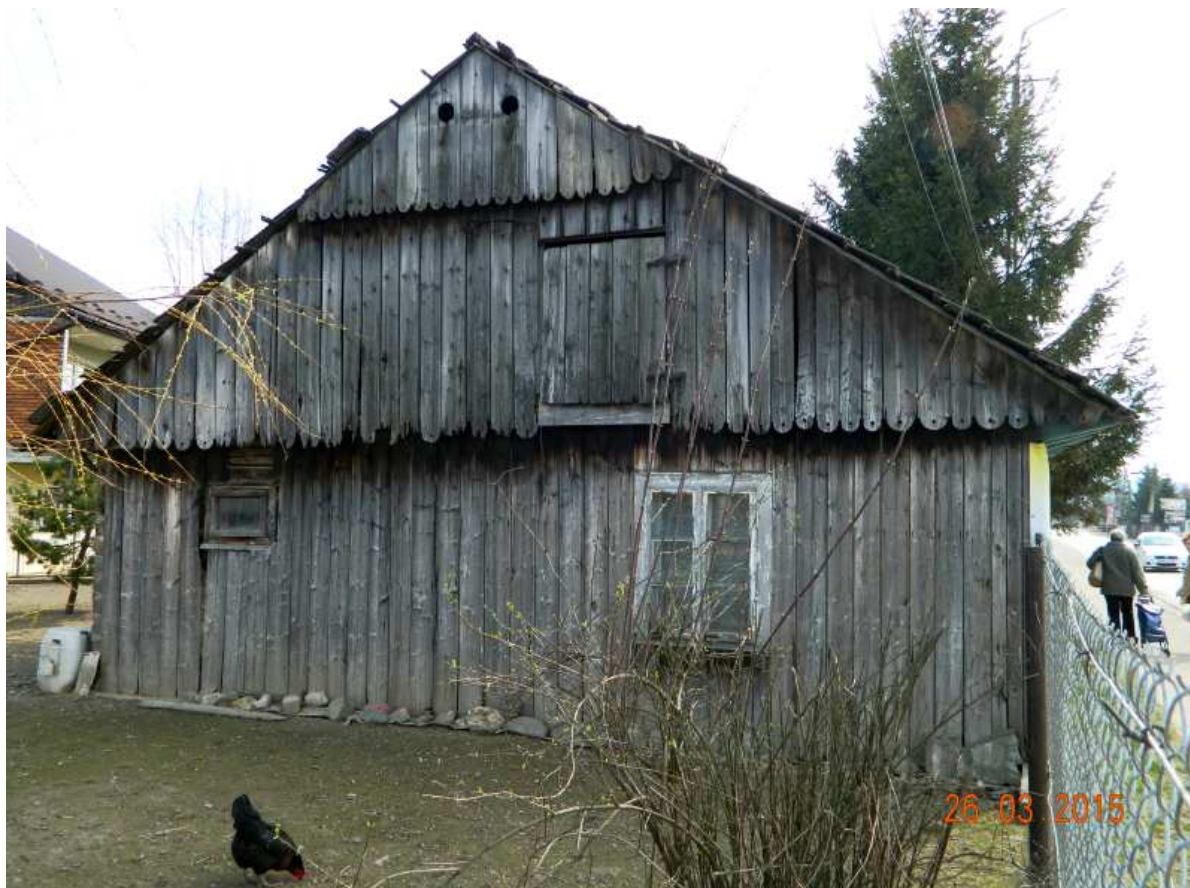
Fot. nr 418. Boczna ściana szczytowa z oryginalnym jeszcze okienkiem.
