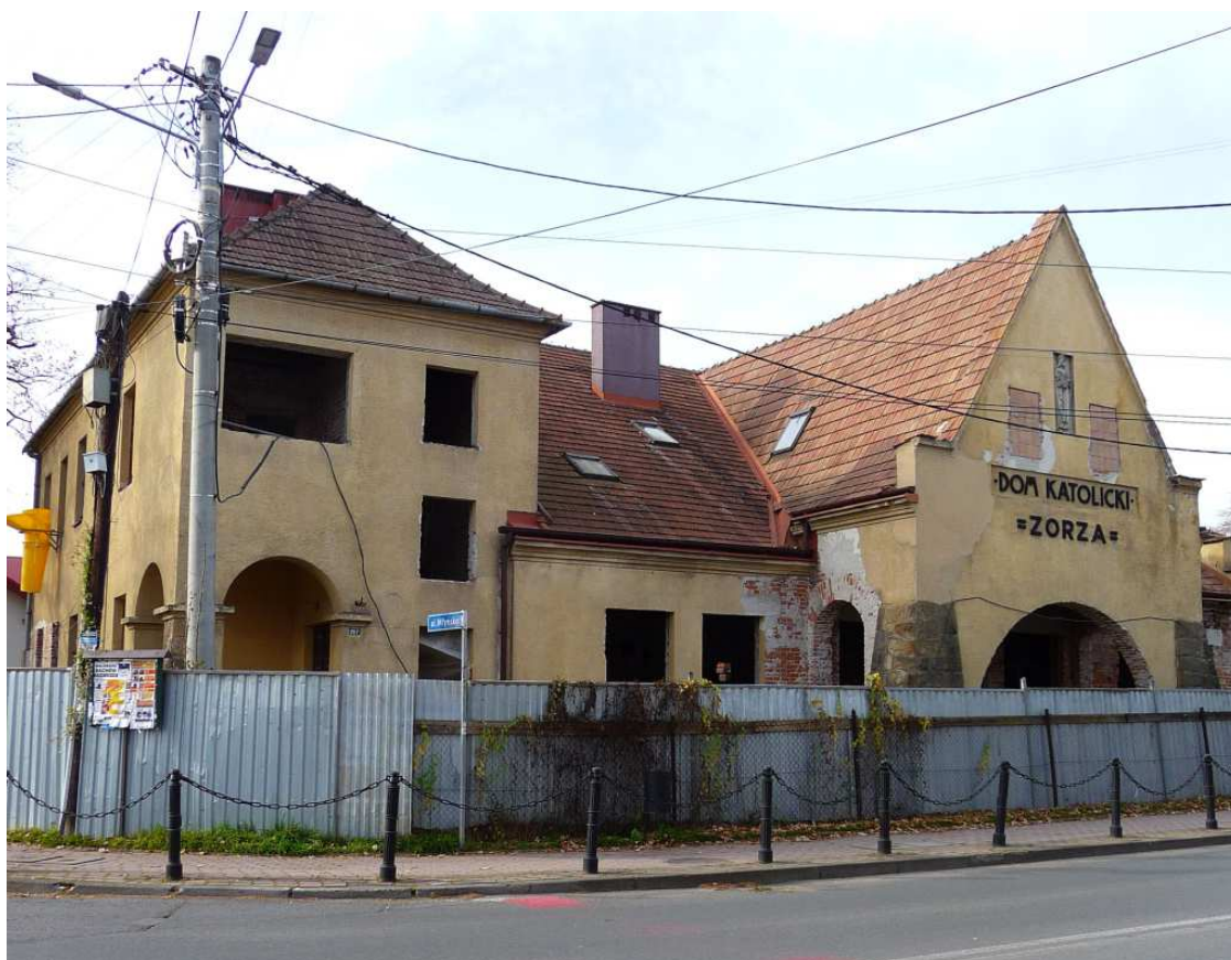
Fot. nr 462. Stan z roku 2025 na etapie remontu. (02.11.2025)
