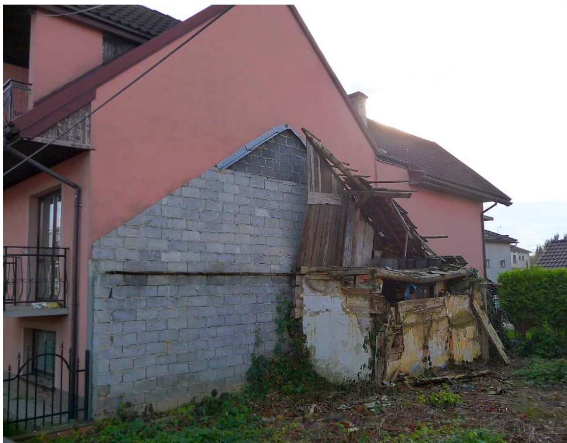
Fot. nr 120. Stan z roku 2025, po wyburzeniu. (22.10.2025)
