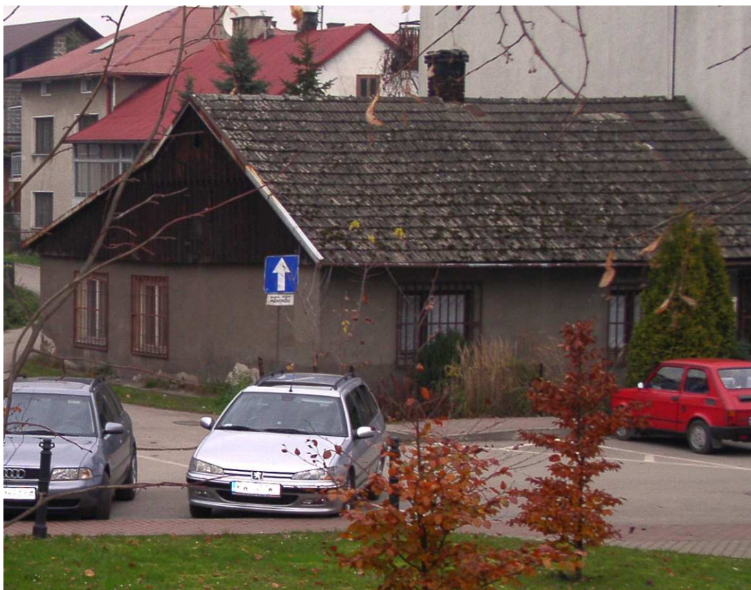
Fot. nr 131. Nieistniejący już dom przyrynkowy spod nr Gdów 524 (?). (16.11.2008)
