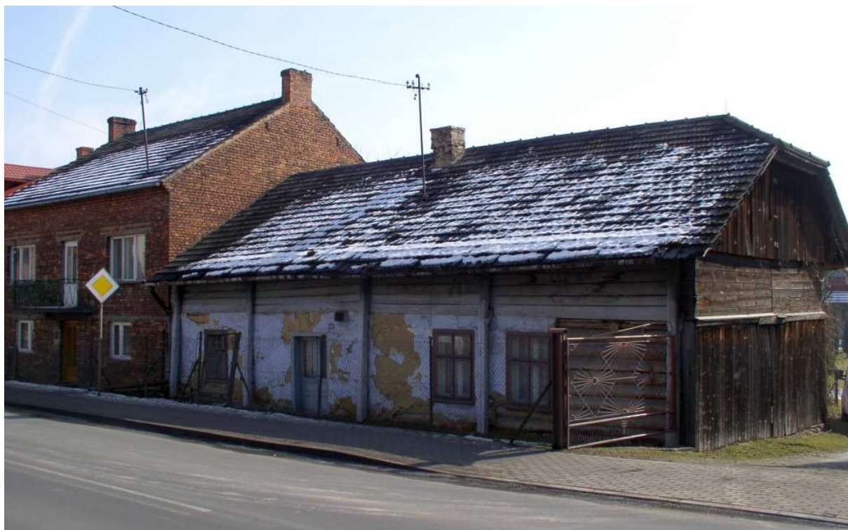
Fot. nr 236. Stan z roku 2011, niedługo przed wyburzeniem. (05.03.2011)
