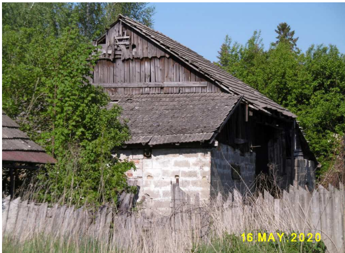
Fot. nr 335 (335-338). Drewniana stodoła i nieco późniejsza, już murowana stajnia przylegająca do chałupy pod 244.
