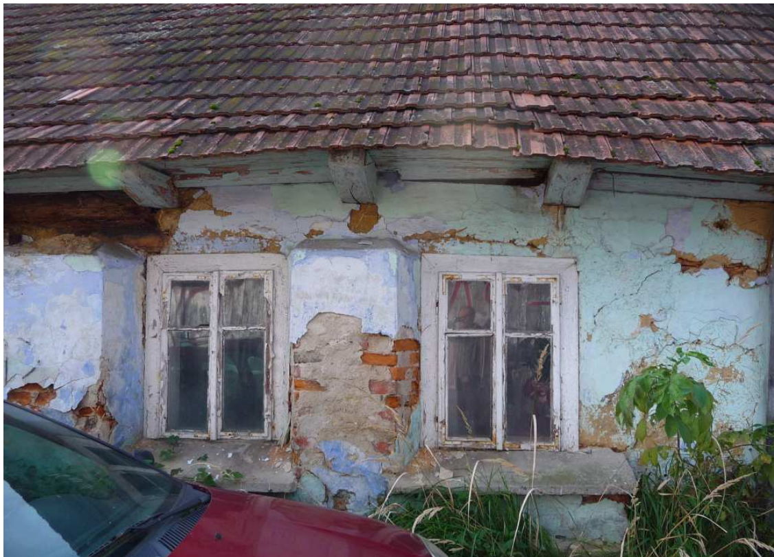
Fot. nr 542. Okienka typu ościeżnicowego, które przybliżają odległe w czasie datowanie. (22.10.2025)
