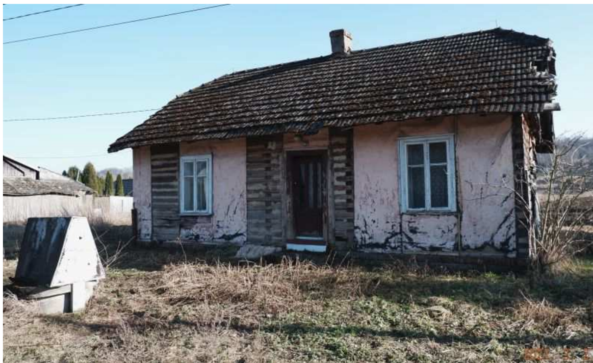
Fot. nr 560 (559-560). Fasada od strony ulicy.
