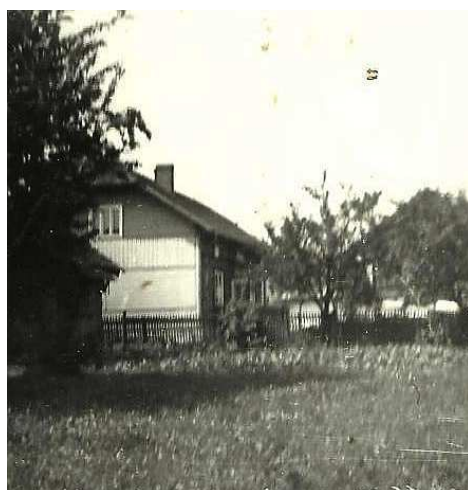
Fot. nr 16. Tył domu Łaszców.
