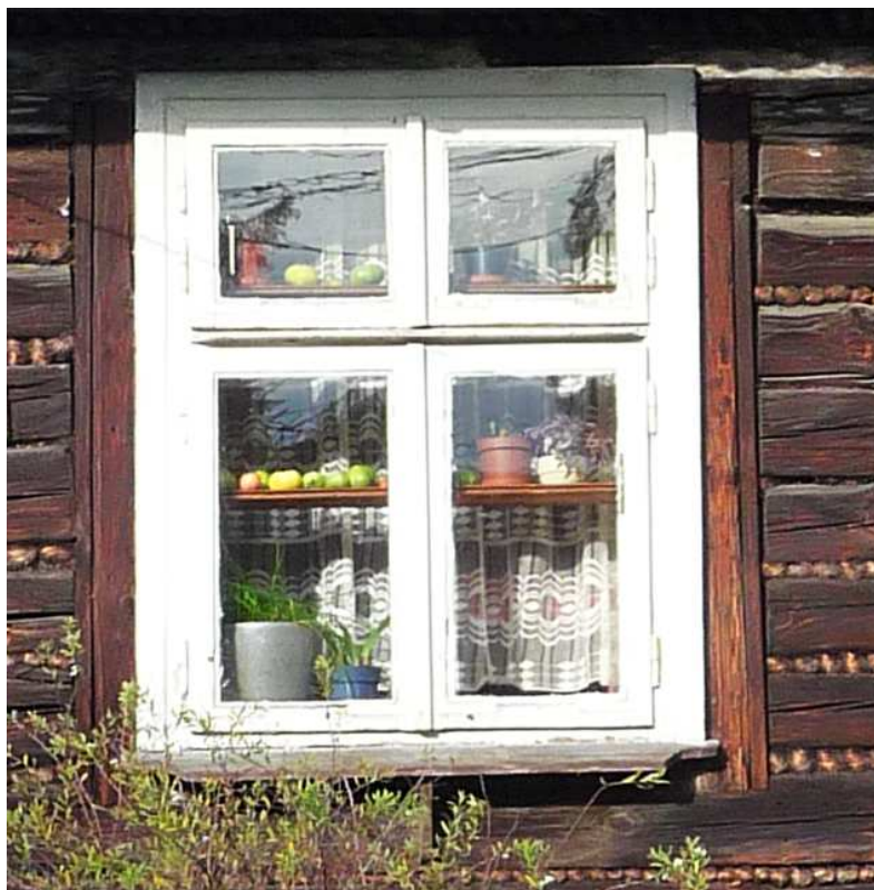
Fot. nr 532. Oryginalne okno typu skrzynkowego. (22.10.2025)
