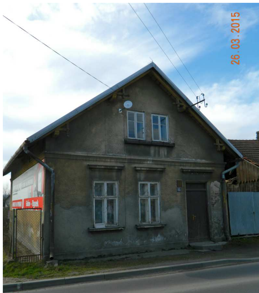
Fot. nr 429. Dom pod nr Gdów 154.
