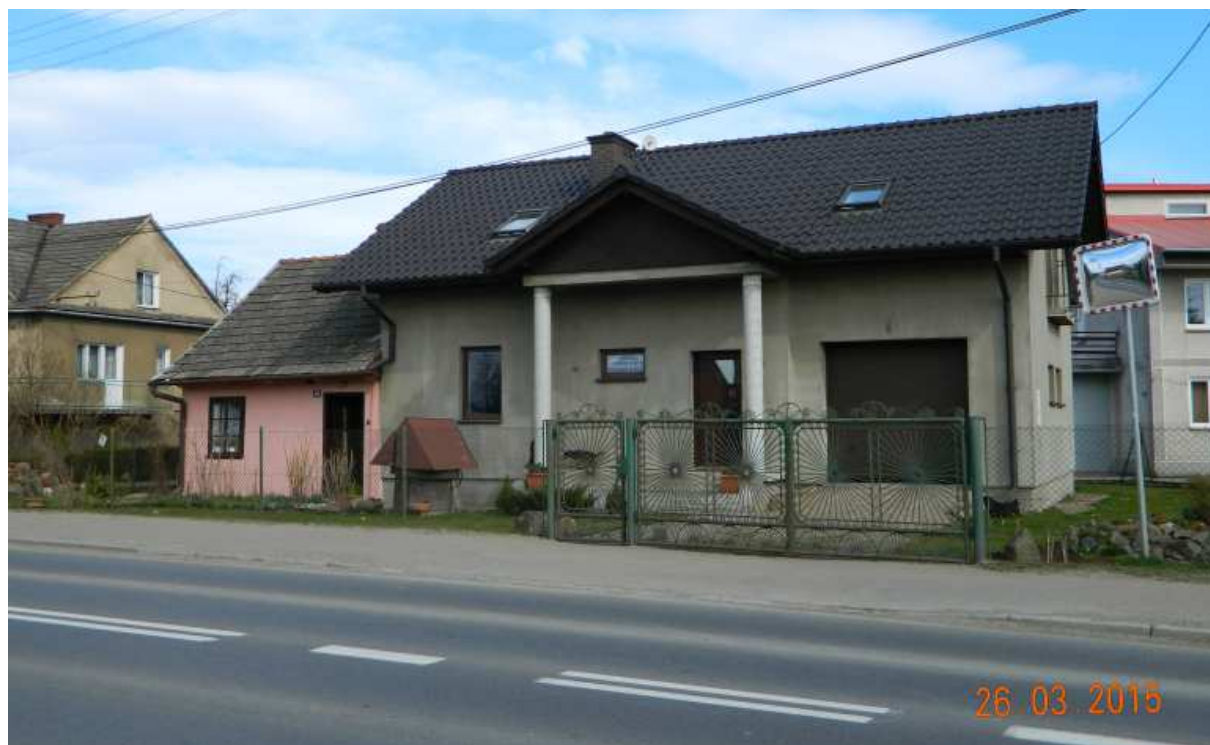
Fot. nr 422 (422-423). Widok chatki i przylegającego do niej nowego domu wg stanu z roku 2015, już po ukończonej przebudowie.
