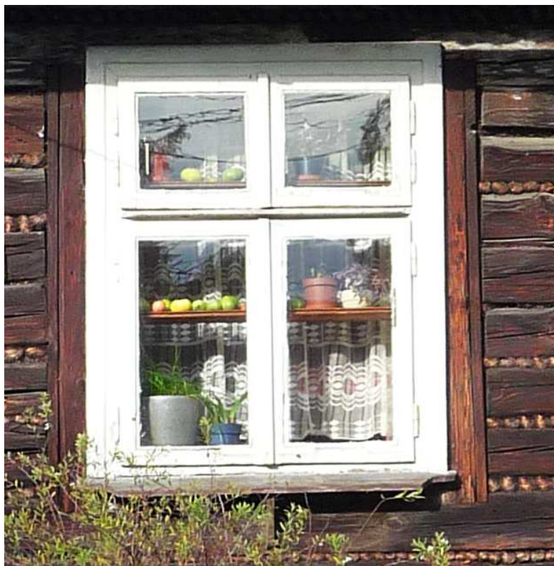
Fot. nr 532. Oryginalne okno typu skrzynkowego. (22.10.2025)
