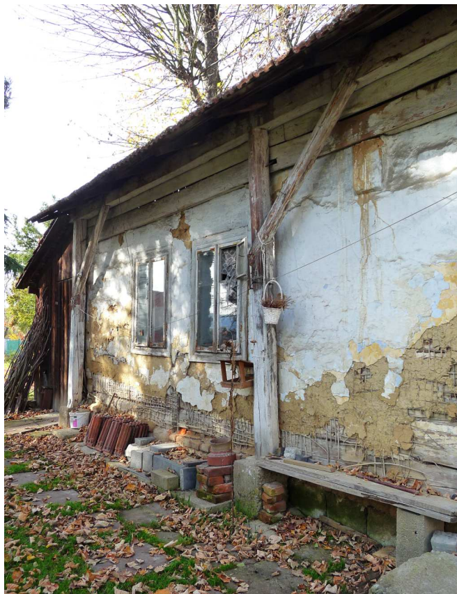
Fot. nr 224. Archaiczne okienka typu ościeżnicowego. (02.11.2025)
