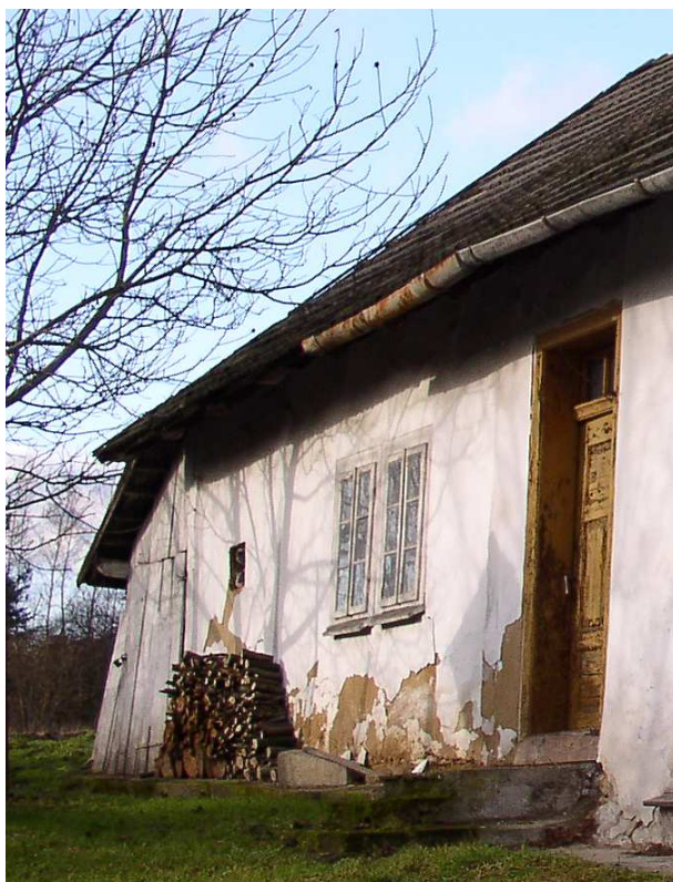
Fot. nr 350. Oryginalne dwukwaterowe, sześciopolowe okna typu ościeżnicowego, typowe dla zabudowy z przełomu wieków XIX i XX. (08.12.2008)
