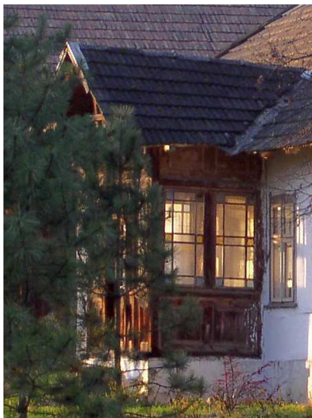
Fot. nr 380. Oszklony i zdobiony kolorowymi szybkami ganek, charakterystyczny dla zabudowy z przełomu lat 20/30 zeszłego wieku. (08.12.2008)
