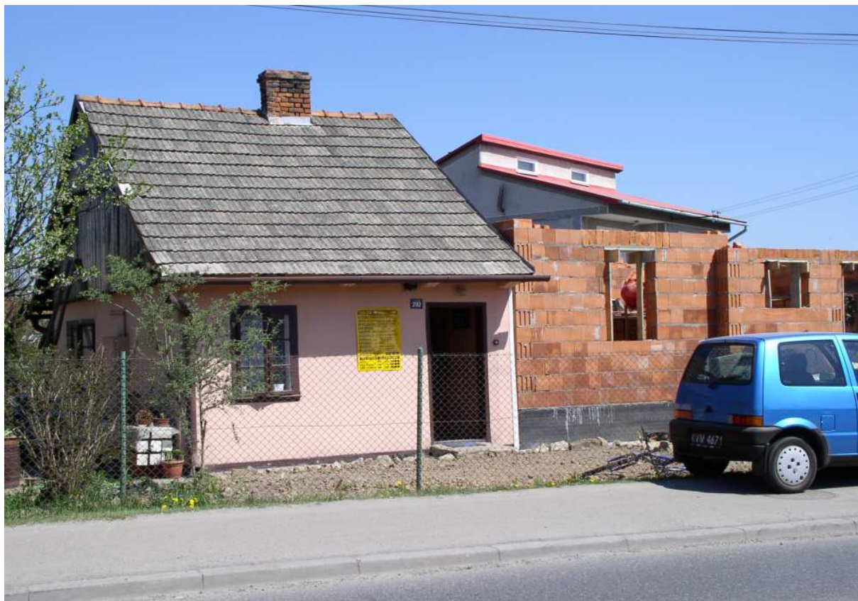
Fot. nr 421. Ujęcie z roku 2009, w trakcie rozbudowy. (25.04.2009)
