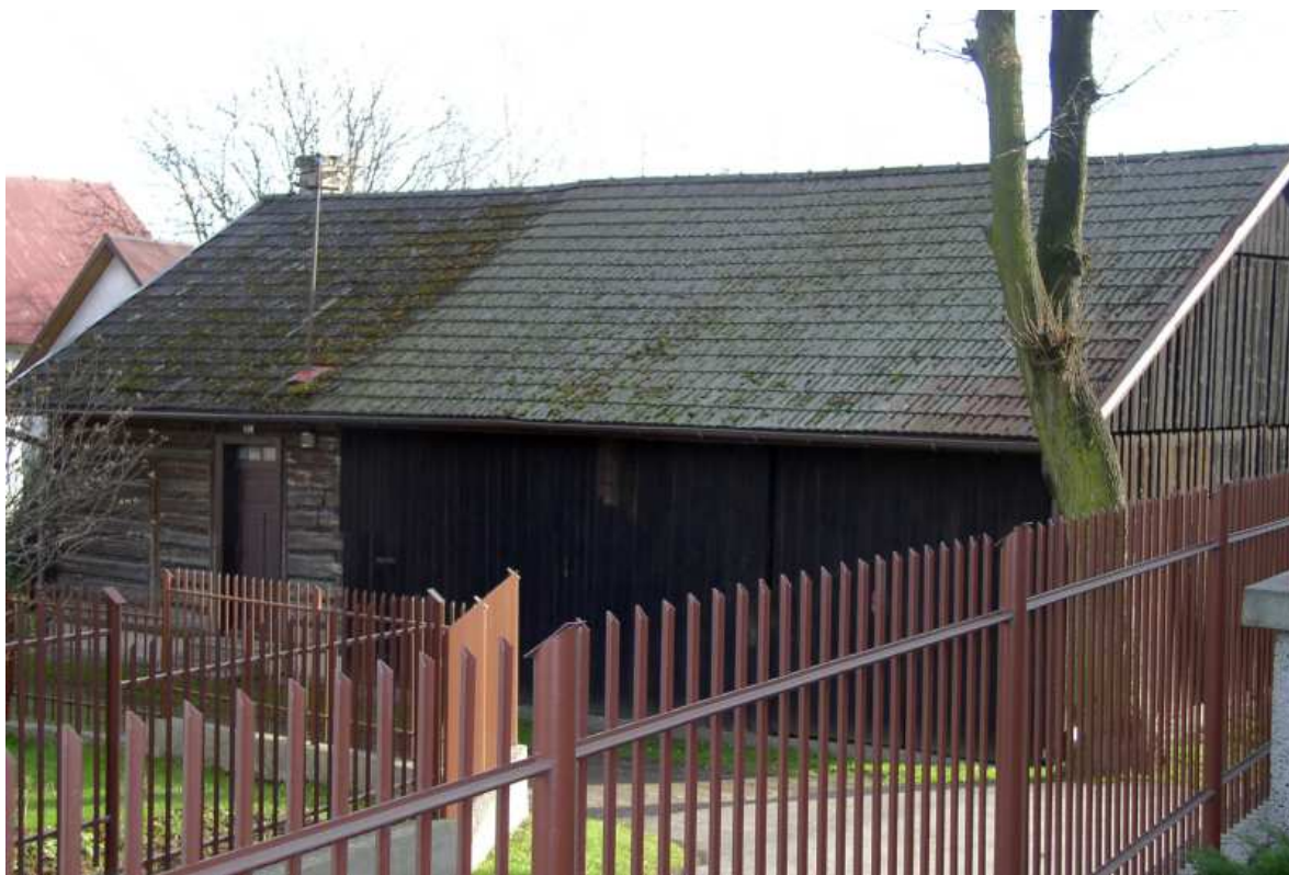
Fot. nr 158 (158-163). Zespolony ze stodołą dom mieszkalny pod nr Gdów 278, wybudowany zapewne na przełomie wieków XIX i XX. Nie figuruje w GEZ. (02.12.2008)
