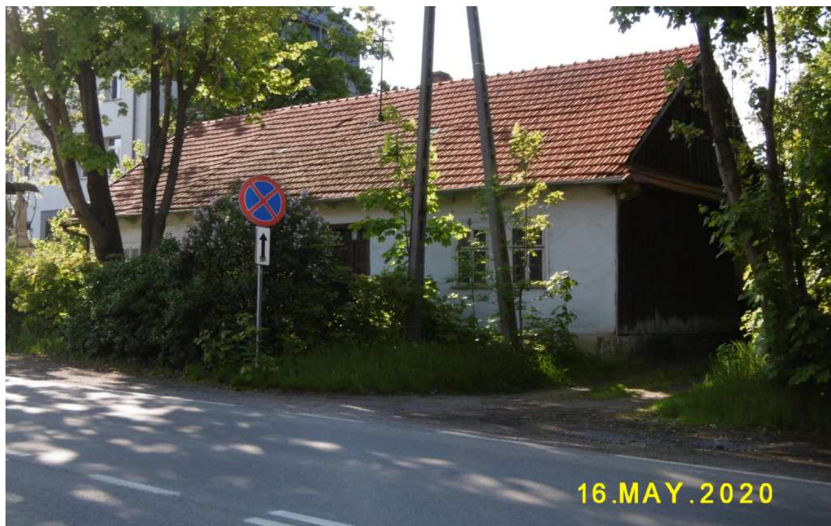
Fot. nr 264. Stan z roku 2020.
