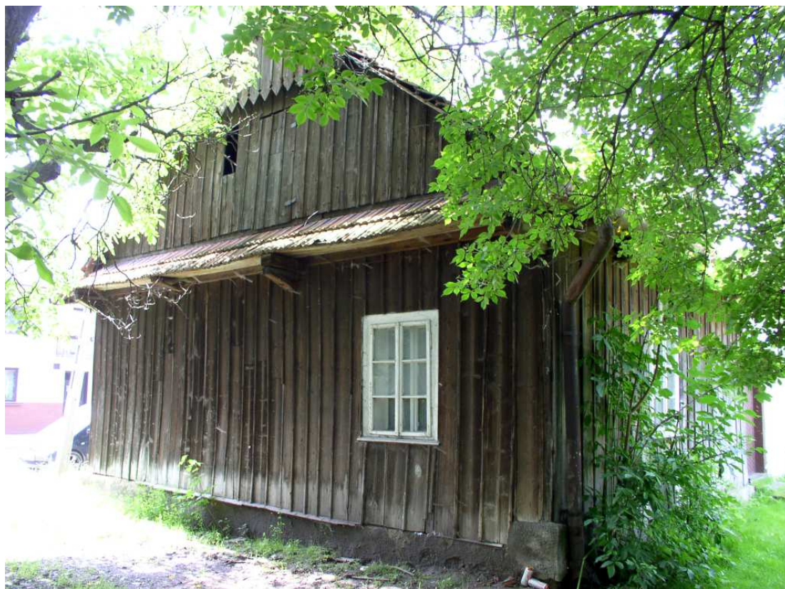
Fot. nr 269 (269-270). Boczna ściana szczytowa. (30.06.2009)
