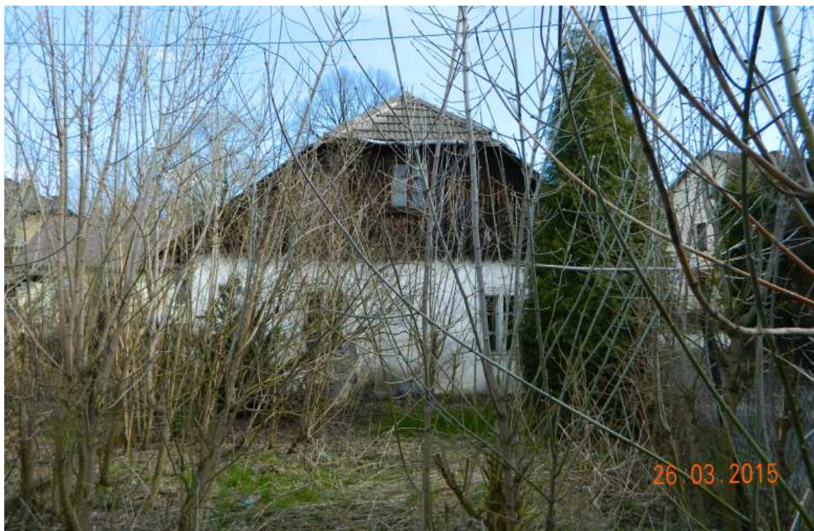
Fot. nr 151. Ściana szczytowa od strony ulicy Bocheńskiej.
