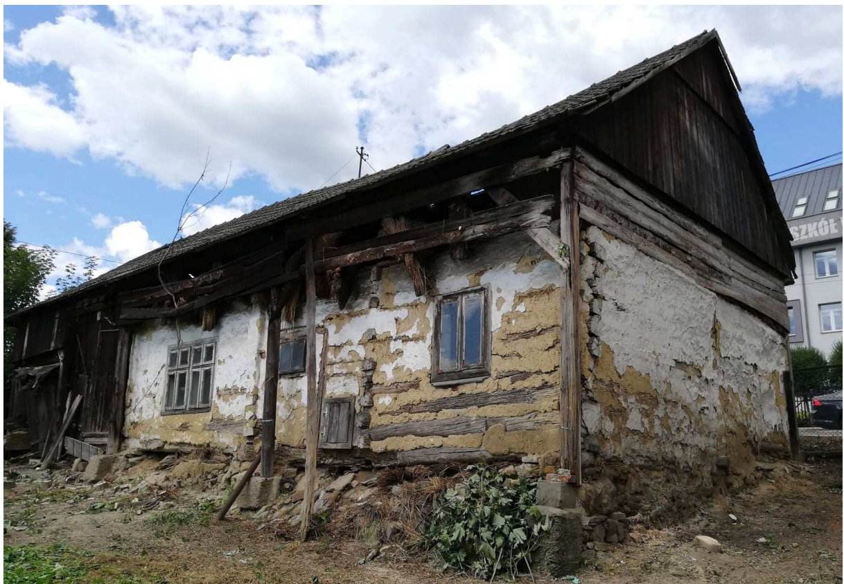
Fot. nr 227. Tylny fragment po oczyszczeniu terenu. Zdjęcie wykonane w dniu 11.08.2022
