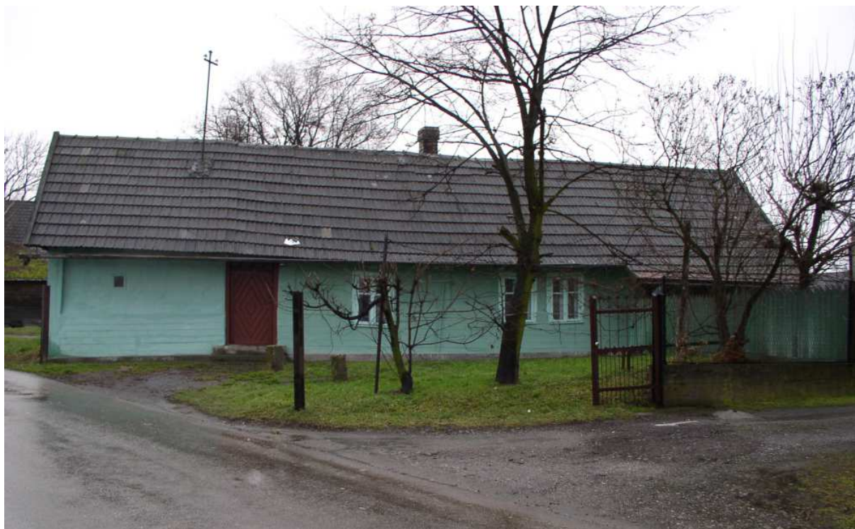
Fot. nr 316 (316-337). Chałupa w zagrodzie spod nr Gdów 244, która została wybudowana w drugiej połowie XIX. wieku i jej detale. W jednym korpusie znajduje się też część gospodarcza. Warto by zachować ją w oryginale i wykorzystać do jakichś kulturalnych bądź gastronomicznych celów, ale szanse na jej przetrwanie maleją z roku na rok. Chałupa figuruje w GEZ, ale, jak pokazuje życie, to jeszcze jej dalszego losu nie przesądza. (21.12.2008)
