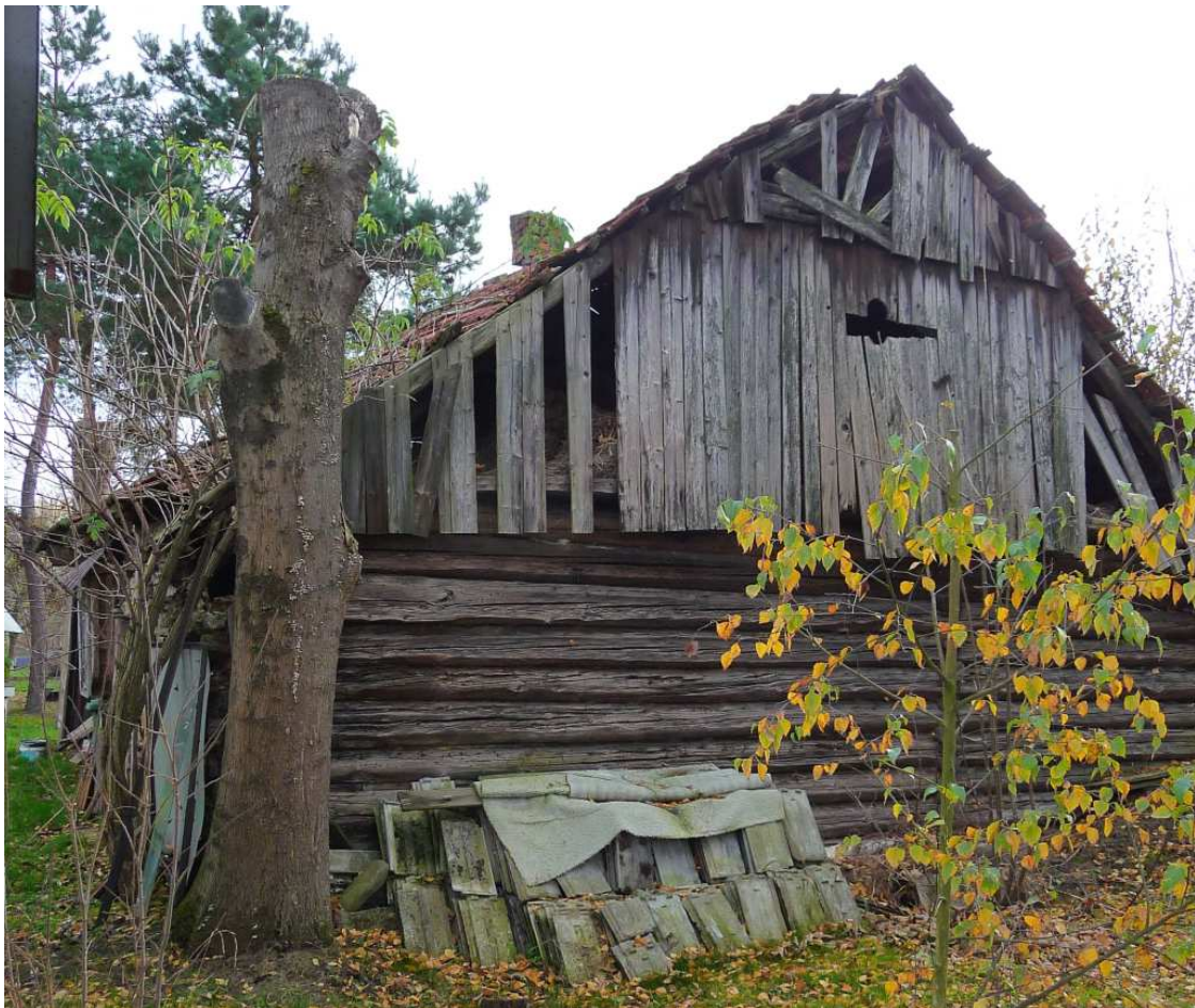
Fot. nr 490. Boczna ściana szczytowa o konstrukcji zrębowej. (02.11.2025)
