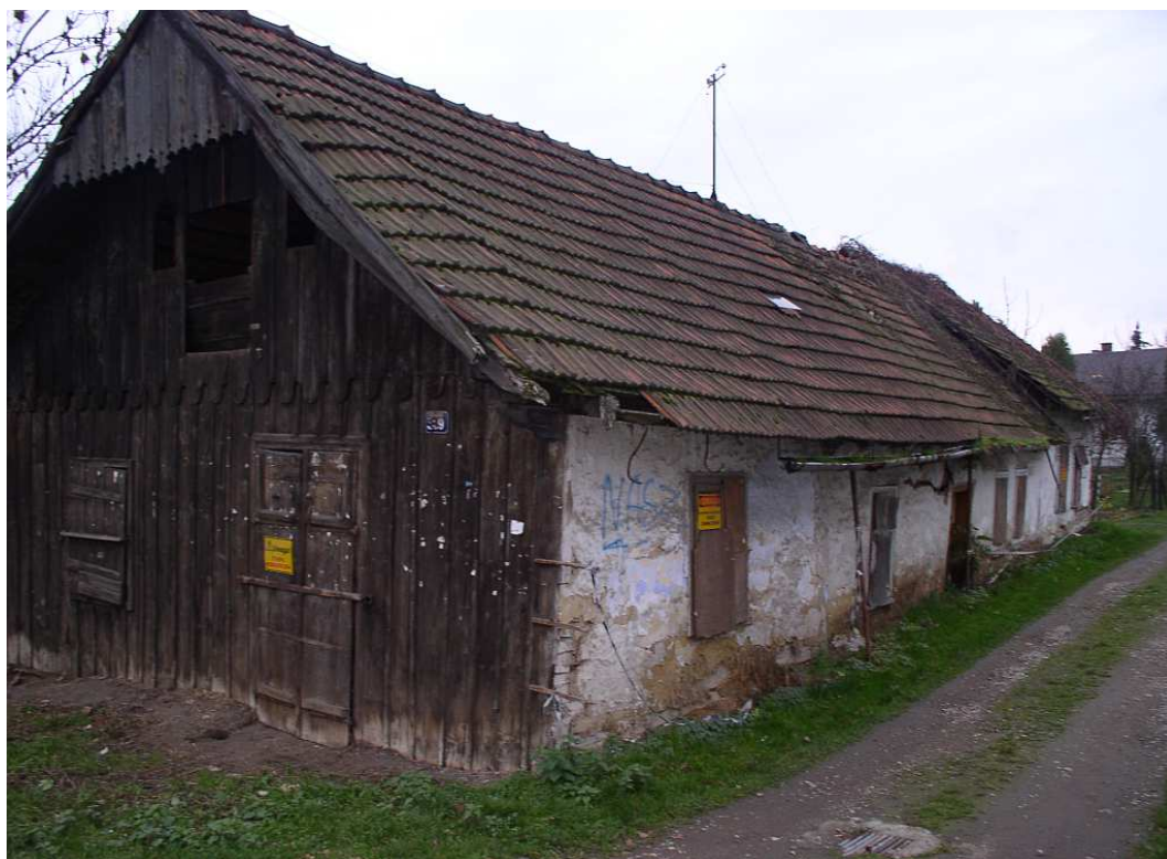
Fot. nr 193 (193-194). Bielona fasada domu przy drodze wewnętrznej. (16.11.2008)
