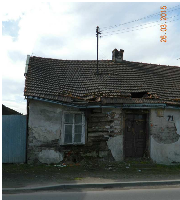
Fot. nr 433. Oryginalne belki dawnej chałupy odsłonięte spod polepy.
