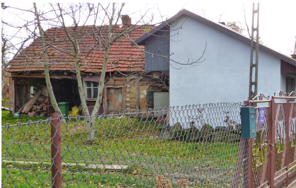
Rot. nr 488 (488-491). Zapewne XIX-wieczny relikw dawnej zabudowy Gdowa z ulicy Młyńskiej 101 (Gdów 193). Tyle dało się uchwycić z ulicy, skąd widać archaiczne detale drewniane pierwotnie bielonej chałupy.
