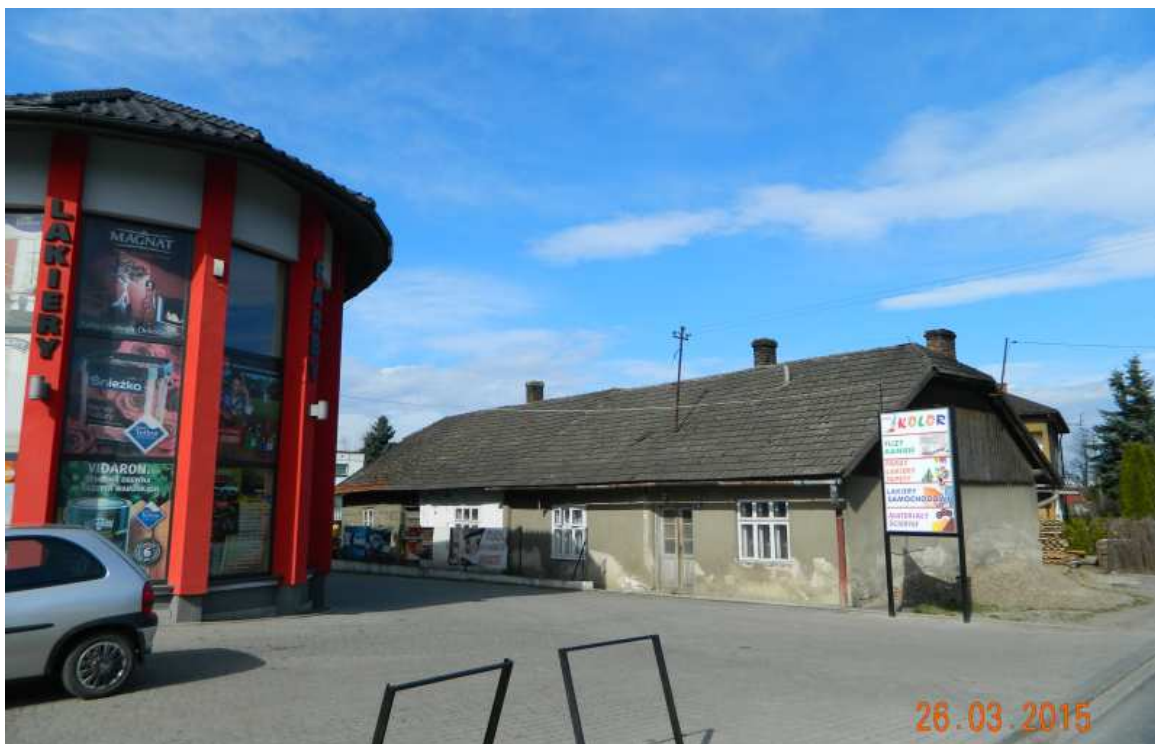
Fot. nr 395 (395-404). Zapewne rozbudowana w okresie międzywojennym dawna chałupa pod nr Gdów 64 z naroża ulic: Łapanowskiej i Zacisze. Pawilon handlowy powstał niedawno w miejscu dawnego Baru Zacisze, wybudowanego gdzieś na początku lat 60.
