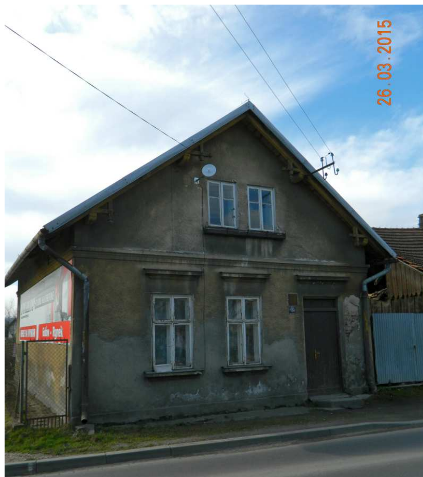
Fot. nr 429. Dom pod nr Gdów 154.
