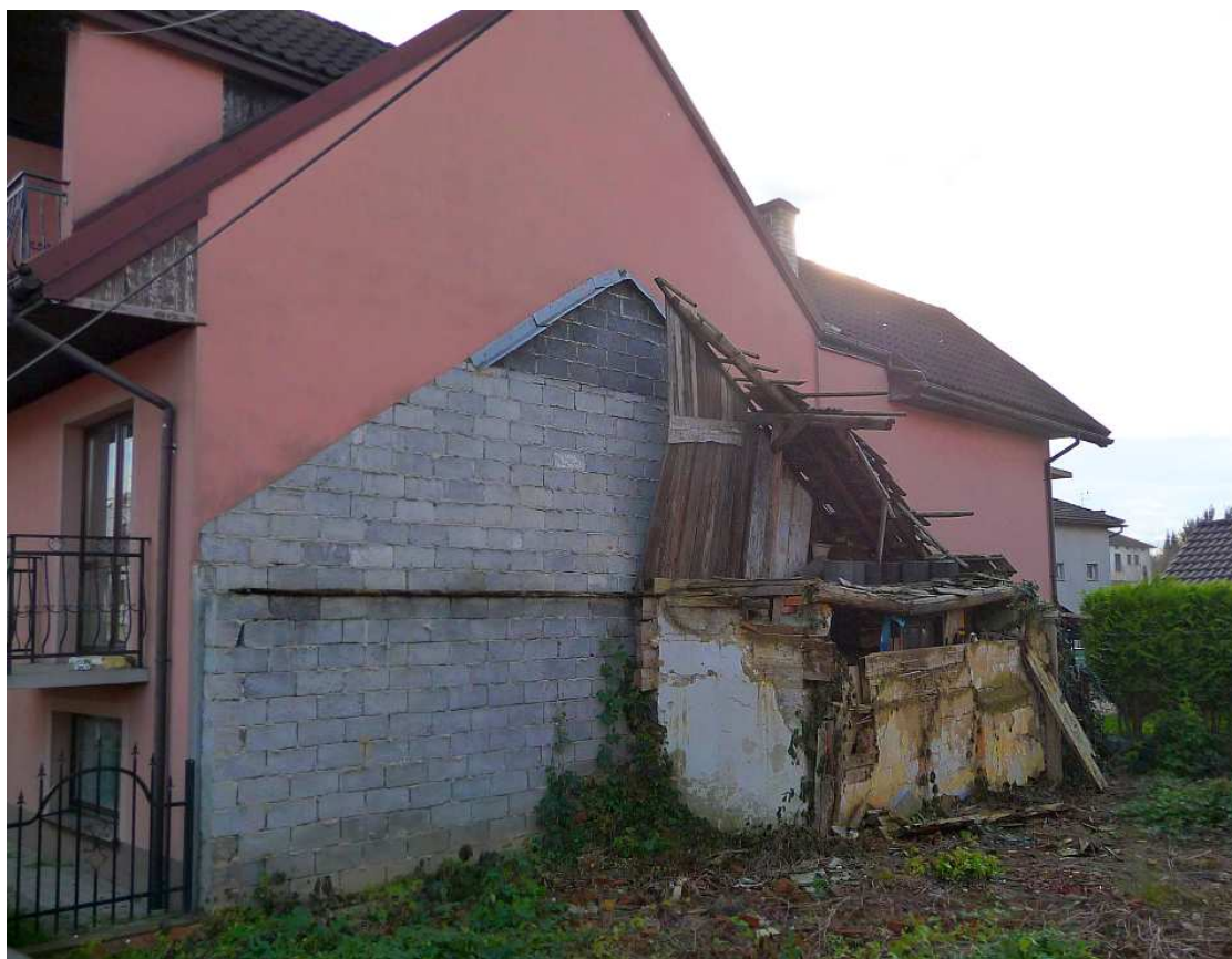
Fot. nr 120. Stan z roku 2025, po wyburzeniu. (22.10.2025)
