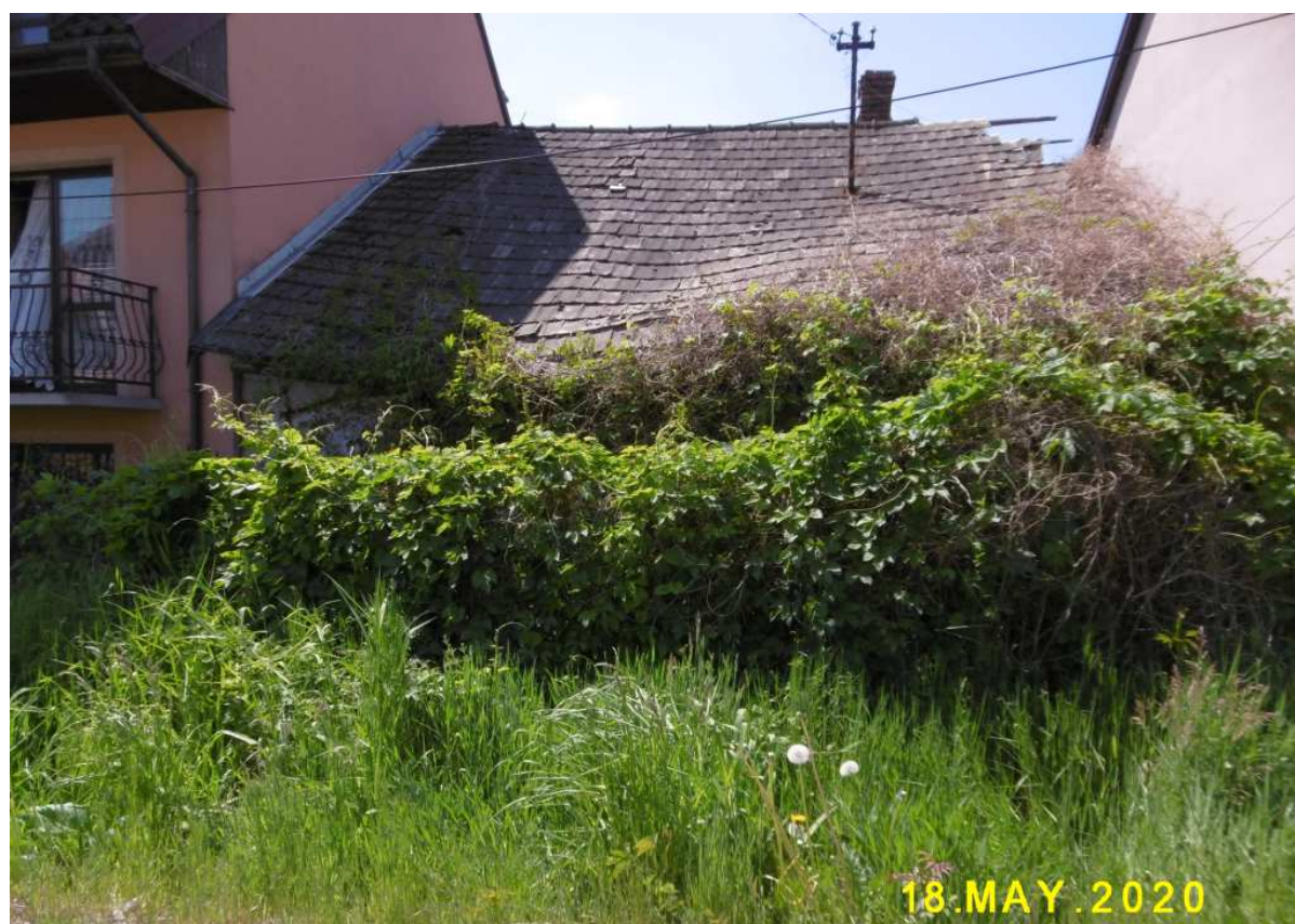
Fot. nr 118 (118-119). Zarośnięta ruina chałupy niedługo przed jej ostateczną rozbiórką.
