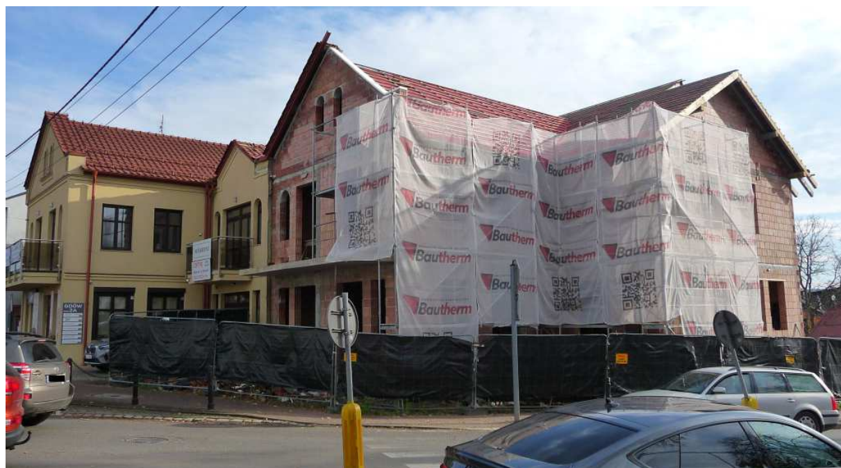
Fot. nr 502. Na etapie rozbudowy. (02.11.2025)
