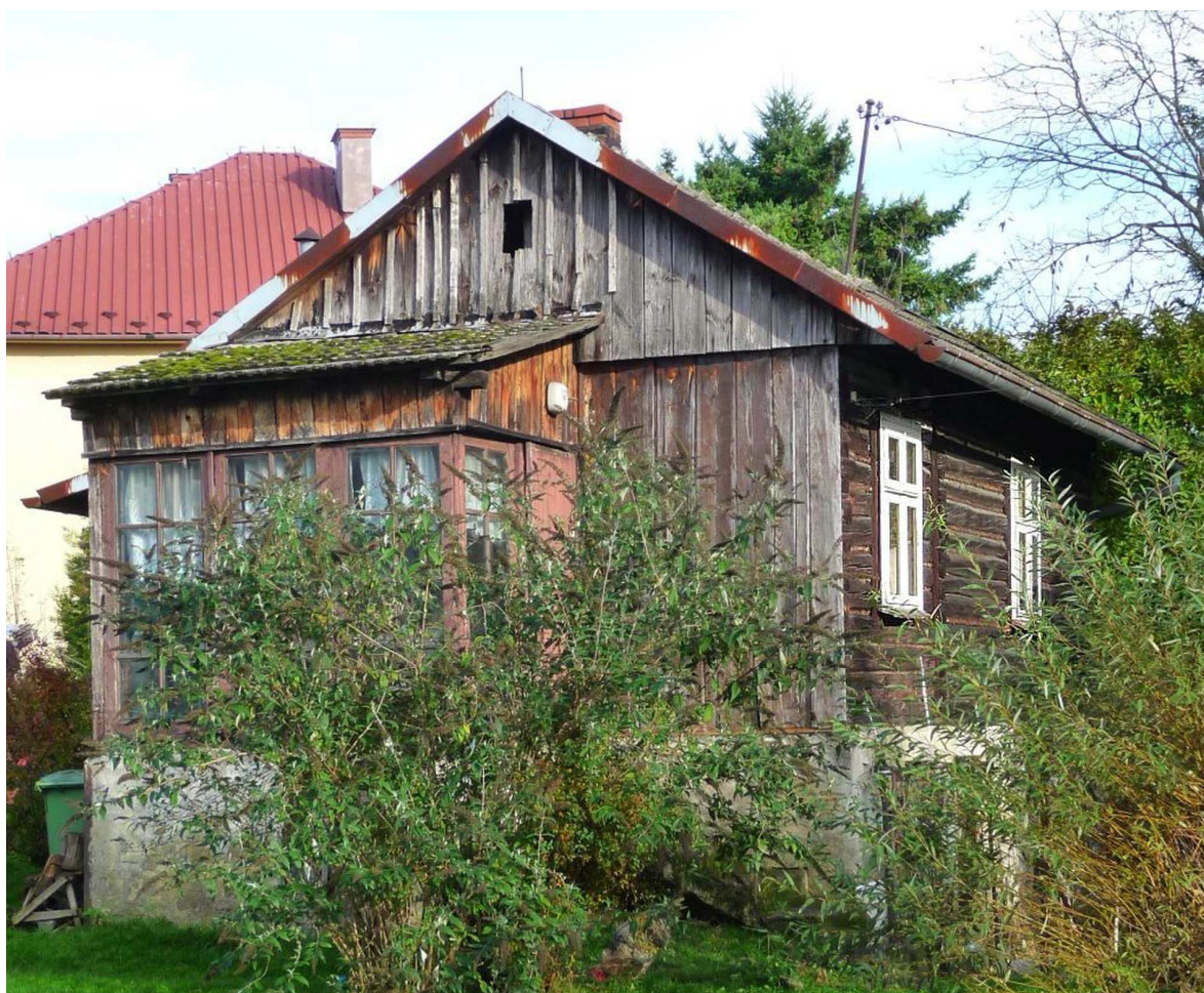
Fot. nr 534. Boczna ściana z oszklonym gankiem, późniejszym. (22.10.2025)
