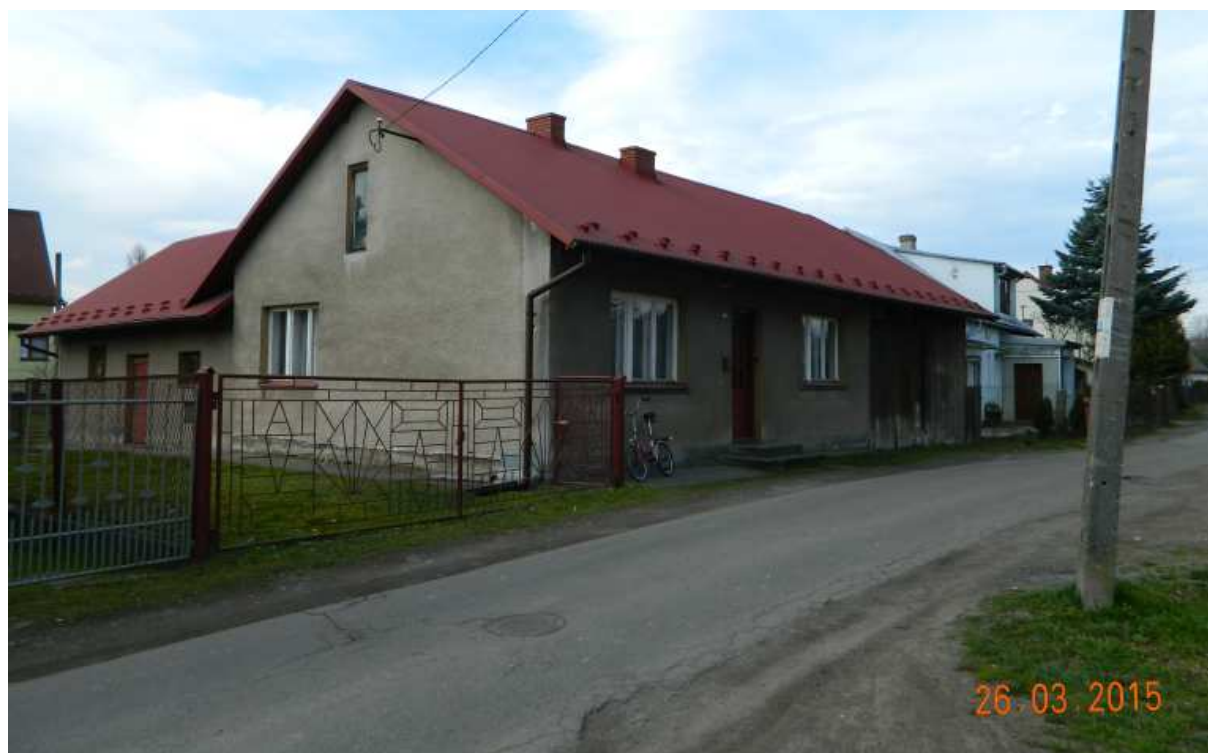
Fot. nr 473 (473-474). Murowany dom, zespolony częścią gospodarczą, z ulicy Krzywoustego spod nr Gdów 190.
