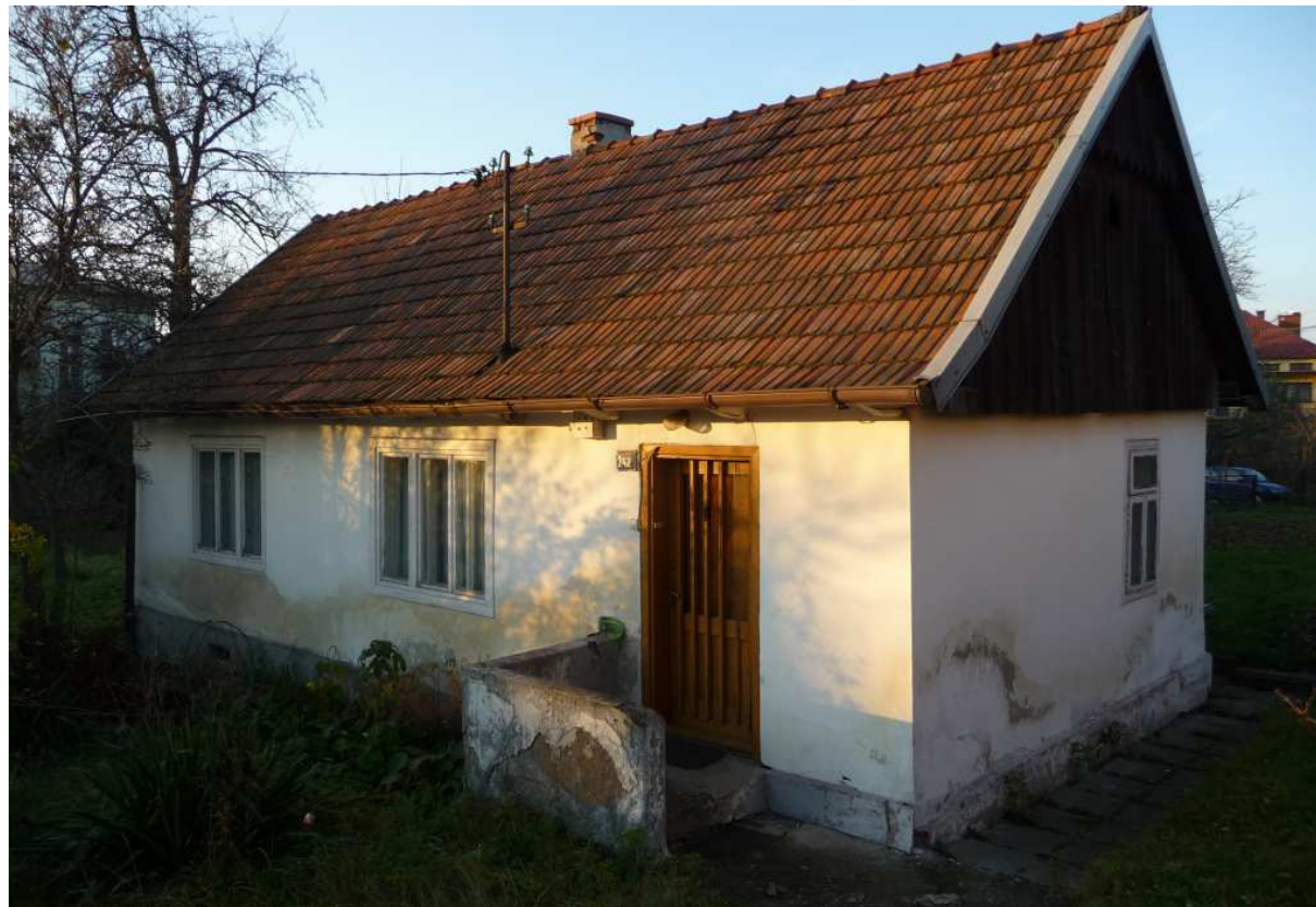
Fot. nr 520. Zapewne około 100-letni dom spod nr Gdów 242, z oryginalnym prawym bokiem i trójskrzydłowym oknem. (14.11.2012)
