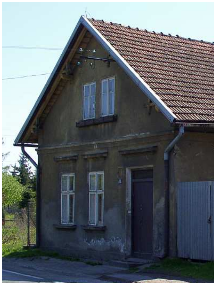
Fot. nr 427. Solidna architektura fasady domu spod nr Gdów 154. (25.04.2009)
