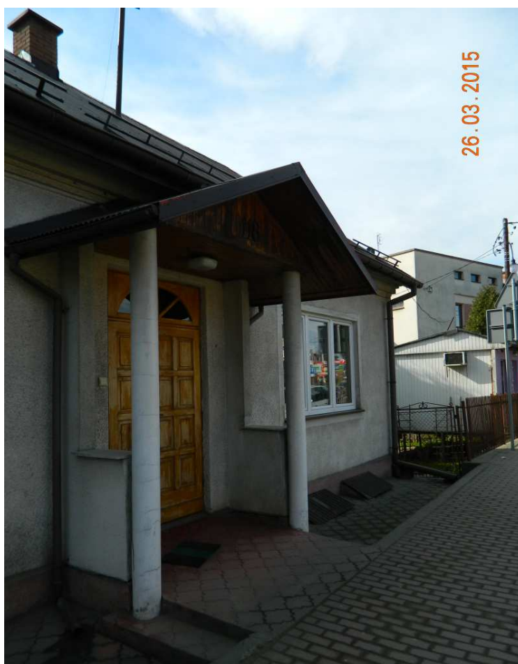
Fot. nr 173. Zadaszenie wsparte na dwóch kolumnach.
