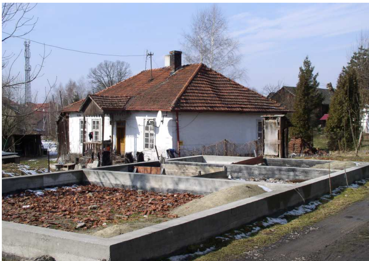
Fot. nr 185 (185-186). Z fundamentami zburzonego już domu spod nr Gdów 309 na pierwszym planie. (05.03.2011)
