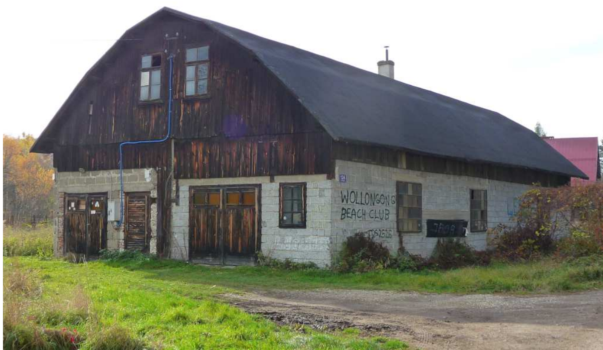
Fot. nr 492. Dawny tartak w zespole młyna przy ulicy Młyńskiej pod nr 124 (Gdów 50), który podobnie jak młyn został wybudowany w roku 1943. (02.11.2025)
