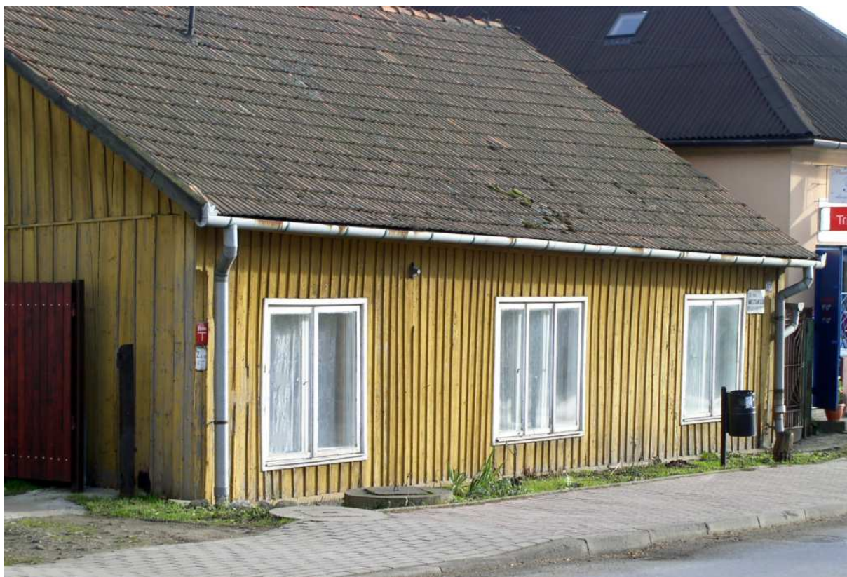
Fot. nr 453. Zburzona już dawna chałupa spod nr 331. (02.12.2008)
