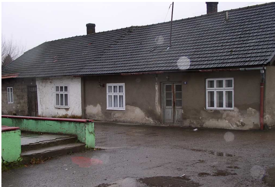
Fot. nr 396. Fasada z oknami typu weneckiego, typowymi dla przełomu lat 20/30 XX wieku. W lewym fragmencie fasady pozostało archaiczne okienko typu ościeżnicowego, zapewne pamiątka po pierwotnej, najpewniej starszej chałupie. (21.12.2008)
