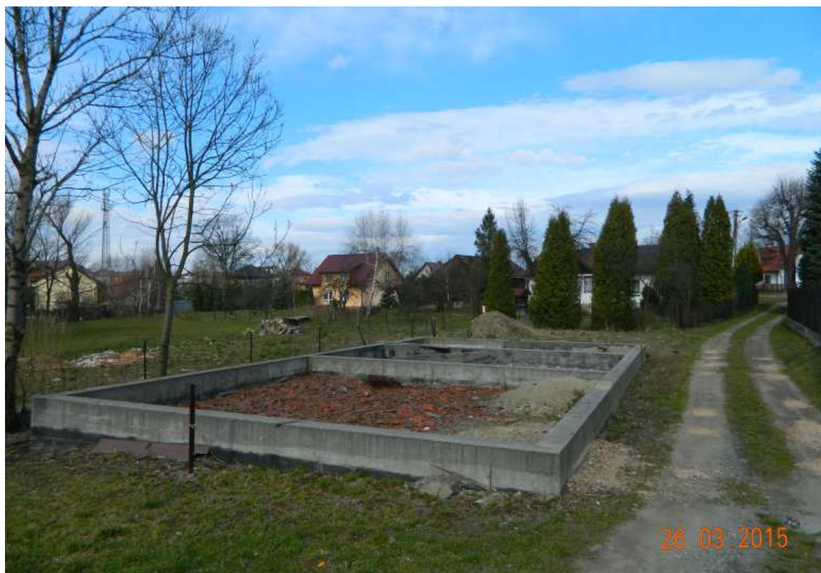
Fot. nr 195 (195-196). A tu już pusta przestrzeń i fundamenty po wyburzonym w roku 2009 obiekcie.
