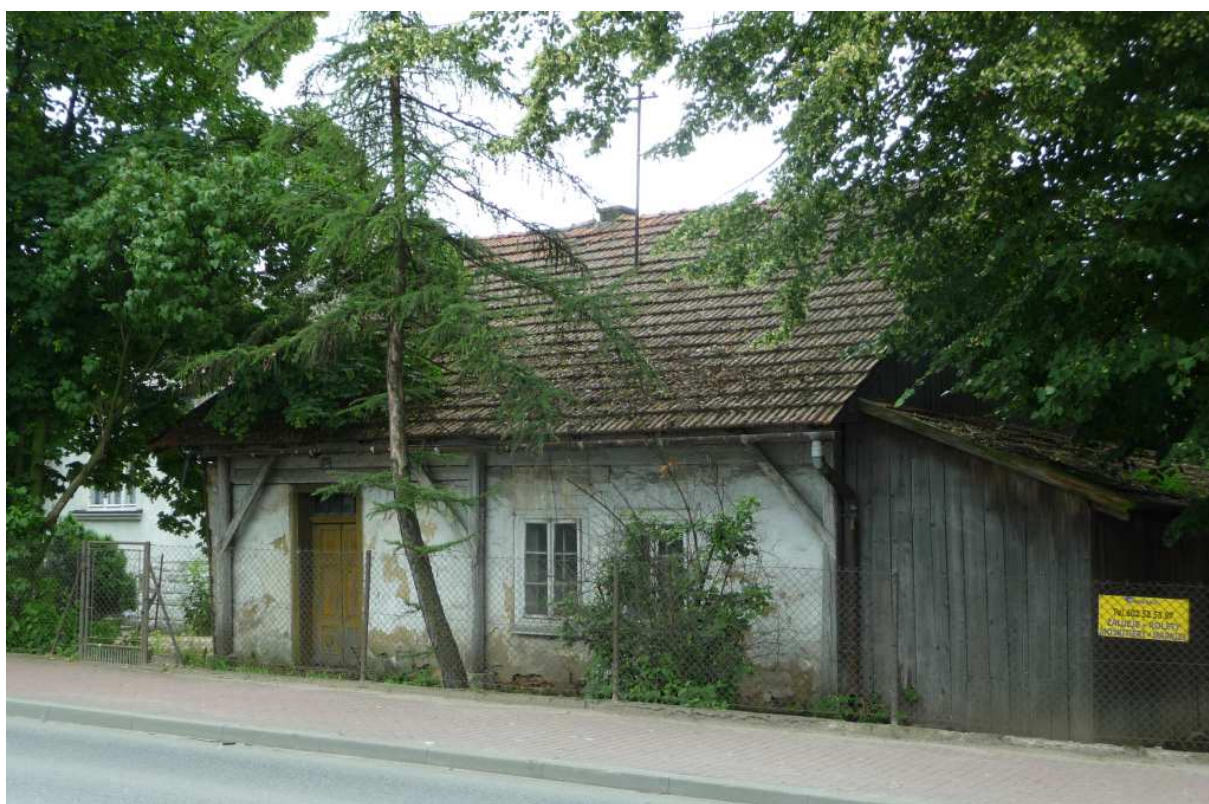
Fot. nr 209 (208-212). Widoki z roku 2013. W fasadzie konstrukcja przysłopowa. (13.06.2013)
