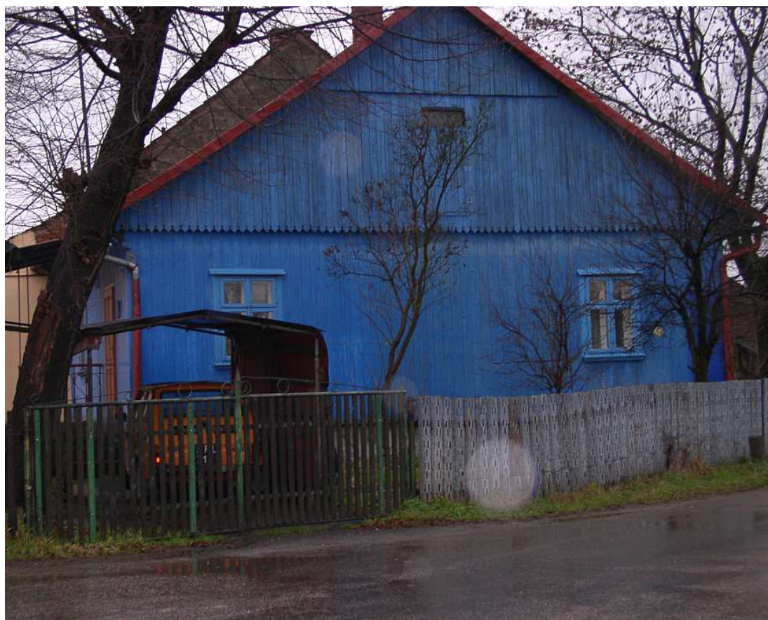
Fot. nr 287 (287-291). Zapewne około 100-letni dom z naroża ulic: Bocheńskiej i Obrytka spod nr Gdów 186, remontowany na początku II. dekady XXI. wieku. Fot. nr: 287-288. Dawny wygląd z roku 2008. (21.12.2008)
