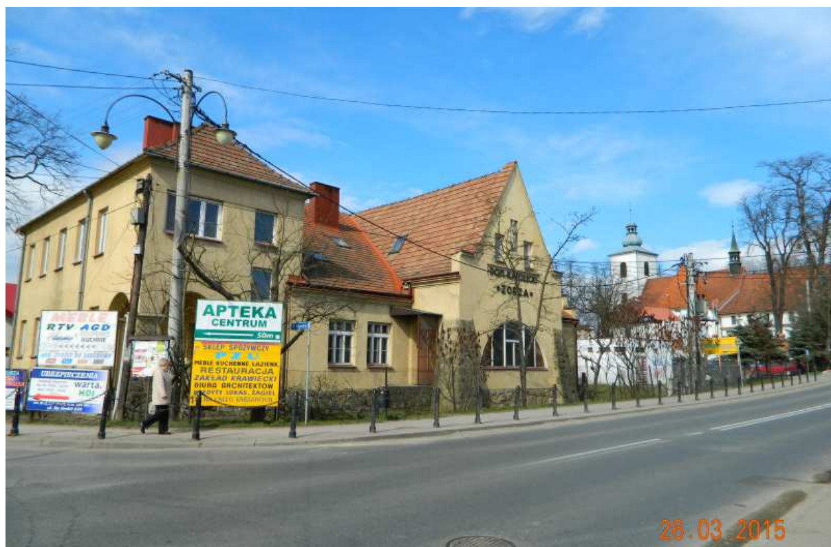
Fot. nr 459 (459-462). Międzywojenny budynek Domu Katolickiego Zorza pod nr Gdów 207, wybudowany w narożu ulic: Łapanowskiej i Młyńskiej około roku 1930.
