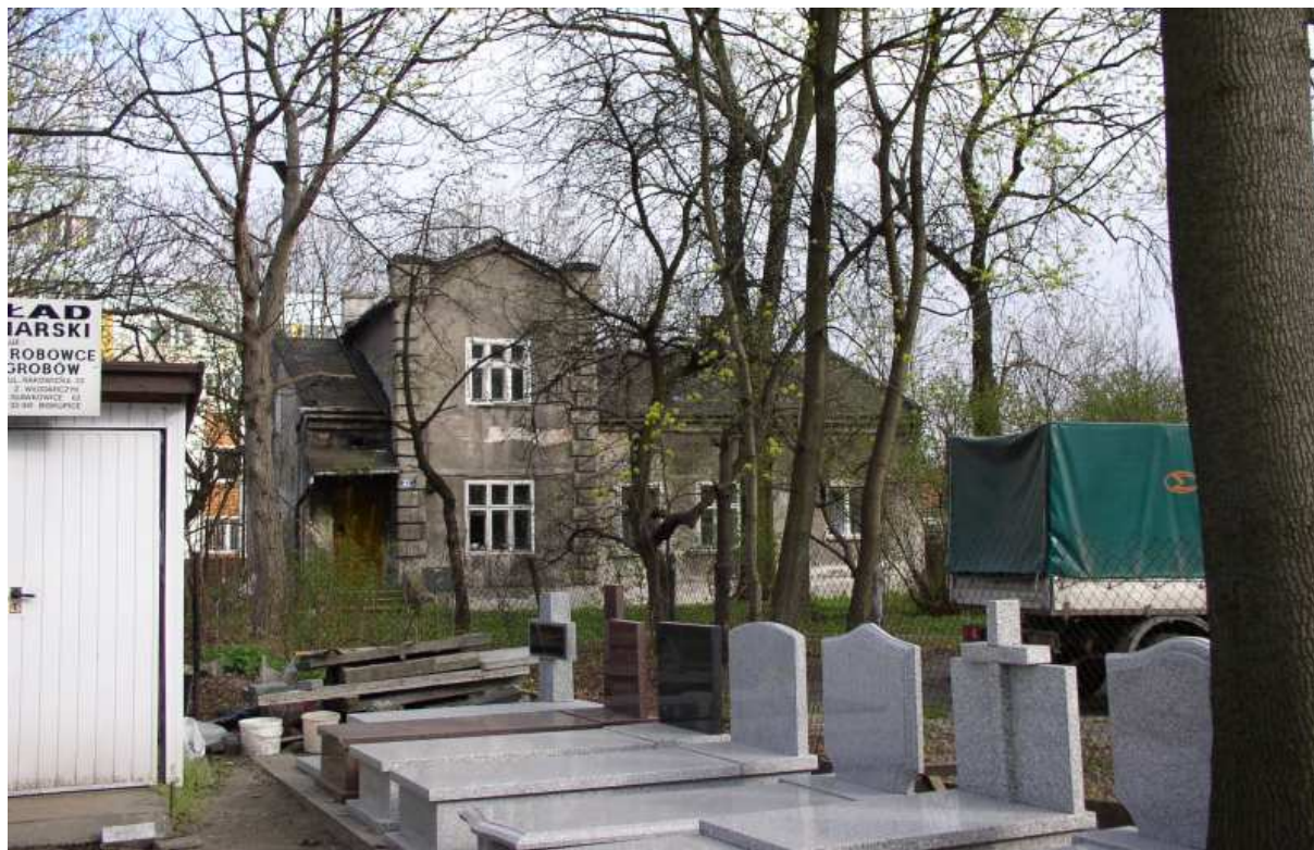
Fot. nr 10 (10-11). Dla porównania stan willi z dnia 12.04.2009. Budynek powstał na skraju Olszy w 1890 roku wg projektu Franciszka Bujasa.
