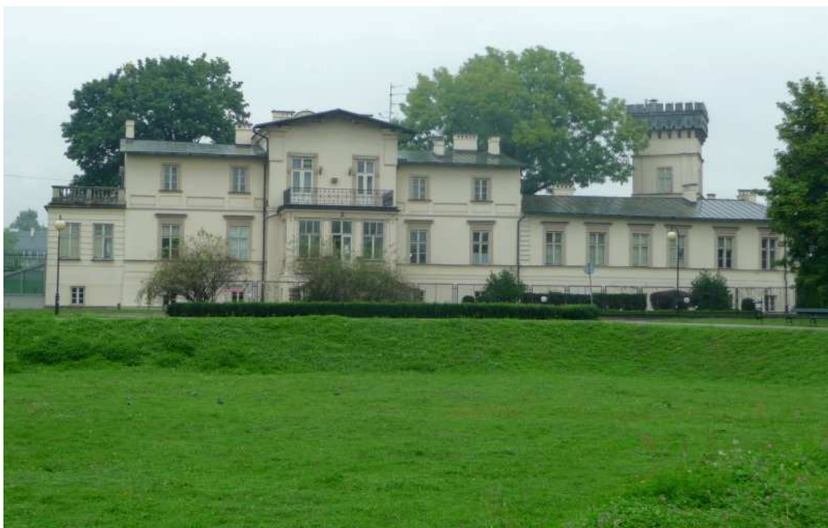
Fot. nr 156. Widok z ulicy Praskiej. (20.09.14).
