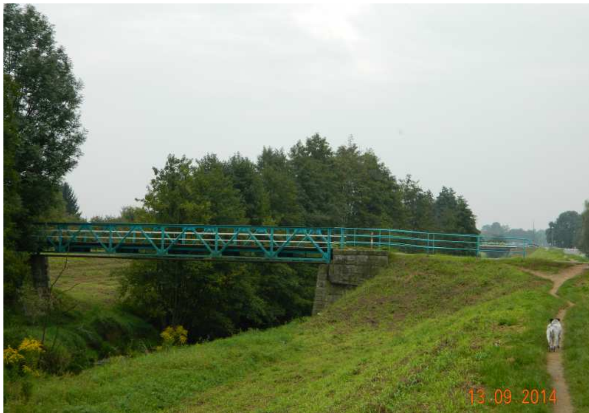
Fot. nr 140. Czwarty most na Rudawie, który pół wieku temu był drewniany i pełen dziur.
