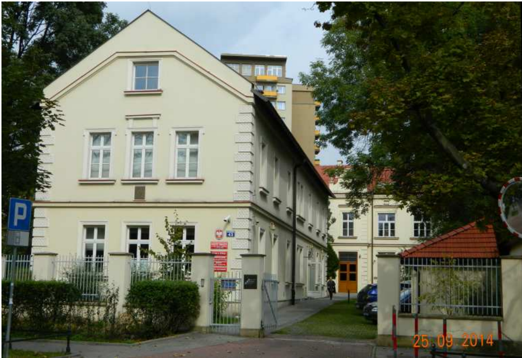
Fot. nr 56 (56-57). Budynek Instytutu Sztuki UP, wybudowany w latach 1900-1906.
