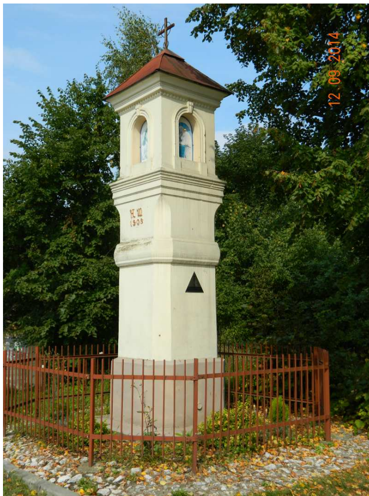
Fot. nr 164. Podmiejska kapliczka, kiedyś latarnia, na styku ulic: Wyłom i Norymberskiej.
