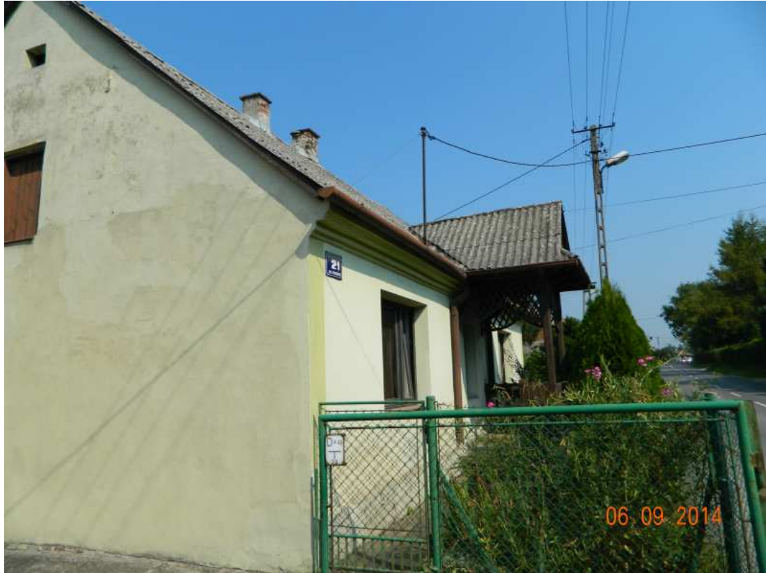
Fot. nr 192 (192-193). Przebudowy już dom z Bolesława Śmiałego 21 (pierwotnie z I ćwierci XX-go wieku).
