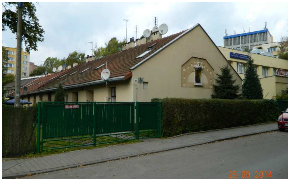
Fot. nr 42 (42-44). Budynek mieszkalny spod nr 32 i jego detale.
