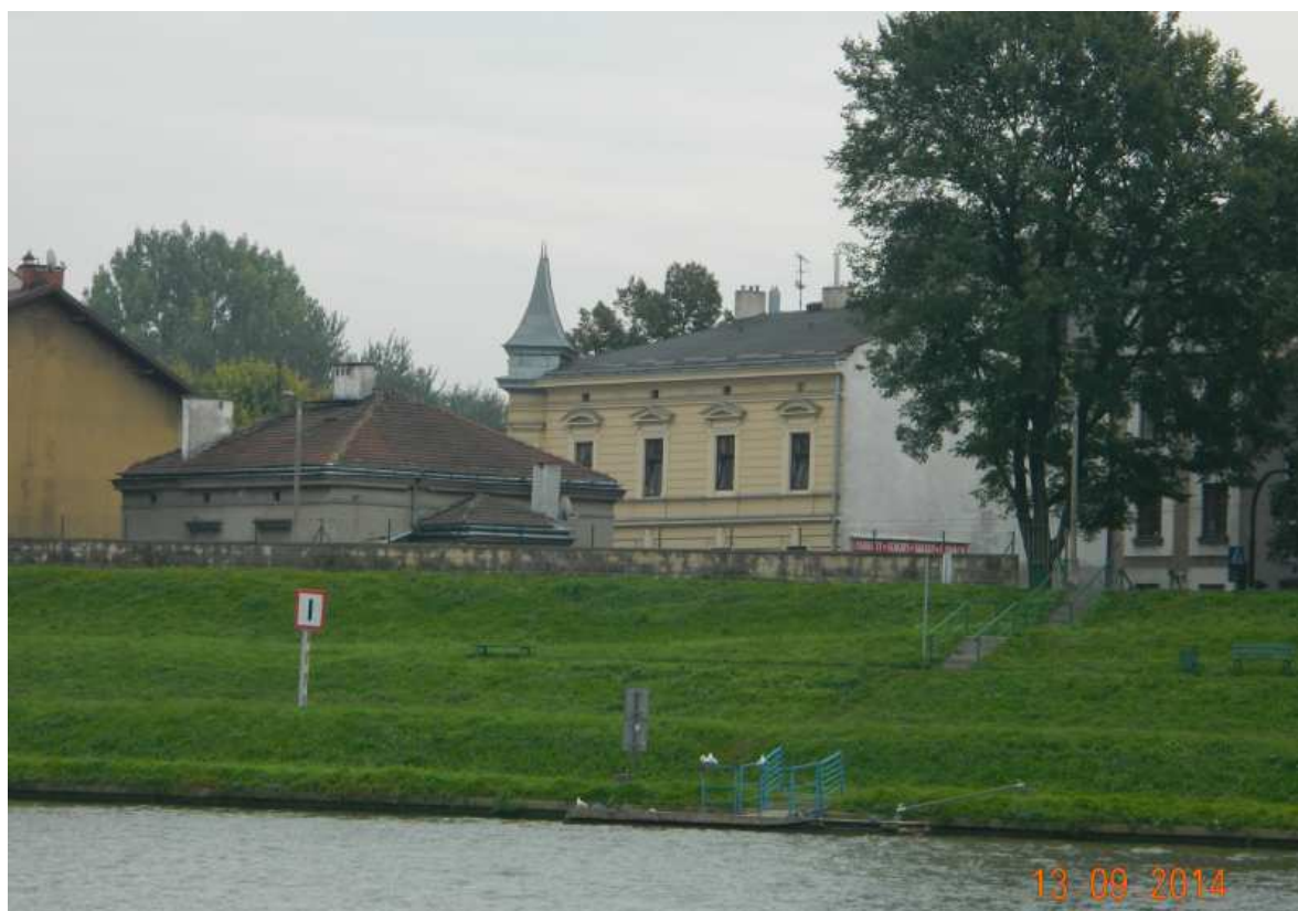
Fot. nr 152. Fragment Dębniak na styku Rynku Dębnickiego i ulicy Tynieckiej.
