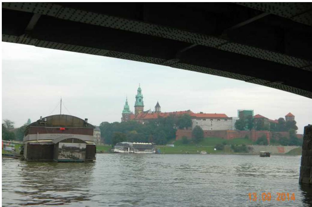
Fot. nr 3. Wzgórze Wawelskie – ujęcie spod Mostu Dębnickiego.
