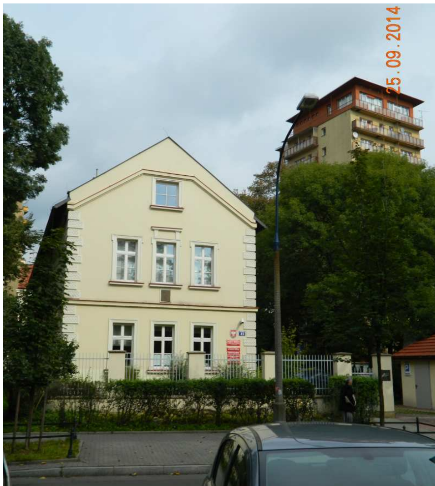
Fot. nr 57. Mazowiecka 43
