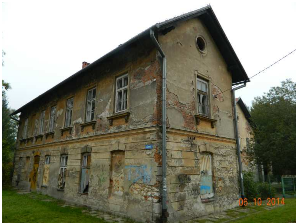
Fot. nr 265 (265-268). Przebudowana pod koniec XIX-go wieku Rządówka przy folwarku Jerzmanowskich z ulicy Górników 29.
