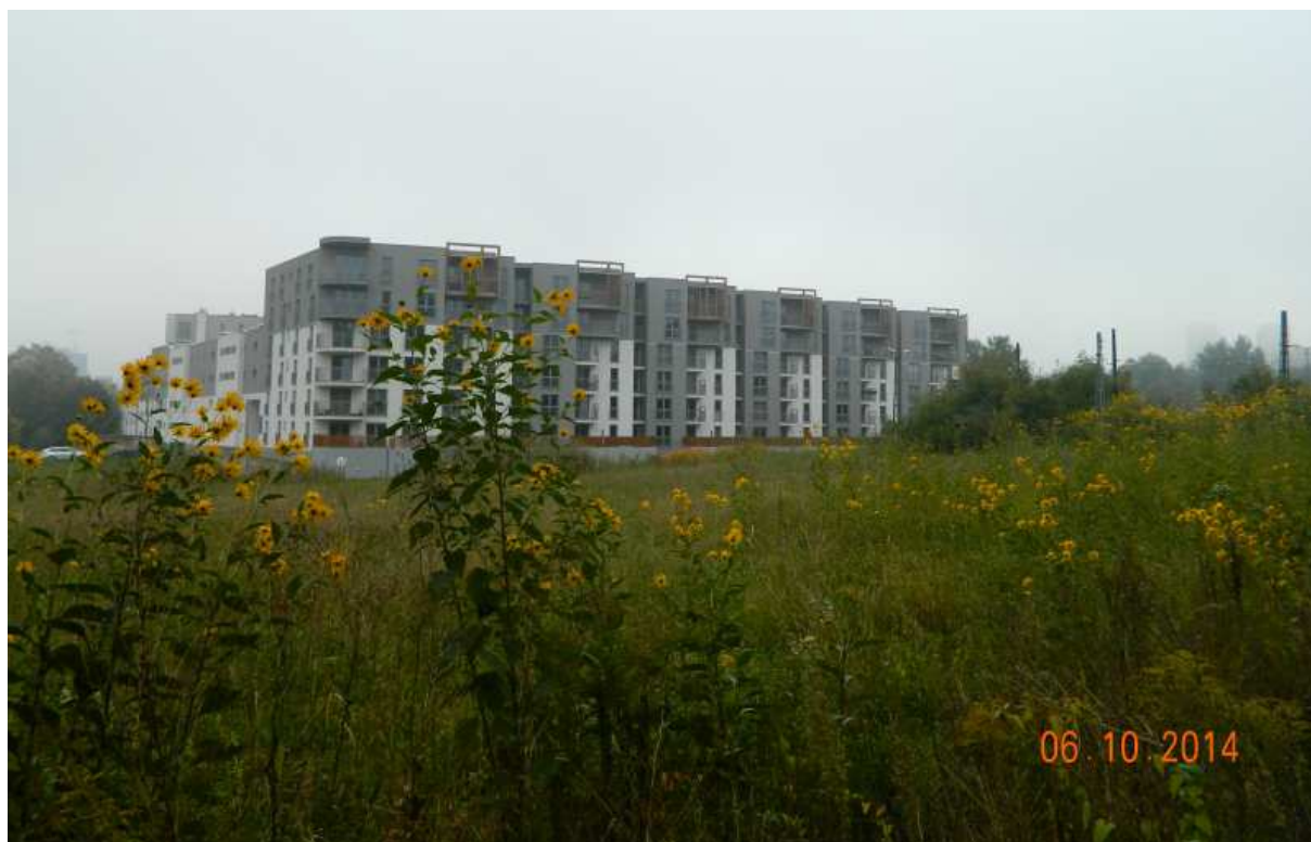
Fot. nr 255 (255-256). Blokowisko od strony dawnej alei dojazdowej.
