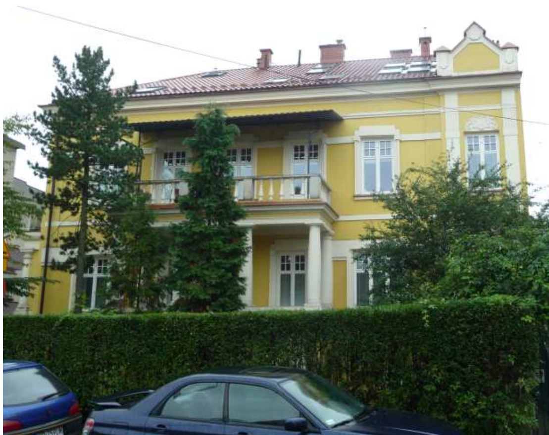
Fot. nr 150. Fasada od strony ulicy Zagrody. (20.09.14)
