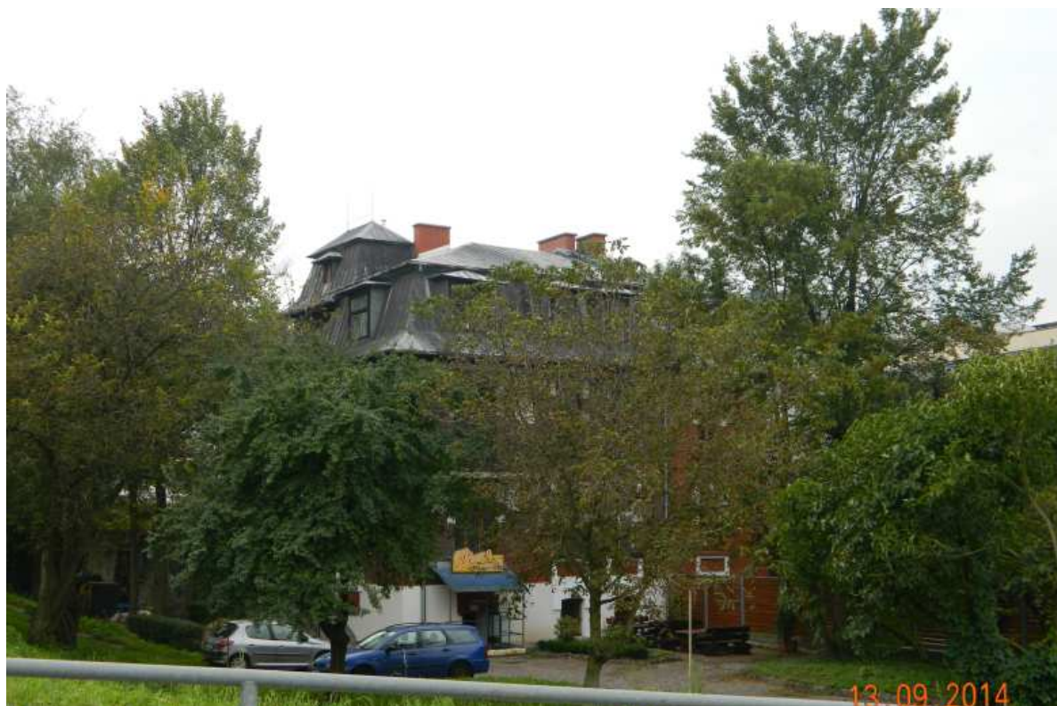
Fot. nr 116 (116-117). Secesyjna willa na styku ulic: Emaus 3 i Kościuszki, wzniesiona w 1911 roku wg projektu Józefa Wilczyńskiego i Alfreda Kramarskiego.
