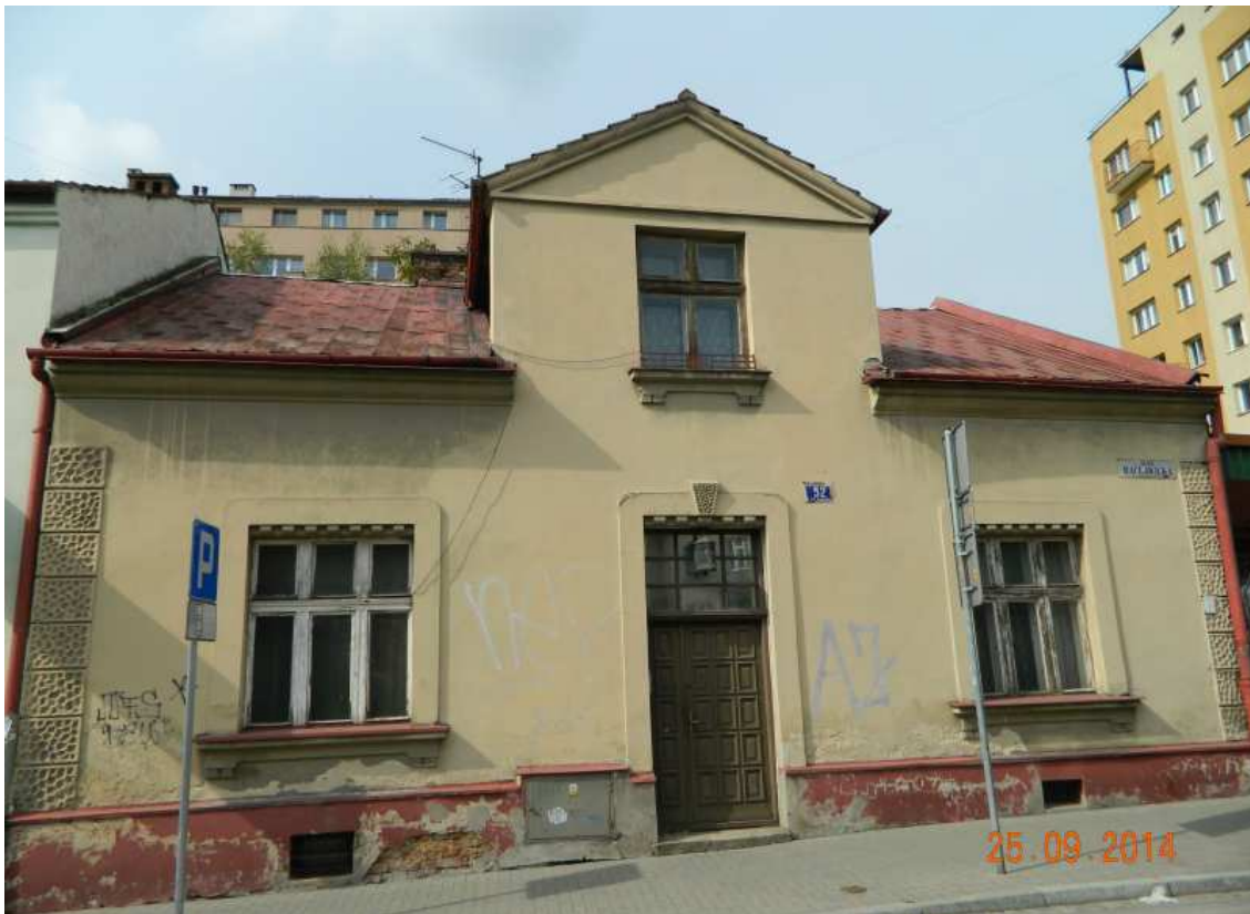
Fot. nr 66. Domek z ulicy Raławickiej 52.
