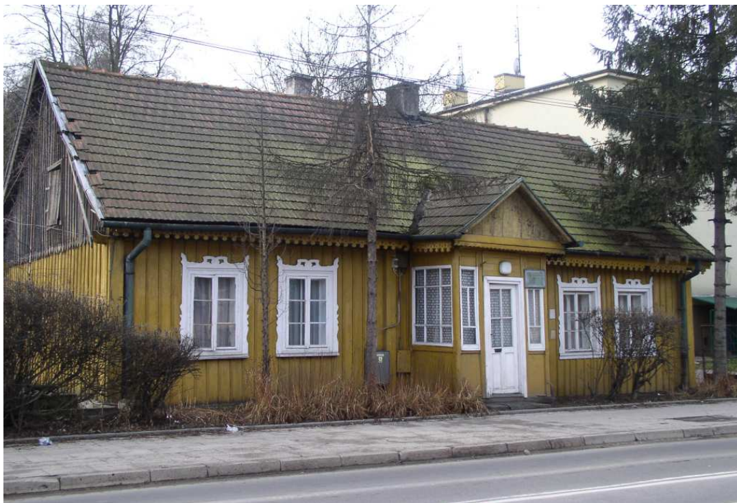
Fot. nr 265. „Perła Zwierzyńca” z ulicy Królowej Jadwigi 120, która została rozebrana na początku roku 2010.
