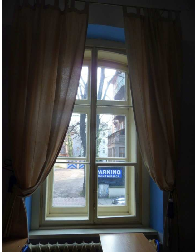
Fot. nr 378. Wiernie zrekonstruowane drewniane okno w jednej z sal parteru. W oczu rzuca się archaiczna, uchylna dolna kwatera. (05.02.2018)
