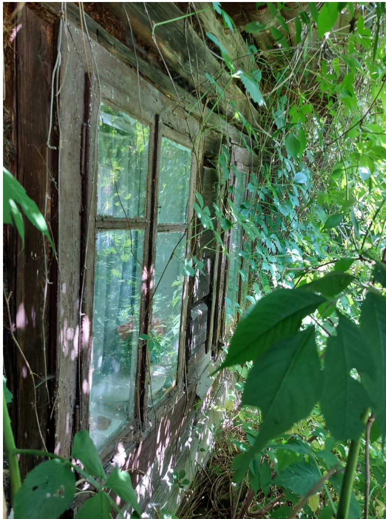
Fot. nr 465e. Oryginalne okna typu ościeżnicowego w ścianie od strony ogrodu.
