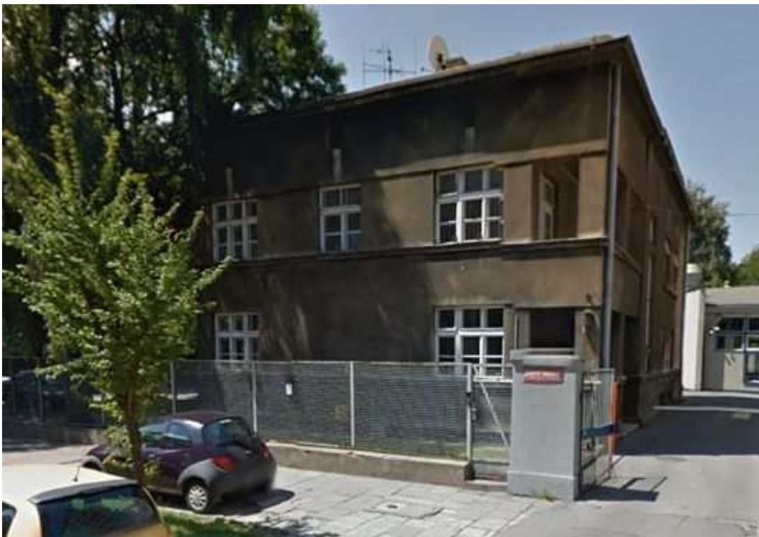
Fot. nr 269. Nieistniejąca już gdzieś od roku 2013 willa z ulicy Oleandry 6.
