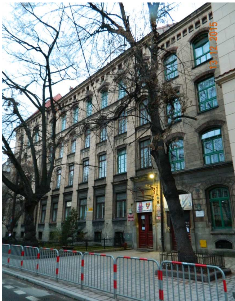
Fot. nr 246. Eklektyczny gmach Zespołu Szkół Energetycznych z ulicy Loretańskiej 16, powstały w I dekadzie XX wieku wg projektu Jana Zawiejskiego. To moja szkoła średnia - dawne Technikum Energetyczne, w tych czasach, na przełomie lat 60/70 nazywana Akademią Loretańską. (12.03.2014)
