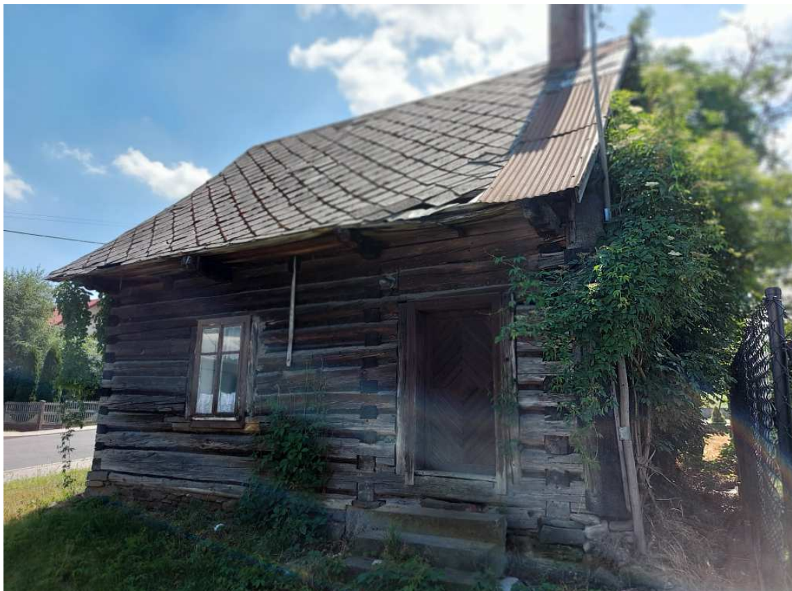
Fot. nr 464b. Fasada domu od strony podwórka. Fot. nr: 464b-464h Antoni Łapajerski (2021)
