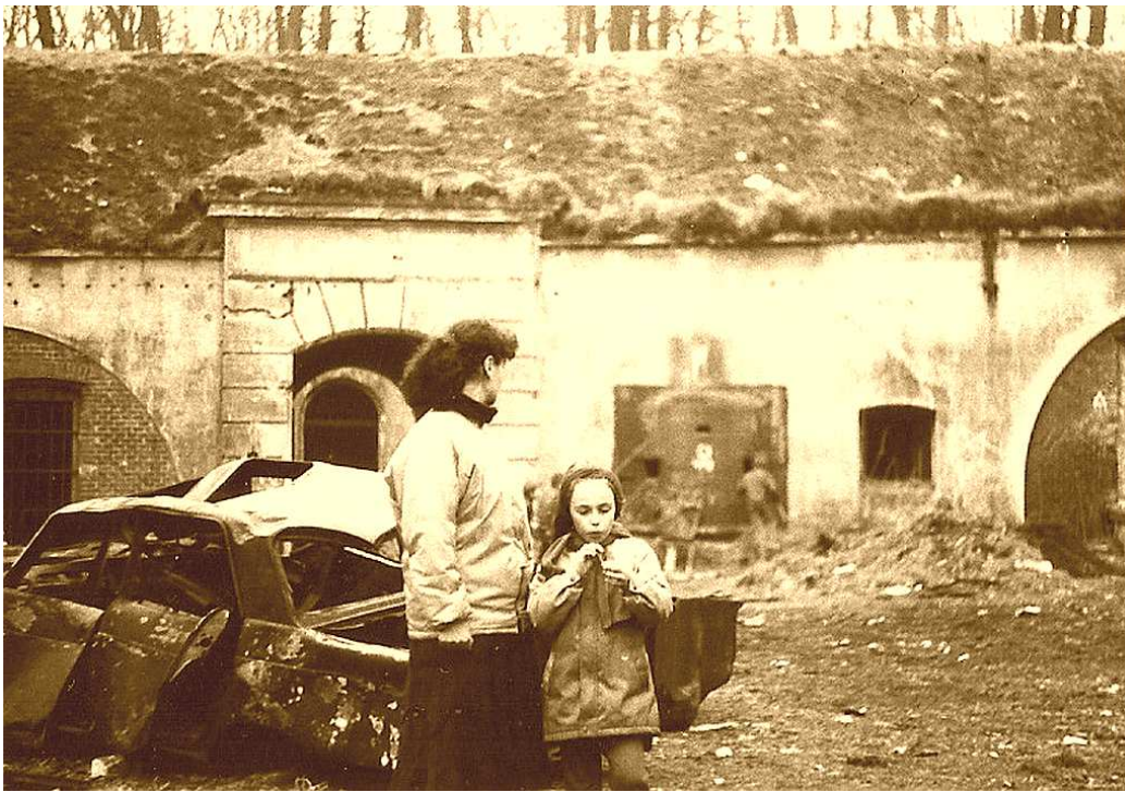
Fot. nr 408. Wejście do fortu nr 50 Prokocim wg stanu z roku 1988. Z prawej jest jeszcze widoczna osłona pancerna dla ckm.
