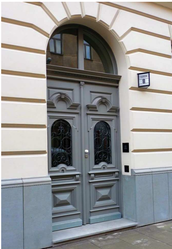
Fot. nr 39. Drzwi „mojej” kamienicy po remoncie, już bez klamki. (07.04.2014)
