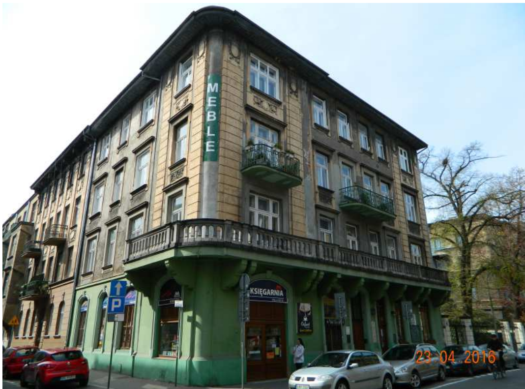
Fot. nr 162. Kamienica z ulicy Krupniczej 14. Na lewo od bramy wejściowej w czasach PRL znajdował się sklepik z krawatami, a na prawo od niej, na wysokim parterze, odbywały się kursy kandydatów na prawo jazdy. Pół wieku temu pod kamienicą zwykle parkowały „Warszawki” z tablicą: „Nauka Jazdy”, które czekały amatorów czterech kółek.
