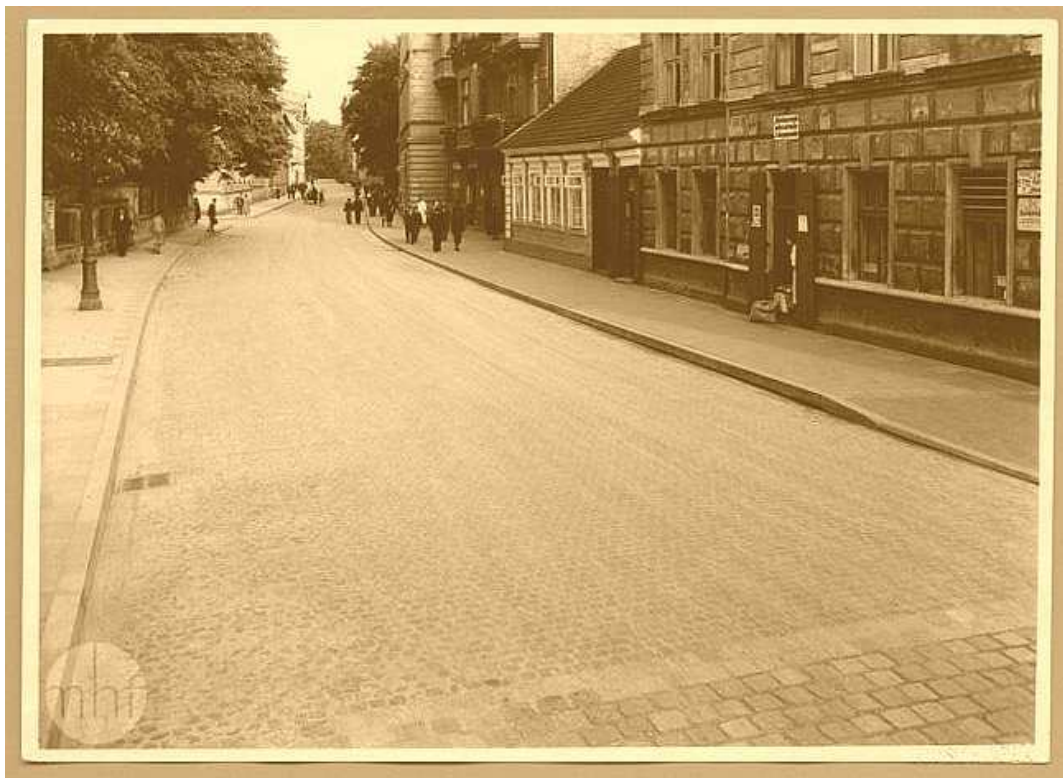
Fot. nr 183. Fotografia z lat 30. zeszłego wieku. Mleczarnia Zofii Mazgajewskiej nadal funkcjonowała w lewym fragmencie parteru kamienicy pod nr 26, wówczas już Mehoferów, ale obok sklepiku działała też jej restauracja. Przy obramieniu drzwi wejściowych do kamienicy pod nr 26 widać szyldy: „akuszerki – J. Przybyłowa i Barbara Wachowa (?)” oraz „malarz S. Karaś”, a ponadto zapewne na podwórku działały: „Pracownia stolarska Teodora Janika” oraz „Wyrób obuwia Franciszka Zawady”. Na lewo pod nr 24 widać parterowy domek Witolda Rzegocińskiego, znanego malarza, który dotrwał do roku 1980; sam artysta zmarł w roku 1969. W prawej części domu Rzegocińskiego funkcjonował „sklep wiejski”. (MHF)
