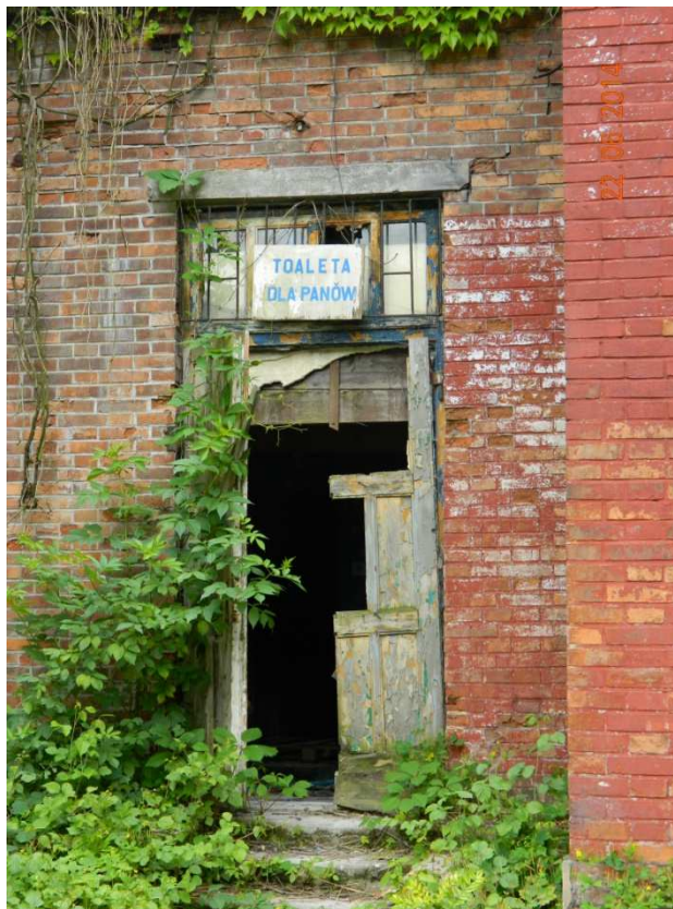
Fot. nr 231. Dawna toaleta męska w kompleksie szatni.
