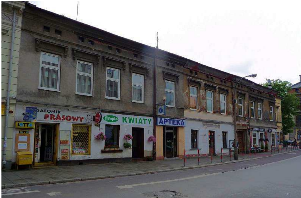
Fot. nr 137. Stan z dnia 09.06.2012. Szewca już nie ma, a miejsce jego warsztatu zajęła kwiaciarnia. Sklepik Mola już dawno zajął Salonik Prasowy. Oryginalne, czteropolowe okna kamieniczki już jakiś czasu zostały wymienione na nieciekawe plastiki. W czasach PRL w parterze kamieniczki znajdowały się tylko dwa punkty rzemieślniczo-handlowe: warsztacik szewski Chytręgo oraz sklepik ogólnospożywczy Edwarda Mola, założony już w latach 20-tych XX wieku.
