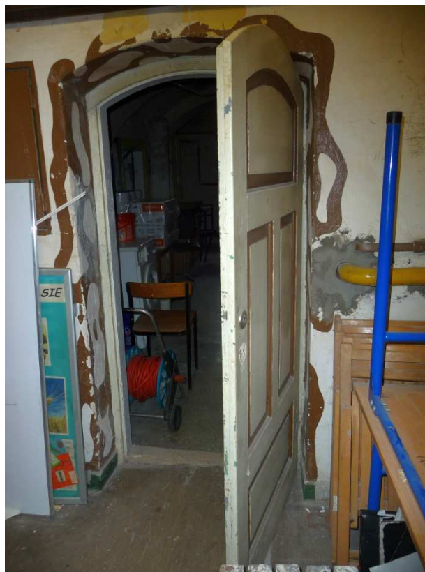
Fot. nr 391. Archaiczne drzwi, które pół wieku temu wiodły do stołówki zlokalizowanej w suterenie, z oknem wychodzącym na ulicę. Obok znajdowała się kuchnia. Miejsce sąsiadujące kiedyś z tymi pomieszczeniami szatni, do której po kilku stopniach w dół schodziło się na końcu podwórka, dziś zajmuje sklep podróżniczy. (05.02.2018)
