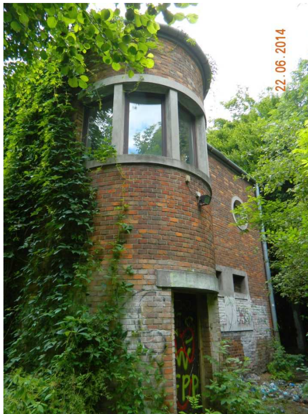
Fot. nr 334. Pochłonięty przez chaszczę budynek szatni męskiej, kiedyś przylegający do amfiteatralnego boiska. (22.06.2014)
