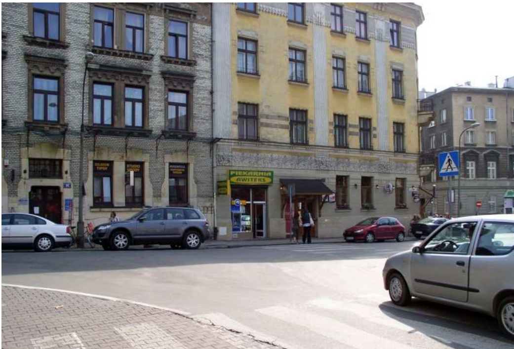
Fot. nr 186. Na parterze kamienicy przy ulicy Krupniczej 30 kiedyś znajdował sklep spożywczy PSS Społem. Tu, gdzie dziś lokal Awitekusu, mieścił się magazyn sklepowy (bez drzwi), a wejście do lokalu handlowego znajdowało się na prawo. (13.09.2010)
