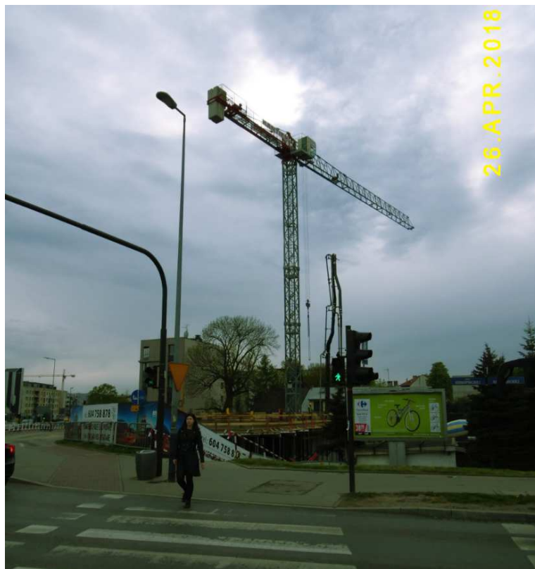
Fot. nr 426 (426-427). Beton wkracza na skraj Dębnik w sąsiedztwie Ronda Grunwaldzkiego.
