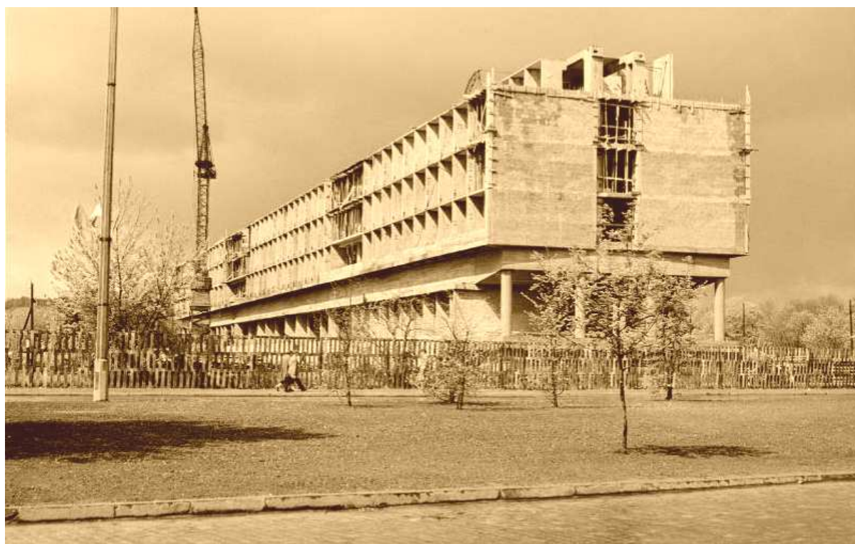
Fot. nr 106. Budowa hotelu Cracovia – początek lat 60. (NAC)
