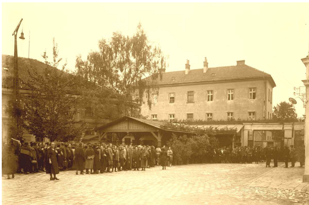
Fot. nr 117. Wspomniany powyżej budynek dawnego z ulicy Dolnych Młynów 11. Widok z dziedzińca zakładów tytoniowych. Stan z września 1926 roku. (NAC)
