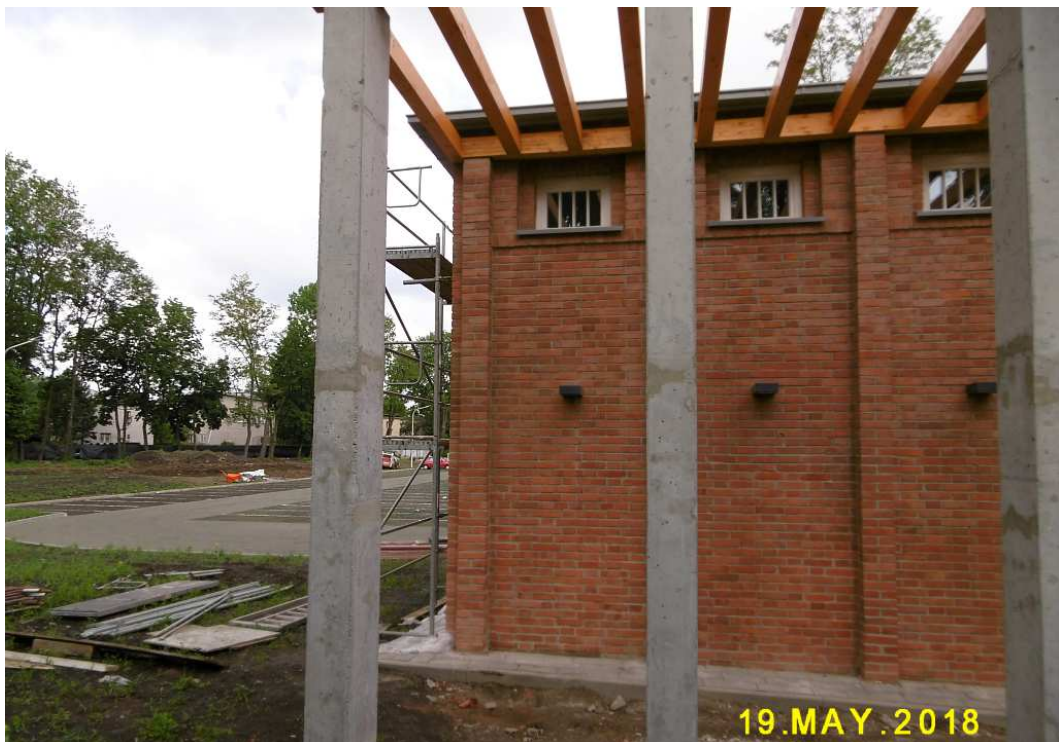
Fot. nr 235. A dziś po basenie głębokim pozostał już tylko pusty plac.
