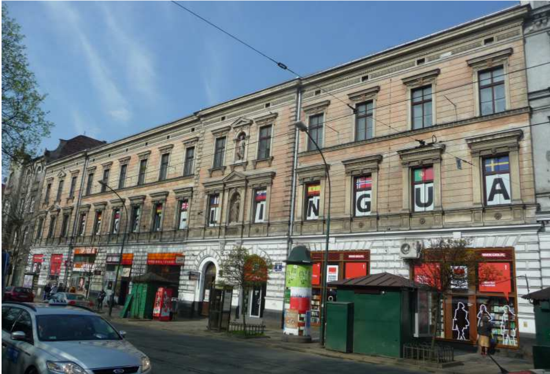
Fot. nr 205. Dawny gmach Zespołu Szkół Poligraficzno-Księgarskich z ulicy Podwałe 6; wcześniej swą siedzibę miała tu szkoła żeńska im. Jotejki. Ponoć istnieją realne plany podwyższenia budynku i utworzenia nim kolejnej galerii handlowej. (07.04.2014)
