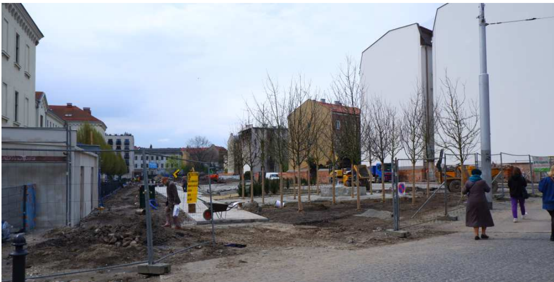
Fot. nr 7e. Końcowy etap prac w parku im. Wisławy Szymborskiej. (14.04.2023)
