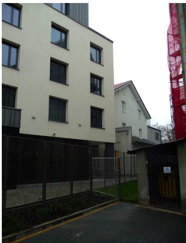
Fot. nr 360. Współczesny koszmarek - Grand Ascot Hotel - nie dość, że całkowicie zajął zieloną przestrzeń dawnego ogrodu, to jeszcze całkowicie przysłonił dawną willę Wojczyńskich. Na ich dawnej posesji w latach 60. mieściło się przedszkole. (12.01.2018)
