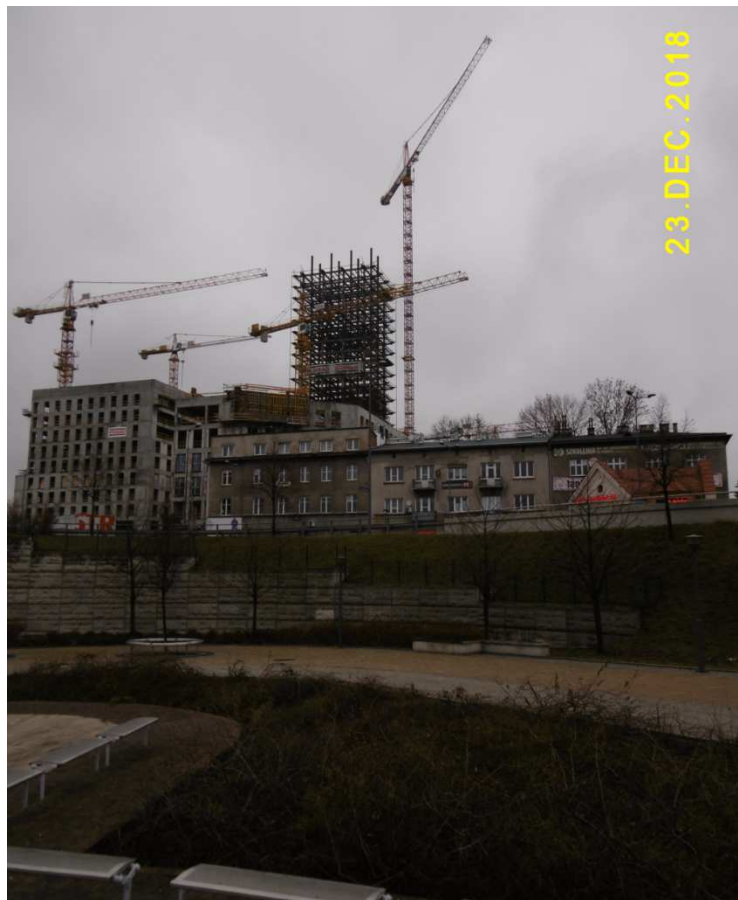
Fot. nr 425. Budowa Unity Centre przy Rondzie Mogilskim, a pośrodku autentyczny już „szkieletor.
