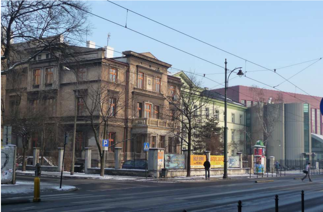
Fot. nr 424. Nowy gmach Opery Krakowskiej (z prawej) wciśnięty w zabudowę ulicy Lubicz. (23.12.2011)
