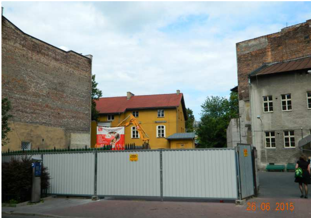
Fot. nr 398. I po zawodach. Rozpoczęła się budowa, a kapliczka znikła.
