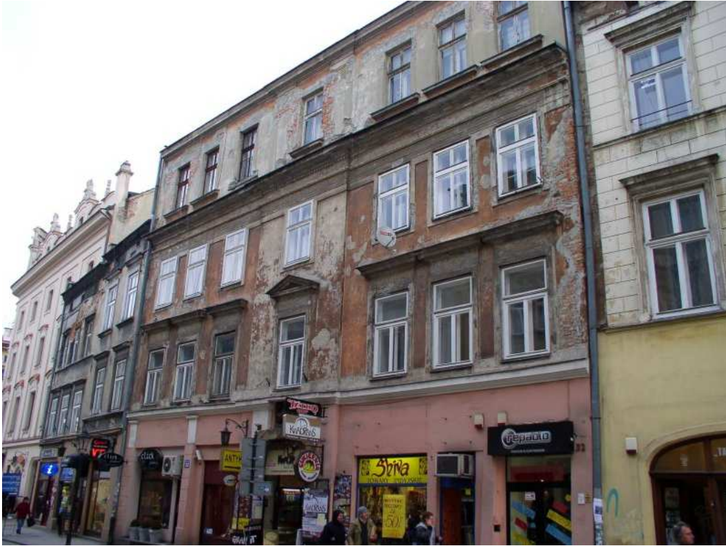
Fot. nr 432. Chaotyczne i przypadkowe fasady kamienic w odcinku ulicy Grodzkiej o nr: 26-32. Dziś, po niedawnej odnowie kamienicy Podelwie (z prawej) jest już trochę lepiej, choć obiekty o nr: 28 i 30 nadal straszą.
