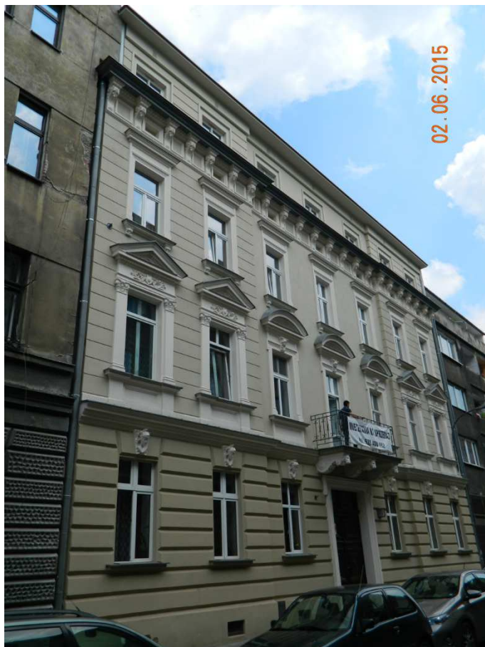
Fot. nr 72. Kamienica spod nr 11 po odbytych właśnie remoncie, który nie obył się bez jej szpetnego jej podwyższenia.
