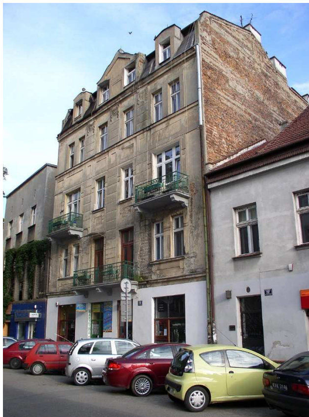
Fot. nr 93. Kamienica przy ulicy Rajskiej 20, pochodząca z lat 1911-1912, wybudowana wg projektu Jozue Oberledera, znana głównie ze spożywczego sklepu Łakomskiej, który funkcjonuje do dziś. Na III jej piętrze mieszkał Janusz Klimas, znany w I połowie lat 70-tych judoka Wisły. (18.08.2010)
