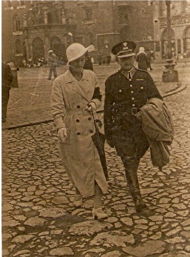
Fot. nr 428. Rynek Główny w latach 30-tych, z jego oryginalnym, wapiennym brukiem.
