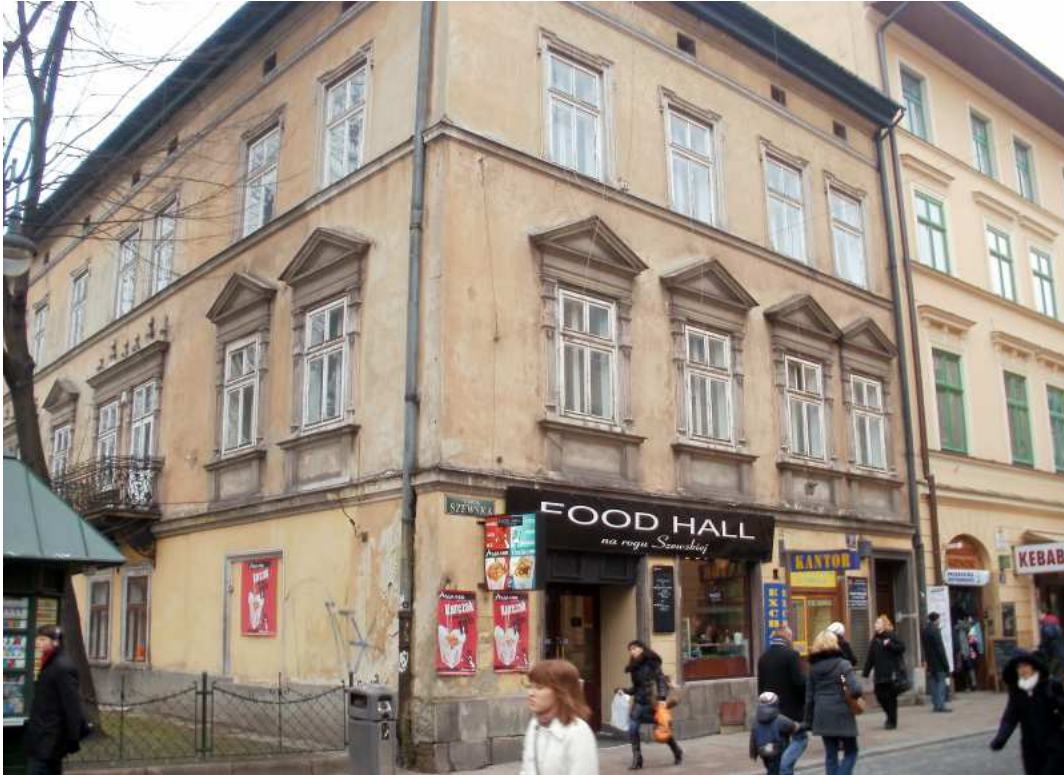
Fot. nr 201. Kamienica z ulicy Szewskiej 27; w jej narożu znajdował się duży sklep Cepelii. (08.04.2010)
