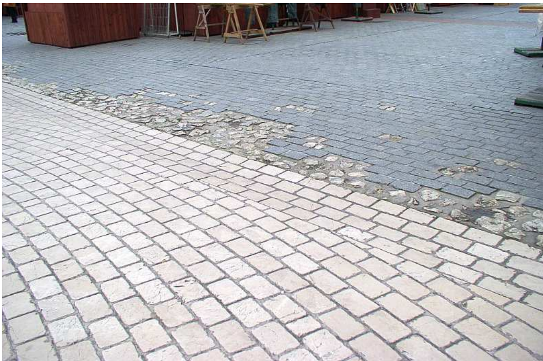
Fot. nr 430. Przykład stosowania różnego wyłożenia płyty Rynku (od lewej): współczesna kostka wapienna, która się nie sprawdziła, oryginalna kostka wapienna i kostka granitowa, dziś powszechna.
