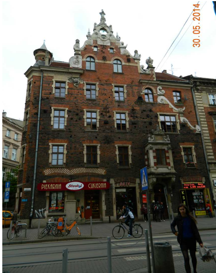
Fot. nr 198. To w dawnej kamienicy Teodora Talowskiego pod nr 35, wybudowanej przez niego w 1886 roku, a noszącej nazwę Pod Pająkiem i jeszcze kilka dekad temu pokrytej dzikim winem, znajdowały się dwa sklepy: gospodarczo-chemiczny (dojście po schodkach), który należał do pana Brody oraz pasmanteria, po prawej stronie bramy. Po lewej stronie, w narożu ulic: Batorego (25) i Karmelickiej (37), znajdował się najbliższy komisariat MO, z wejściem od ulicy Batorego.
