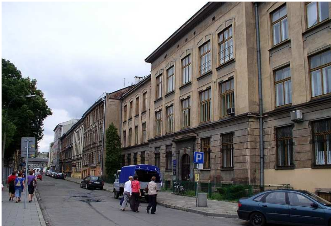
Fot. nr 67. Gmach Instytutu (Ło)Patologii AM przy ulicy Czystej 18. Druga z prawej kamienica pod nr 16, która powstała w 1906 roku; jej projektantem był Benjamin Torbe. (08.04.2010)
