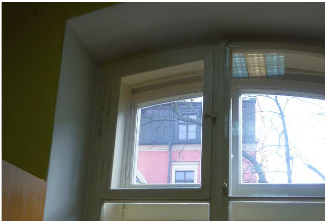
Fot. nr 384. Uchylna górna kwadra okna sali lekcyjnej na I piętrze i jego oryginalne detale. (05.02.2018)
