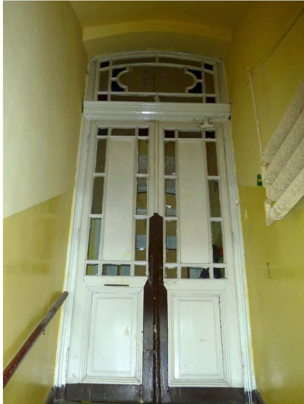
Fot. nr 370. Oryginalne drzwi wewnętrzne wiodące na korytarz parteru. (05.02.2018)
