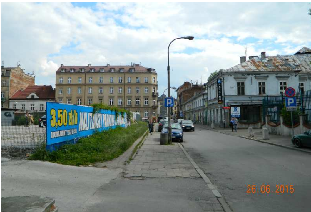
Fot. nr 116. W wyglądzie ulicy Dolnych Młynów w zasadzie niewiele się zmieniło, bo zburzony został jedynie dwupiętrowy budynek dawnego lazaretu spod nr 11 (z lewej widok pustego po nim placu z lewej), który przylegał do dawnych koszar wojskowych.
