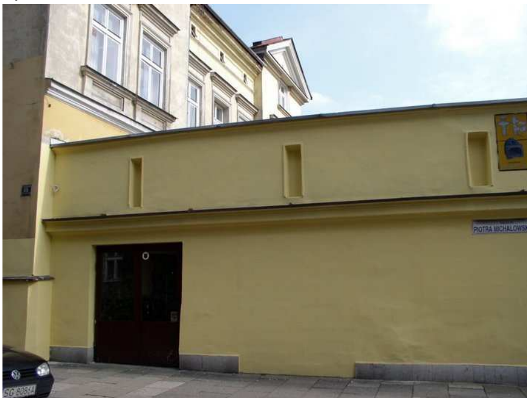
Fot. nr 134. W tym miejscu mieścił się zakład fryzjerski Jana Pilniakowskiego. Drzwi wejściowe zostały zamurowane, a ich miejsce pokazuje przerwa w betonowej podmurówce, na prawo od widocznych drzwi. W tle willa z ulicy Czarnowiejskiej 1. (13.09.2010)
