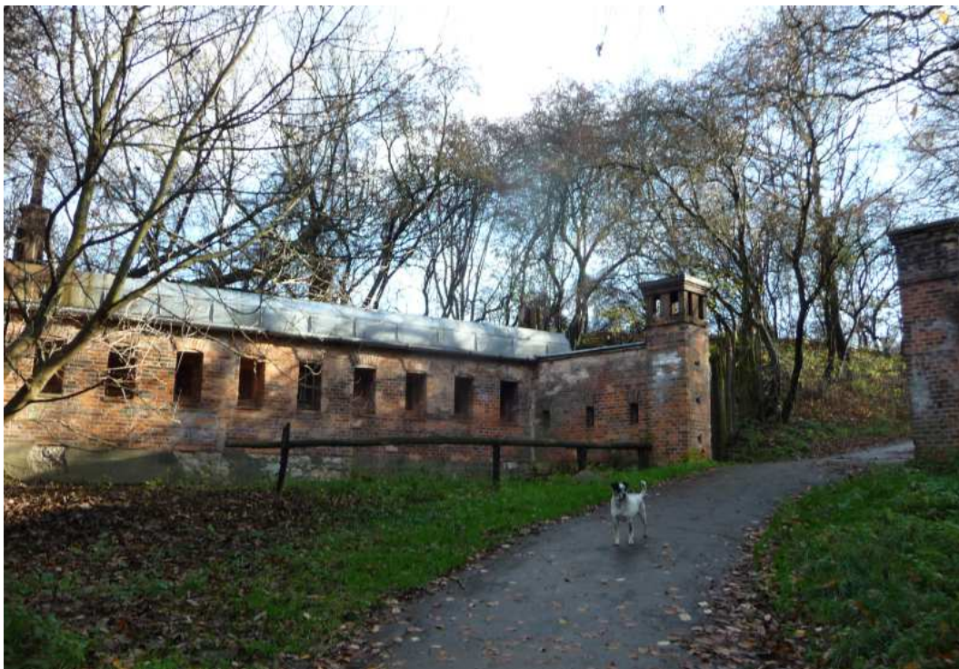
Fot. nr 281. Dawna brama forteczna zespołu bramnego 3a fortu Kościuszko, zlokalizowana na przedłużeniu dawnej ulicy Spadzistej, dziś Hofmana, przy szańcu ziemnym FS-3. (2014)
