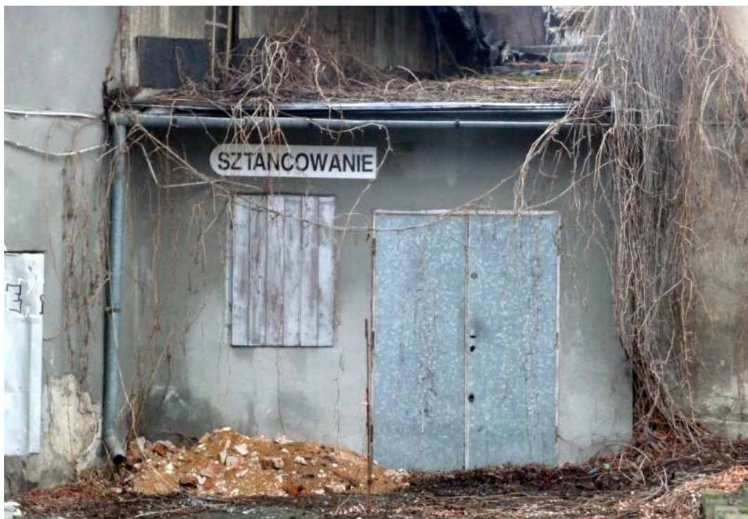
Fot. nr 141. Ślad po dawnym zakładzie rzemieślniczym. (11.02.2014)
