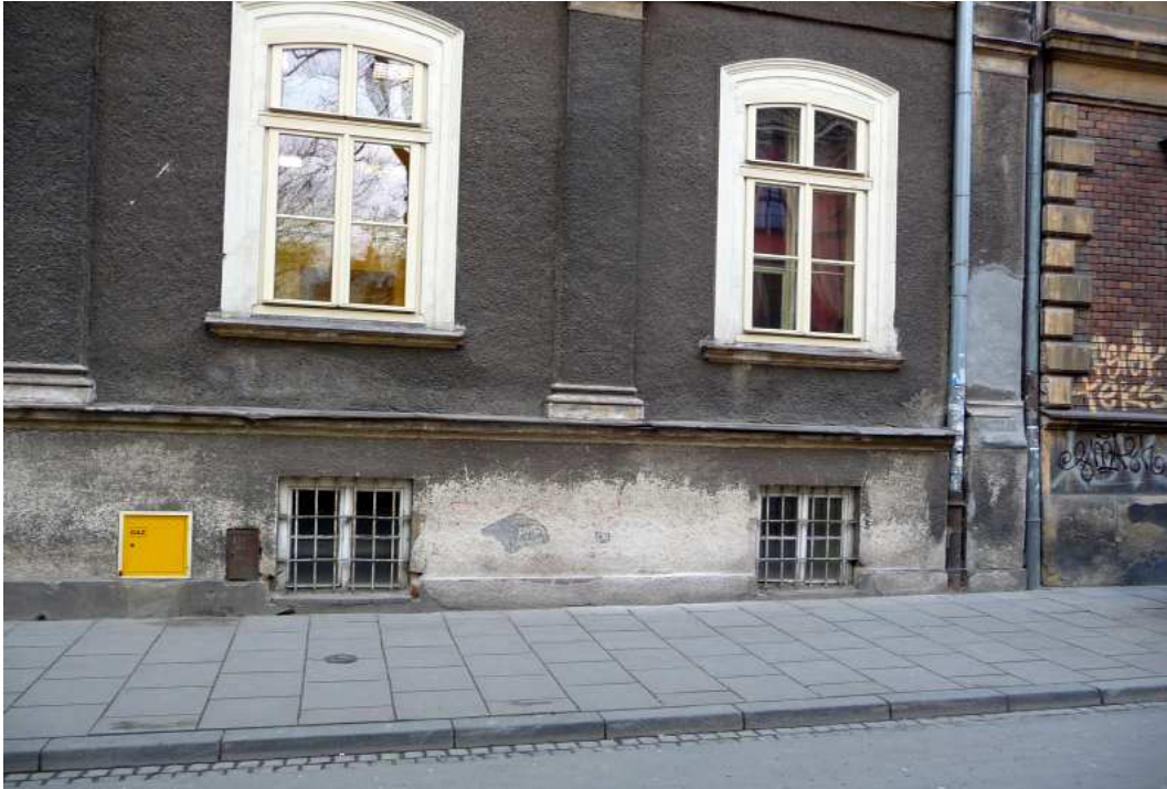
Fot. nr 392. Dwa okna wychodzące na chodnik ulicy Krupniczej: dawnej kuchni (z lewej) i stołówki. Nieraz dolatywały stamtąd kuchenne zapachy. (05.02.2018)
