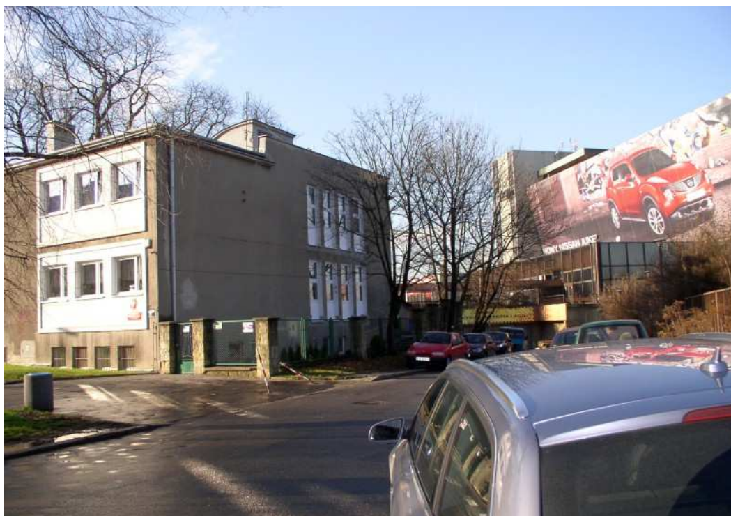
Fot. nr 327. Zachowany fragment ulicy Barskiej, dawniej przylegający od strony Wisły do stadionu RKS Garbarnia, z dobrze znanym mi od lat 60-tych budynkiem przedszkola. (19.11.2010)
