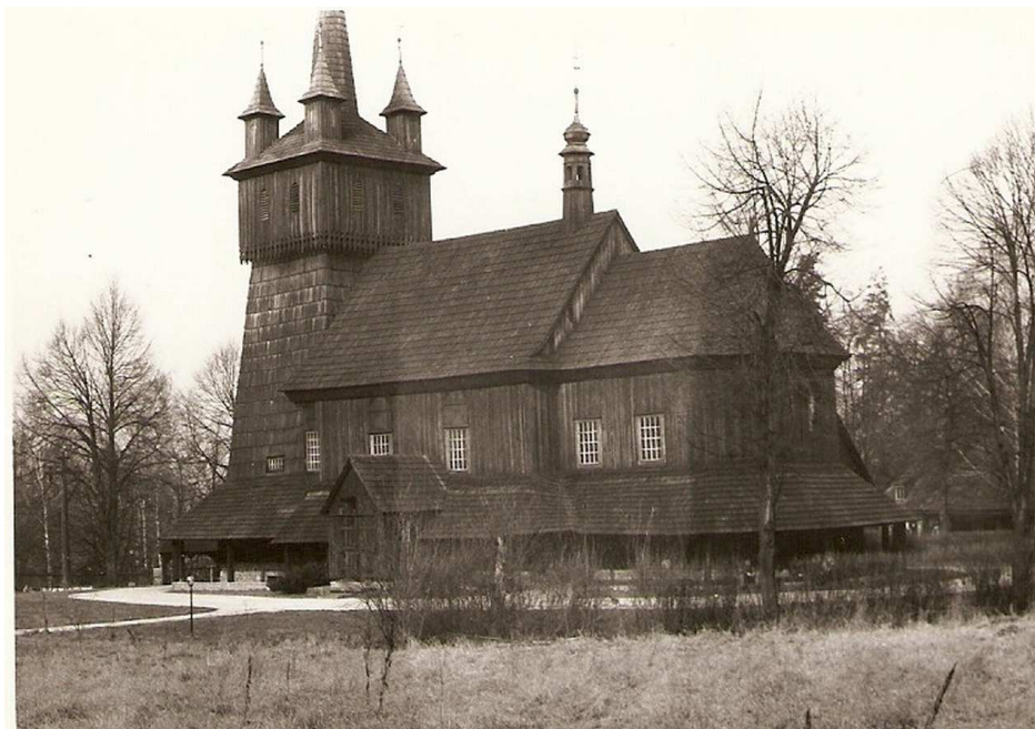
Fot. nr 284. Odtworzony kościółek na Woli Justowskiej, który niedługo spłonął ponownie; widok od strony ulicy Cisowej (1988).
