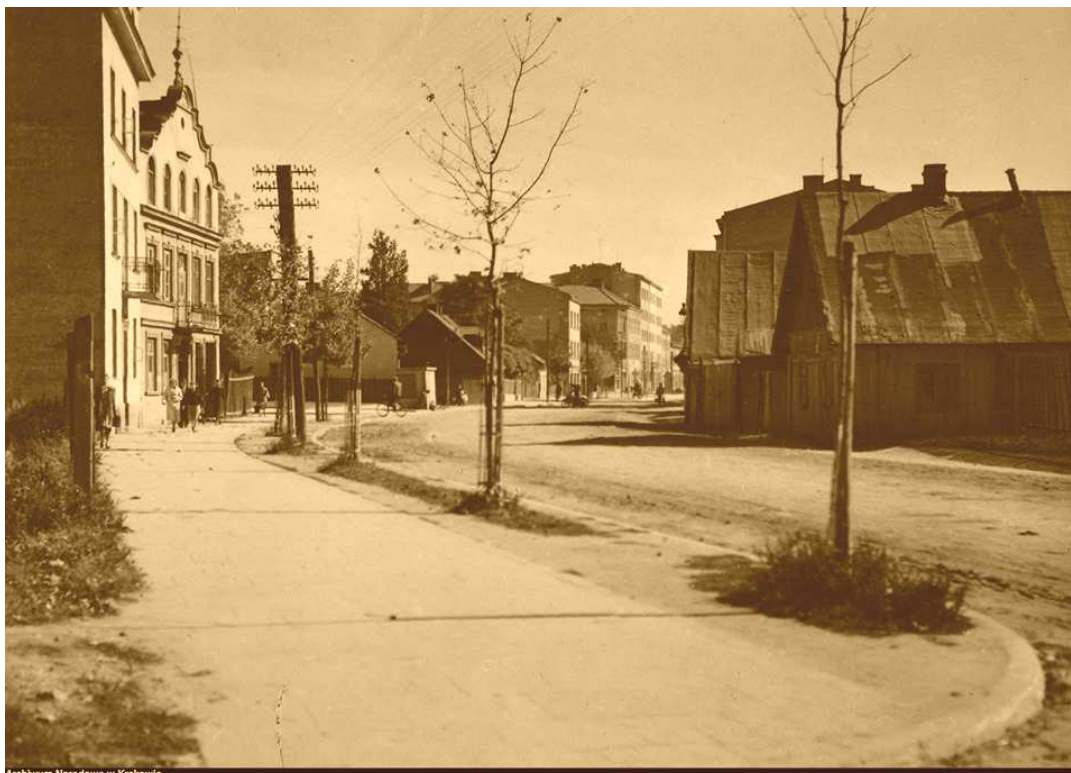
Fot. nr 102. Ulica Czarnowiejska w stronę alei Mickiewicza w ujęciu z wylotu Urzędniczej. Fot. Stanisława Kolowcy z roku 1941 (AN w Krakowie).
