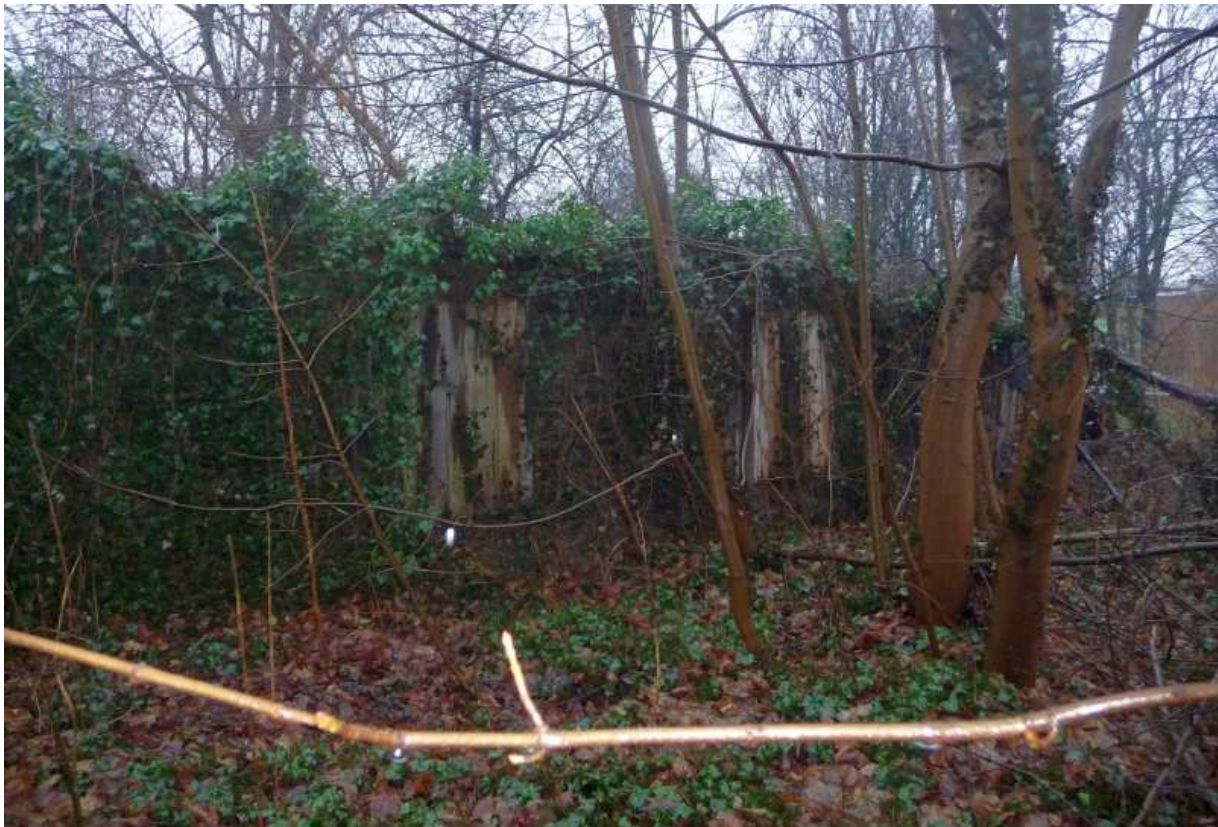
Fot. nr 117. Zarośnięta winem ruina starej chałupy na styku ulic: Ułanów i Fiołkowej. (15.01.14)
