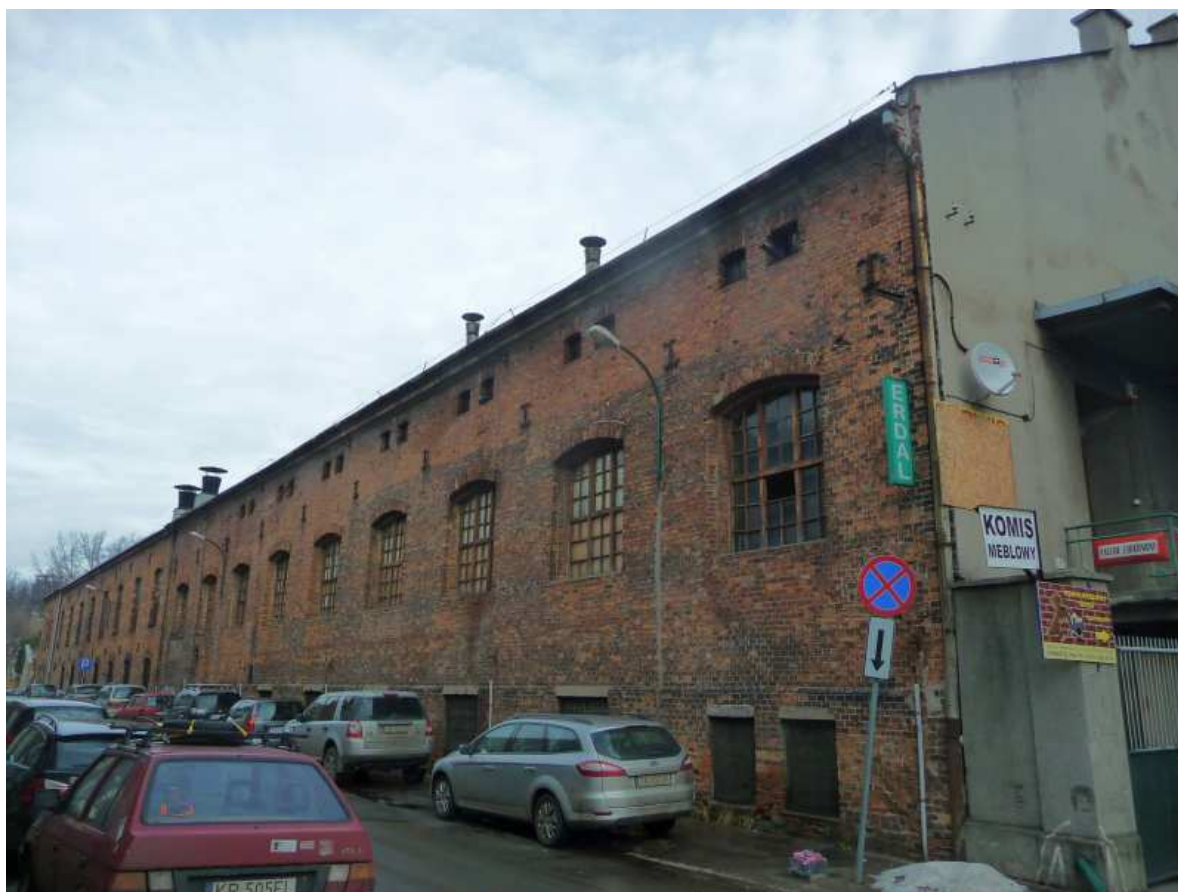
Fot. nr 152 (152-153). Dawne pomieszczenia fabryki Erdal. (07.02.14)
