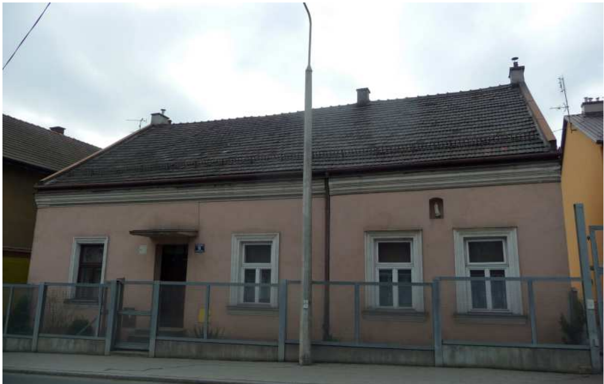
Fot. nr 13. Niewiele pozostało już z dawnej zabudowy ulicy Klasztornej. Na fotografii domek spod nr 16. (08.03.14)
