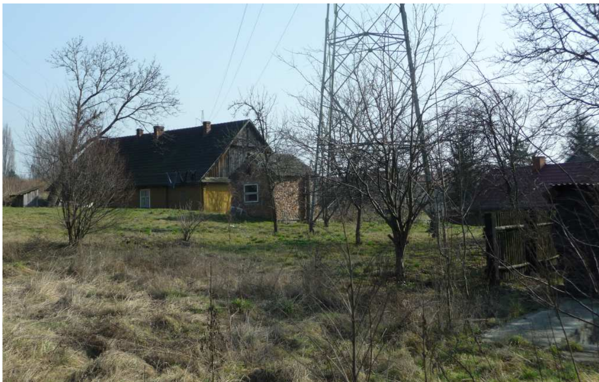
Fot. nr 112 (112-113). Widoki od strony podwórka (ulicy Ptaszyckiego). (09.03.14)
