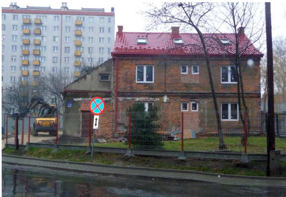
Fot. nr 126 (126-127). Przebudowana już kamieniczka z naroża z ulicy Ułanów 45 (naroże z ulicą Pilotów). (15.01.14)
