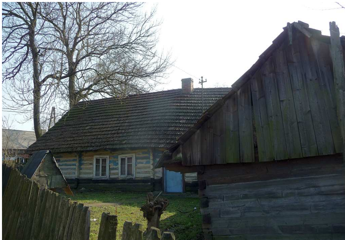
Fot. nr 72 (72-74). Widoki od strony podwórka i ulicy Bardosa. (09.03.14)
