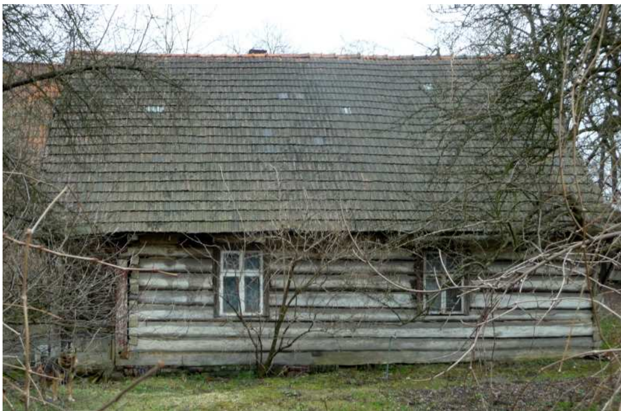
Fot. nr 23 (23-31). Nadal zachowany w dobrym stanie budynek młyna pocysterskiego w narożu ulic: Klasztornej i Żaglowej. (08.03.14)
