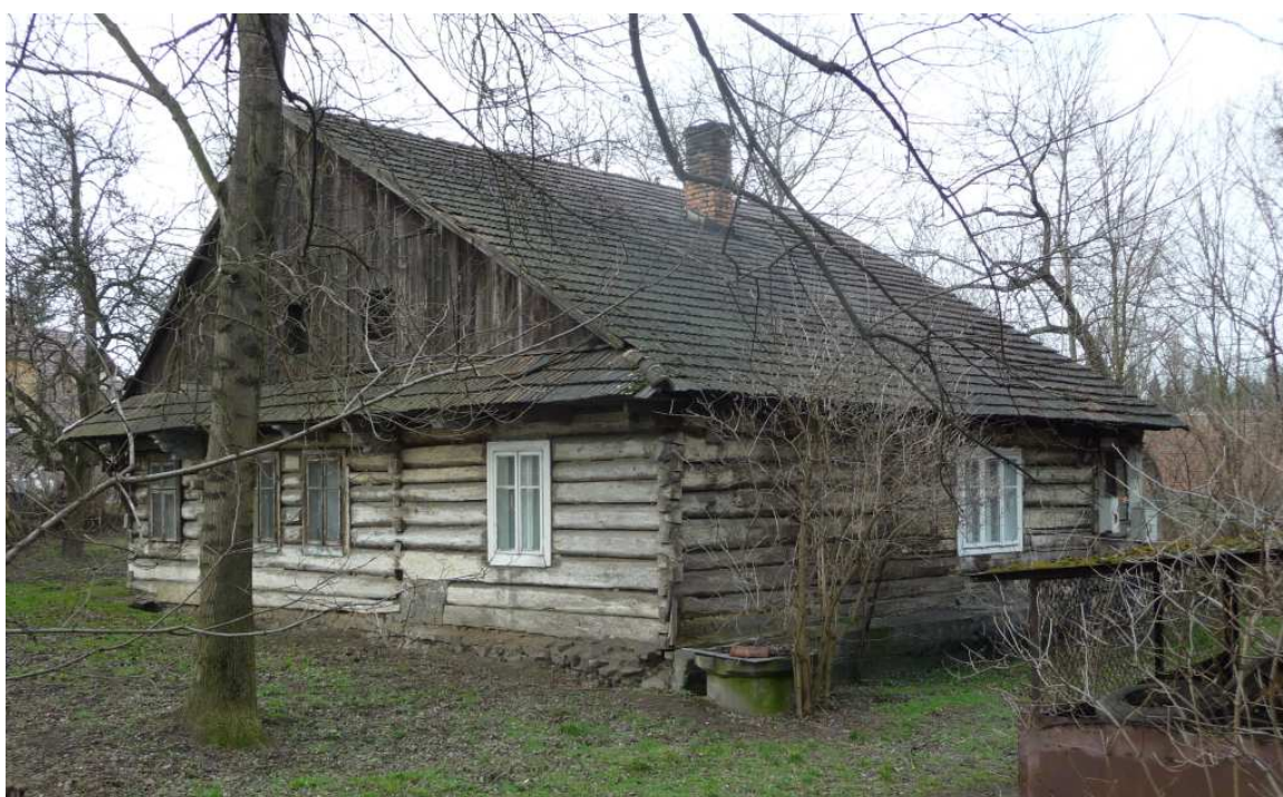
Fot. nr 31. Tylny fragment budynku dawnego młyna. (08.03.14)
