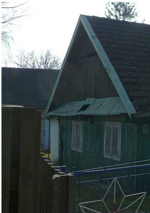
Fot. nr 92. Detale bocznej ściany. (09.03.14)
