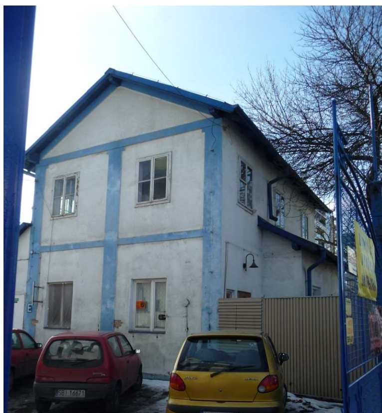
Fot. nr 169. Budynek przy bramie wjazdowej na teren dawnych zakładów. (05.02.14)
