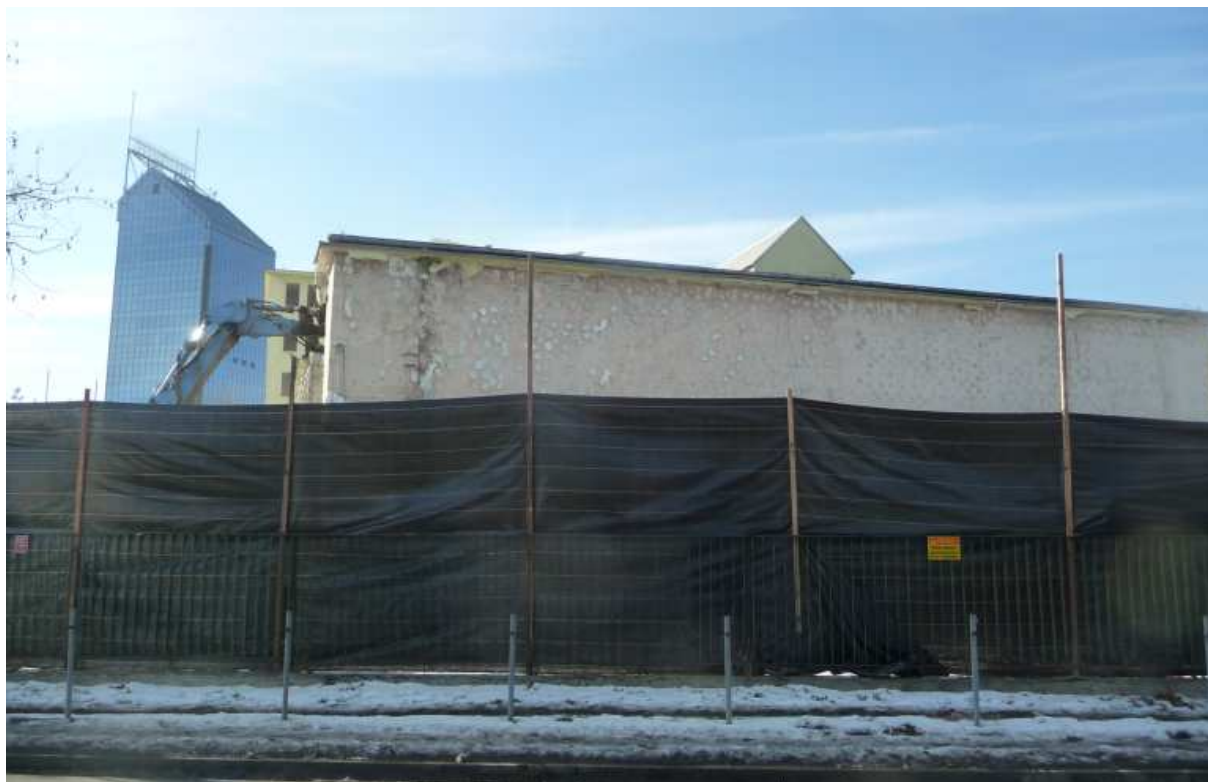
Fot. nr 156. Widok z ulicy Rogozińskiego. (05.02.14)
