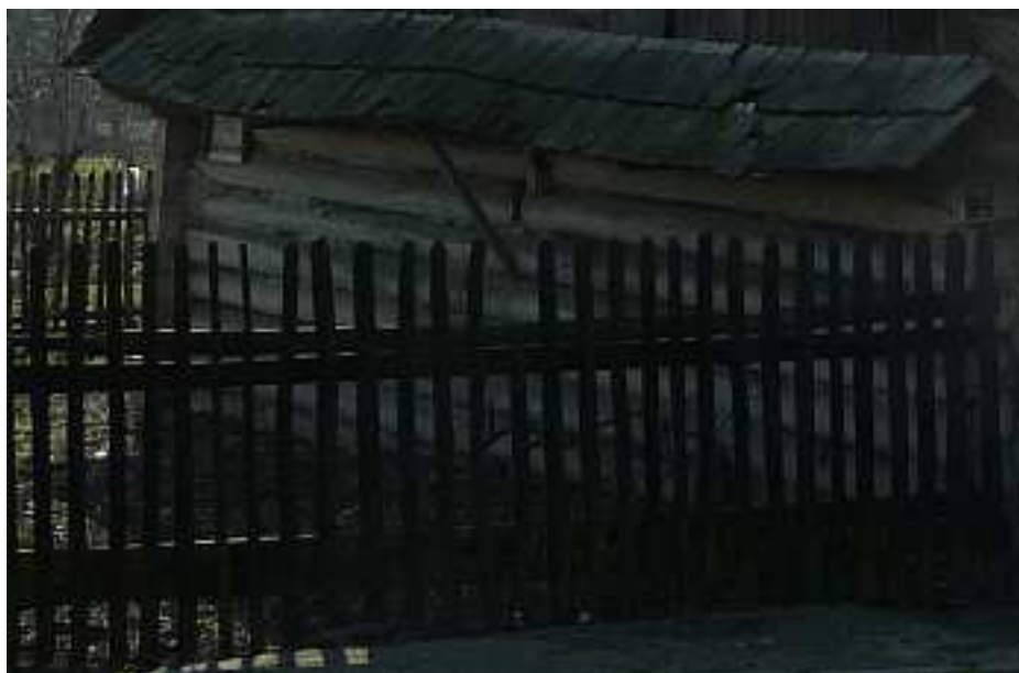
Fot. nr 75 (75-76). Boczna ściana (09.03.14)
