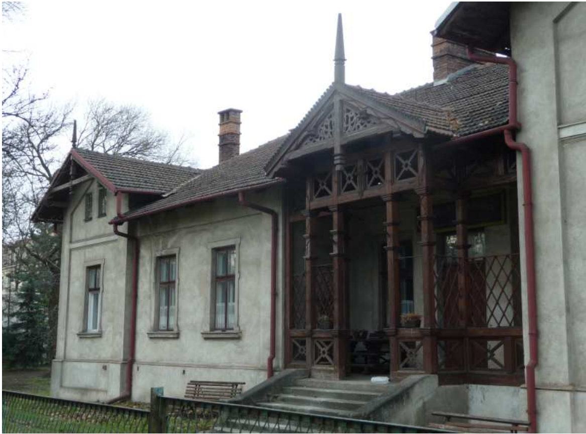
Fot. nr 8. Lewy fragment fasady – widok od strony ulicy Sieroszewskiego. (08.03.14)
