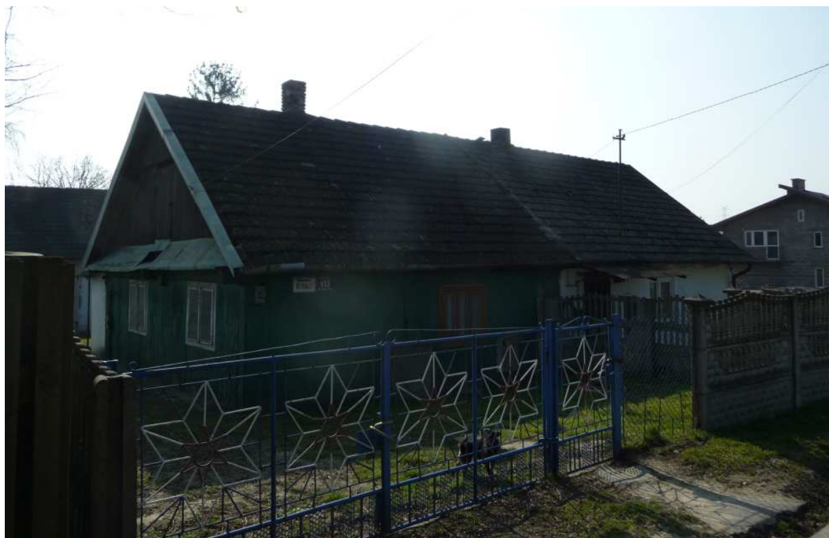
Fot. nr 91 (91-92). Stara chałupa z ulicy Kopaniec 12. (09.03.14)
