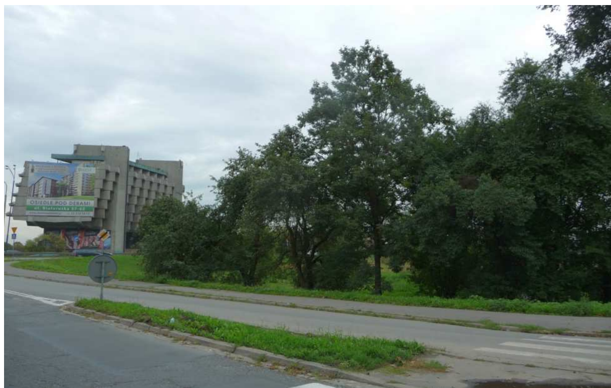
Fot. nr 132 (132-133). Widok od strony Osiedla Podwawelskiego. (25.09.13)
