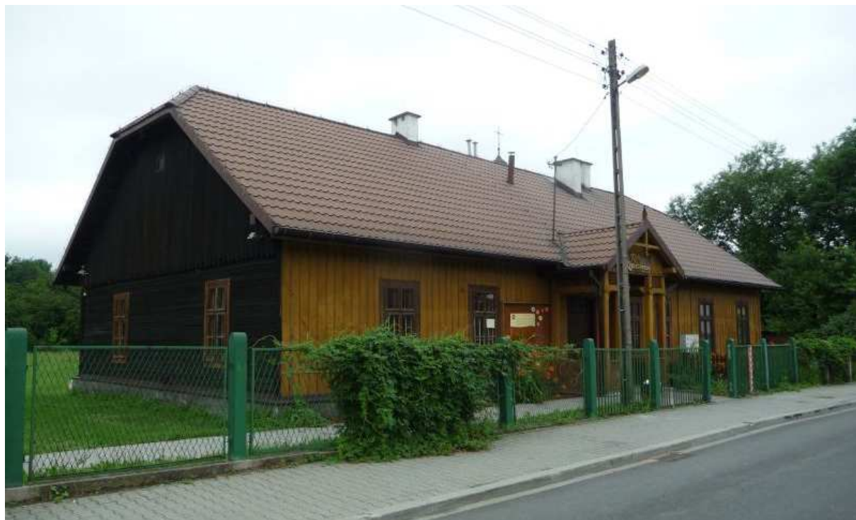
Fot. nr 39 (39-40). Fasada od strony ulicy Wańkowicza. (25.06.13)
