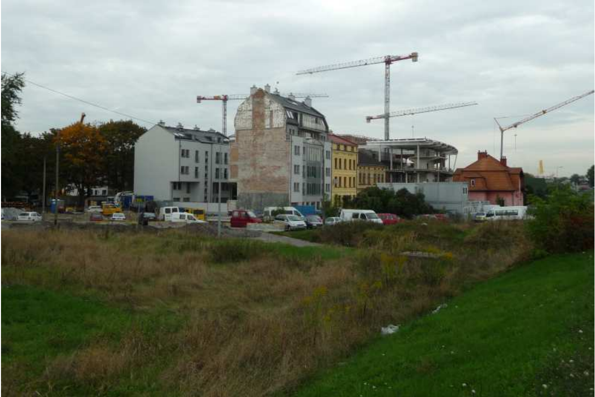
Fot. nr 97 (97-100). Fragment przebudowywanego odcinka ulicy Barskiej o numerach: 57-61. Kamienica pod nr 63 została właśnie wyburzona. (25.09.13)
