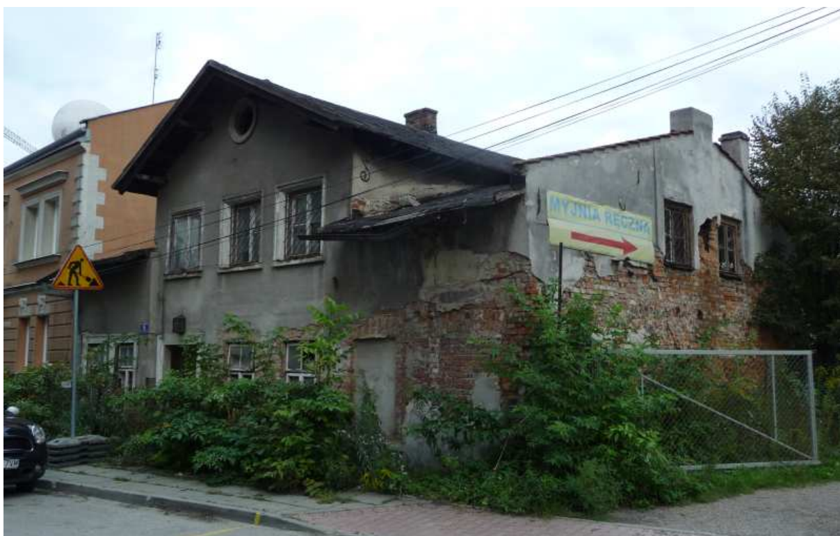
Fot. nr 122 (122-125). W klimacie galicyjskiego Zakrzówka. Ruina podmiejskiego domku spod nr 16. (25.09.13)
