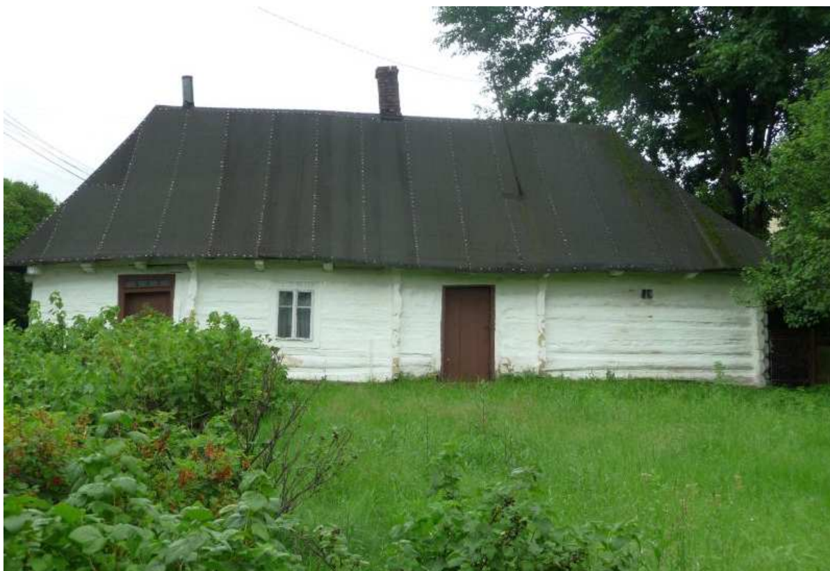
Fot. nr 13 (13-15). Widoki od strony ulicy Krasnowolskiego. (25.06.13)
