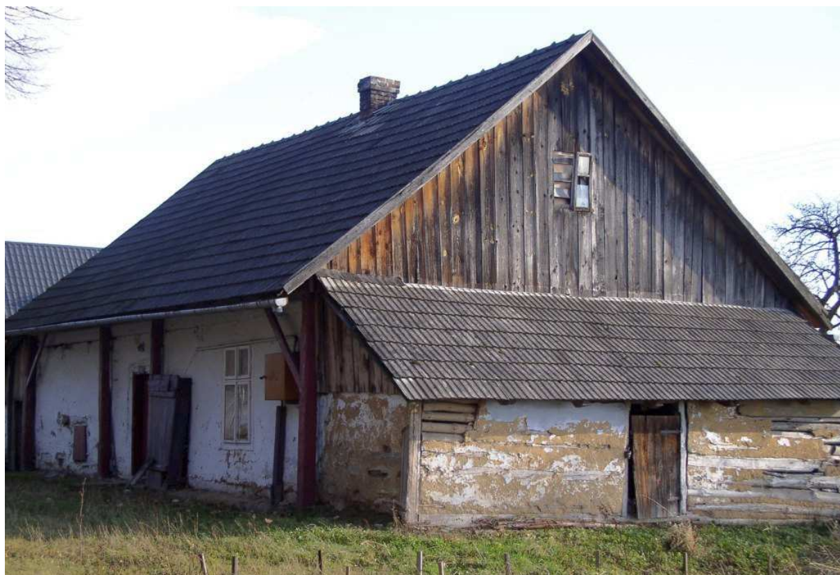
Fot. nr 79 (79-80). Opuszczona przez lata chałupa z Kobyłca (02.12.08)
