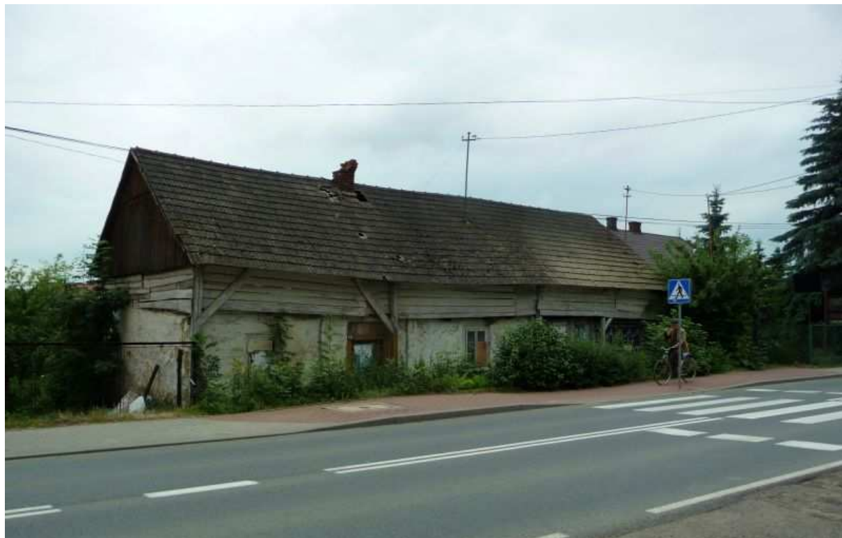
Fot. nr 36 (36-39). Odchodząca w niebyt chałupa spod nr: Gdów 148, zlokalizowana naprzeciw budynku LO. (27.06.13)
