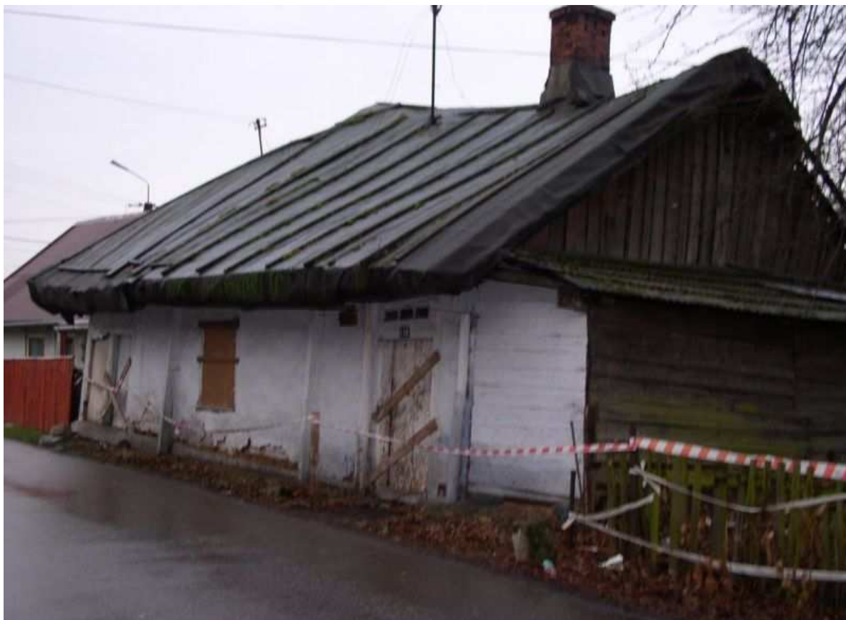
Fot. nr 74. Ulica Obrytka - Gdów 152. (21.12.08)
