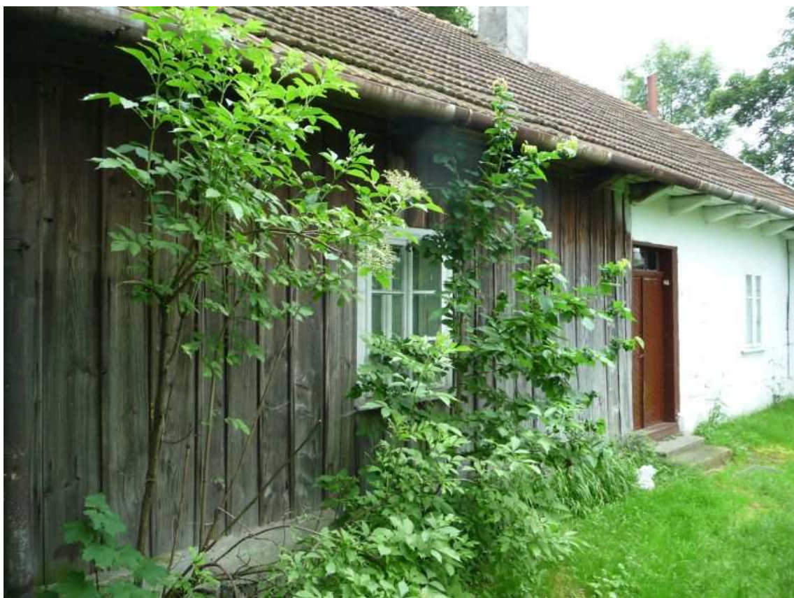
Fot. nr 28. Widok od strony podwórka. (27.06.13)
