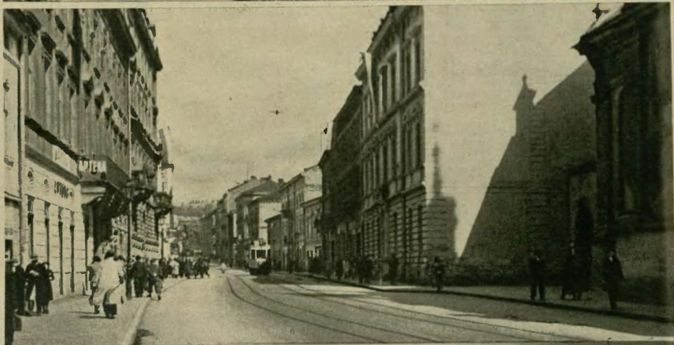
Część ulicy Łyczakowskiej po przebudowie w 1938 r.
