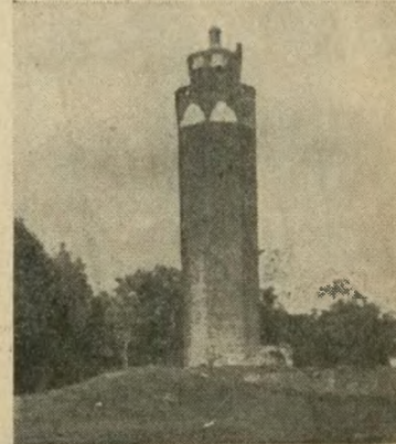
Baszta pozamkowa w Brodnicy nad Drwecą.
