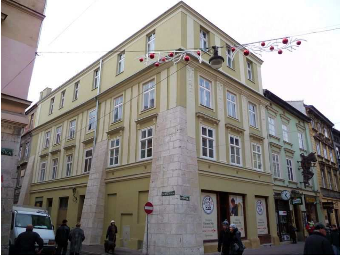
Fot. nr 37. Gdyby nie ta szpetna nadbudówka w kamienicy przy ulicy Szewskiej 10 (w narożu z ulicą Jagiellońską), byłby to ciekawy przykład zabudowy z końca XIX-go wieku. (07.01.12)
