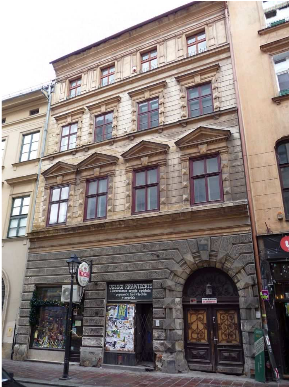
Fot. nr 32. Typowa, mieszczańska kamienica z ulicy Szczepańskiej 9, w której dobudowano III piętro. (07.01.12)
