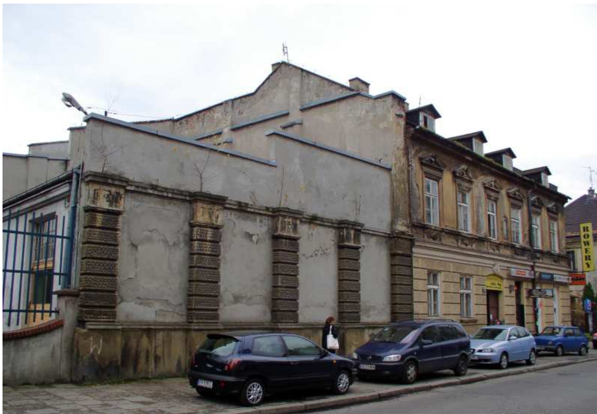
Fot. nr 55. Nieistniejące już zabudowania na obrzeżu zakładów tytoniowych przy ulicy Czarnowiejskiej 4. 08.11.10
