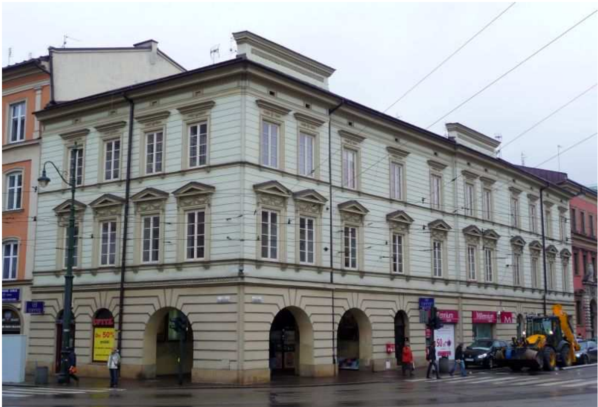
Fot. nr 82. Klasycystyczny budynek z naroża ulic: Stradom (2) i św. Gertrudy (25), któremu ostatnio przywrócono dawny wygląd. (10.01.12)
