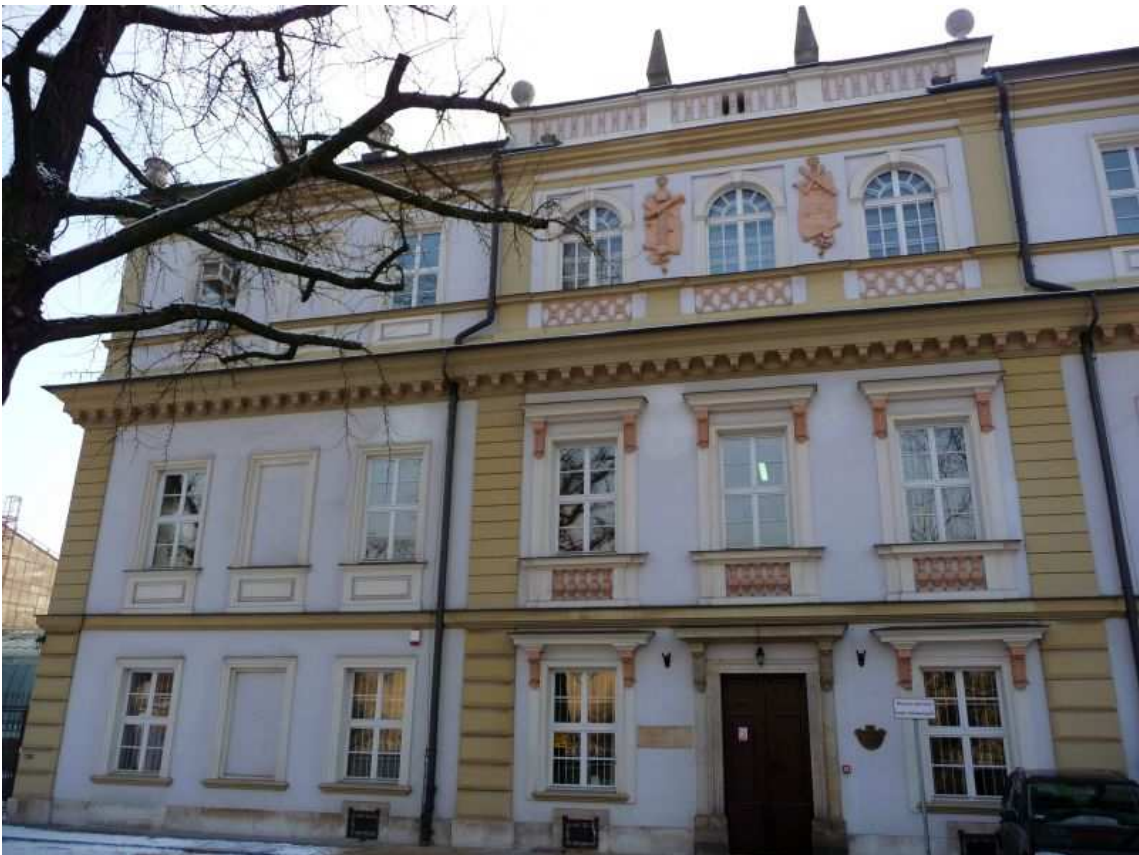
Fot. nr 70. Część środkowa i lewe skrzydło budynku. (23.12.11)
