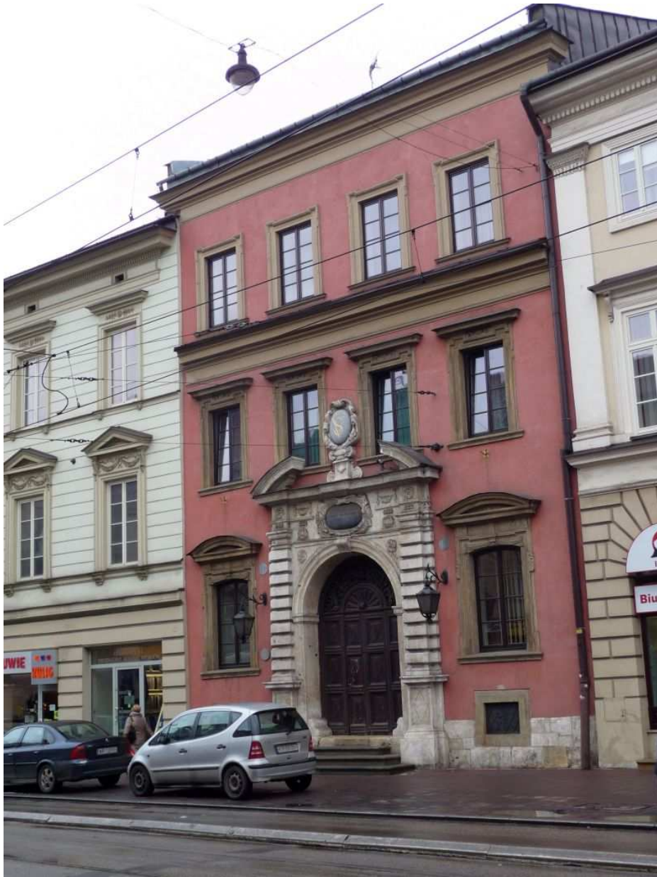
Fot. nr 83. Odnowiony budynek przy ulicy Stradomskiej 4, z pięknym barokowym portalem, który przynależy do klasztoru Misjonarzy. (10.01.12)
