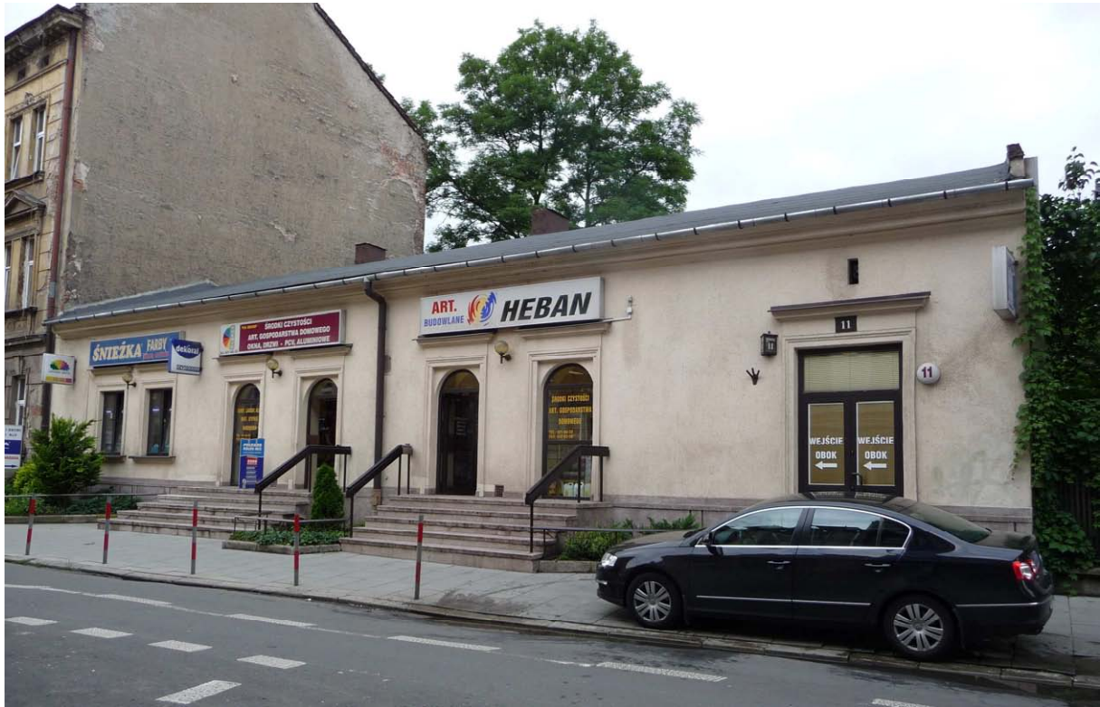
Fot. nr 50a. Mocno zniekształcona przez współczesne przebudowy podmiejska willa z ulicy Garbarskiej 11. 28.06.13
