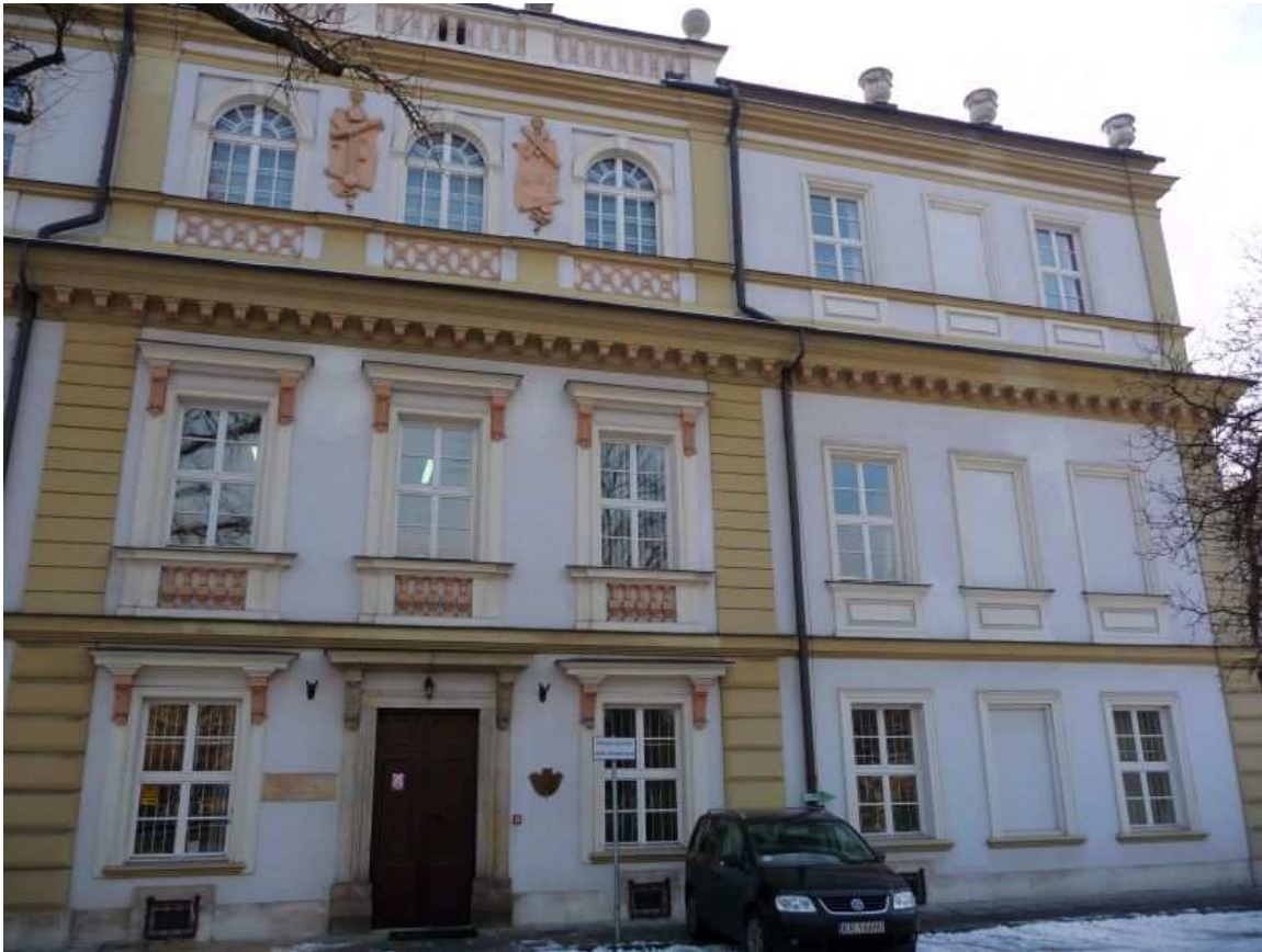
Fot. nr 71. Część środkowa i prawe skrzydło budynku. (23.12.11)
