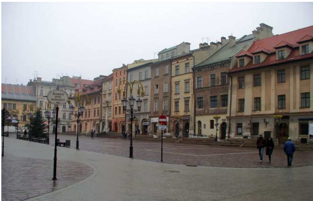
Fot. nr 9 (9-11). Wschodnia pierzeja Małego Rynku, której po 1970 roku przywrócono klasycystyczny charakter. (07.01.12)
