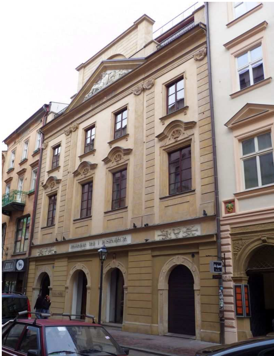
Fot. nr 31. Jeden z najokazalszych klasycystycznych budynków na terenie Krakowa – kamienica Steinkellera z ulicy Szczepańskiej 5, przebudowana w I połowie XIX-go wieku. (07.01.12)
