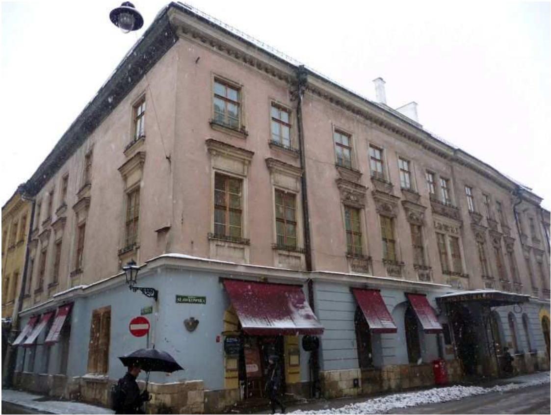
Fot. nr 29. Jednolity w swym kształcie (po dokonanej 30 lat temu rewaloryzacji) budynek Hotelu Saskiego z naroża ulic: Sławkowskiej (3) i św. Tomasza. (17.02.12)
