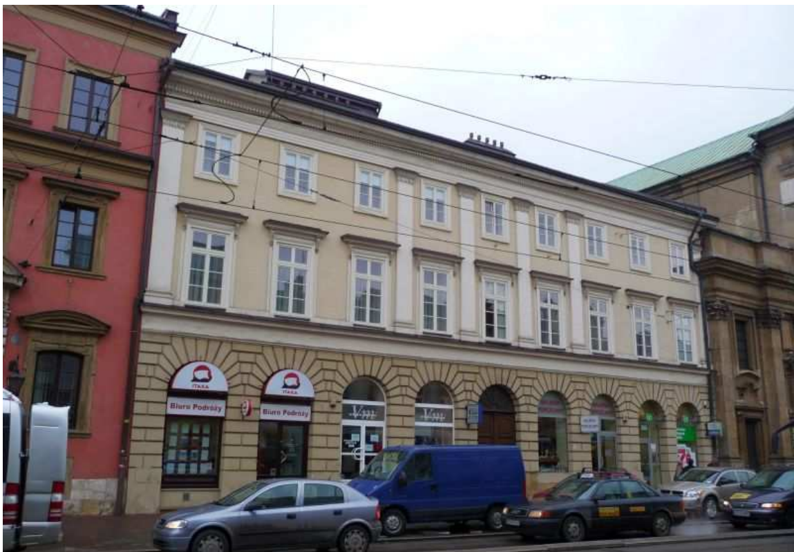
Fot. nr 85. Ostatnio odnowiona i uporządkowana fasada budynku. (10.01.12)
