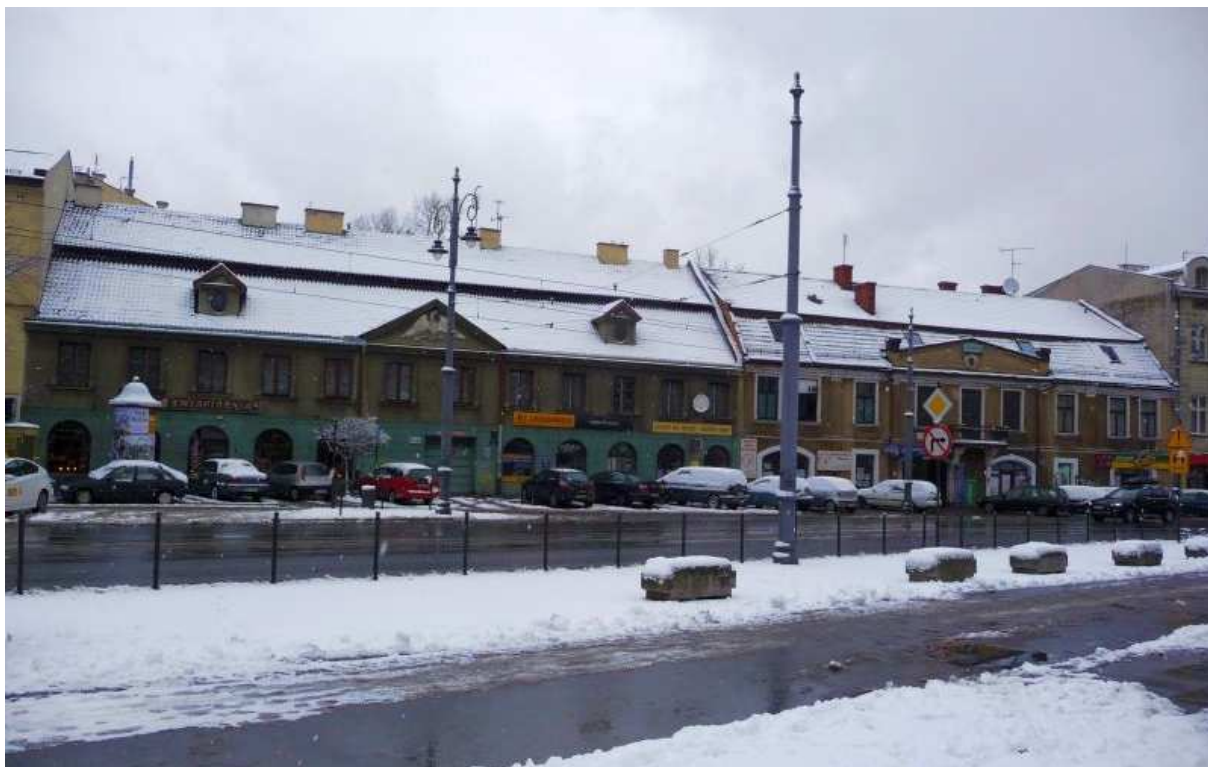
Fot. nr 99 (99-100). Fragment zabudowy zachodniej pierzei Rynku Podgórskiego, która powstała na początku XIX-go wieku. Z lewej kamienica Pod Czarnym Orłem (dziś przemalowaną na biało) pod nr 13, z prawej zaś kamienica Pod Białym Orłem (nr 14), choć bez orła w fasadzie. (14.01.12)
