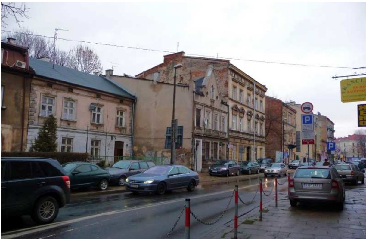
Fot. nr 61. Fragment zabudowy ulicy Czarnowiejskiej do nr 23. (10.01.12)
