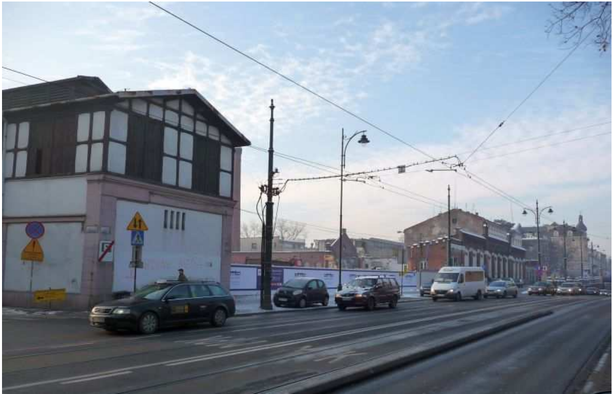
Fot. nr 75. Pozostałości po dawnym browarze – widok od strony ulicy Lubicz. (23.12.11)
