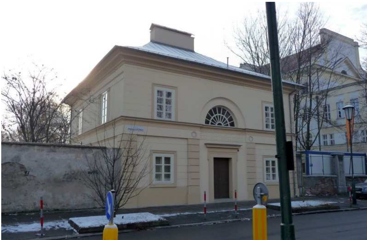
Fot. nr 72 (72-73). Fasada budynku oficyny z ulicy Kopernika 27, który przylegają do gmachu dawnego Obserwatorium Astronomicznego. (23.12.11)
