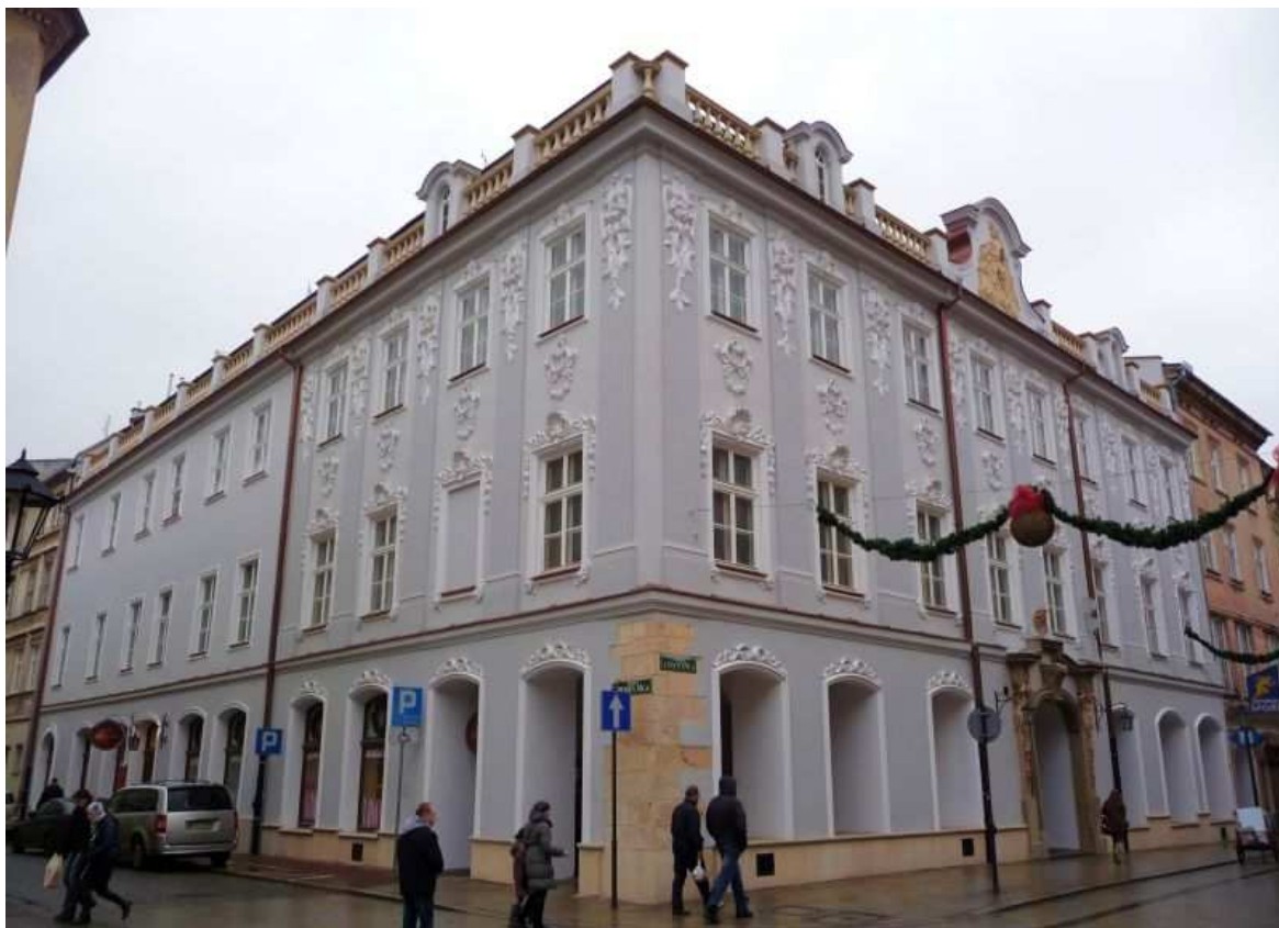
Fot. nr 41. Neorokokowy Pałac Stadnickich z ulicy Grodzkiej 40, który obecną postać uzyskał po przebudowie z połowy XIX-go wieku. (10.01.12)
