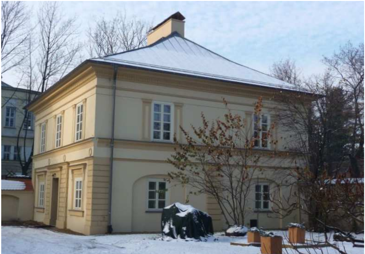
Fot. nr 73. Tylna część budynku oficyny, obiektu o cechach klasycystycznych. (23.12.11)
