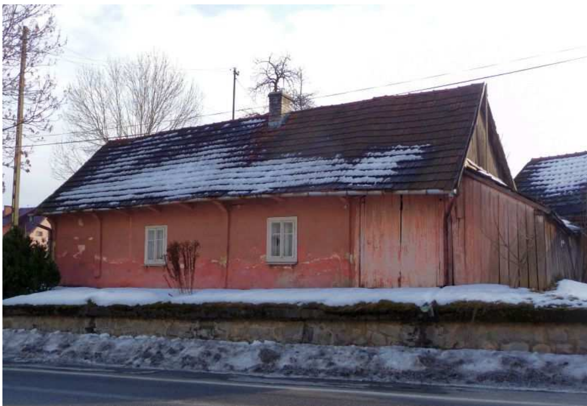
Fot. nr 65. Jeszcze jedno ujęcie bocheńskiego antyku od strony ulicy. (20.02.2012)
