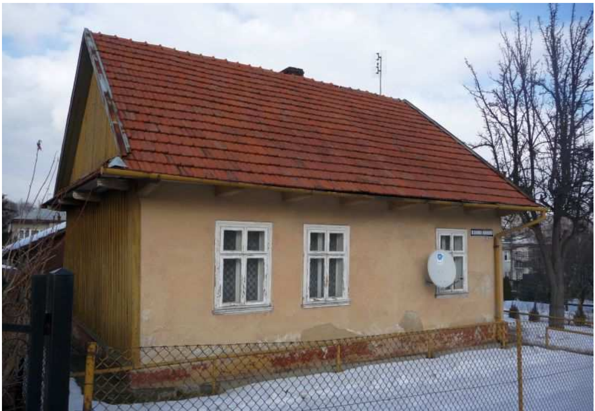
Fot. 54. Fasada domku, który zachował oryginalną stolarką okienną. (20.02.2012)
