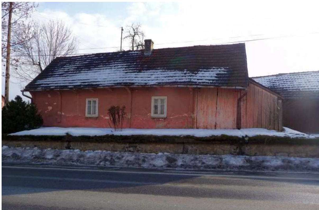
Fot. nr 64. Fasada chałupy, do której przylega część gospodarcza. (20.02.2012)
