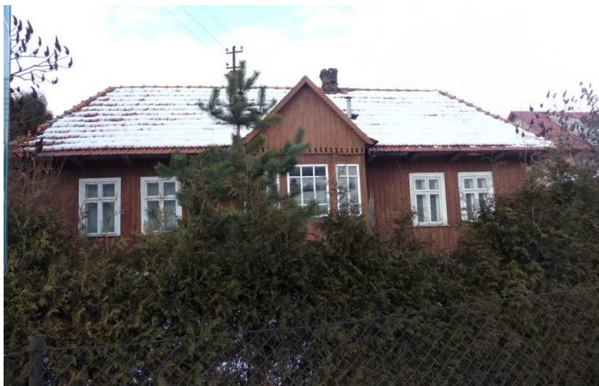
Fot. nr 83. Fasada domu, który zachował oryginalną stolarkę ganku i okien. (20.02.2012)
