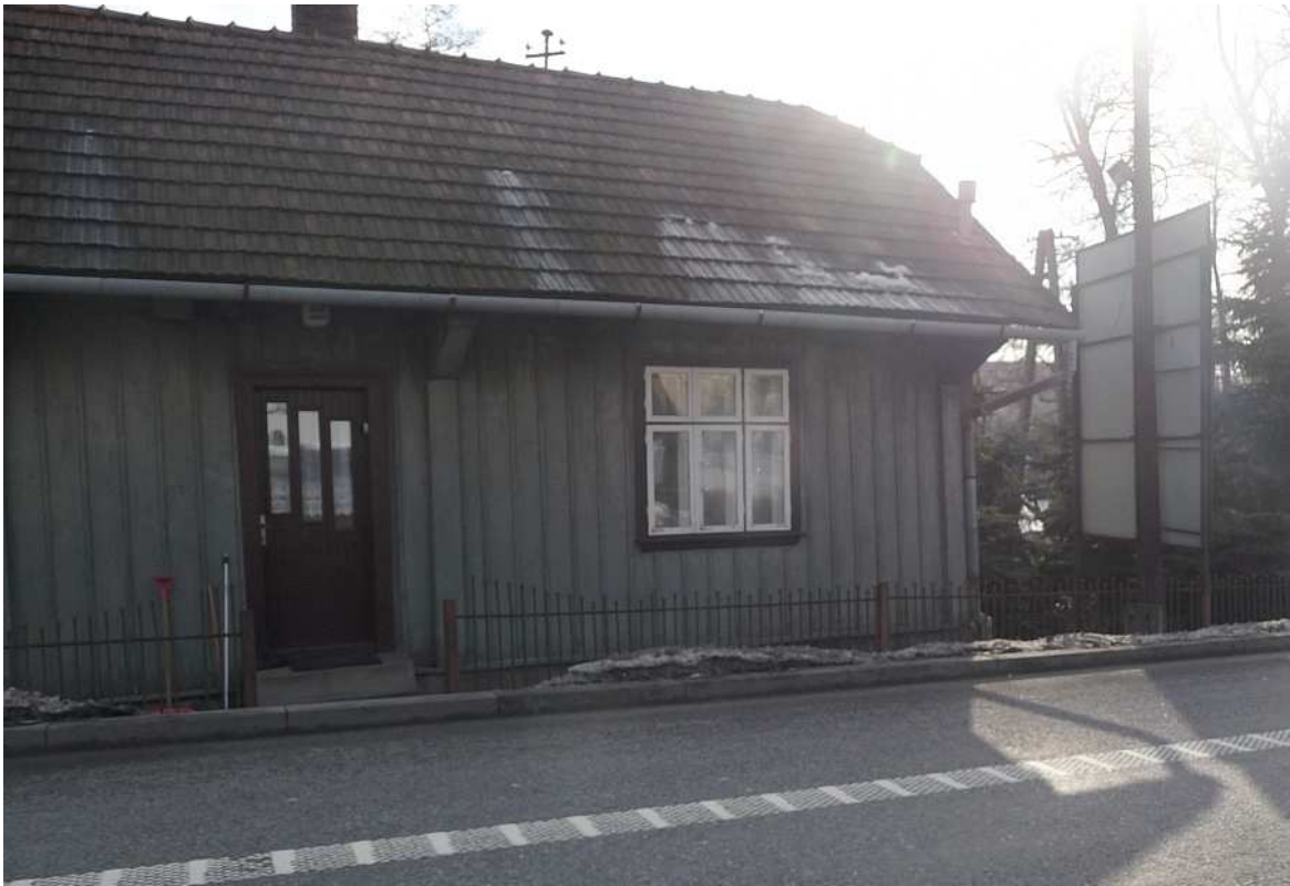
Fot. nr 86. Fragment obitego boazerią, może jeszcze przedwojennego łapczyckiego domu ze środkowej części wsi (pod nr 79). Okno jest w nim ciągle oryginalne. (20.02.2012)
