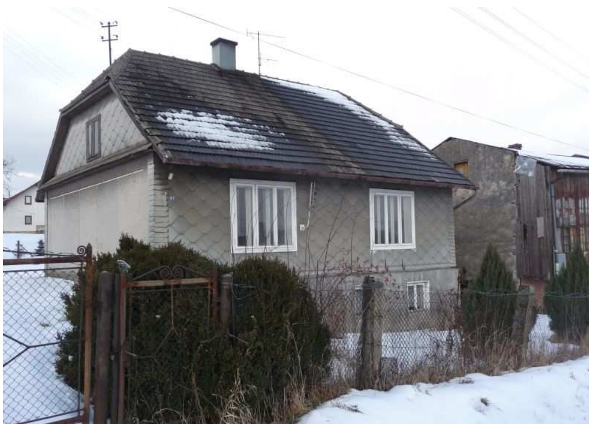
Fot. nr 71. Podmiejski domek z ulicy Brodzińskiego 57, który mógł powstać tuż po II wojnie światowej i jego łuskowata boazeria. (20.02.2012)
