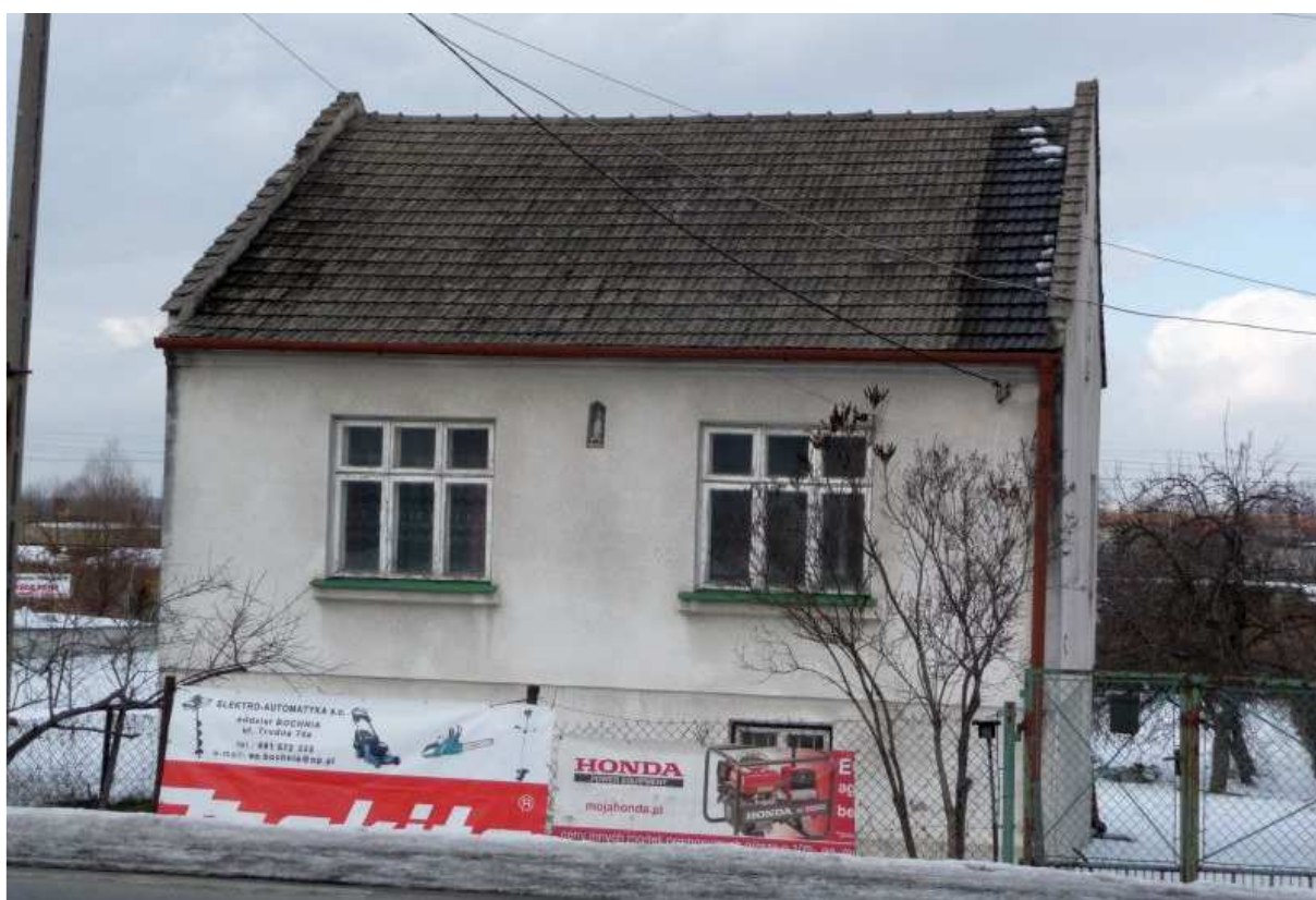
Fot. nr 30. Murowany domek z ulicy Brzeskiej 50, który nadal zachował tradycyjną stolarką okienną. (20.02.2012)
