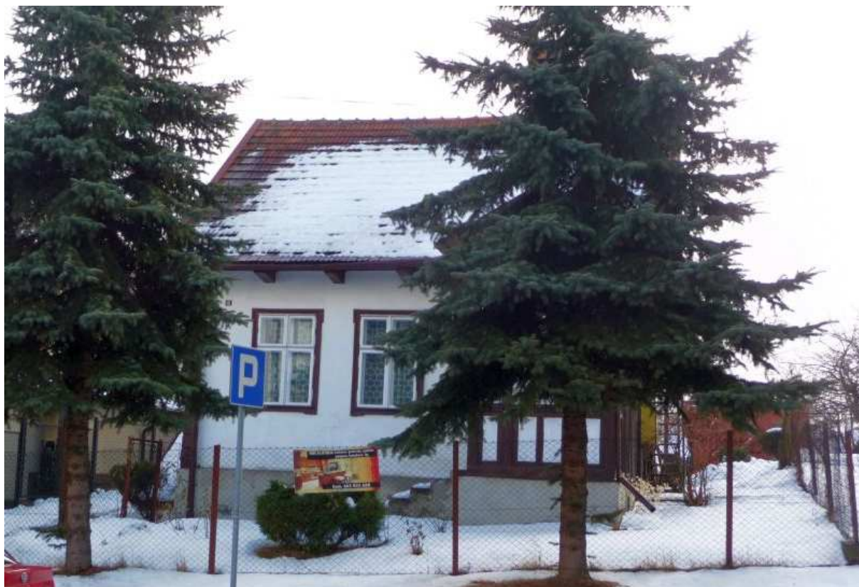
Fot. nr 56. Fasada domku, który zachował dawne, oryginalne okna z cienkimi szprosami. (20.02.2012)
