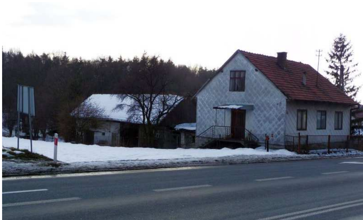
Fot. nr 78. Stara zagroda z ulicy Brodzińskiego 92. Dom z nieoryginalnymi oknami i bozerią łuskową mógł powstać w okresie międzywojennym. (20.02.2012)
