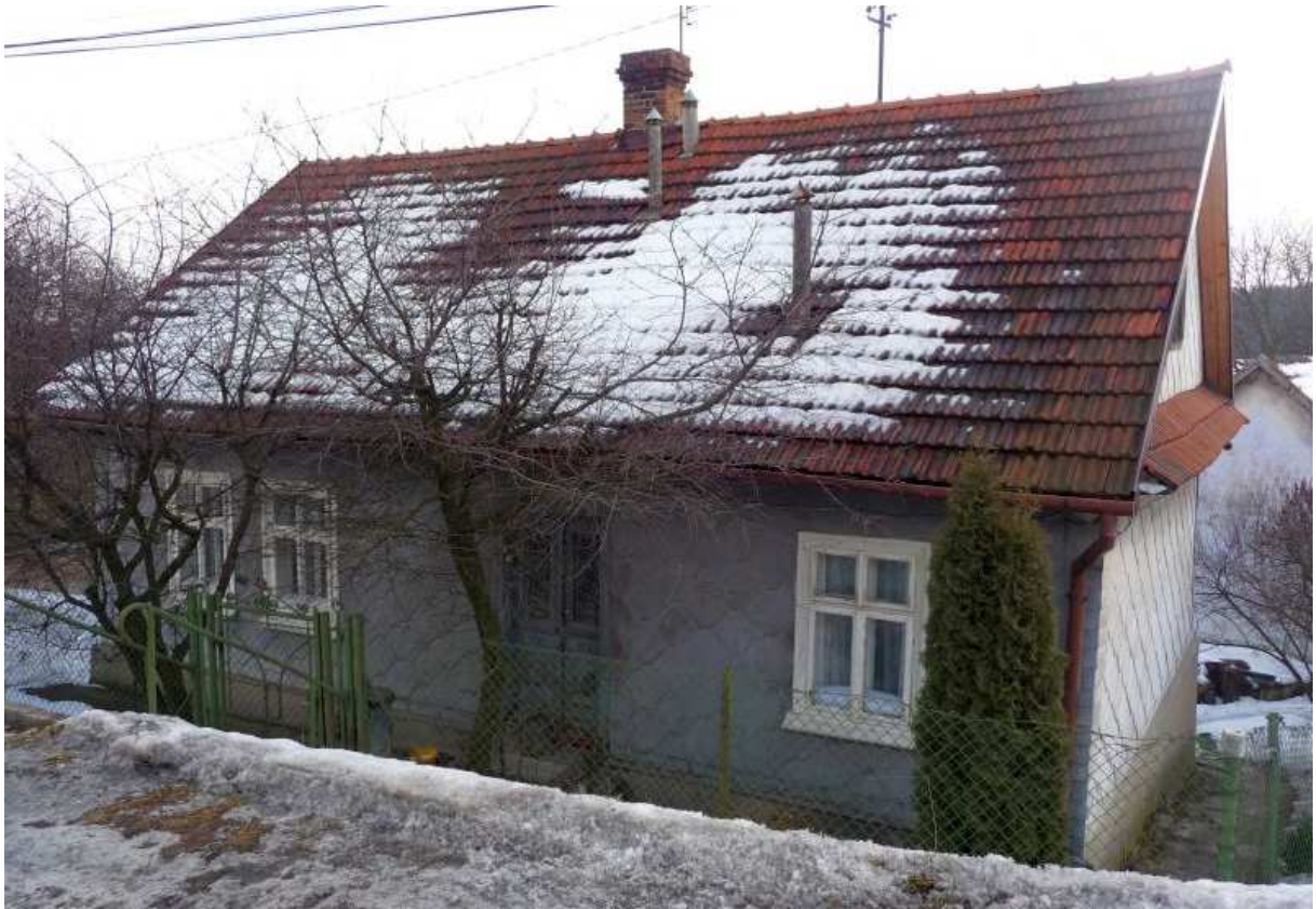
Fot. nr 76. Dawne pochodzenie tego blisko stuletniego domku podkreśla jego znaczne obniżenie w stosunku do aktualnego poziomu jezdní. (20.02.2012)
