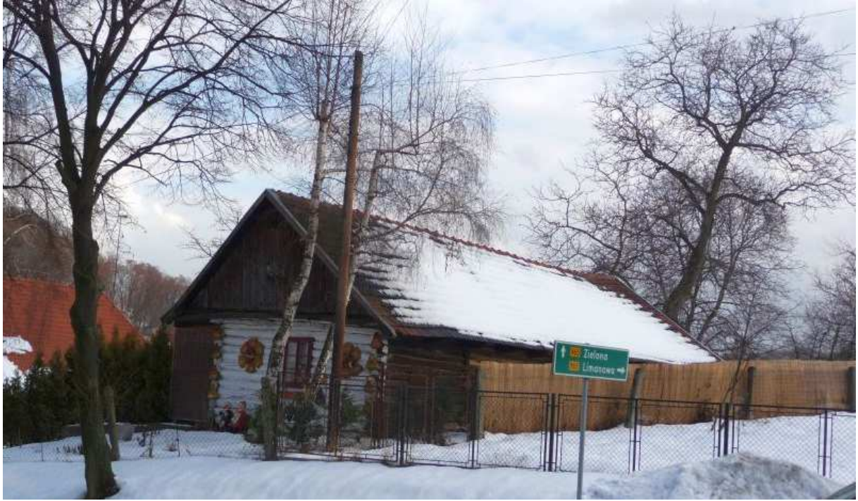
Fot. nr 8 (8-9). Wiejska chałupa, z pewnością z XIX-to wieczną metryką, z ulicy Brodzińskiego 2. (20.02.2012)
