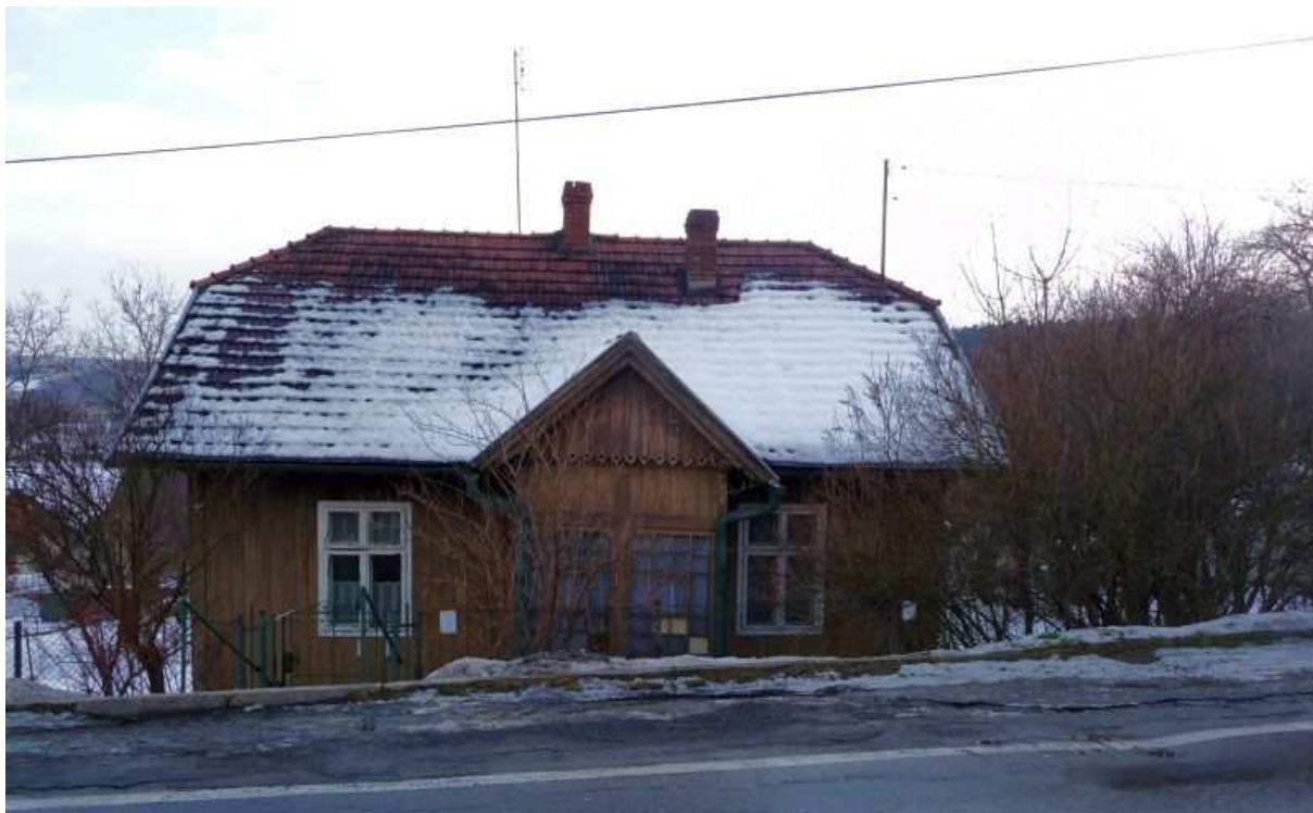
Fot. nr 18. Drewniany domek z ulicy Brodzińskiego 44, typowy dla zabudowy międzywojennej. (20.02.2012)
