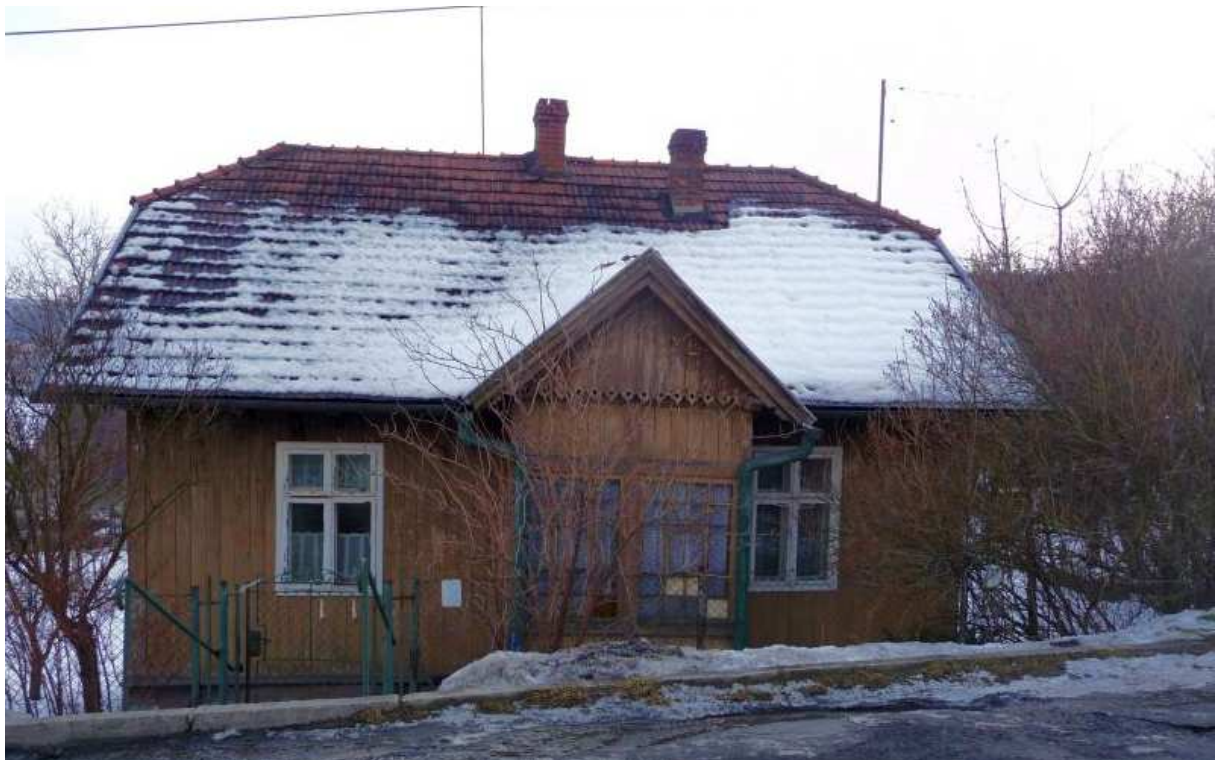
Fot. nr 73. Fasada domku, który dziś stoi sporo poniżej poziomu ulicy. (20.02.2012)
