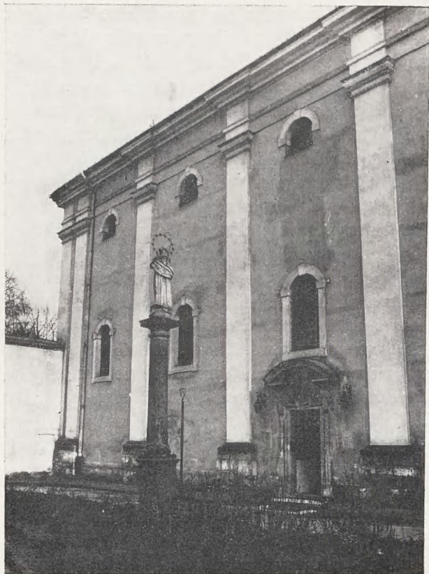
5. Kościół SS. Dominikanek — elewacja zachodnia
