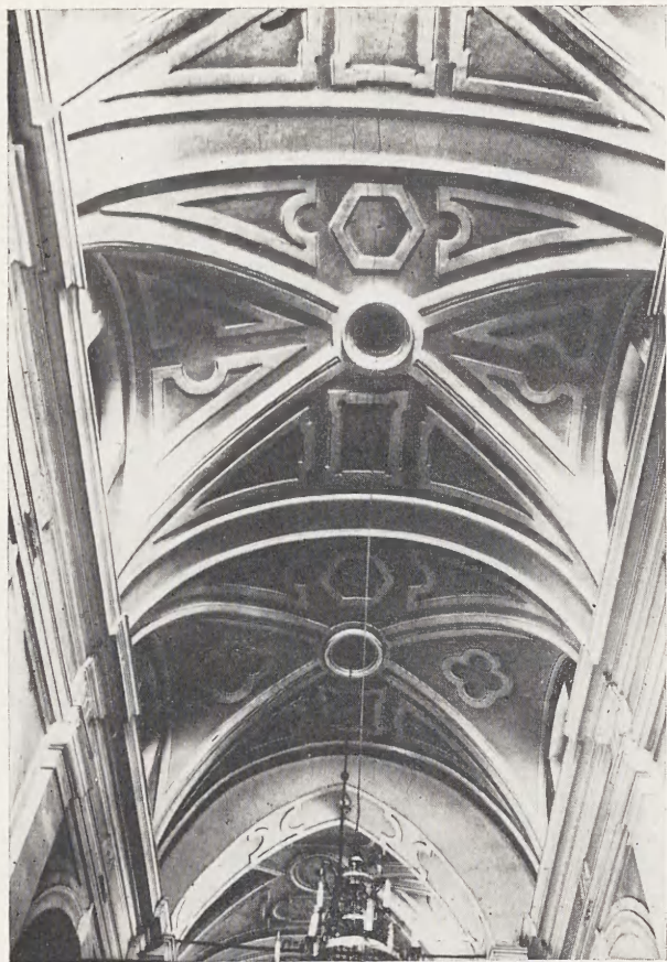
7. Kościół p.w. Św. Marka — fragment artykulacji nawy głównej z widokiem na sklepienie
