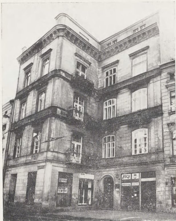
23. Bogumił Trenner, dom przy placu Dominikańskim 4, stan obecny
