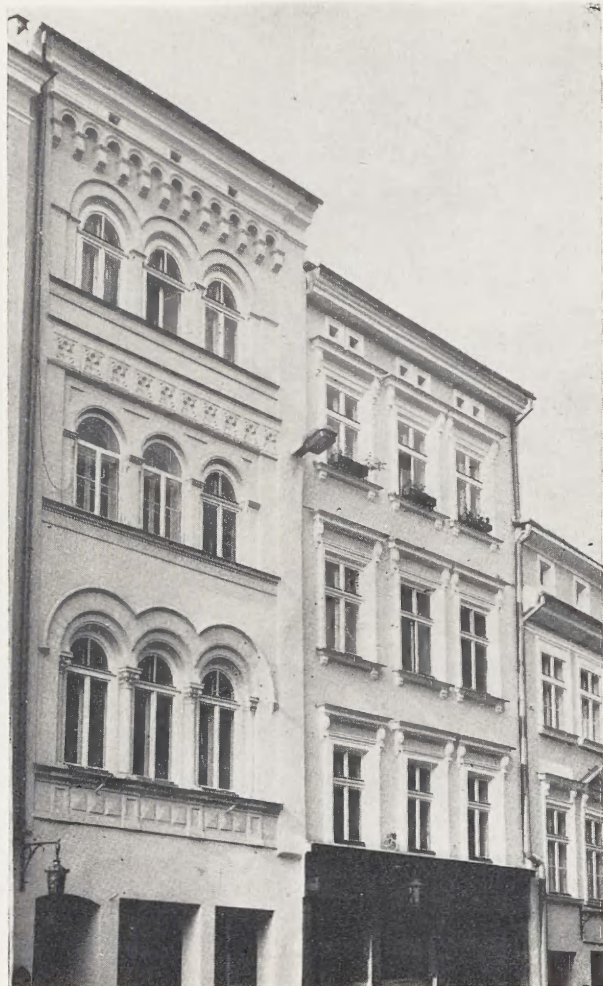
8. Antoni Stacherski, dom Armatysa przy ul. Grodzkiej 27, stan obecny
