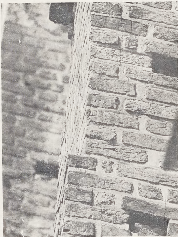
1. Kościół Bożego Ciała, prezbiterium, fragment przy-pory w elewacji południowej
