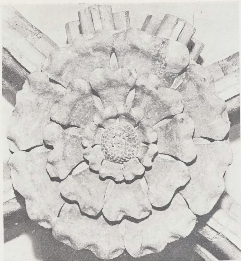
11. Katedra na Wawelu — zwornik sklepienia d. kaplicy Św. Małgorzaty, stan po konserwacji
