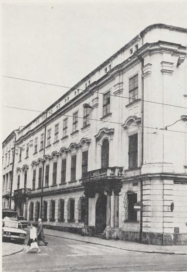
9. Pałac Larischa od strony kościoła Franciszkanów, elewacja barokowa przekształcona w wieku XIX, stan obecny
