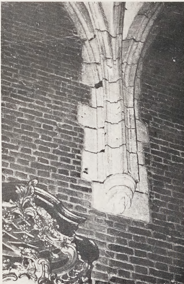
9. Kościół Bożego Ciała, nawa południowa, wspornik w ścianie zewnętrznej
