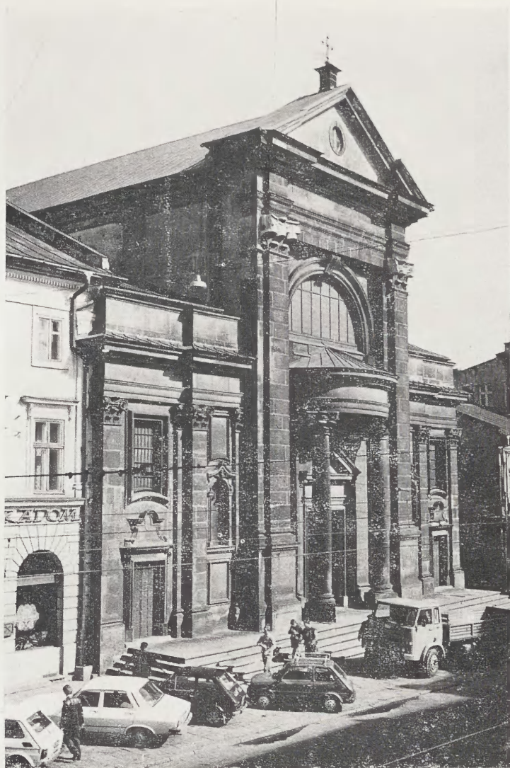
4. Fasada kościoła Misjonarzy na Stradomiu, stan obecny
