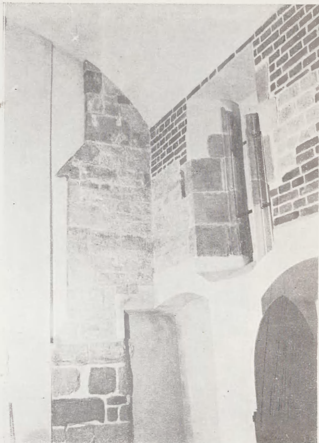
7. Fragment d. elewacji północnej kaplicy Św. Małgorzaty — stan po odsłonięciu i konserwacji
