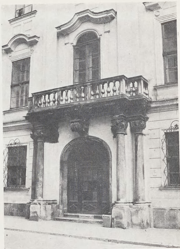
4. Portal bramny elewacji frontowej pałacu Stefana Jordana, stan obecny
