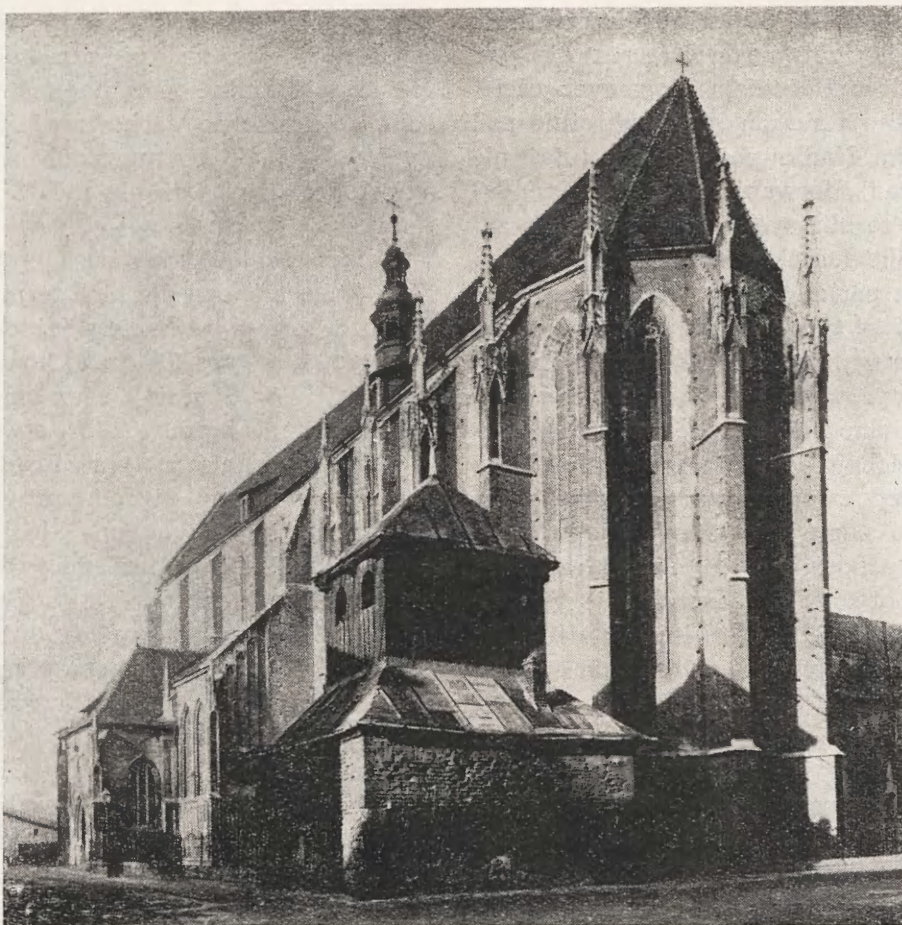
9. Kościół Św. Katarzyny, widok od połudn. wschodu
