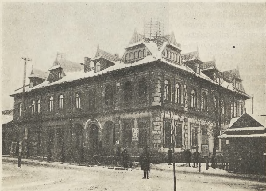
Ryc. 26. — Poczta zakopiańska przed przebudowaniem.
