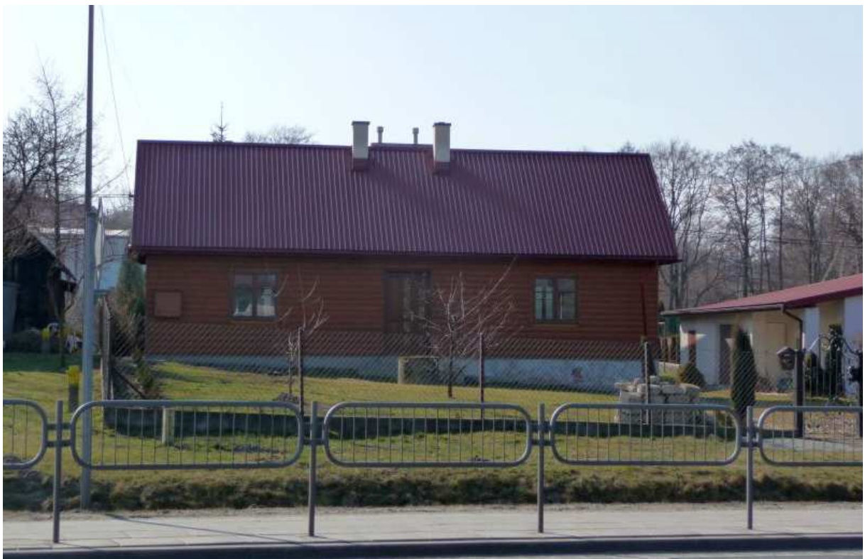
Fot. nr 91. Ten sam dom po przebudowie (07.03.2012).
