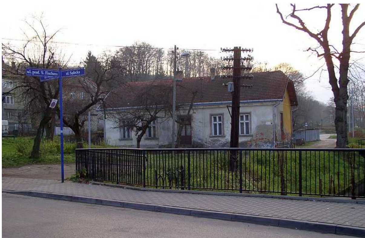
Fot. nr 36. Parterowy dom mieszkalny z ulicy Sądeckiej 7, który mógł powstać w I ćwierci XX wieku. (20.11.2010)
