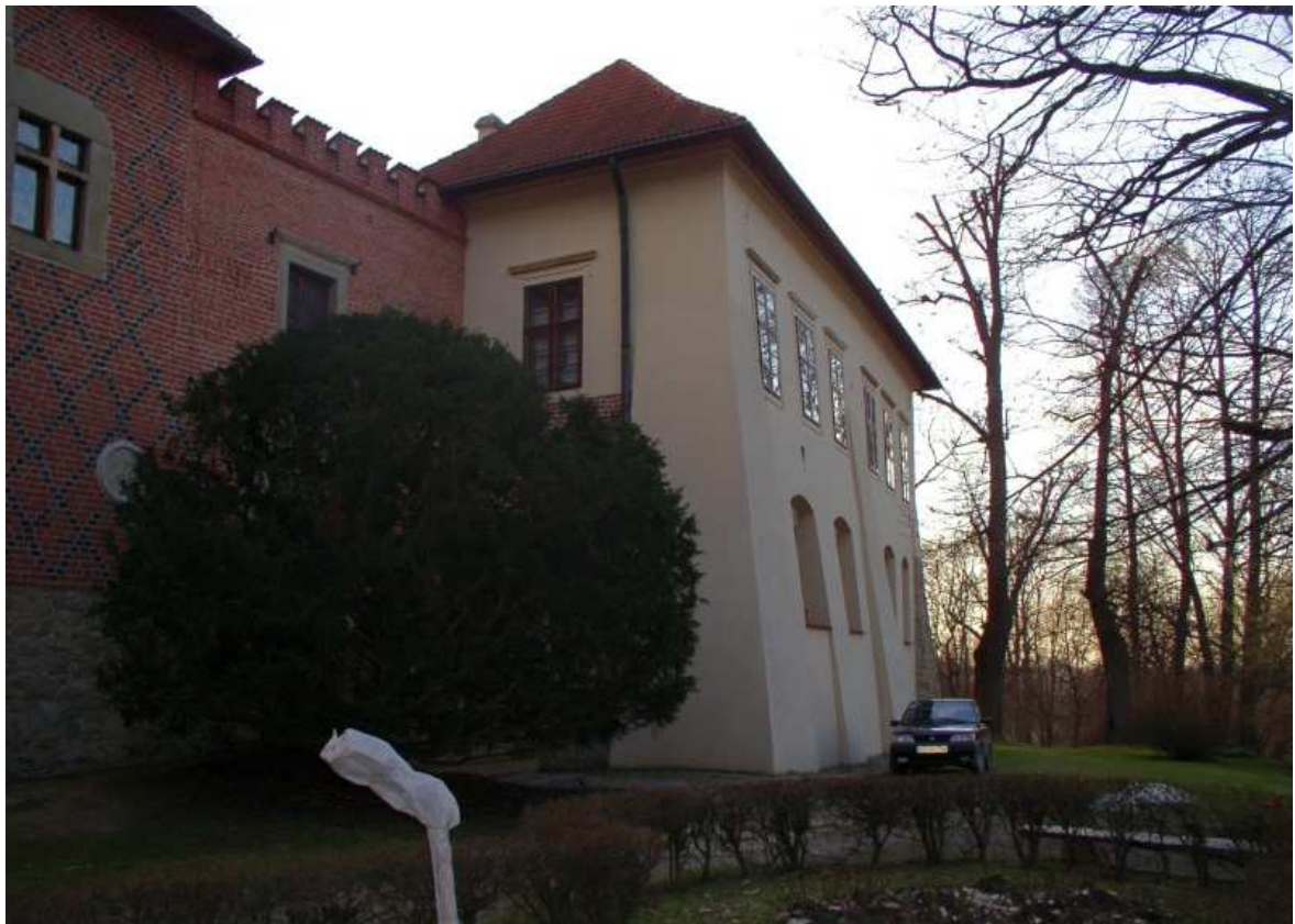
Fot. nr 115. Późniejsza dobudówka do części południowej o cechach klasycystycznych.
