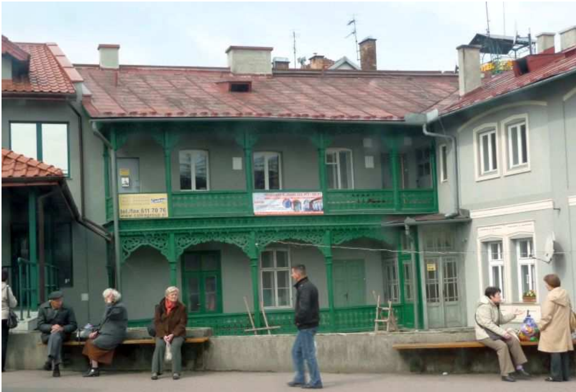
Fot. nr 52. Oryginalna fasada domu spod nr 3 z ażurowym zdobnictwem. (19.04.2012)
