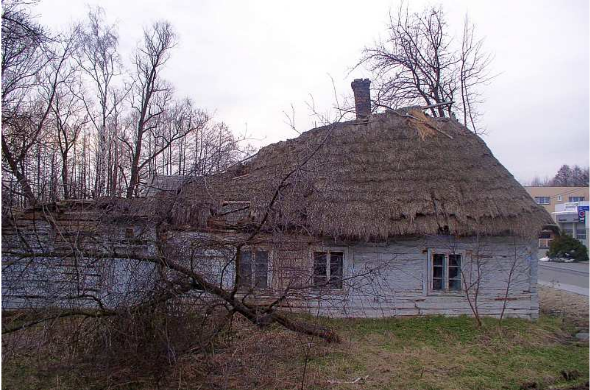
Fot. nr 135. Fasada chałupy, której już nie ma – zniknęła na wiosnę 2010-go roku. (15.03.2009)
