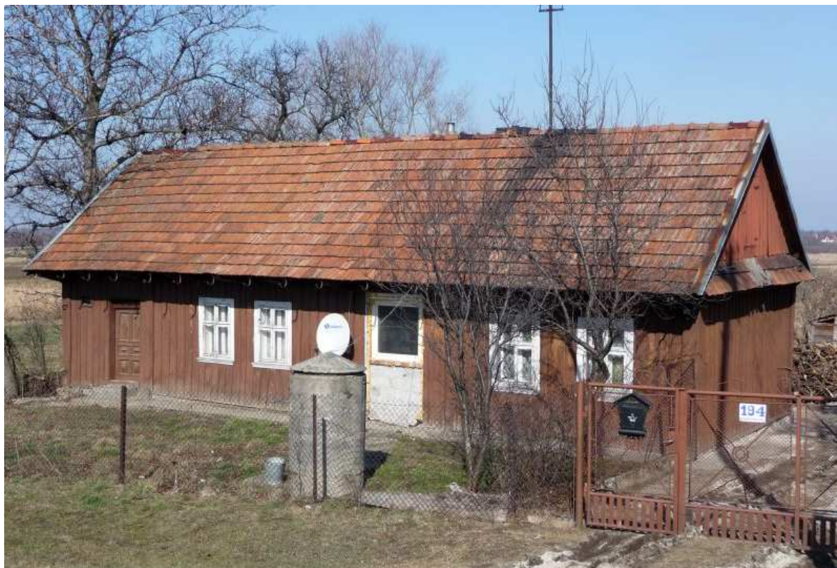
Fot. nr 62. Niemal oryginalna fasada – tylko dawny ganek został przerobione na okno. (07.03.2012)
