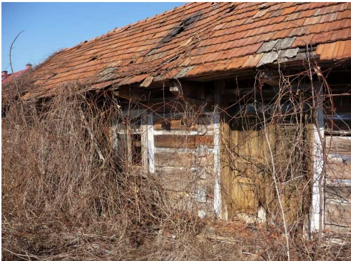
Fot. nr 58. Detale fasady poprzecznie belkowanej chałupy. (07.03.12)
