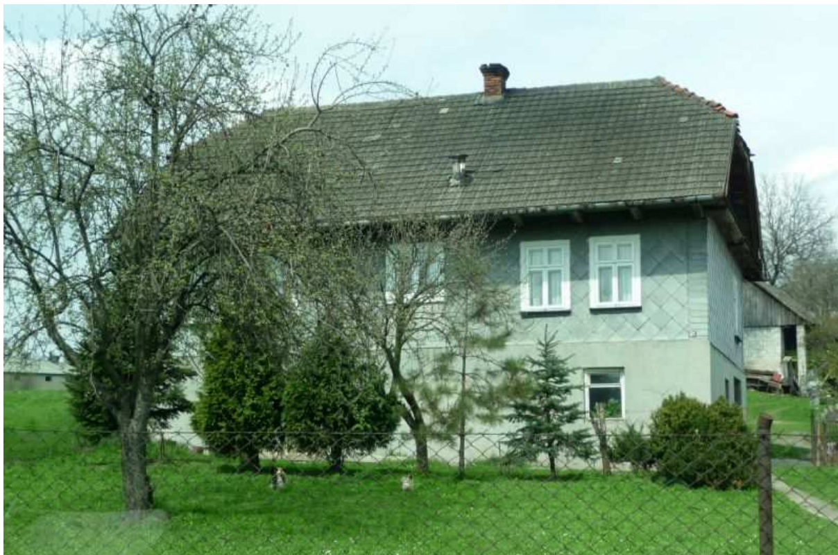
Fot. nr 34. Prawy część domu. (19.04.2012)
