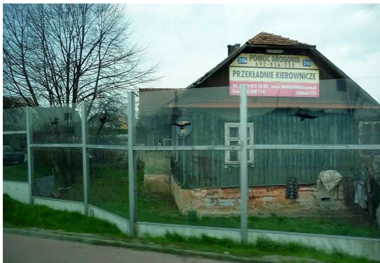
Fot. nr 7 (7-14). Opuszczona już chałupa z Targowiska (nr 231), która zajmuje naroże między drogami: 94 i 75. Fot. nr 7 wykonane z busa. (19.04.12)
