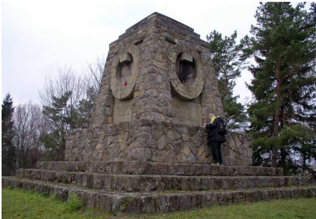
Fot. nr 173. Solidny monument, który przetrwa jeszcze wieki.
