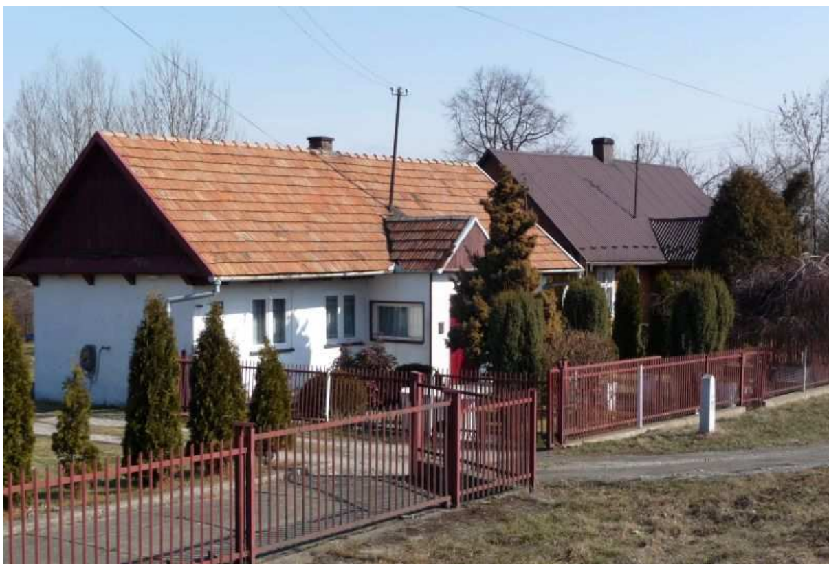
Fot. nr 63. Dalszy fragment zabudowy dawnej ulicówki. Przebudowany już dom z gankiem spod nr 174. (07.03.2012)
