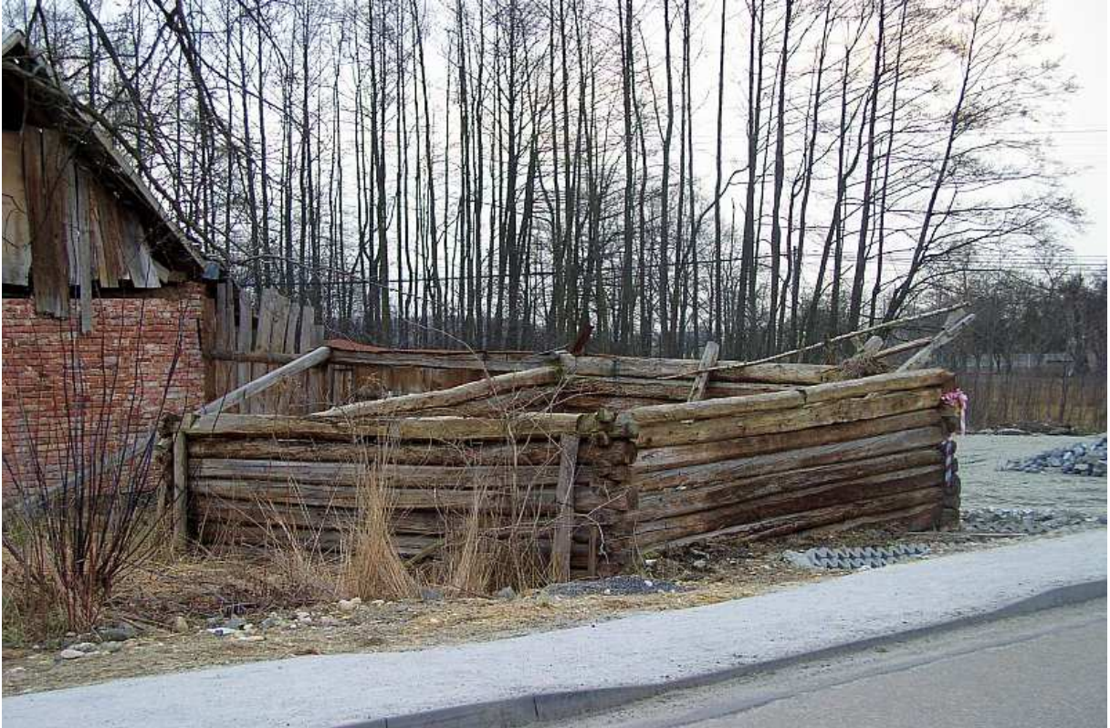
Fot. nr 139. Szczątki dawnego budynku gospodarczego, który do chałupy przylegał od tyłu. (15.03.2009)
