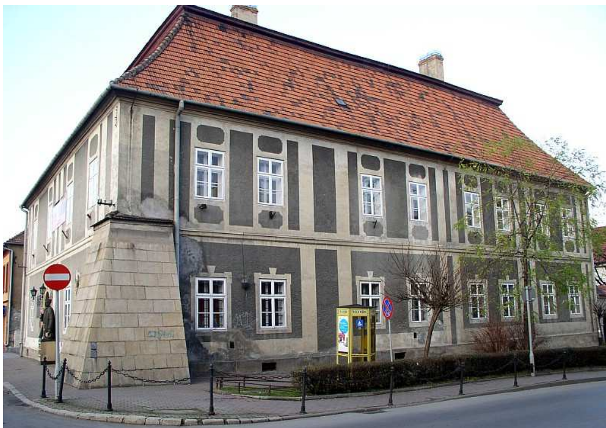
Fot. nr 39. Zabytkowa kamienica z końca XVIII wieku (przebudowany gmach klasztoru poddominikańskiego) przy Rynku 20/Kościuszki 2 – widok z wylotu ulicy Sądeckiej. (20.11.2010)
