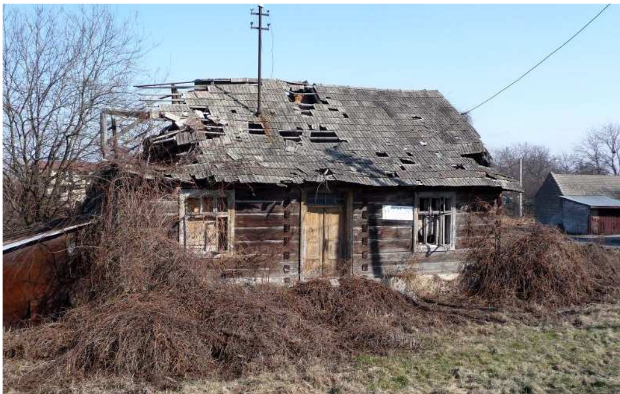
Fot. nr 86. Podobne ujęcie jak na poprzednich dwóch fotografiach. (07.03.2012).
