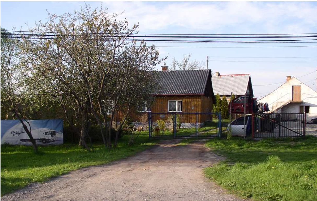
Fot. nr 142. Podobny dom pod nr 43, ale już z wymienionymi oknami na plastikowe. (26.04.2011)
