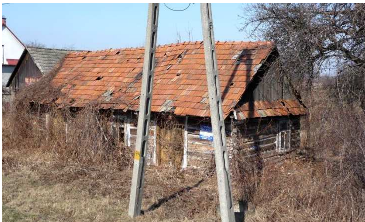
Fot. nr 57. Próba uchwycenia fasady zakrytej warstwą winorośli. (03.07.2012)
