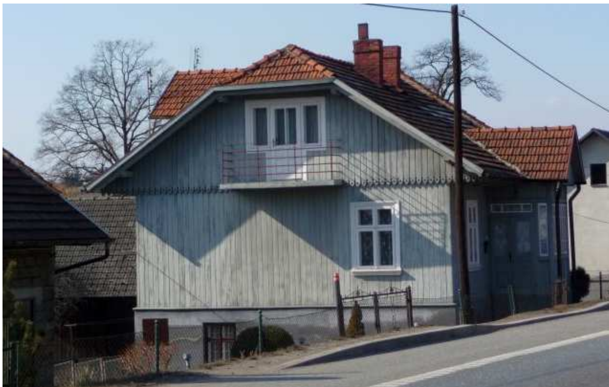
Fot. nr 30. Szczegóły fasady budynku. (07.03.2011)
