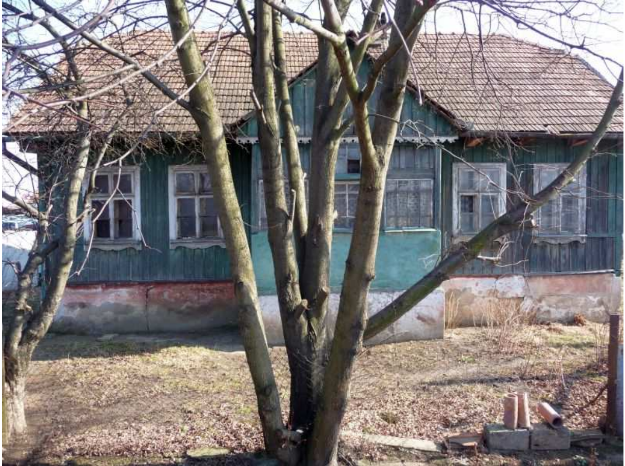
Fot. nr 8 (8-10). Trzy ujęcia oryginalnej fasady chałupy; aż trzy, by ująć każdy jej detal, wszak może niedługo już jej nie będzie? (07.03.11)
