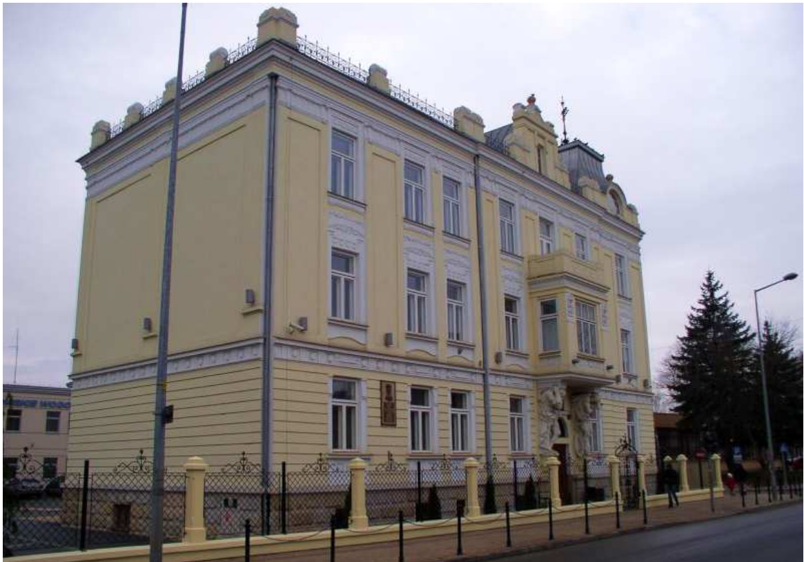
Fot. nr 130 (130-131). Efektowna, modernistyczna kamienica z naroża ulic: Konarskiego i Wodnej. (20.11.2010)
