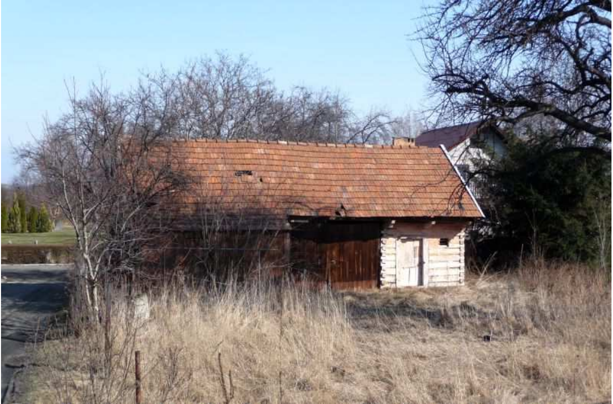
Fot. nr 92. Tył kompleksu mieszkalno-gospodarczego w jednym korpusie spod nr 130, zlokalizowany po lewej stronie drogi, który może mieć ze sto lat. (07.03.12)
