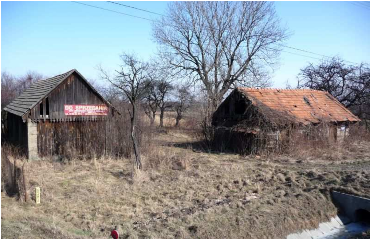
Fot. nr 54. Pierwsza z tradycyjnych chat (licząc od strony Bochni) przy drodze nr 75 (dawnej A-4) pod nr 196. (07.03.2012). Obiekty z fot. nr: 54-89 znajdują się po lewej stronie tej drogi w kolejności od strony Bochni.
