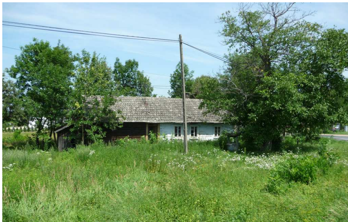
Fot. nr 152 (152-155). Ostatnie tchnienia archaicznego kompleksu mieszkalno-gospodarczego z roku z lata 2012. (23.09.2012)
