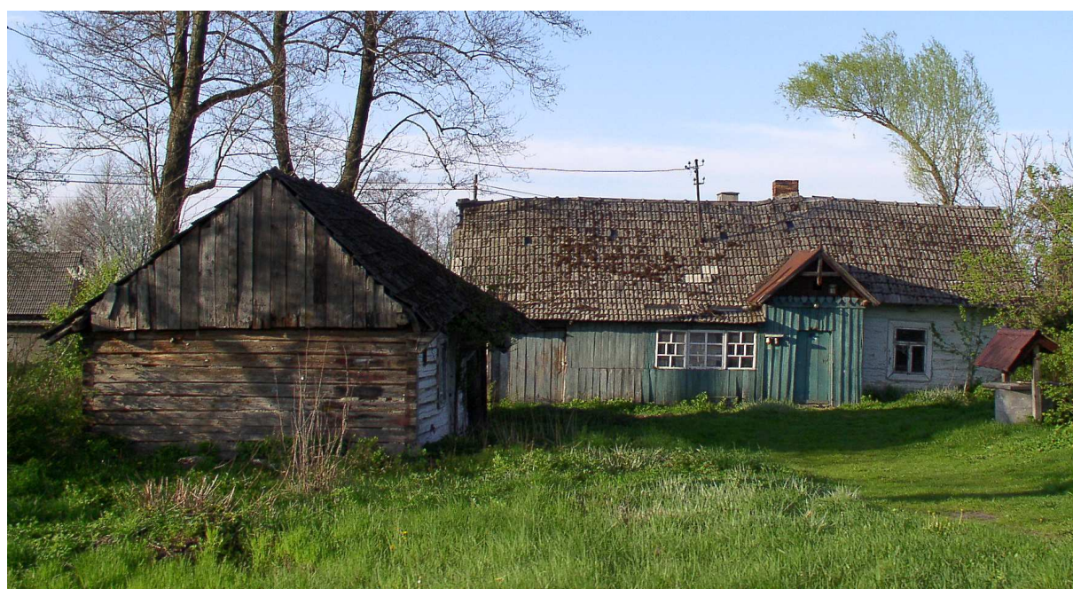
Fot. nr 146. Próba zbliżenia fasady tej zagrody. (26.04.2011)
