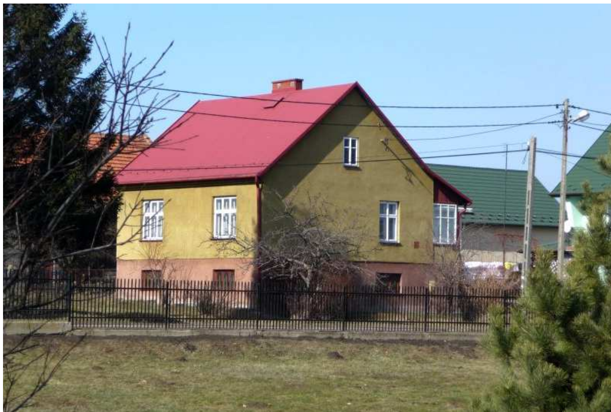
Fot. nr 18 (18-19). Zapewne powojenny dom pod nr 333 z zachowaną, oryginalną stolarką okienną. (07.03.11)
