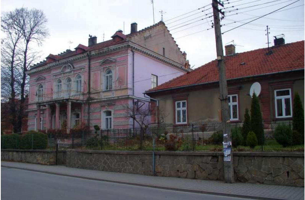
Fot. nr 48. Fragment stuletniej zabudowy ulicy Orackiej 5 i 7. (20.11.2010)
