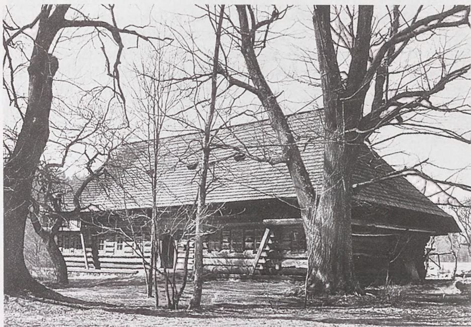
49. Dwór Moniaków w Zubrzycy Górnej (remont 1951–1953)
