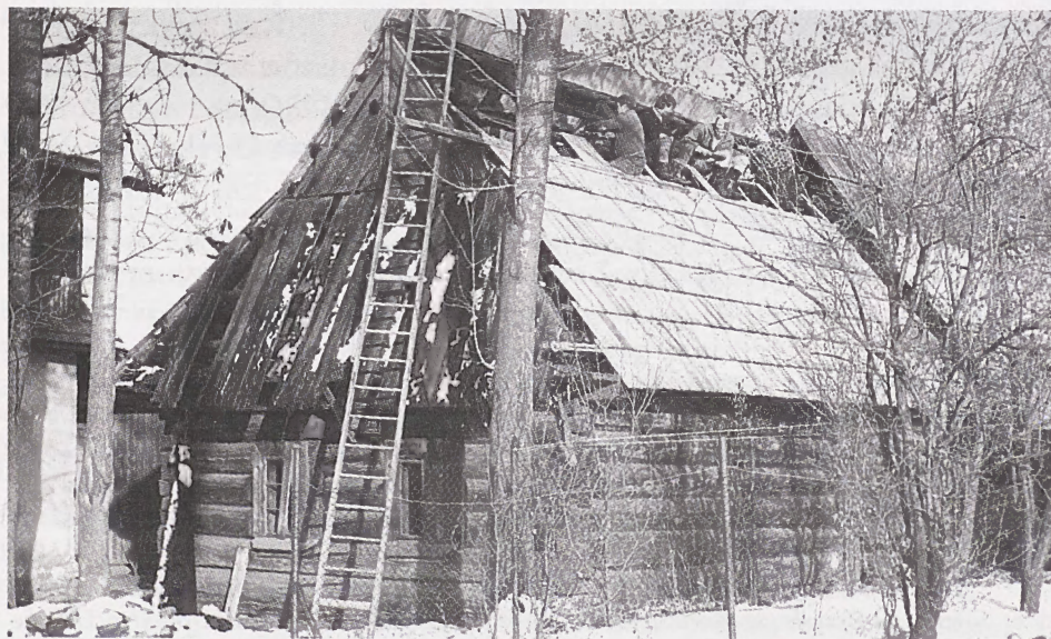
54. Remont zagrody Sołtysów w Jurgowie (1982)
