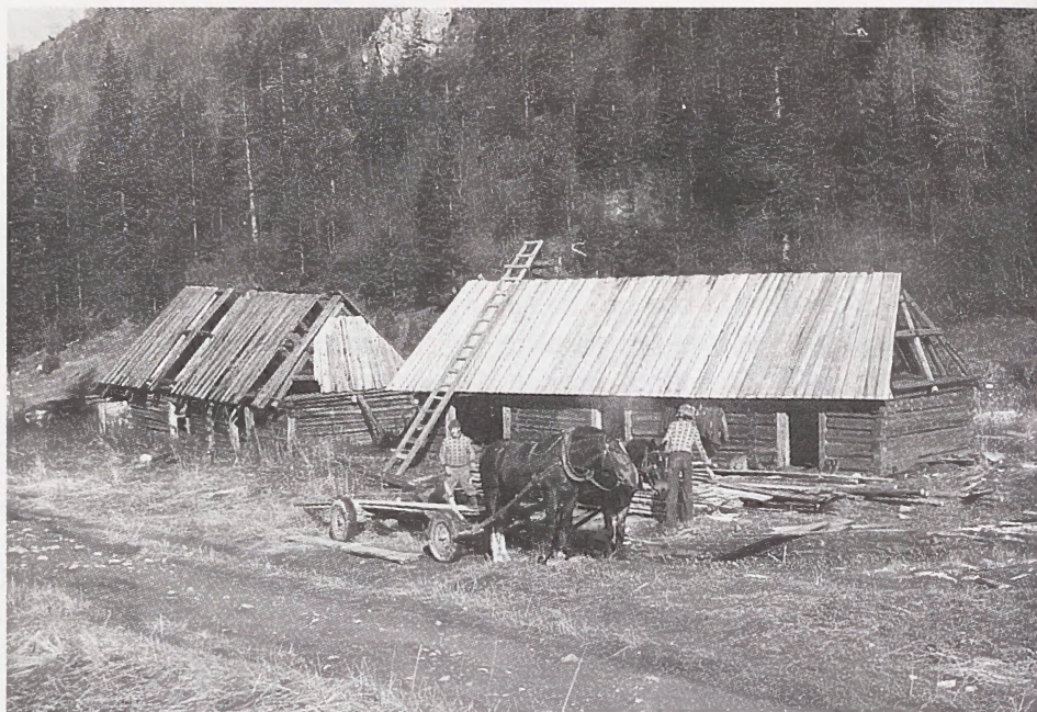
53. Remont szałasów na Hali Jaworzynka (1978)
