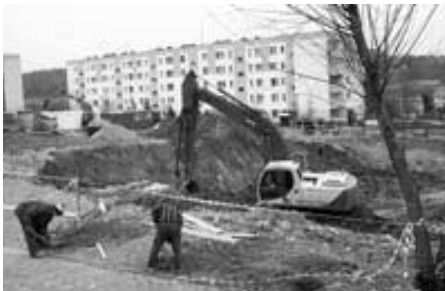
Pierwsze dni budowy basenu na Kurdwanowie.
