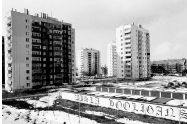
„Betonowa Dżungla”. Zbieg ulic Bojki i Wystouchów – jedno z najbardziej niebezpiecznych miejsc na os. Kurdwanów Nowy. Fot. „Dudens” – Kamil Duda
