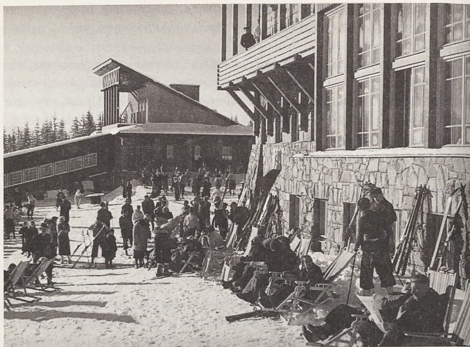
26. Stacja górna kolejki i restauracja na Gubałówce
