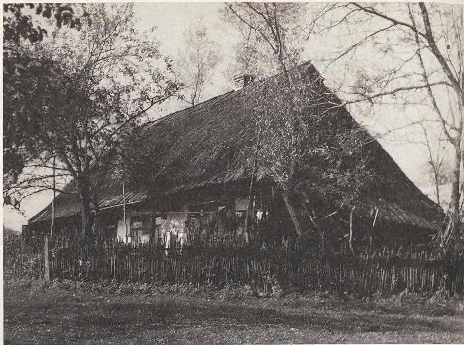
43. Dom z ogródkiem w Piekelniku
