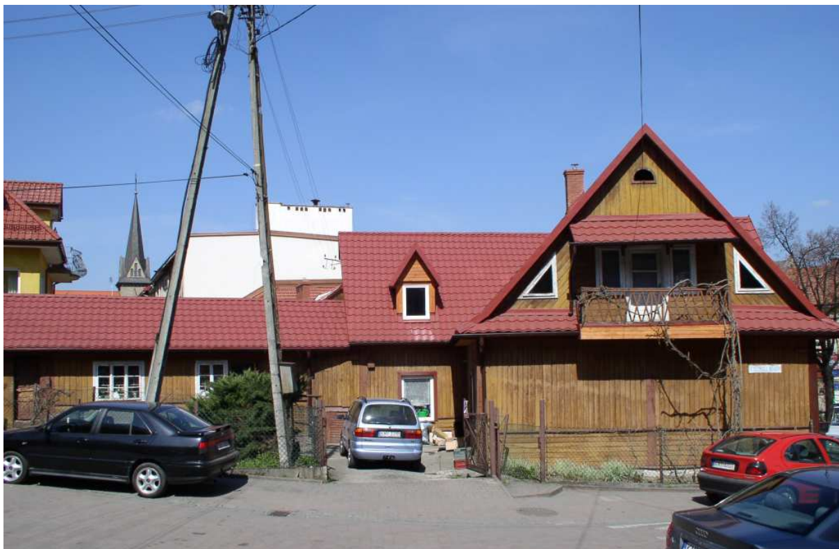
Fot. nr 16 (16-17). Stary kompleks mieszkalno-gospodarczy z naroża Rynku 33 i ulicy Kazimierza Wielkiego, pochodzący zapewne z początku XX wieku.
