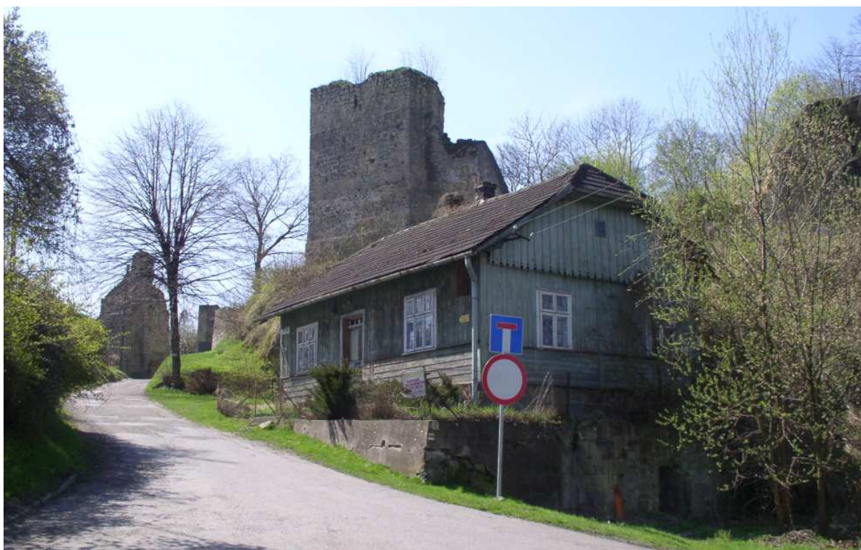
Fot. nr 23 (23-24). Drewniany dom z ulicy Kasztelana Dobka (nr 9?), zapewne pochodzący z okresu międzywojennego początku, na tle baszty wchodzącej w obręb dawnych murów obronnych starych Dobczyc.
