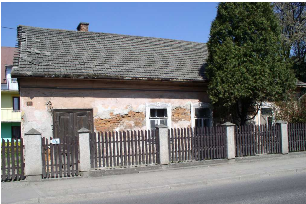
Fot. nr 47 (47-48). Murowana chałupa (nr 66) pochodząca zapewne z przełomu I i II ćwierci XX wieku.
