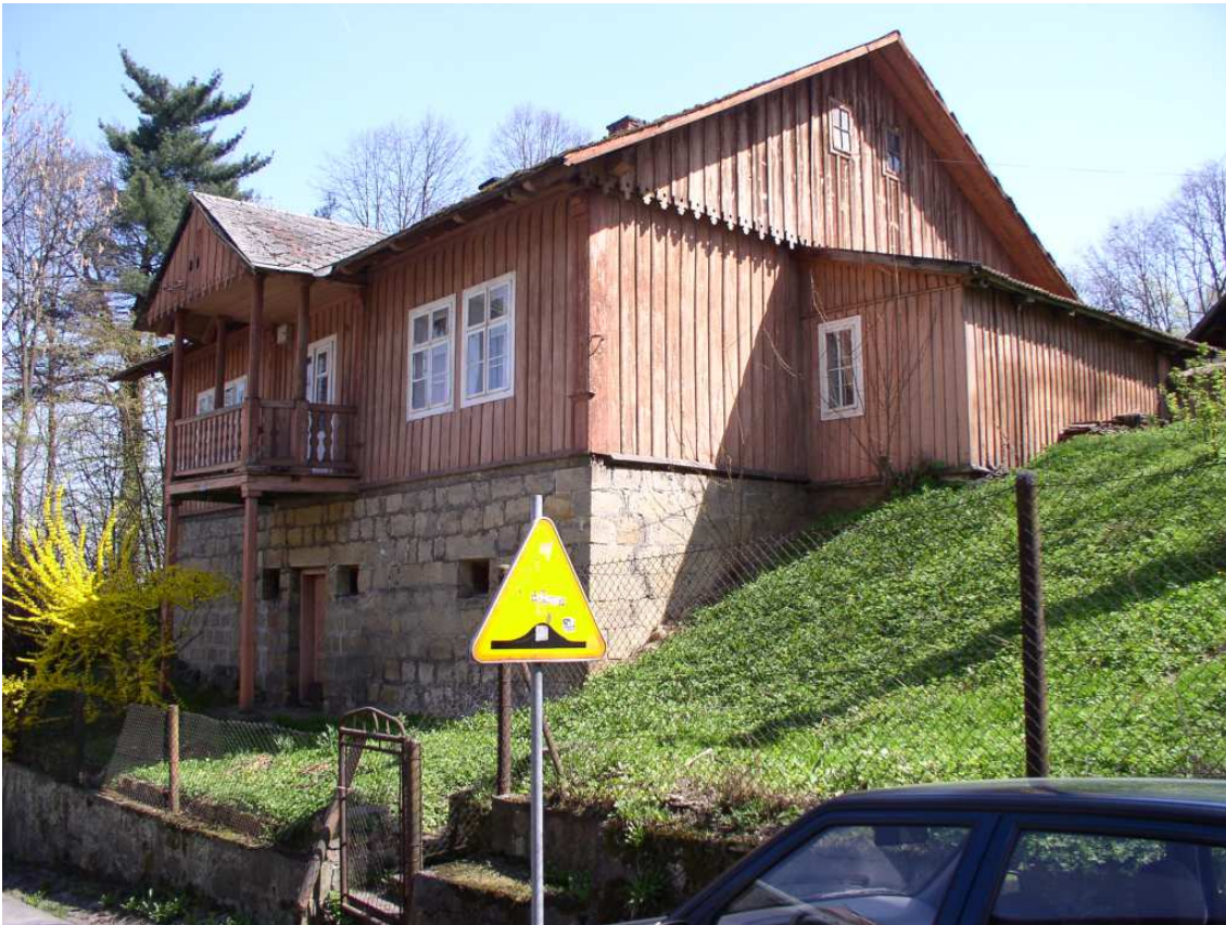
Fot. nr 18 (18-21). Oryginalna, drewniana willa z ulicy Kazimierza Wielkiego 6, która mogła powstać gdzieś wokolicy II dekady XX wieku.
