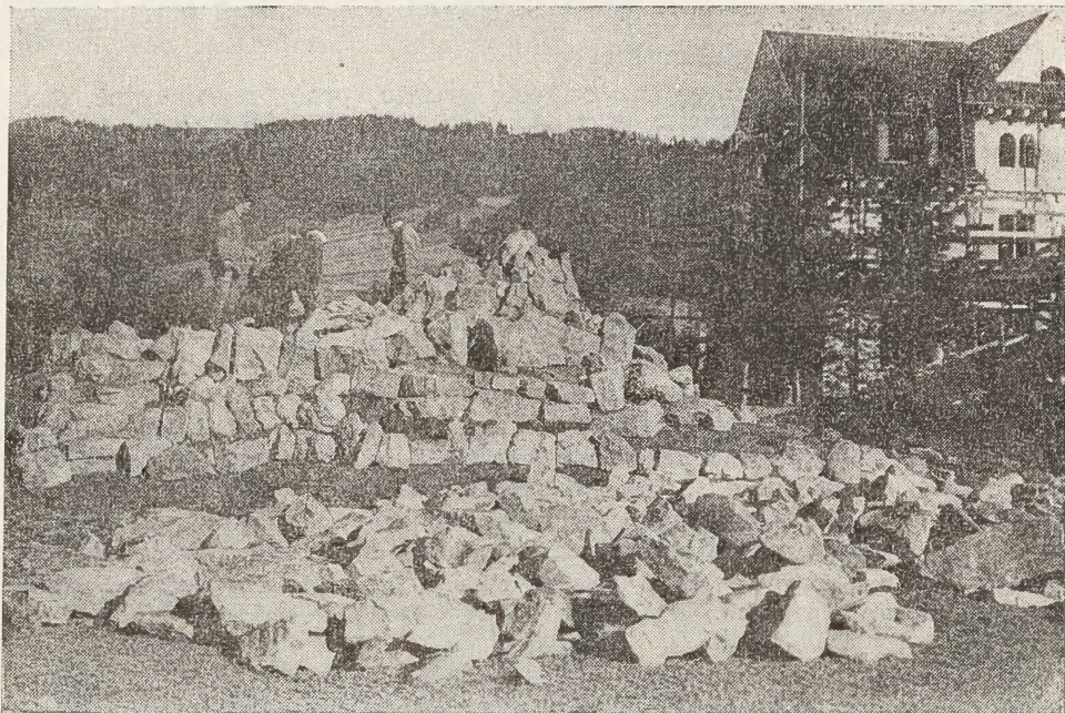
29. Budowa alpinarium przy budynku Muzeum Tatrzańskiego w ogrodzie PTT, 1919 r.
