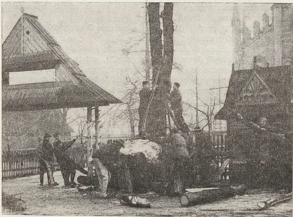
56. Budowa pomnika Powstańców Chochołowskich w Chochołowie, 1966 r.
