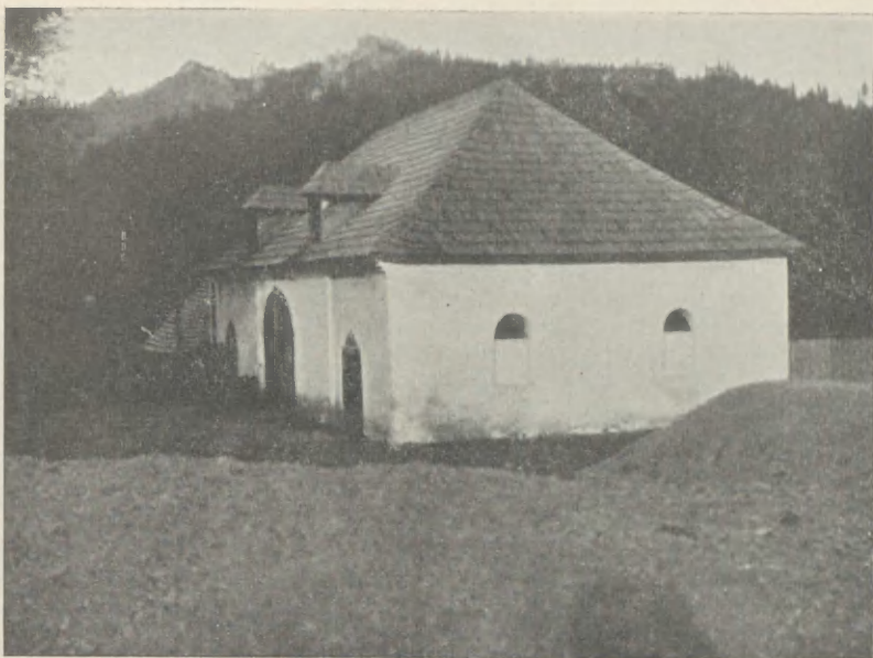
Dworski budynek w Kuźnicach
