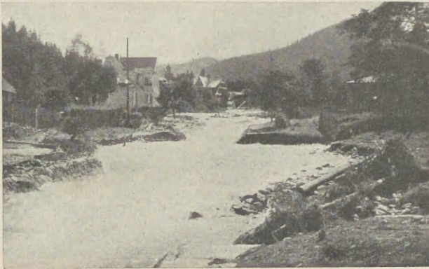
Powódź w lipcu 1934 r. Bulwar Słowackiego pod Kozieńcem; zniszczenie regulowanego koryta Bystrej.
