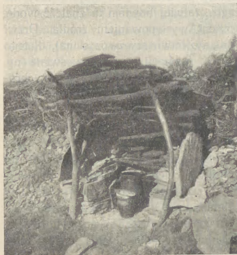
Ryc. 2. — Kuchenka zbudowana na sochy i ślemię, na Kiczrze. Fot. autor.
