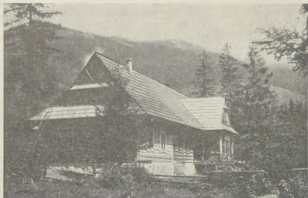
Schronisko w Roztoce po przebudowaniu.
