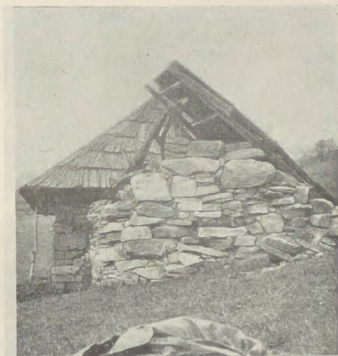
Ryc. 1. — Szałas na Hrobaczęj Łące. Dach zbudowany na sochy i ślemię. Na pierwszym planie kuchotka. Fot. autor.
