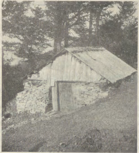
Ryc. 4. — Szalas kamienny na Kiczerze — konstrukcja dachu na kozły — wewnątrz wyżka dla ludzi, zaznaczona poziomą belką.
