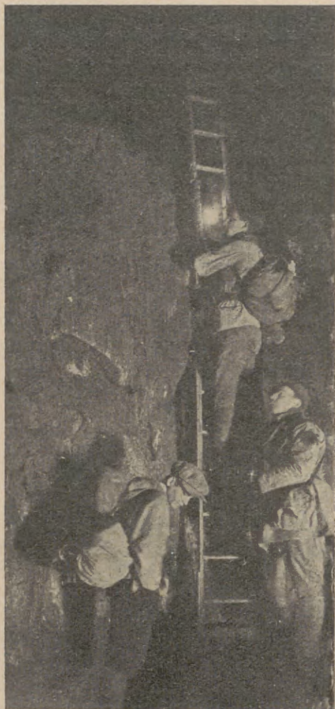
Ryc. 3. Przed wejściem do wielkiego komina.
