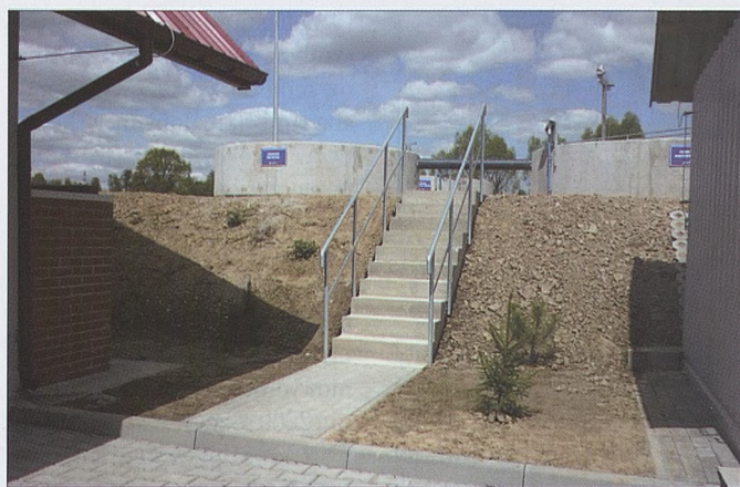
■ Oczyszczalnia ścieków w Nieszkowicach Wielkich
