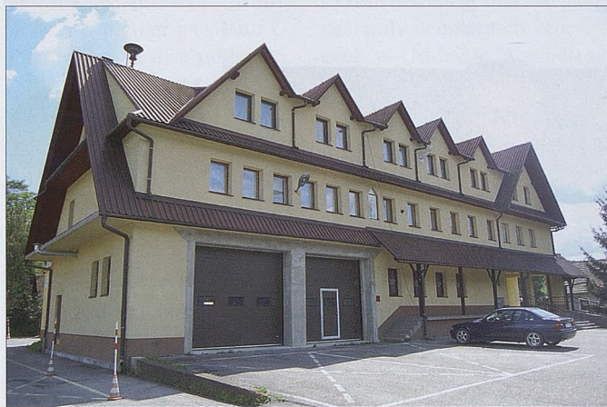
■ Budynek remizy w Tarnawie
