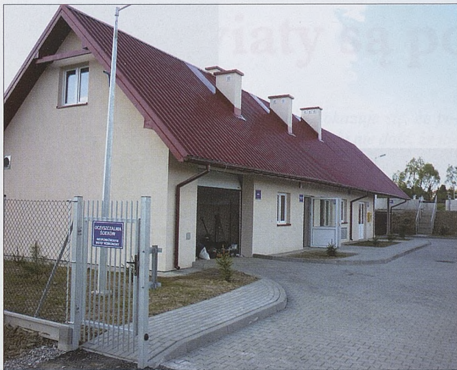
■ Oczyszczalnia ścieków w Nieszkowicach Wielkich
