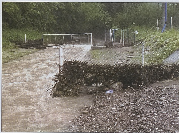
■ Zniszczenia na ujęciu wody w Kamionnej
