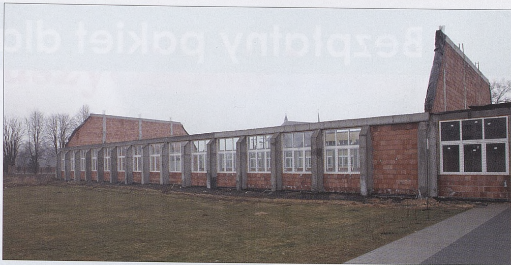
■ Hala w Łapanowie w kwietniu 2012 roku jeszcze bez dachu... ale za to z oknami
