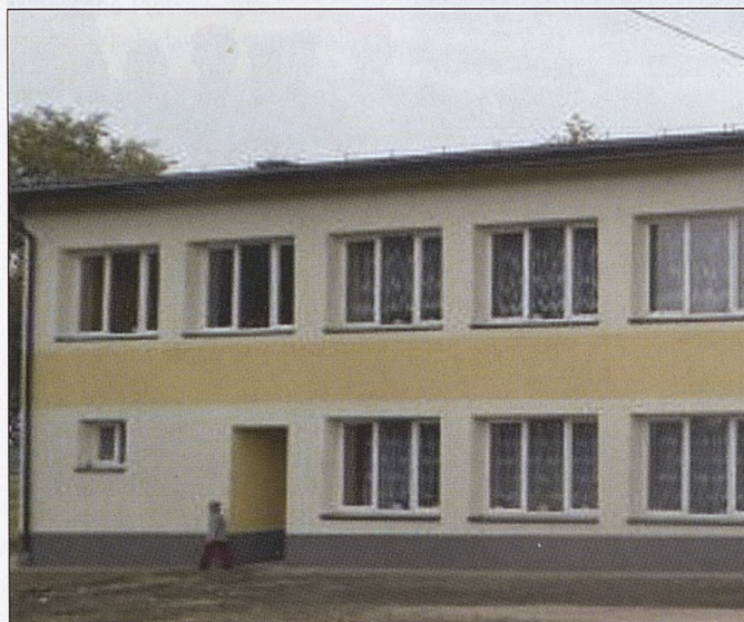
■ Szkoła w Grobli po remoncie
