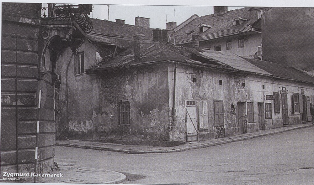
■ Bochnia, ul. Solna, początek lat 80.
