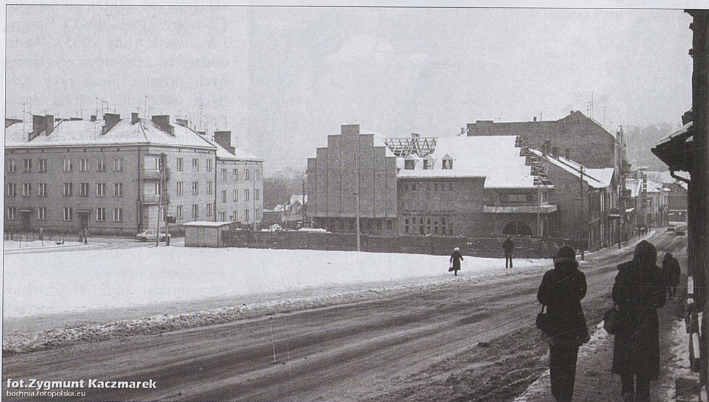
■ Bochnia, ul. Kraszewskiego. Budynek Szkoły Muzycznej w budowie, początek lat 80.
