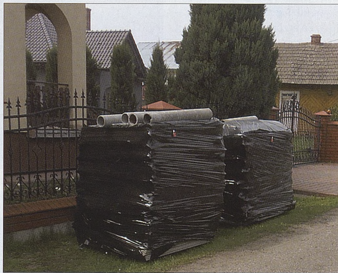
■ Odpowiednio zabezpieczony azbest czeka na transport
