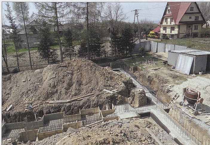
■ Budowa sali gimnastycznej w Kierlikówce.
