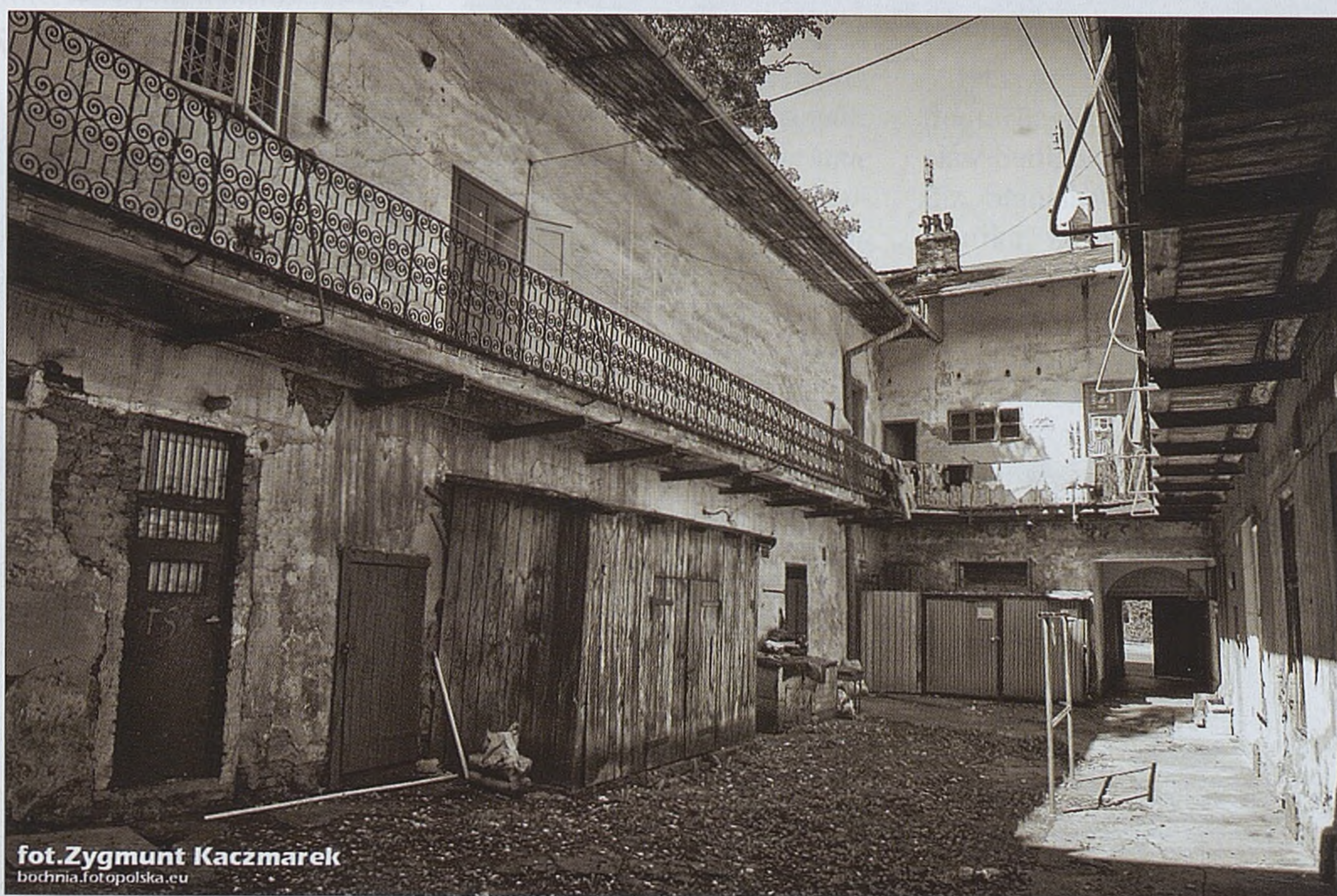
■ Dzielnica kamienicy przy placu św. Kingi 1 kilka lat przed wyburzeniem
