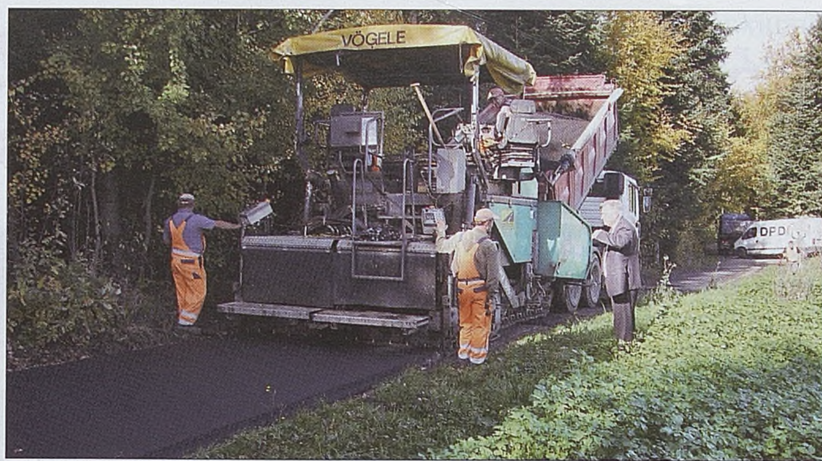
■ Odbudowa drogi gminnej w Bełdnie
