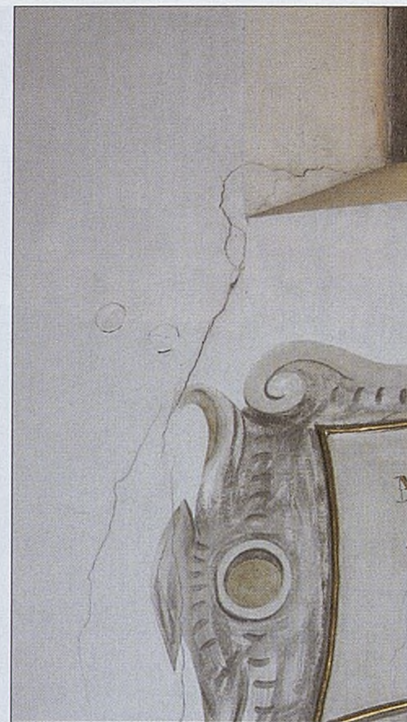
■ Niektóre z pęknięć widocznych wewnątrz świątyni.
