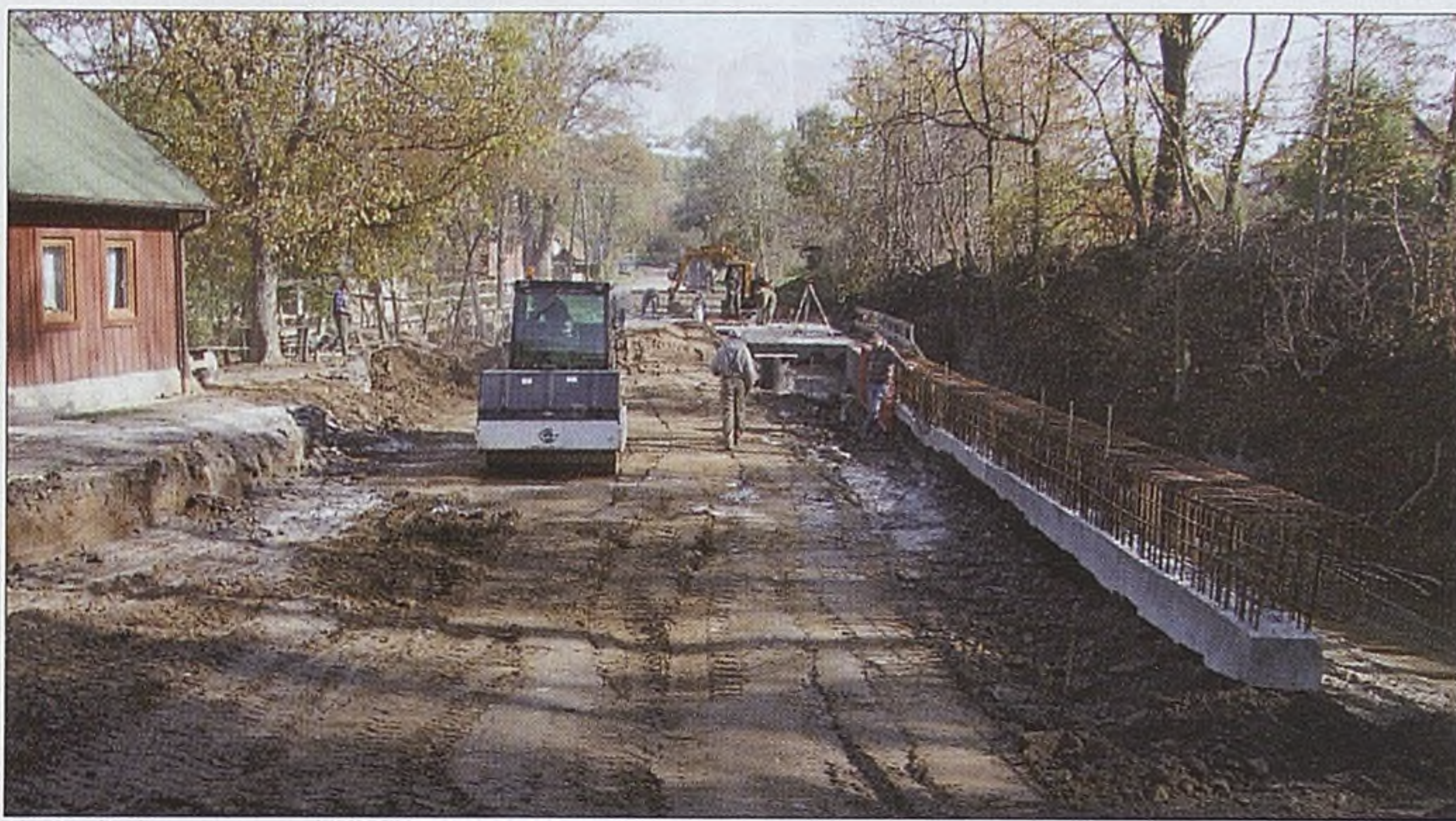
■ Budowa mostu w Bytomsku
