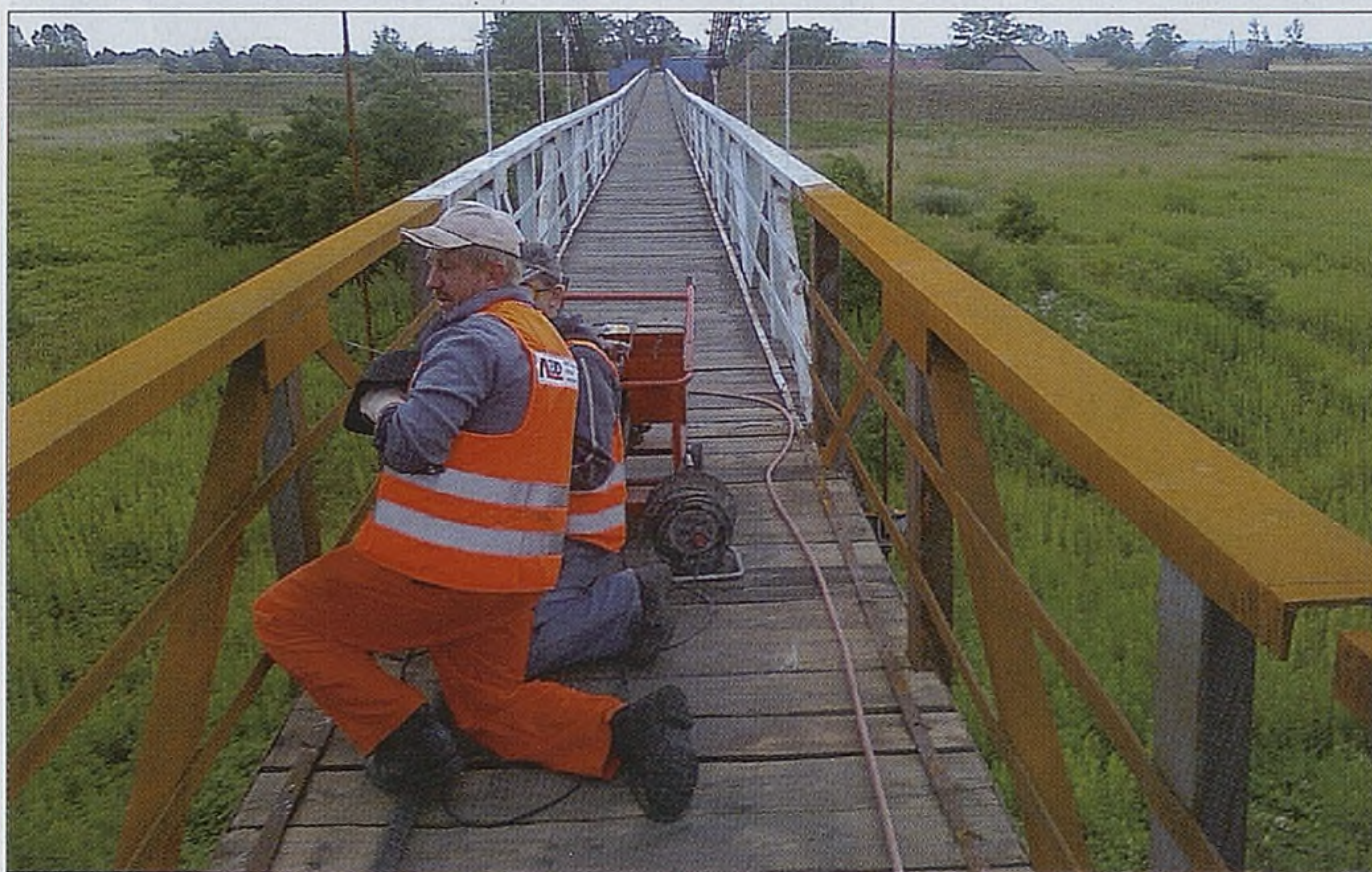
■ Most łączący Majkowice z Mikłuszowicami ma zostać oddany do użytku jesienią b.r.
