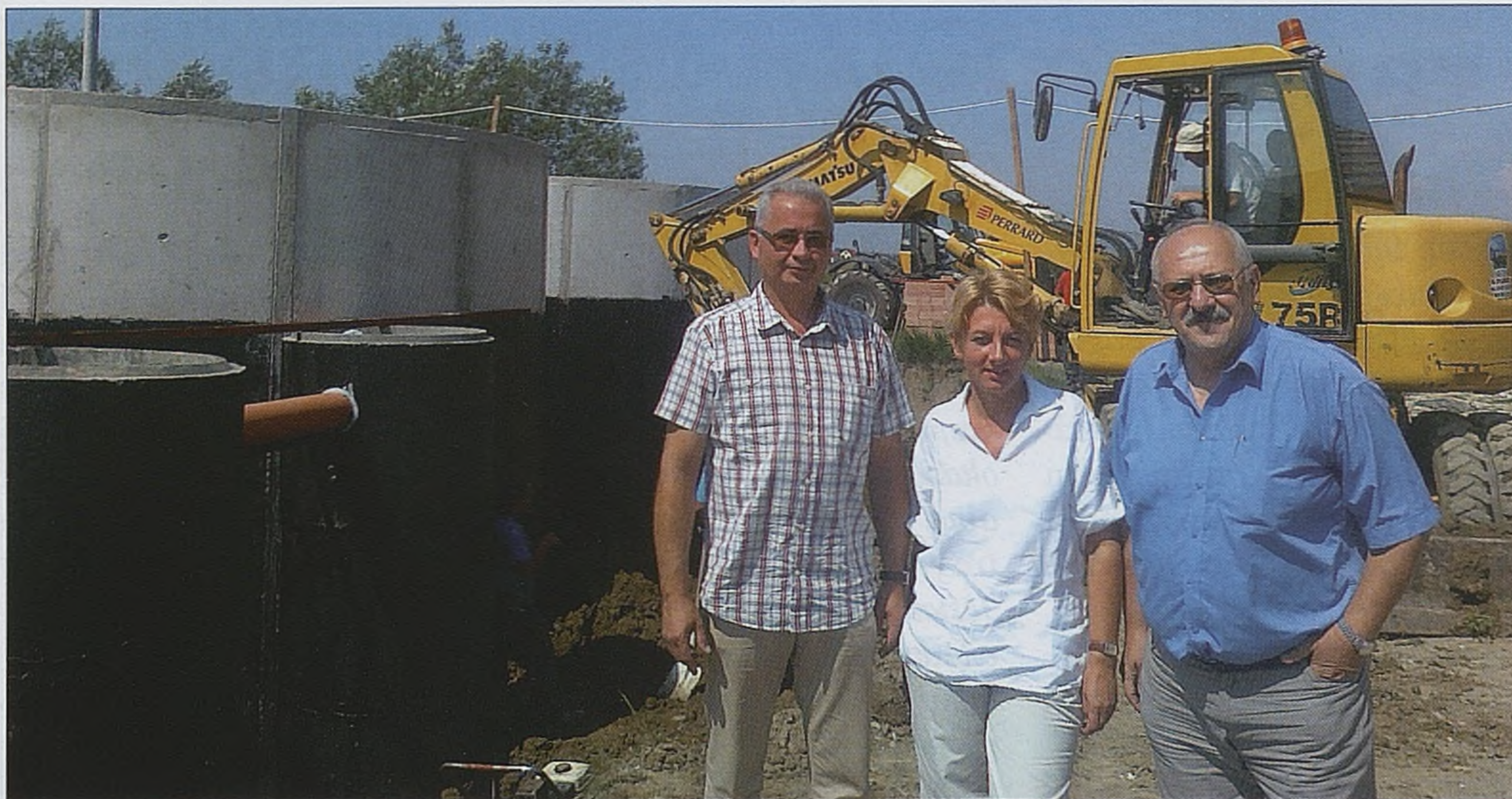
■ Robert Gabryel – kierownik wydziału budownictwa UG, Agnieszka Bronowska – inspektor z UG i Jerzy Lysy – wójt gminy Bochnia przy budowanej inwestycji w Bogucicach.
