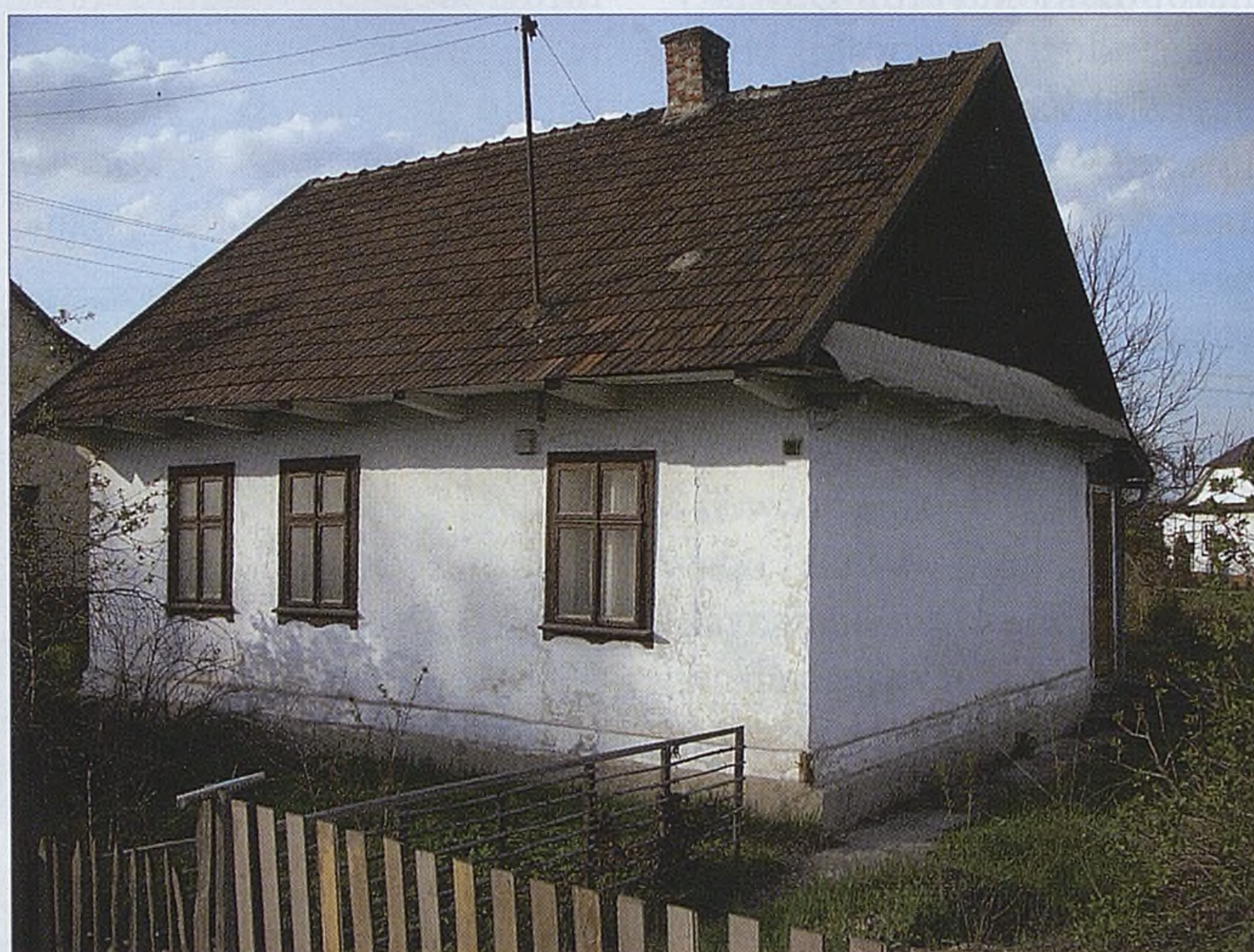
■ Domek w Stanisławicach, który uszkodziła bomba zabijając jedną osobę, a dwie kolejne raniąc.
