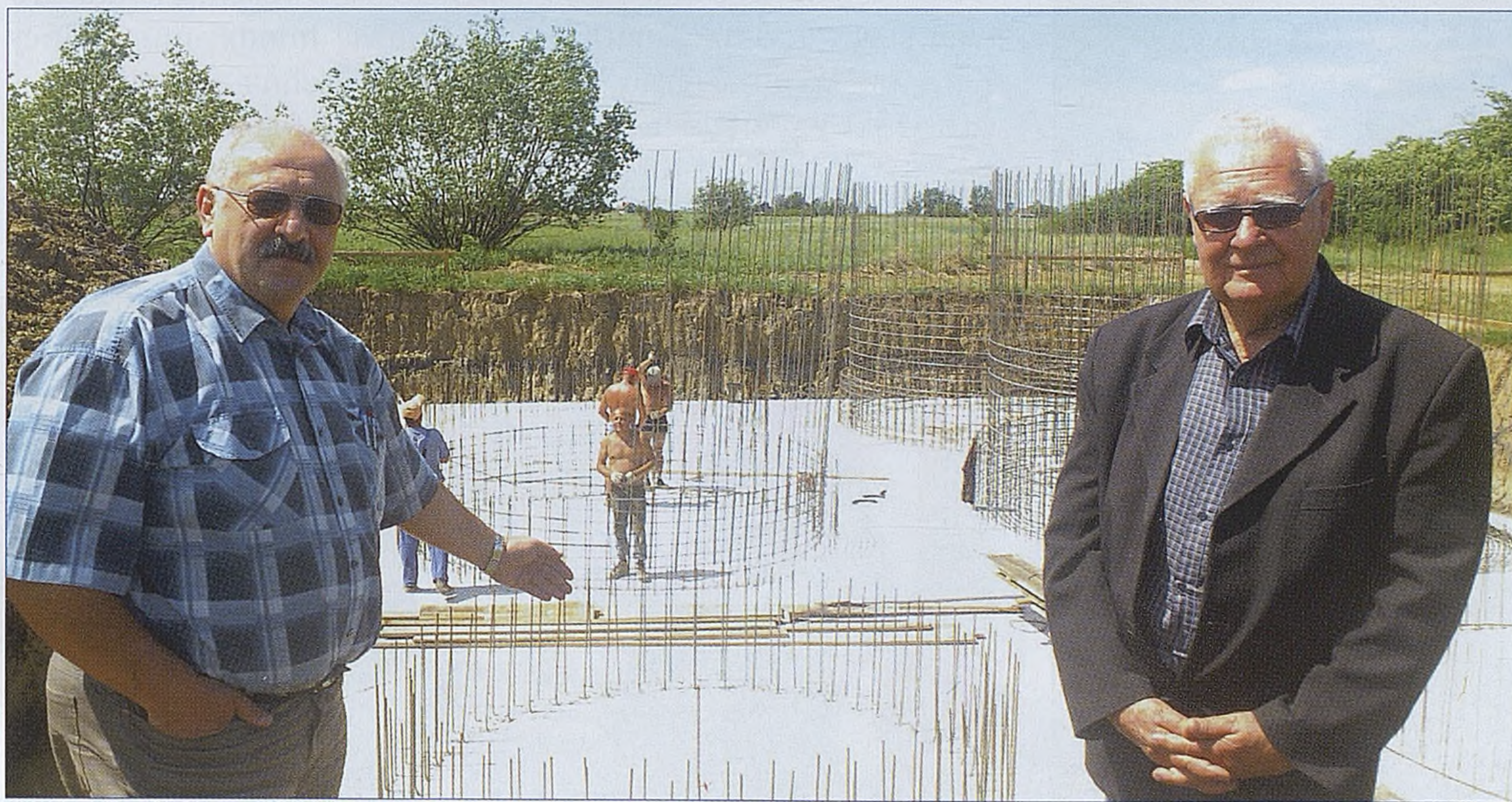
■ Największą ubiegłoroczną inwestycją była budowa kanalizacji w Bogucicach i Brzeźnicy, obecnie trwa budowa oczyszczalni ścieków „Północ” w Bogucicach; inspektor nadzoru, mgr inż. Jerzy Radliński z wójtem Jerzym Lysym.
