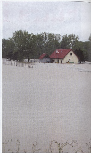
■ Zalana oczyszczalnia ścieków w Damienicach podczas powodzi w 2010 roku.
