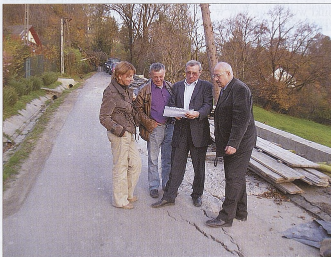
■ Przedstawiciele Urzędu Gminy Bochnia i wykonawców podczas wizji w terenie związanej z inwestycjami drogowymi i oświetleniowymi.
