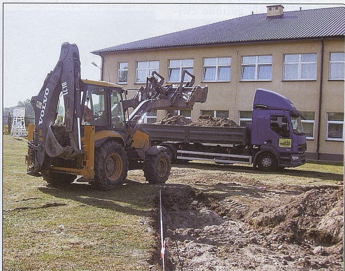
■ budowa placu zabaw w Mikłuszowicach
