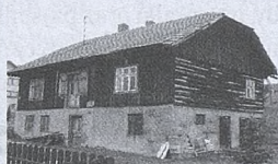
ŁAPCZYCA – dom (pow: 90m 2 ) drewniany na murowanym podpiwniczeniu, Dz. 10ar -95.000zł.
