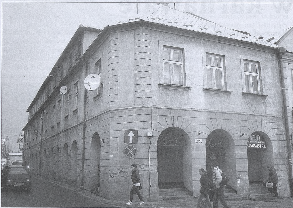
■ Kamienica przy ul. Szewskiej 1, stan obecny.
