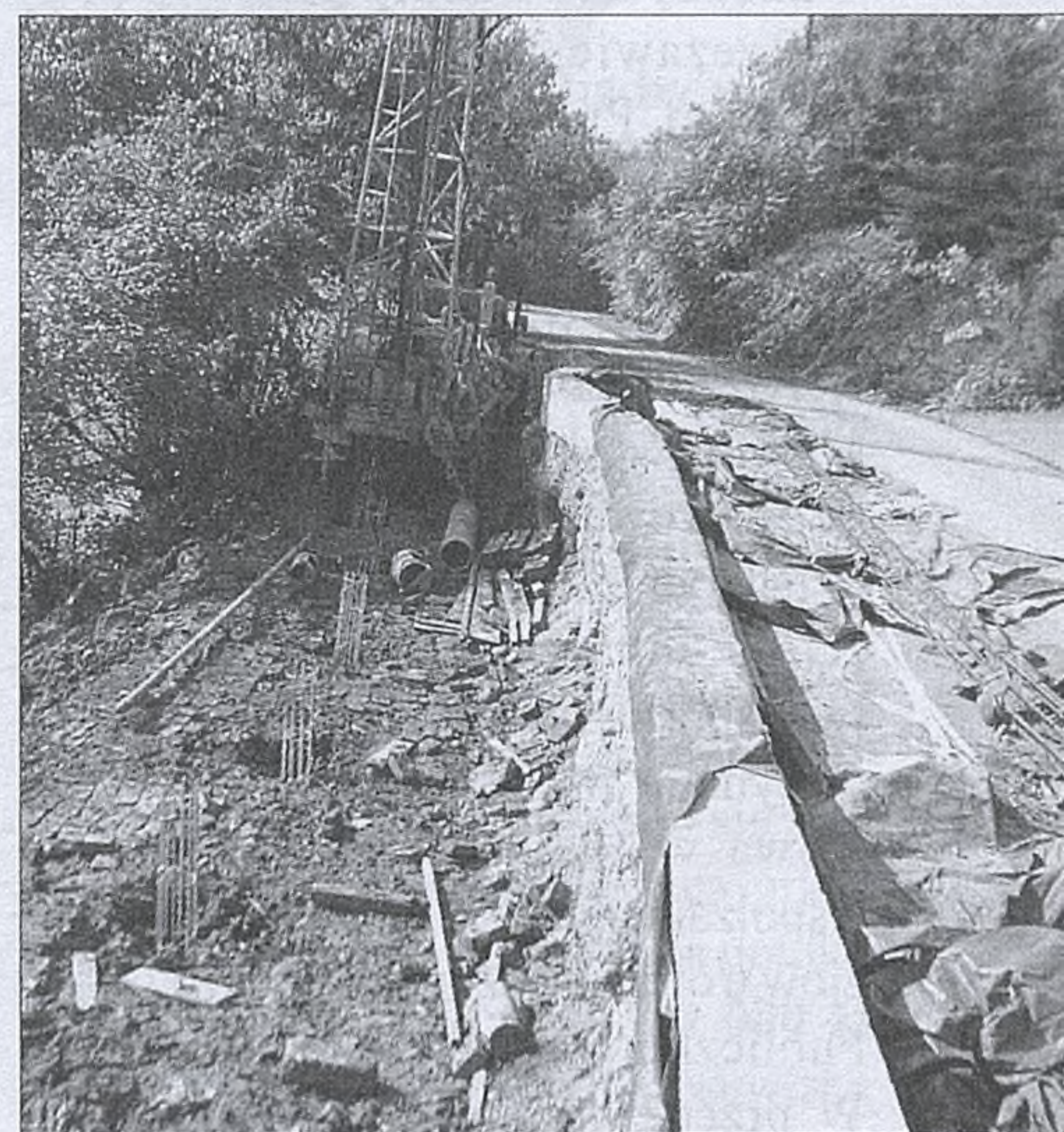
Dzięki gospodarczemu systemowi realizacji, za około 20% rzeczywistej wartości powstało zabezpieczenie osuwiska w Chełmie
