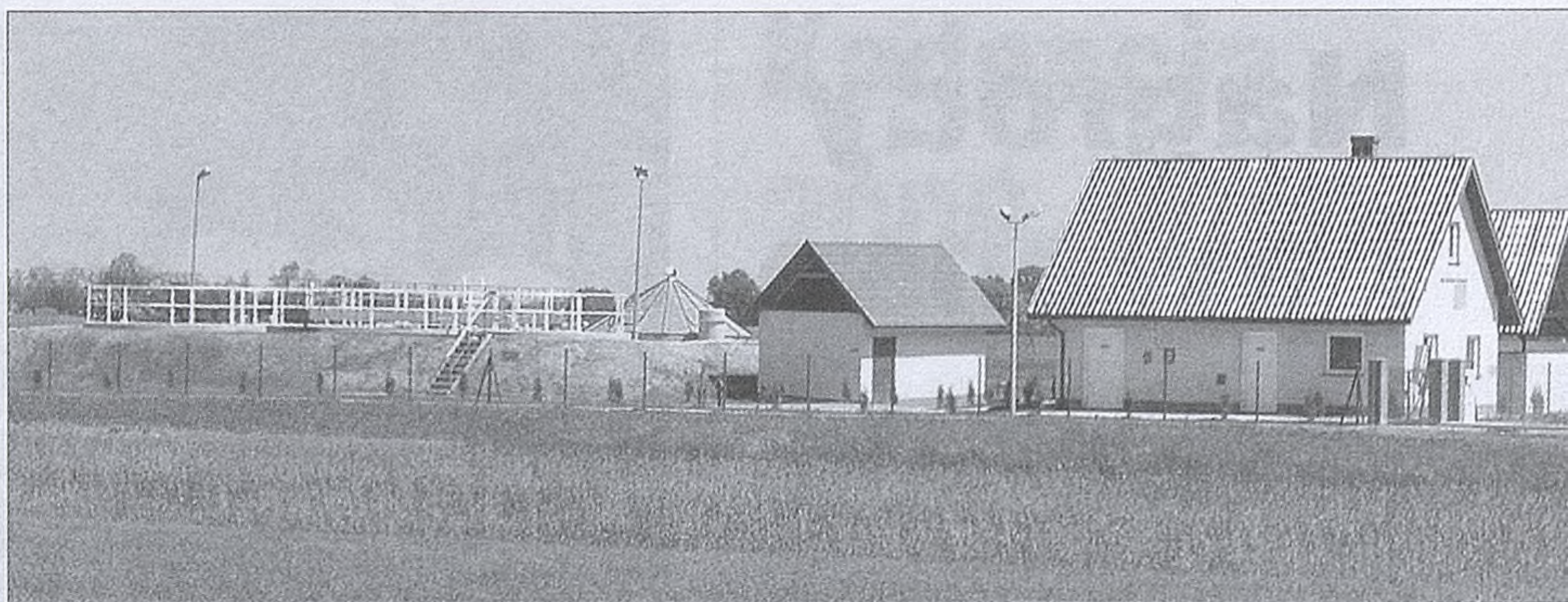
Nowoczesna oczyszczalnia ścieków w Proszówkach działa od 7 lat. Podobna oczyszczalnia powstanie w przyszłym roku w Bogucicach. Mimo mniejszych dochodów z podatków gmina zrealizuje ją przy pomocy środków unijnych
