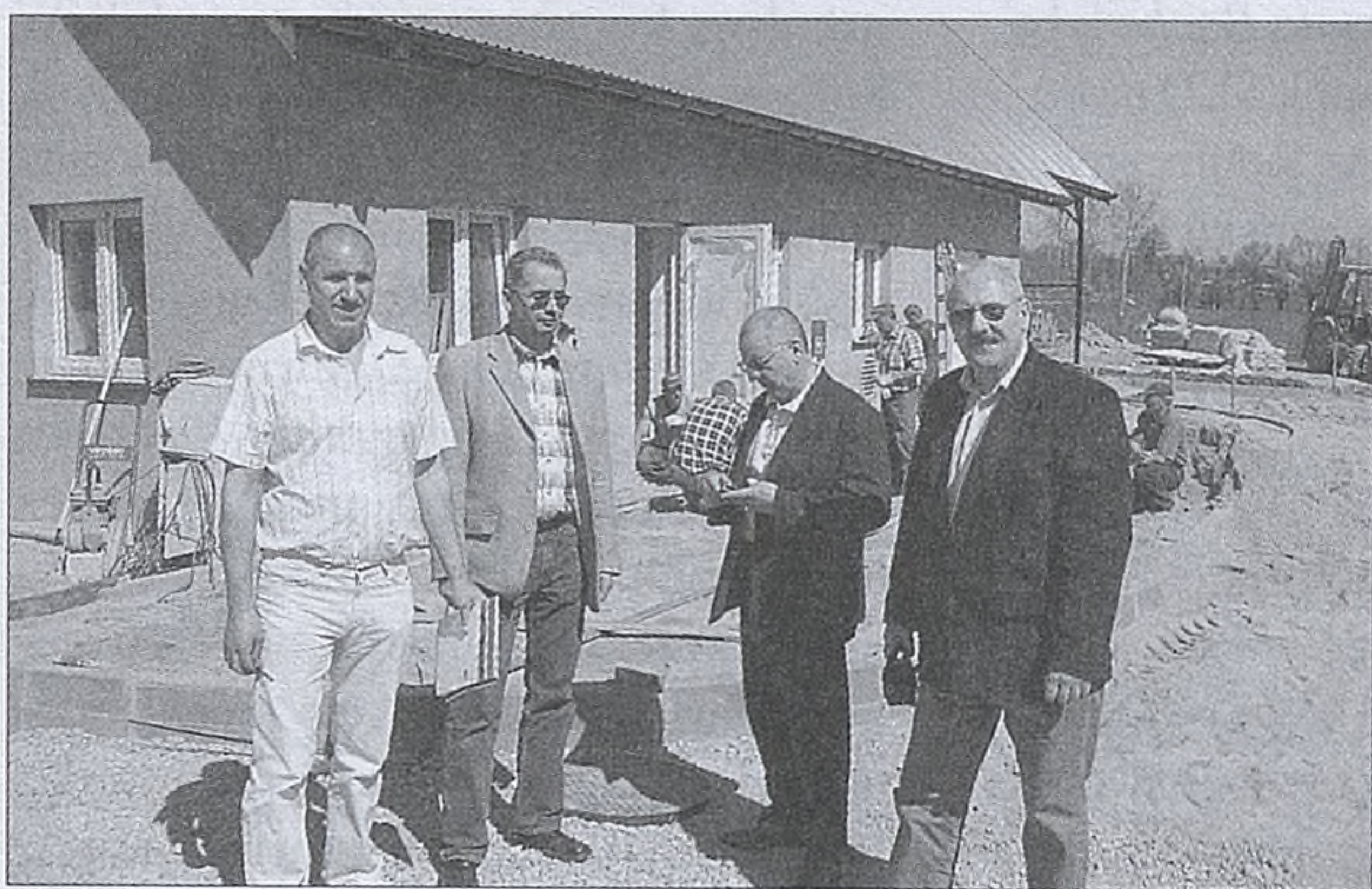
Wybudowano oczyszczalnię ścieków w Brzeźnicy – niedawno rozpoczęto budowę II etapu (kolektory)
