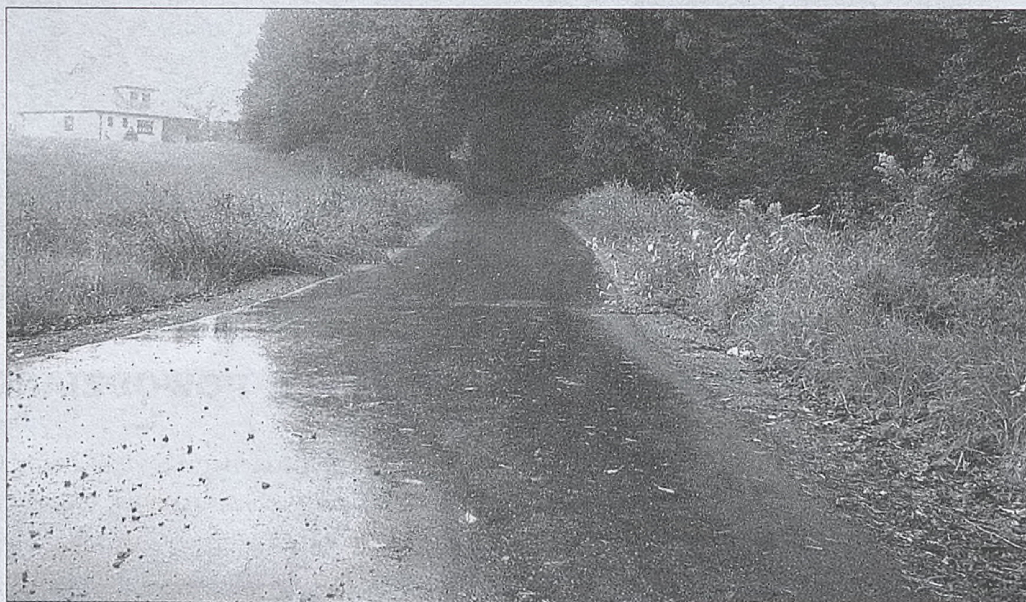
Zmodernizowana droga w Kobylcu
