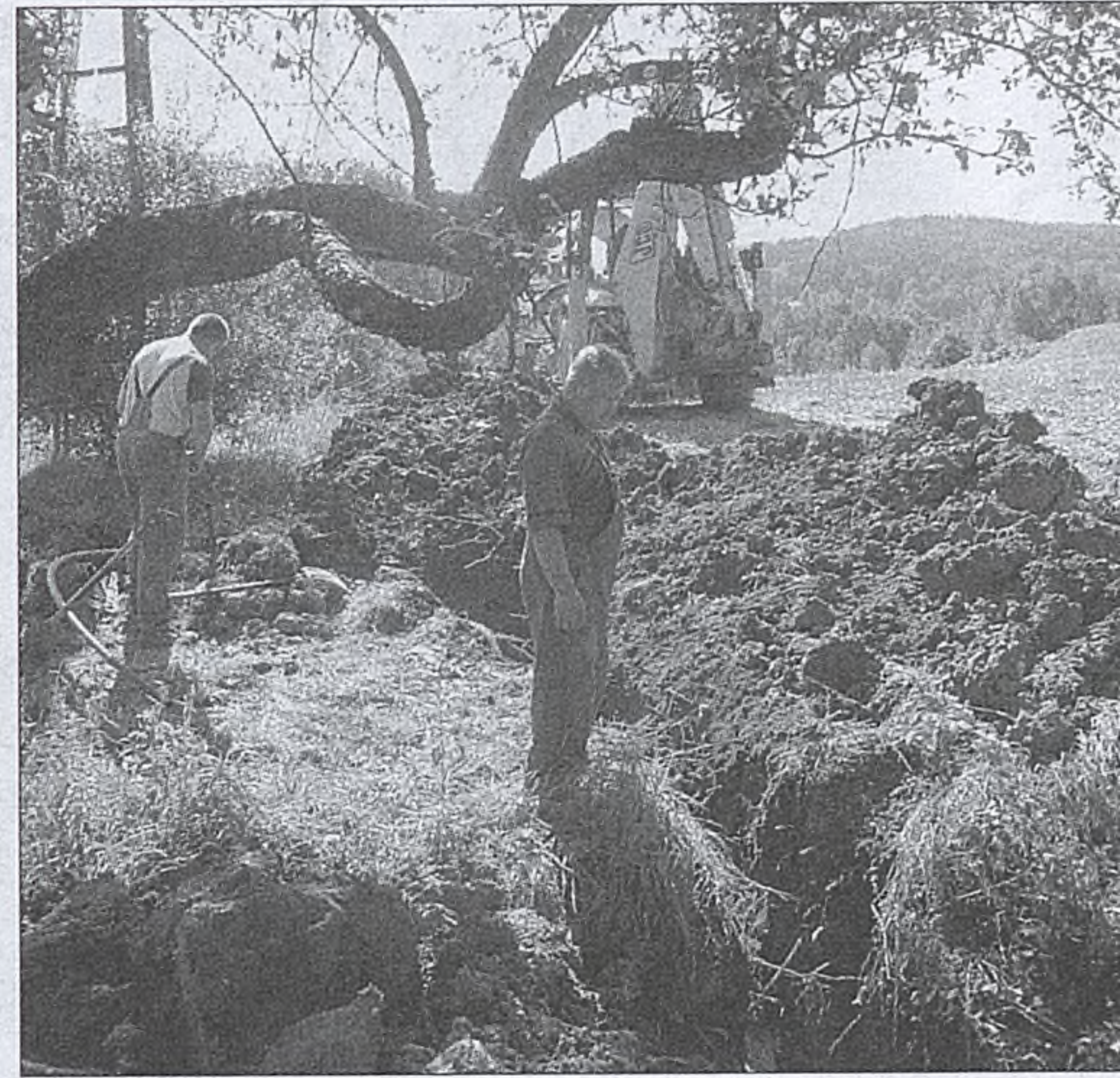
Prace przy budowie sieci wodociągowej w Żegocinie
