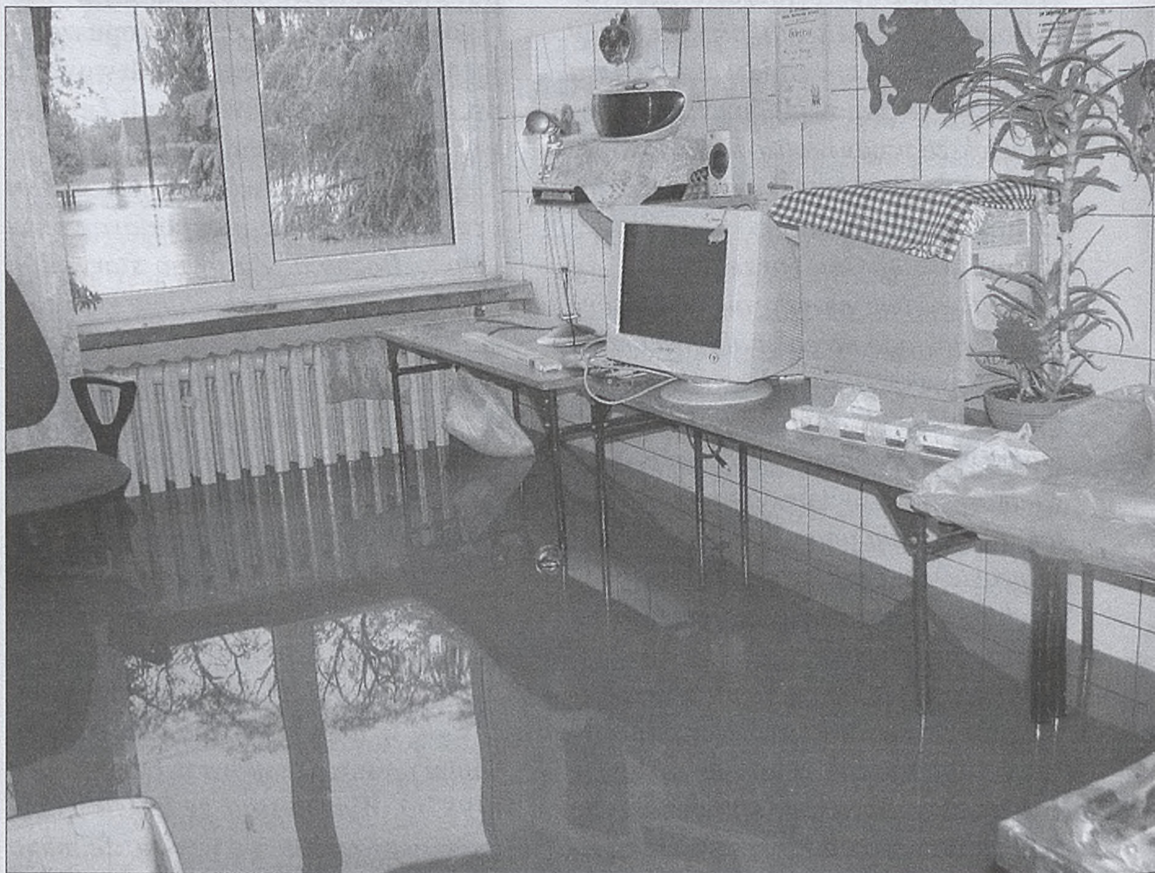
Pomieszczenia biurowe WTZ w Proszówkach
