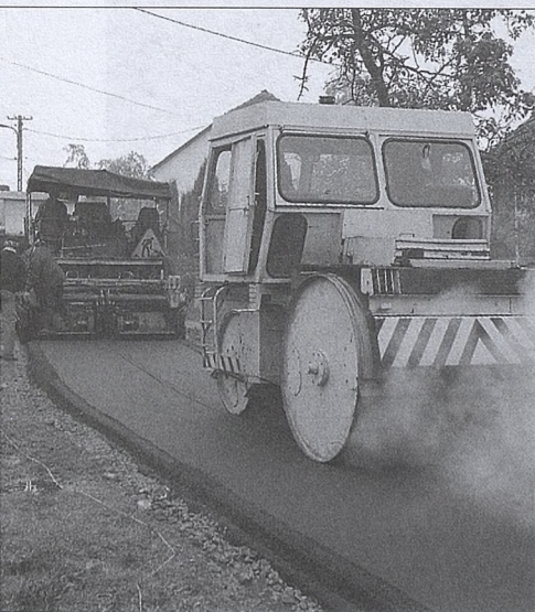
Remont drogi w centrum Dąbrówki
