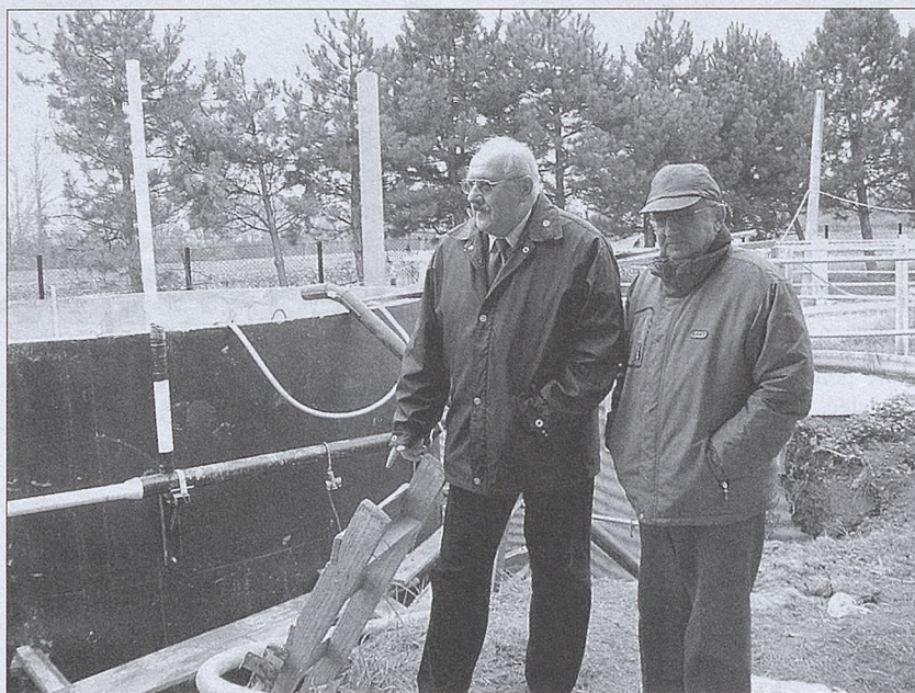
Na placu budowy: wójt Jerzy Lysy i inspektor nadzoru inż. Tadeusz Chyla
