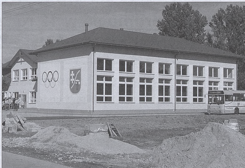
Nowo wybudowana sala gimnastyczna w Stanisławicach.
