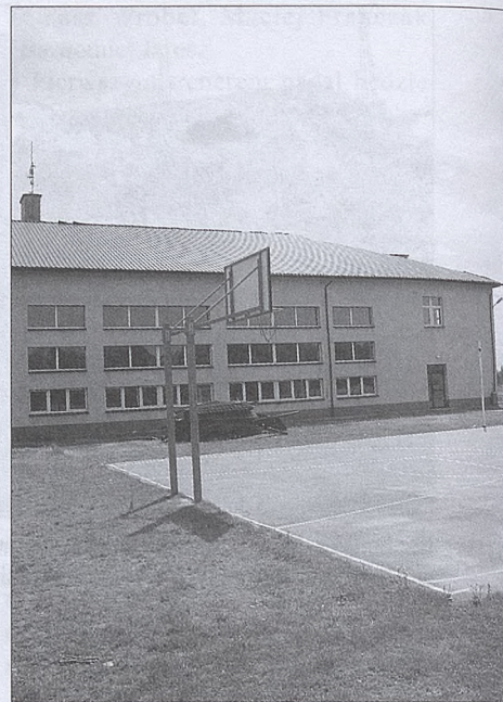
Sala gimnastyczna przy szkole w Mikuszowicach.
