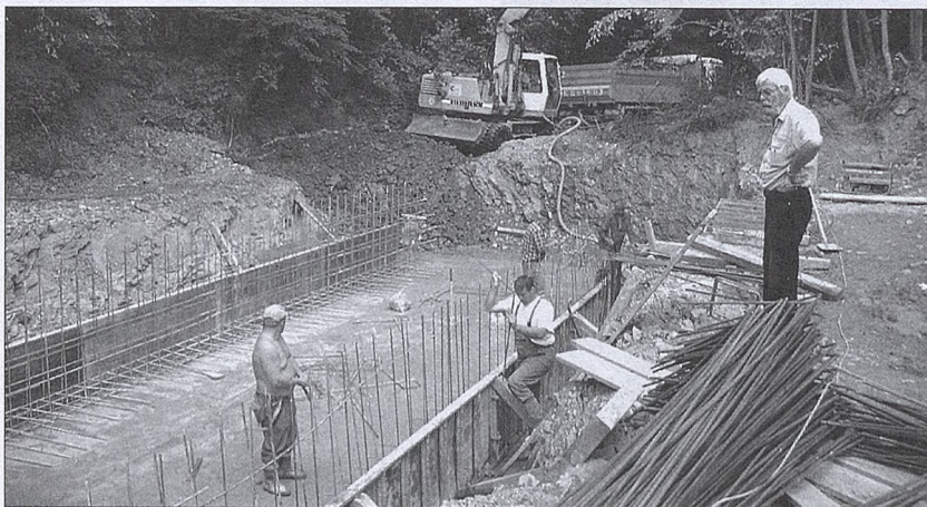
Prace przy budowie ujęcia wody w Kamionnej.
