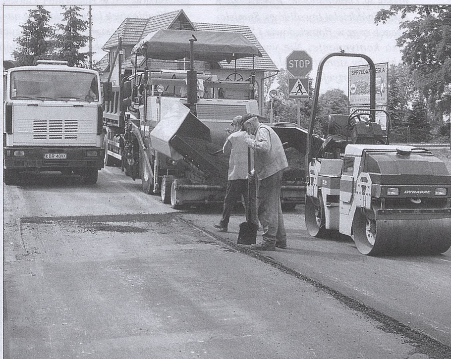
Remont ulicy Hutniczej.
