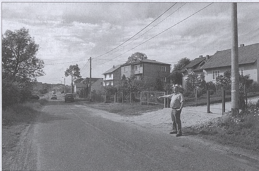
Remontu doczeka się m.in. droga prowadząca przez centrum Borku w stronę Centrum Aktywnego Wypoczynku.
