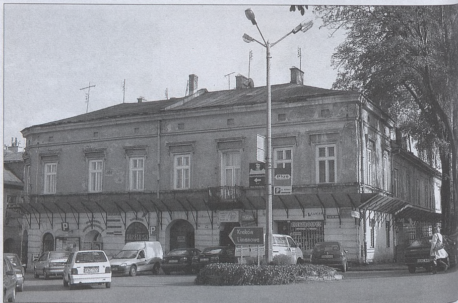
Kamienica jest w fatalnym stanie technicznym.
