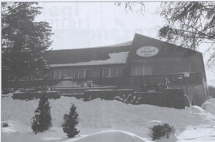
Motel Miś w Gorzkowie.
