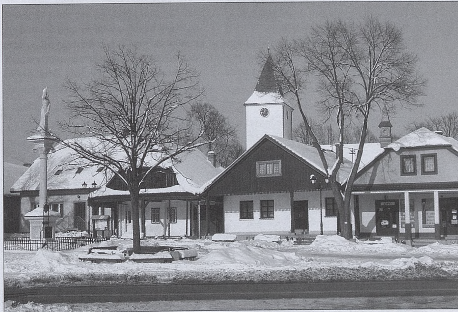
Rynek w Lipnicy Murowanej.
