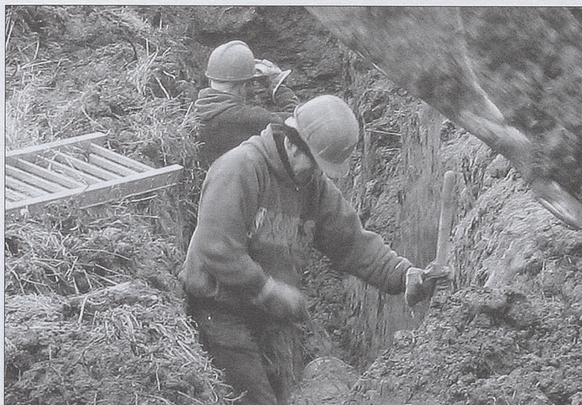
Mimo jesienno-zimowej aury, prace kanalizacyjne idą do przodu.
