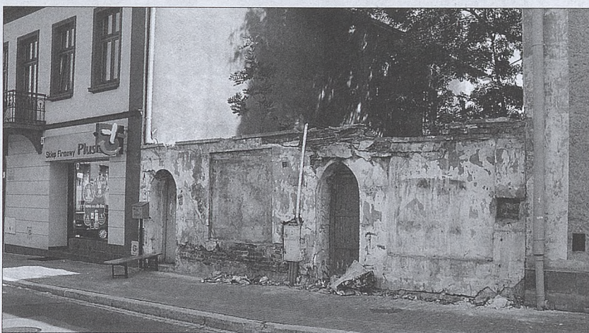
Po wyburzeniu drewnianego parkanu oczom przechodniów ukazał się znany sprzed lat widok szaletów. Po kilku minutach koparka zrównała teren z ziemią... fot. Jan Paruch.
