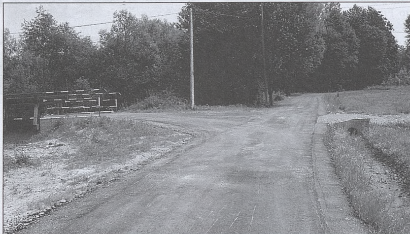
Wyremontowany most i droga w Zbydniowie.
