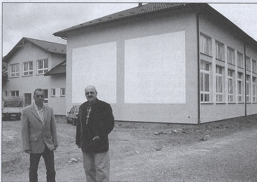
Kierownik Wydziału Budownictwa – Robert Gabryel i wójt Jerzy Lysy często osobiście doglądają inwestycję w Stanisławicach.
